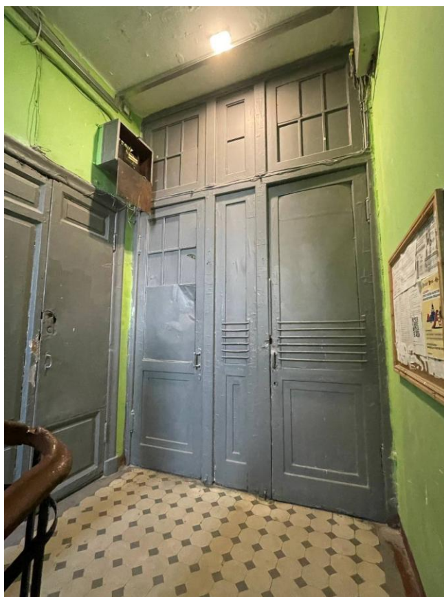
Фото 50. Интерьер первого этажа выявленного объекта культурного наследия «Депо Конно-железной дороги и комплекс трампарка (4 здания)»
