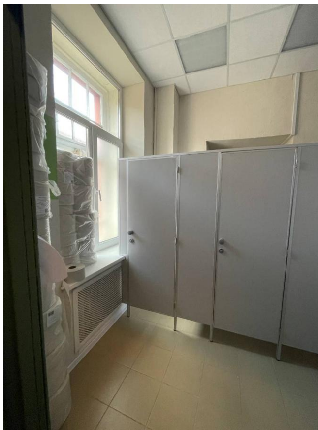
Фото 42. Интерьер первого этажа выявленного объекта культурного наследия «Депо Конно-железной дороги и комплекс трампарка (4 здания)»
