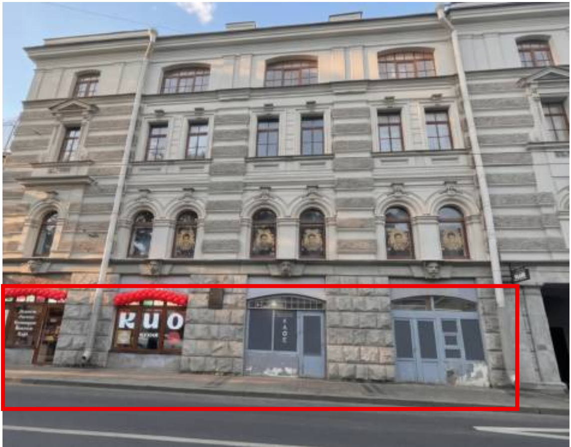
1. Вид на фасад с Гороховой улицы
