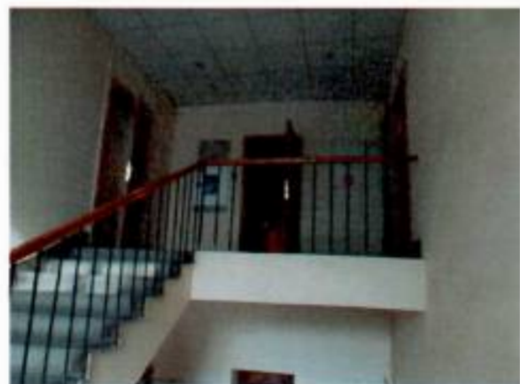
23. Лестничная клетка 4Н (36)
