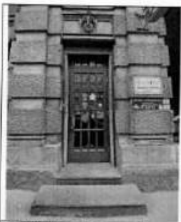
5. Фрагмент юго-западный фасада.
