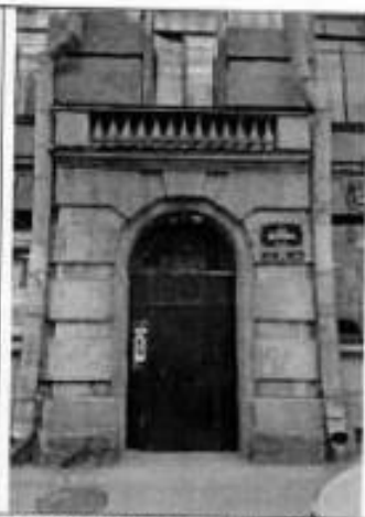
4. Фрагмент юго-западный фасада.
