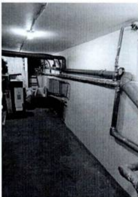
Фото 13. Помещение подвала объекта культурного наследия.
