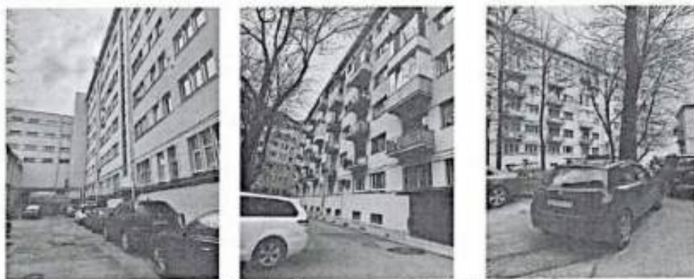
22,23,24. Фрагмент дворового фасада
