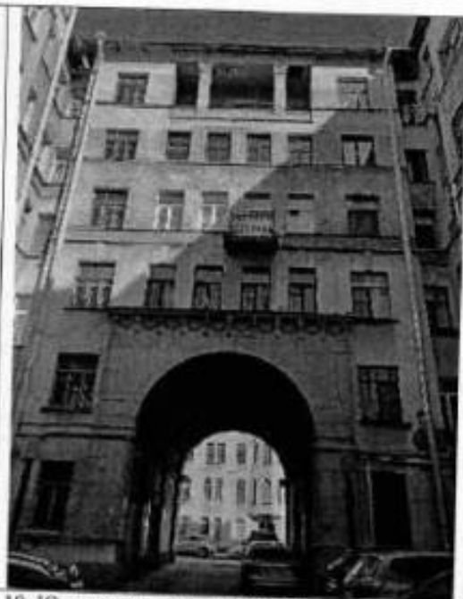
10. Юго-западный дворовый фасад.
