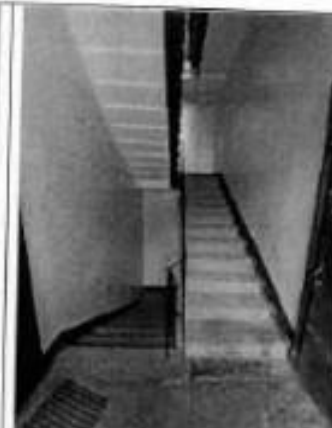
26. Лестничная клетка 7ЛК.
