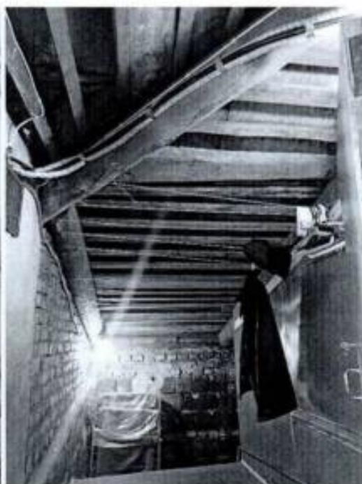
Фото 14. Стропильная система объекта культурного наследия.
