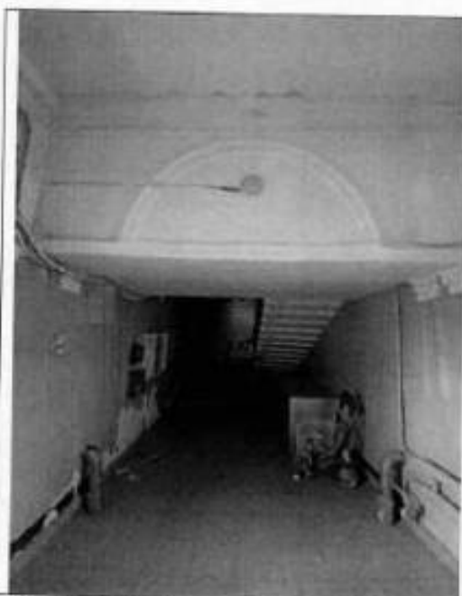
22. Вестибюль лестничной клетки 5ЛК.
