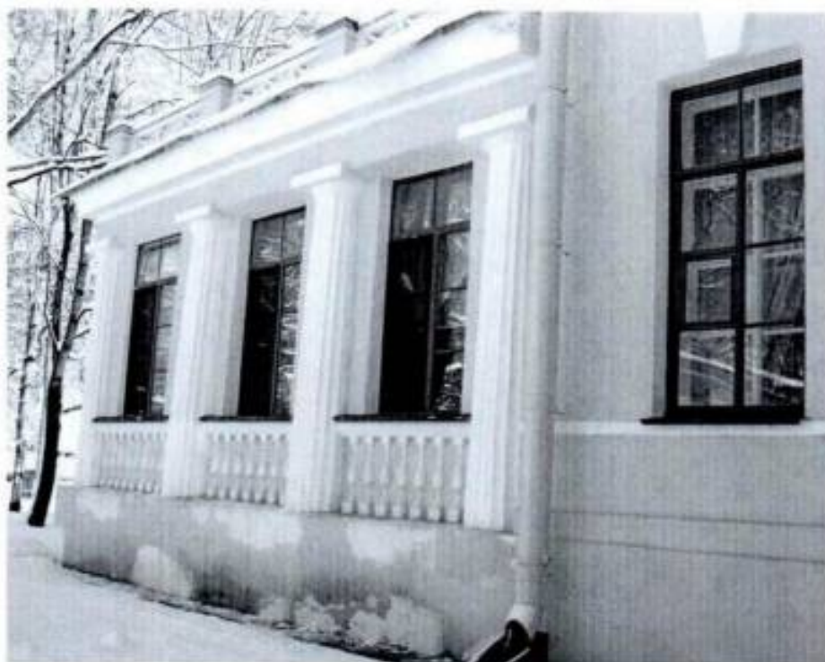
Фото 4. Фрагмент юго-западного фасада объекта культурного наследия.
