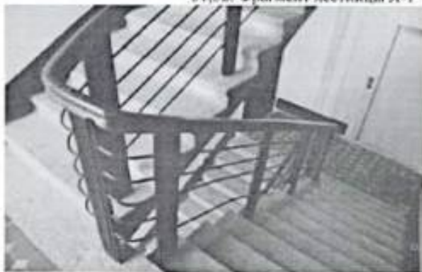
33. Фрагмент ограждения лестницы Л-1 – Л-6, Л-8
