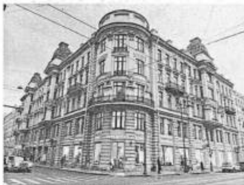
1. Лицевой фасад. Общий вид.
