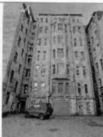
14. Северо-западный торцевой фасад.
