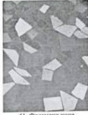
41. Фрагмент пола пом. 6-Н(12)
