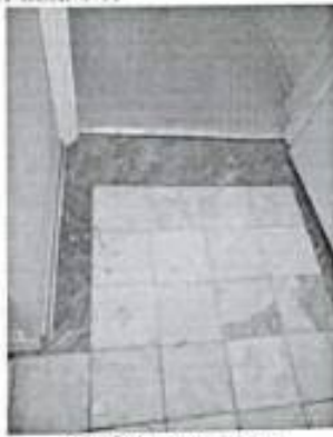
40. Фрагмент пола пом. 2-Н(13)
