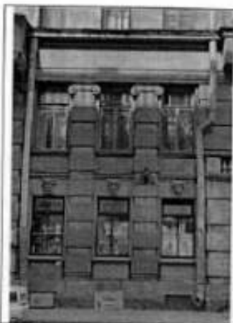
2. Фрагмент юго-западный фасада.
