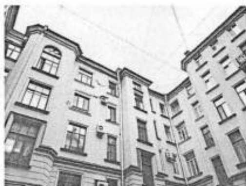
8. Дворовый фасад. Фрагмент
