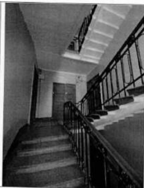
23. Лестничная клетка 5ЛК.
