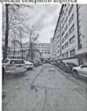
19,20,21. Фрагмент дворового фасада
