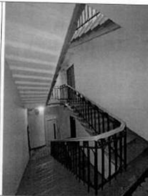
21. Лестничная клетка 4ЛК.
