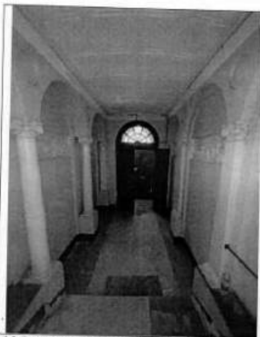
16. Вестибюль лестничной клетки 1ЛК.
