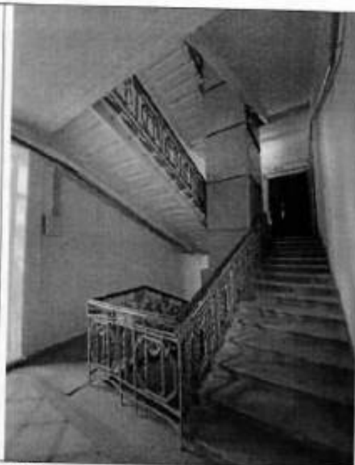
19. Лестничная клетка 2ЛК.
