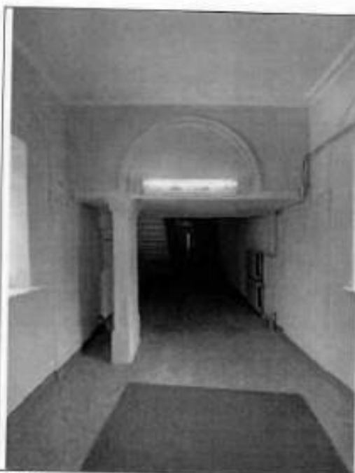
20. Вестибюль лестничной клетки 4ЛК.
