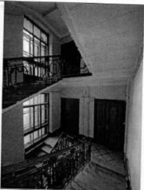
17. Лестничная клетка 1ЛК.
