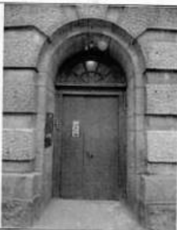
3. Фрагмент юго-западный фасада.
