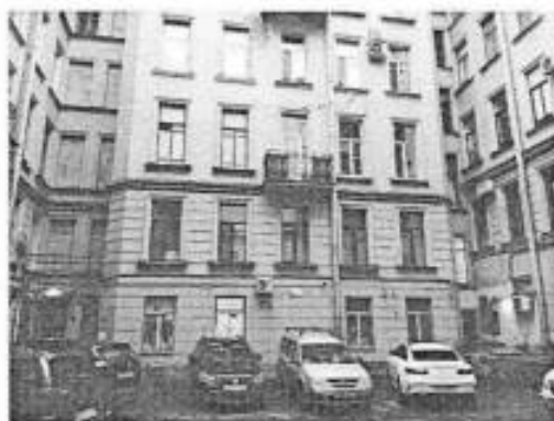
7. Дворовый фасад. Фрагмент
