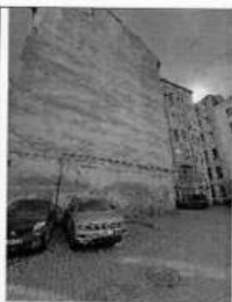
13.. Брандмауэрная стена северо-западного торцевого фасада.
