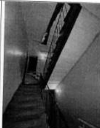
25. Лестничная клетка 6ЛК.
