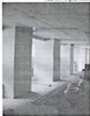
45. Фрагмент подвального пом.
