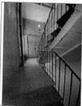
24. Лестничная клетка 3ЛК.
