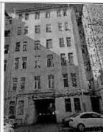
15. Юго-восточный торцевой фасад.
