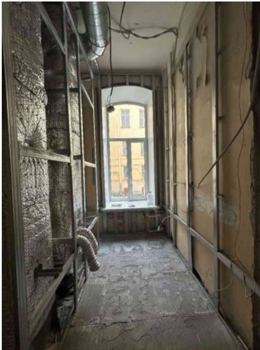
Фото 35. Помещение 2-Н. 1 этаж. Вид в сторону двора
