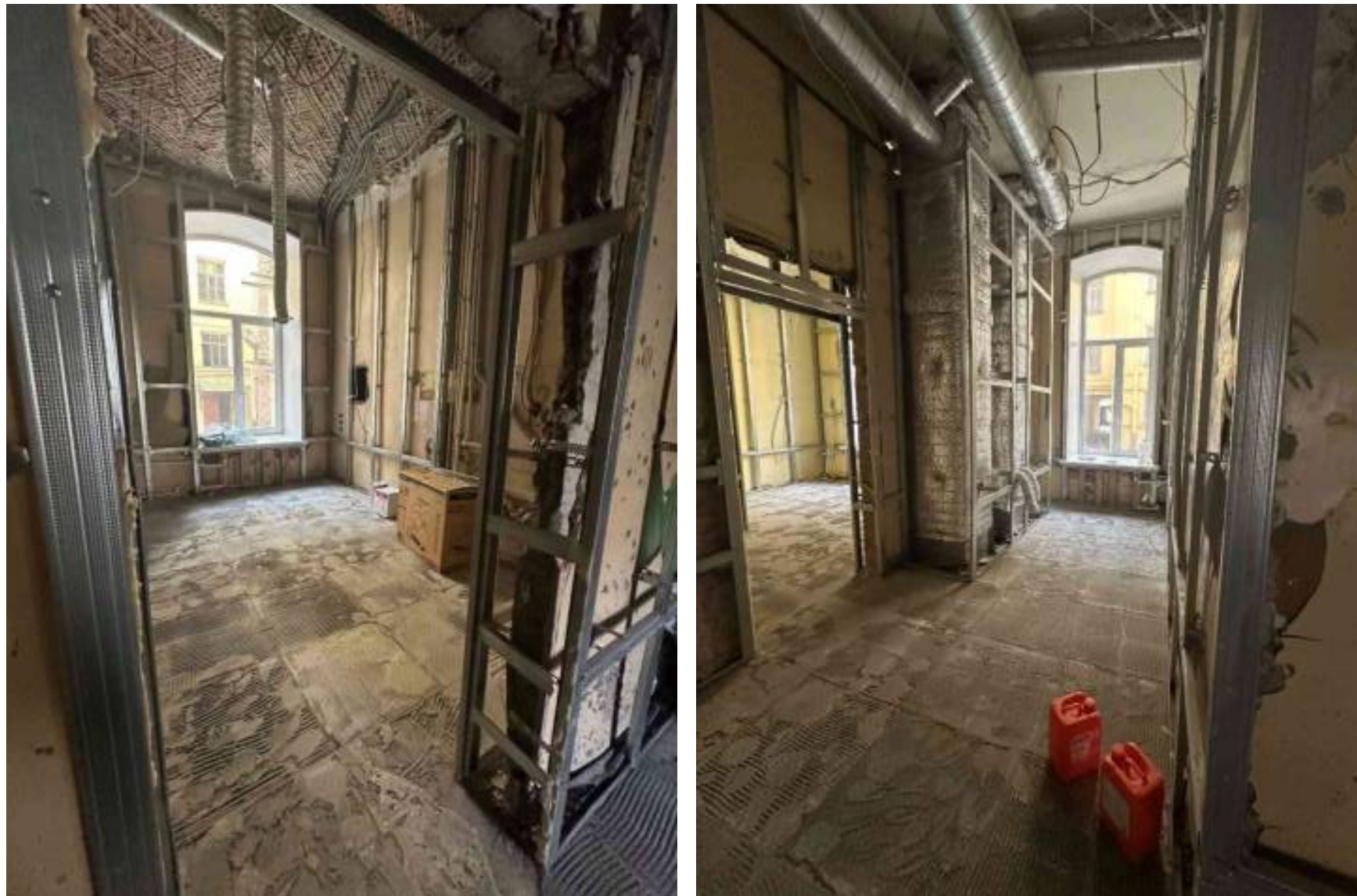
Фото 23, 24. Помещение 2-Н. 1 этаж. Вид в сторону двора
