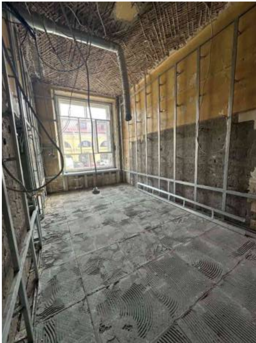
Фото 31. Помещение 2-Н. 1 этаж. Вид в сторону 7-й линии ВО
