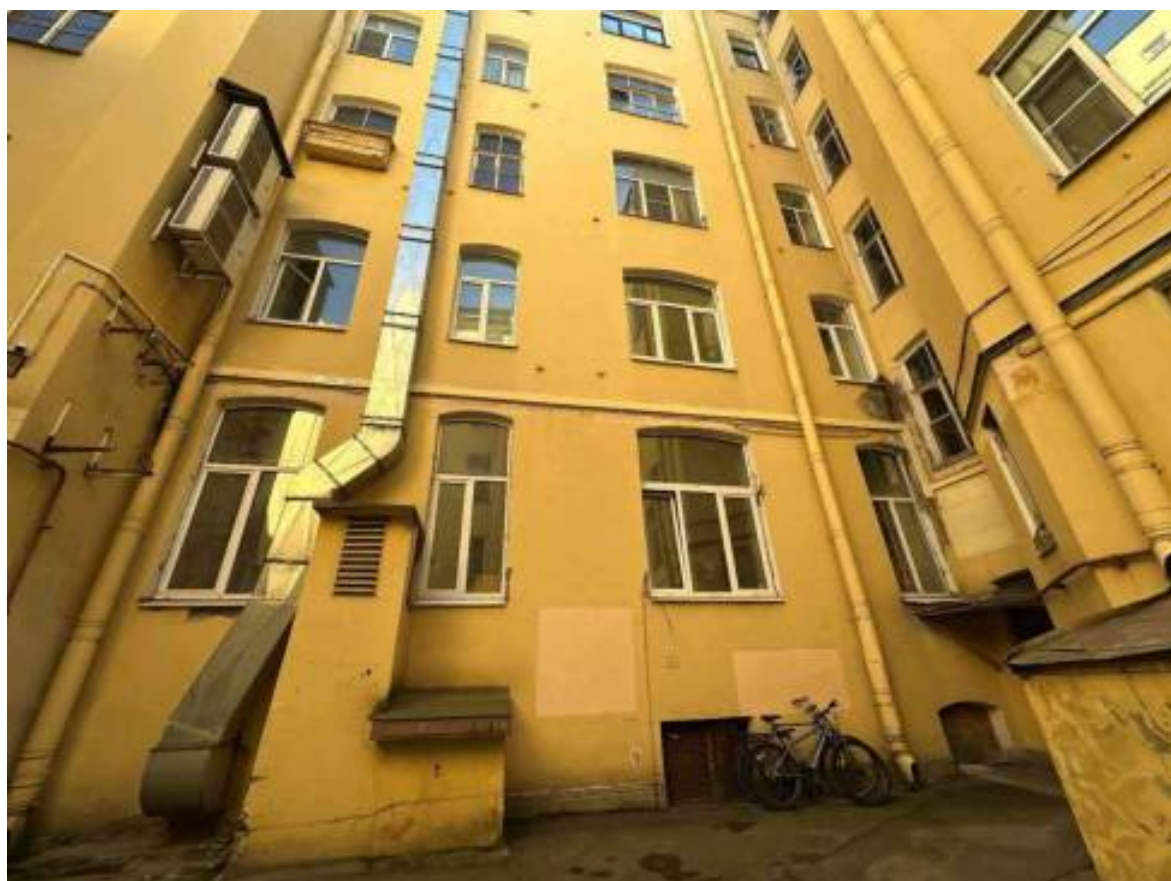
Фото 2. Общий вид здания со стороны двора
