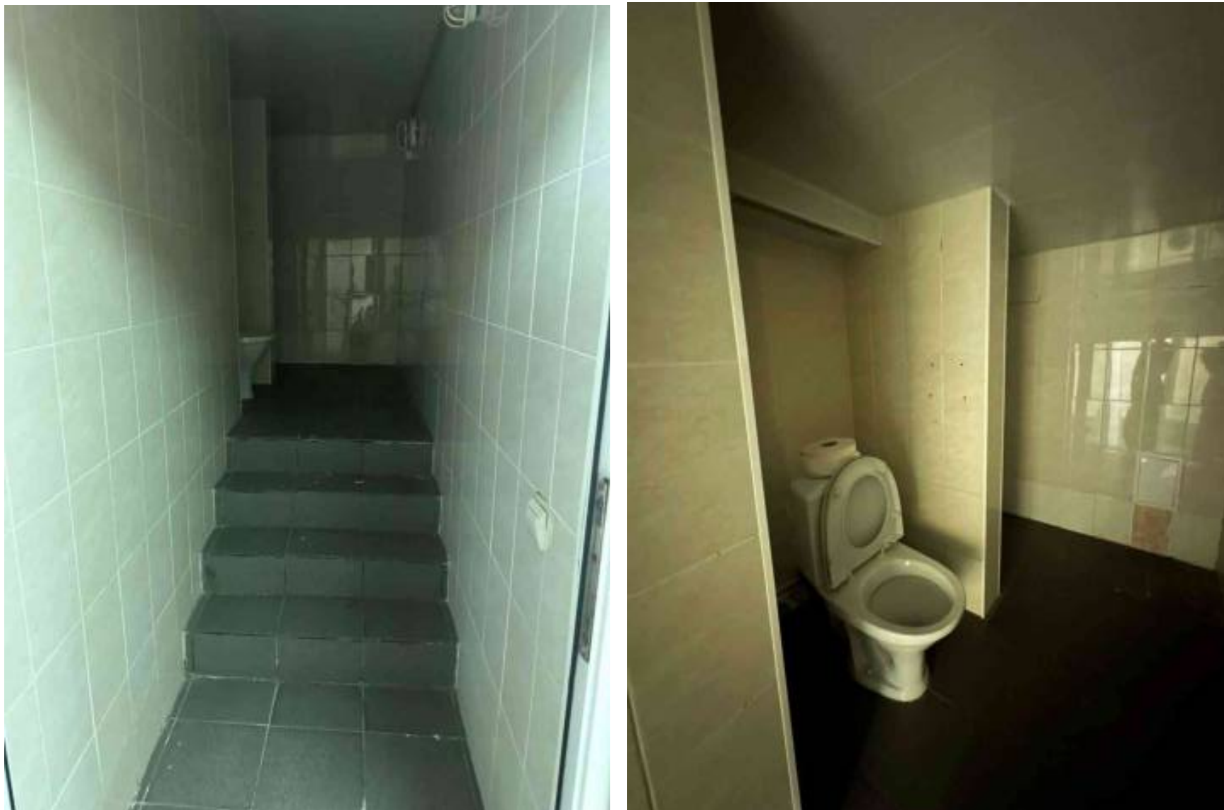
Фото 9, 10. Помещение 1-Н. Цокольный этаж. Санузел
