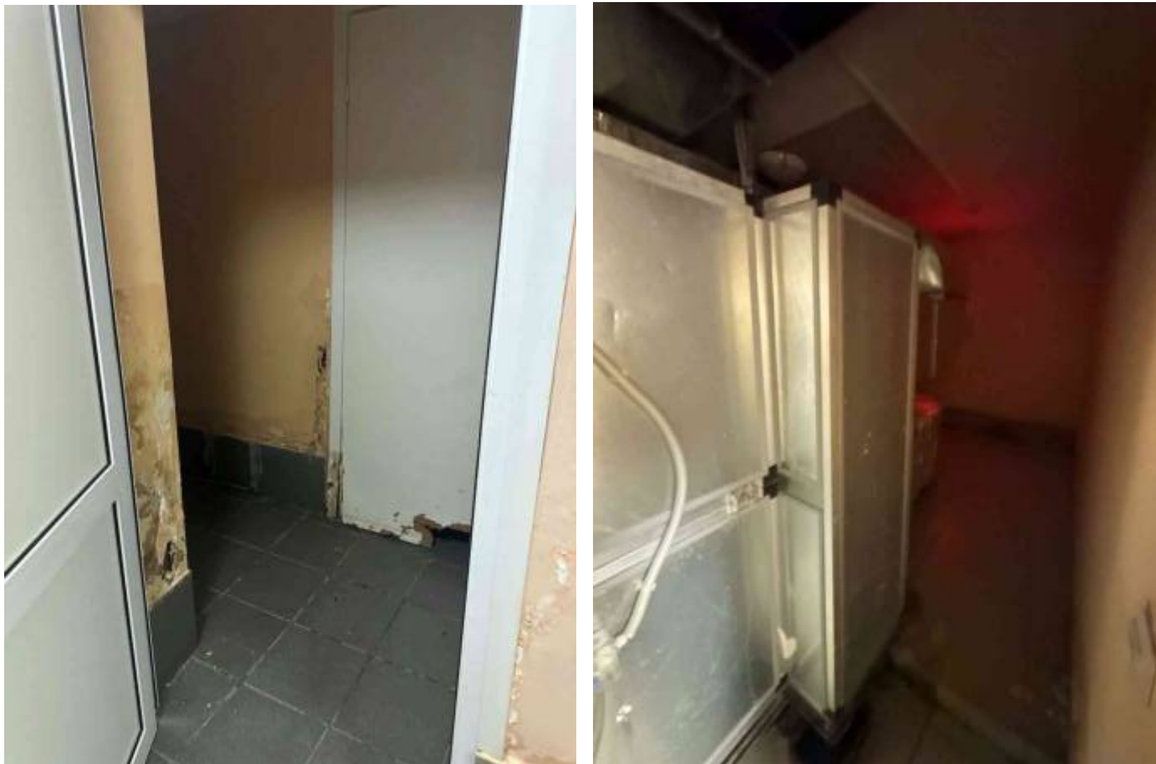
Фото 17, 18. Помещение 1-Н. Цокольный этаж
