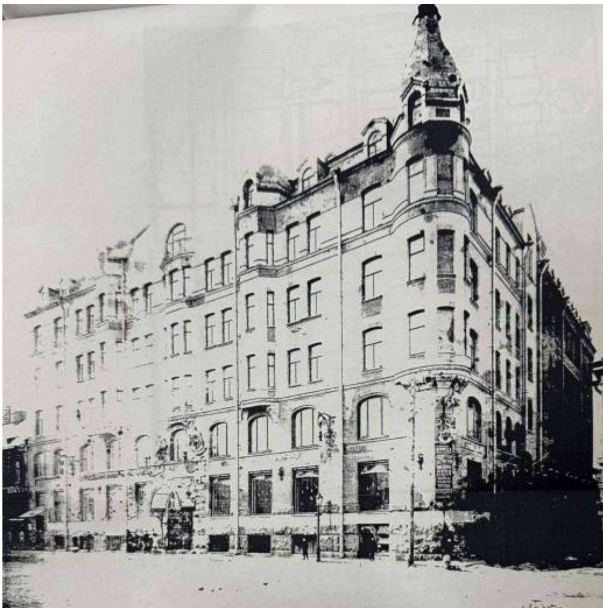
Илл. 10. Фасад здания. Архитектор З.Я.Леви, 1913г. Фотокопия. Архив ЦИАИС. Историко-архитектурный паспорт участка № 16-18
