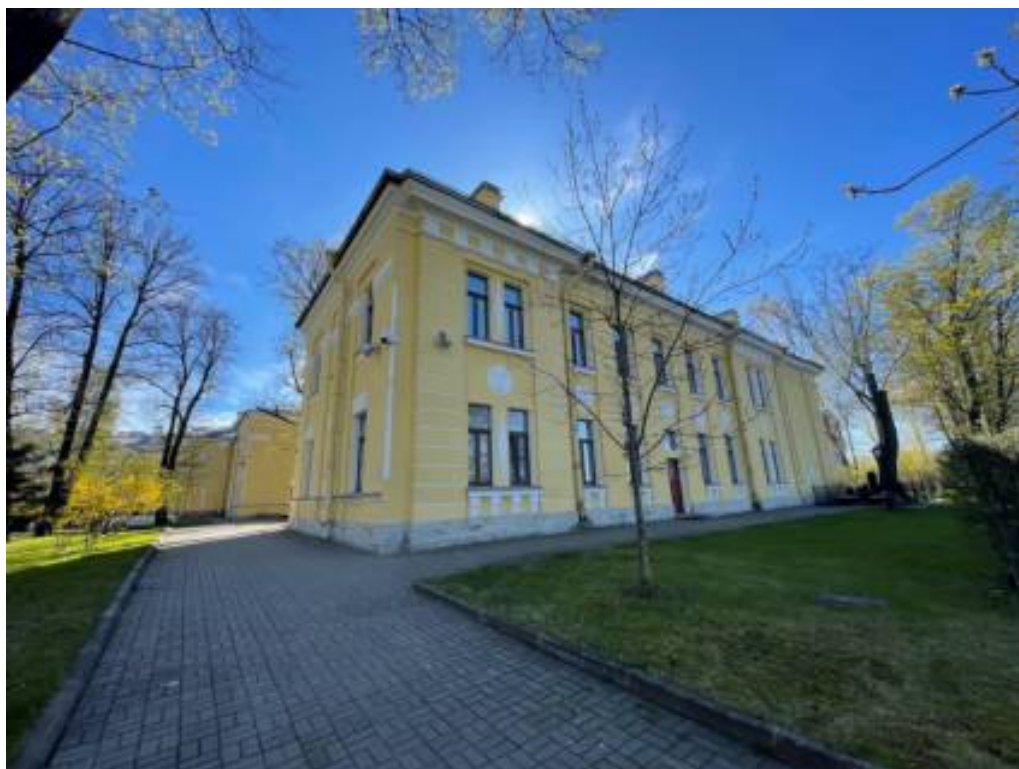
Фото 6. Фрагмент дворового фасада объекта культурного наследия федерального значения «Корпус № 1», входящего в состав объекта культурного наследия федерального значения «Дом ветеранов сцены им. М. Г. Савиной»
