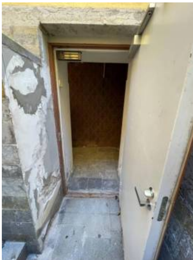
Фото 9. Фрагмент дворового фасада объекта культурного наследия федерального значения «Корпус № 1», входящего в состав объекта культурного наследия федерального значения «Дом ветеранов сцены им. М. Г. Савиной», вход на подвальный этаж
