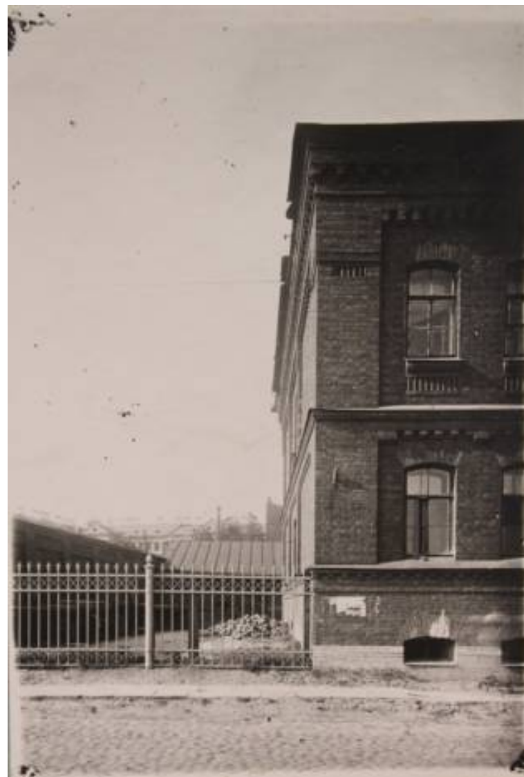
Вид на участок Дома предварительного заключения на Арсенальной набережной. Фрагмент фасада жилого флигеля (совр. лит. А). 1938 г. // ЦГА КФФД СПб. Фотодокументы. Описание 1ГР-51. Ед.хр.77553.
