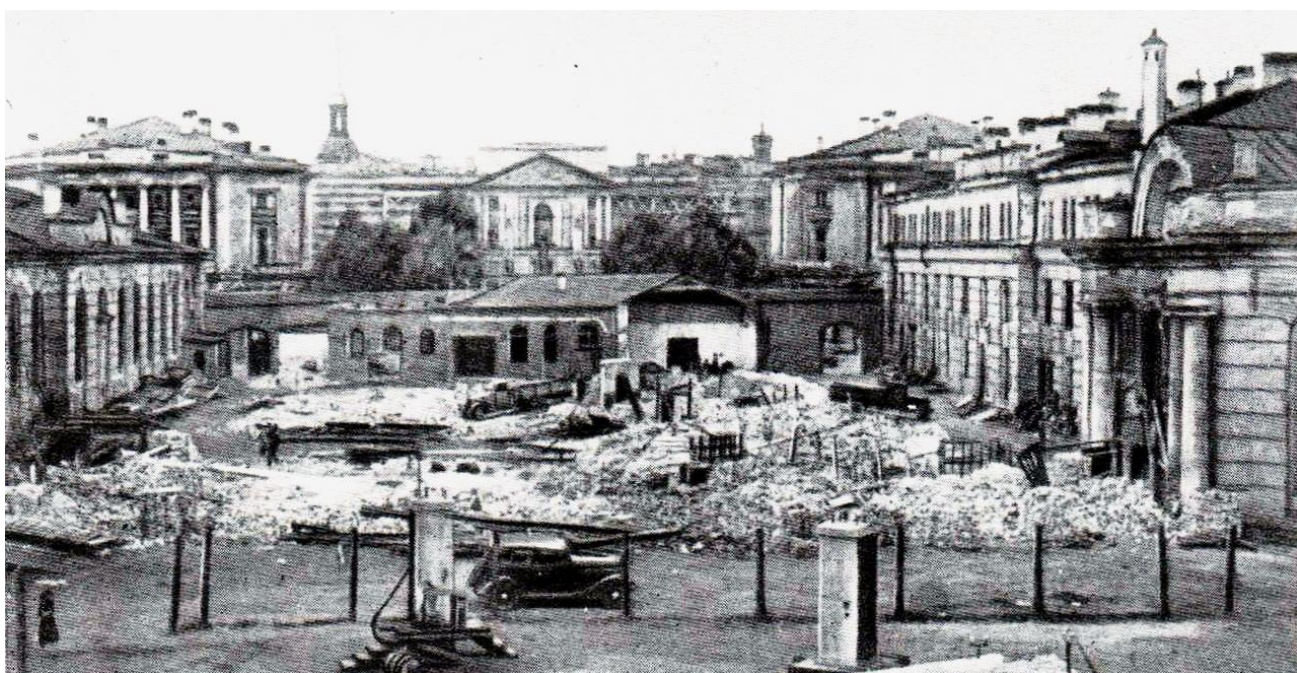
Илл. 10. СПб, Михайловский (Инженерный) замок в центре и Манеж (слева), Конюшни (справа) в процессе слома на кирпич связующий «коридорный» корпус между Манежем и Конюшнями. Виден (еще почти цел) такой же корпус по Инженерной ул. Вид с юга, фото 1948-49.
