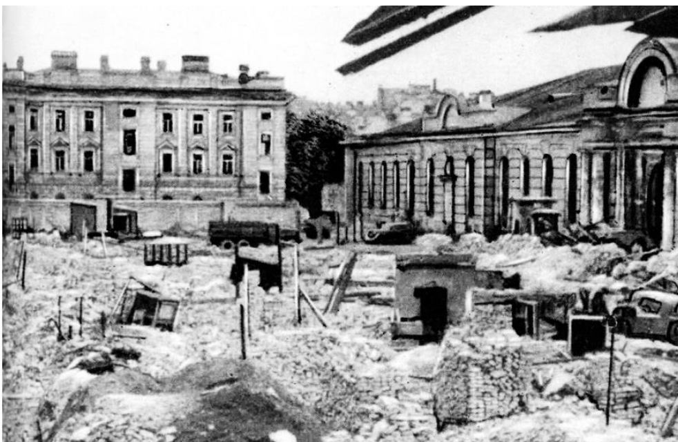
Илл. 9. СПб, слева дом №4 по Манежной пл., (б. Дом Офицеров свиты) и Манеж (справа) в процессе слома на кирпич связующий «коридорный» корпус между Манежем и Конюшнями. Вид с севера, фото 1948-49.
