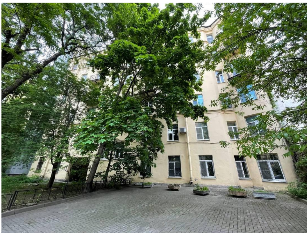
Фото 4. Фрагмент дворового фасада объекта культурного наследия «Дом по набережной канала Грибоедова», входящего в состав выявленного объекта культурного наследия «Дома Я.А. Фохтса (Ф.М и М.М. Богомольцев)»
