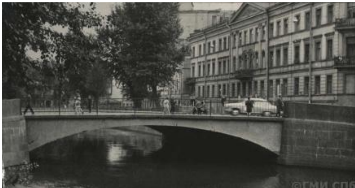
17. Харламов мост (Комсомольский мост), дом № 119-121. 1950-1960-е гг. — СПб ГБУК «Государственный музей истории Санкт-Петербурга» [Электронный ресурс]. URL: https://goskatalog.ru/portal/#/collections?id=14842070
