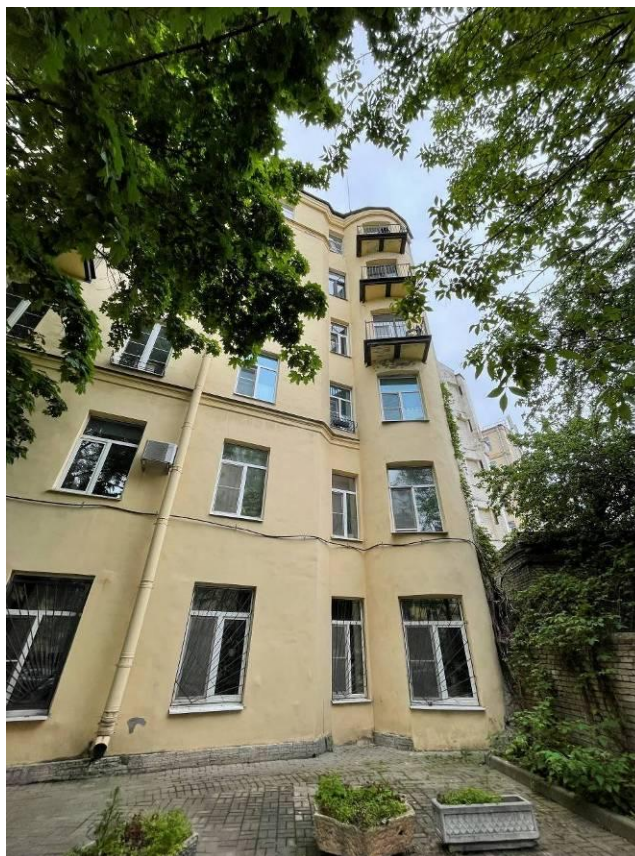
Фото 5. Фрагмент дворового фасада объекта культурного наследия «Дом по набережной канала Грибоедова», входящего в состав выявленного объекта культурного наследия «Дома Я.А. Фохтса (Ф.М и М.М. Богомольцев)»
