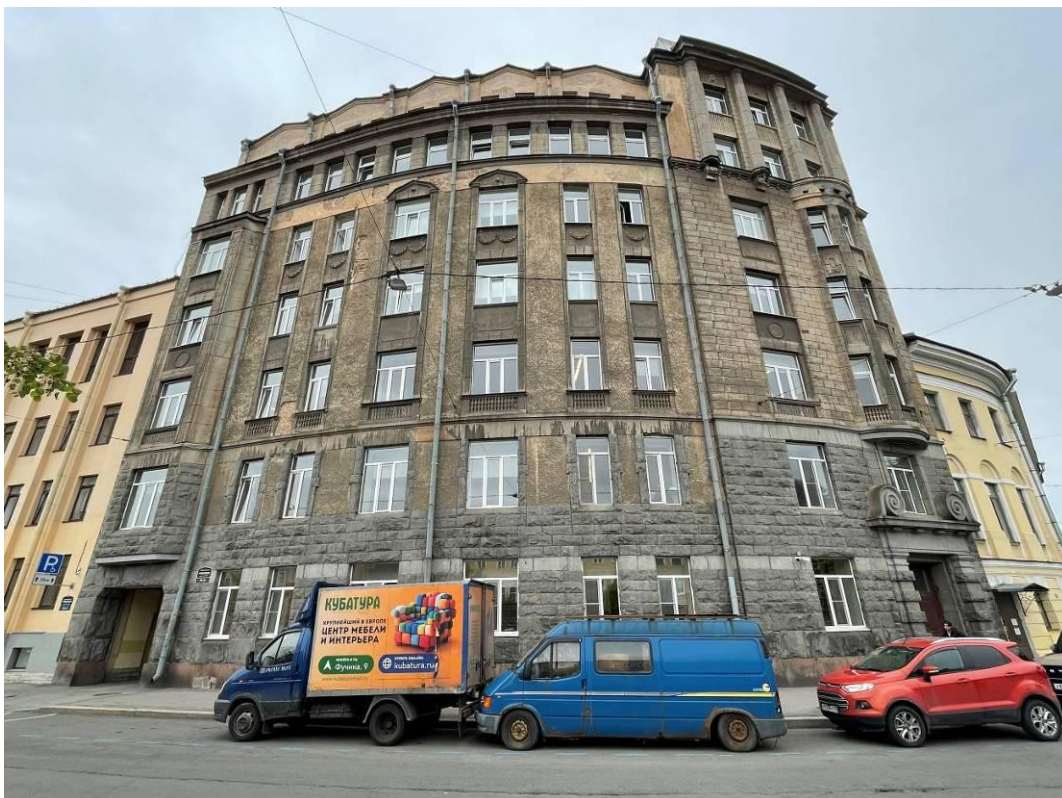
Фото 1. Лицевой фасад выявленного объекта культурного наследия «Дом по набережной канала Грибоедова», входящего в состав выявленного объекта культурного наследия «Дома Я.А. Фохтса (Ф.М и М.М. Богомольцев)»
