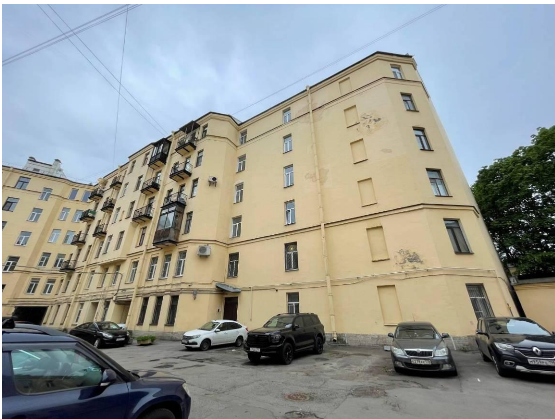
Фото 2. Фрагмент дворового фасада объекта культурного наследия «Дом по набережной канала Грибоедова», входящего в состав выявленного объекта культурного наследия «Дома Я.А. Фохтса (Ф.М и М.М. Богомольцев)»
