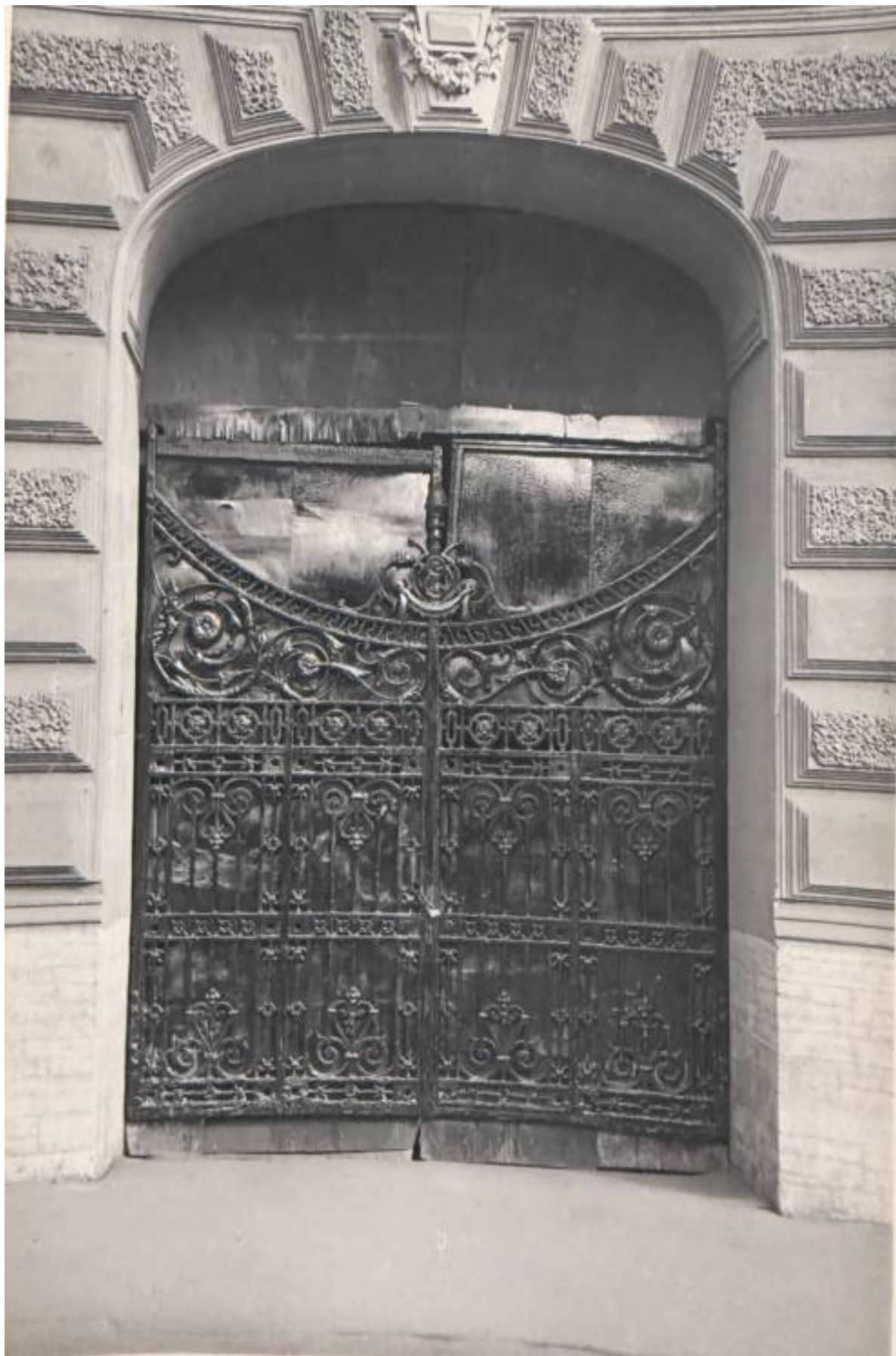
25. Воротный проезд. Фото. 1961 г. // Источник: Архив КГИОП.
