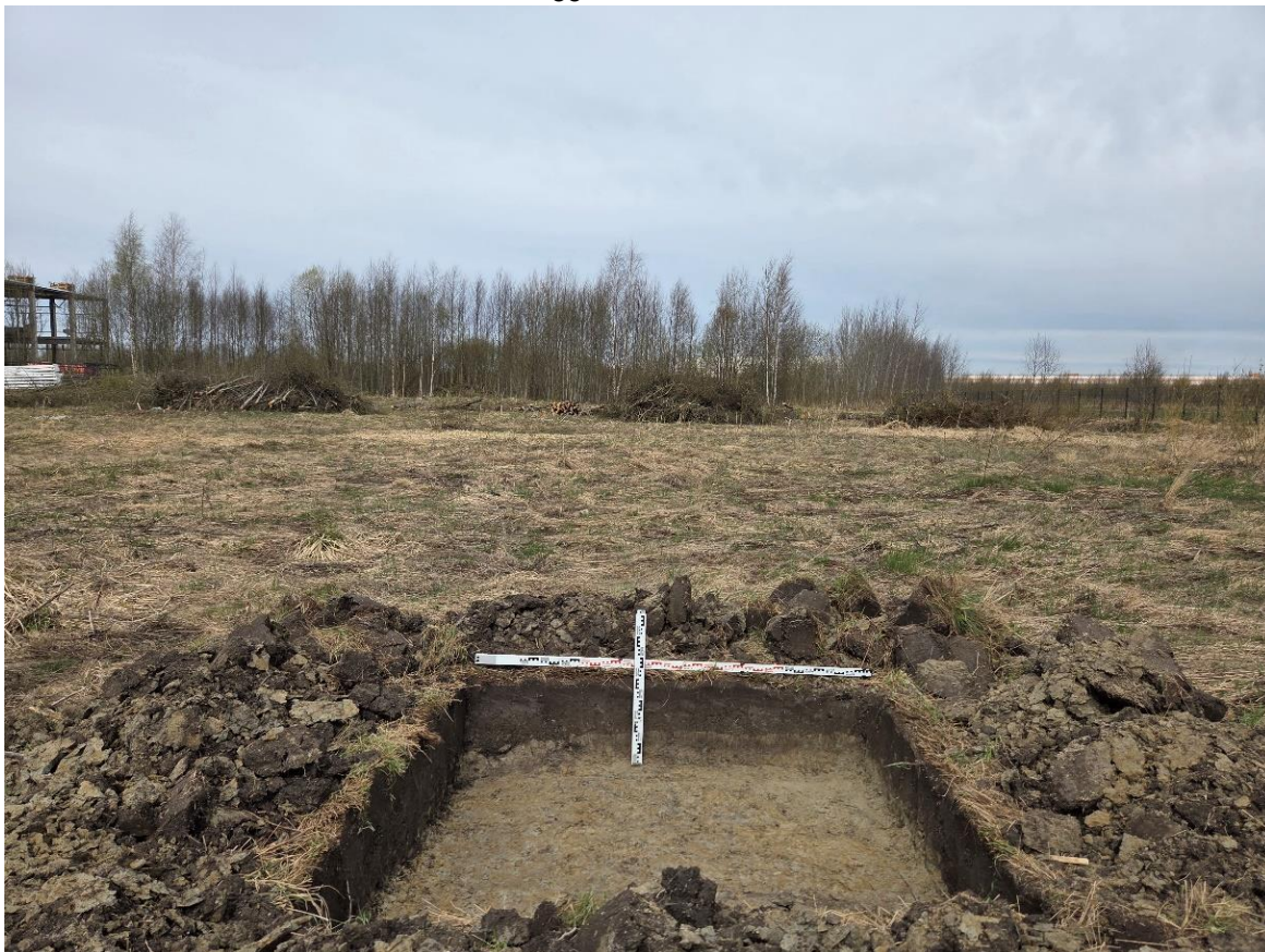
Рис. 24. СПб-2026. г. Петергоф, территория Марьино, земельный участок 78:40:1911602:3236. Шурф 2. Общий вид по окончанию работ. Вид с Ю.
