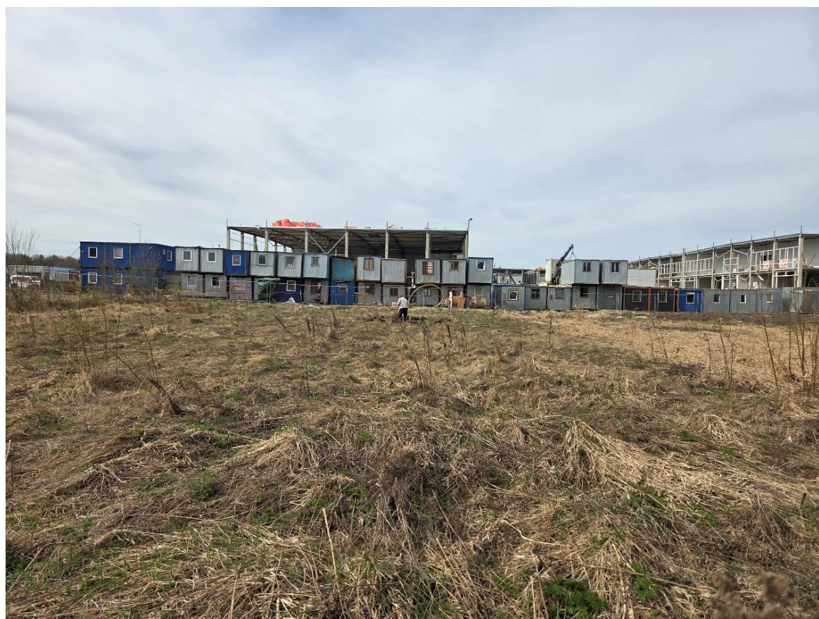
Рис. 13. СПб-2026. г. Петергоф, территория Марьино, земельный участок 78:40:1911602: 3236. Общий вид участка обследования. Точка фотофиксации 2. Вид с В.
