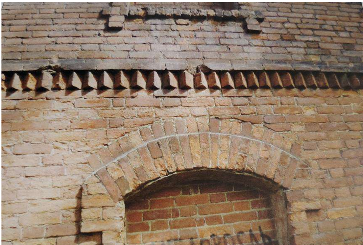
Илл. 81. Вид на междуэтажную тягу в уровне 1-го – 2-го этажей восточного корпуса. 2013 г. (источник: архив КГИОП. П. 1155. Н-14436).
