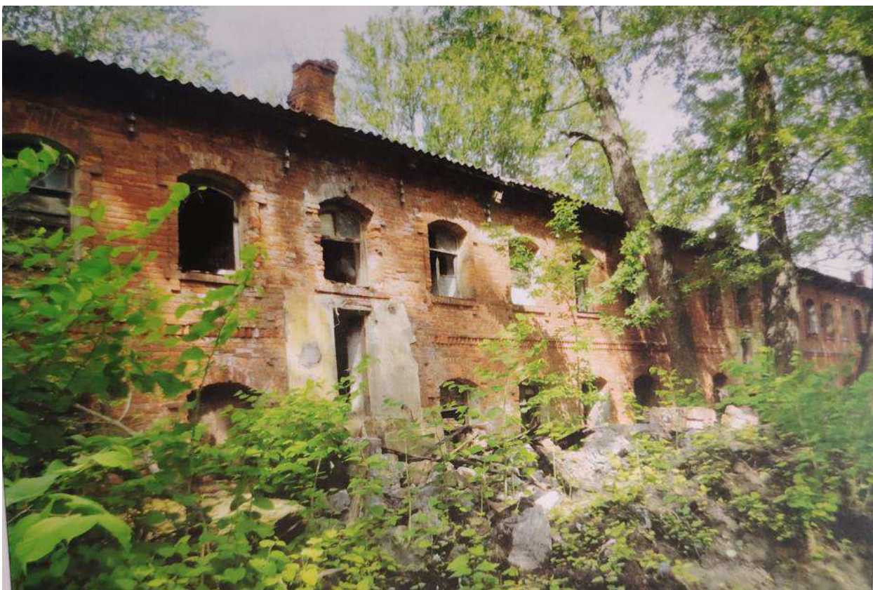
Илл. 59. Две казармы для служащих. Восточный фасад западного корпуса. 2013 г. (источник: архив КГИОП. П. 1155. Н-14436).
