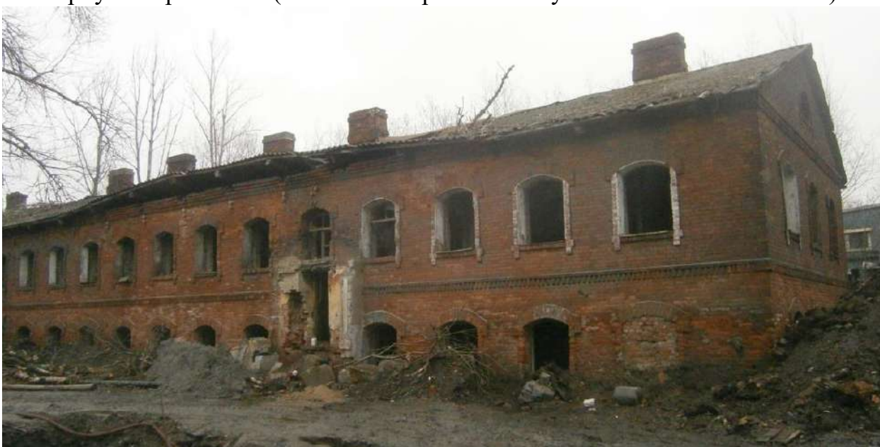
Илл. 90. Две казармы для служащих Варшавского вокзала. Вид на восточный корпус. Март 2017 г. (источник: https://www.citywalls.ru/house28073.html ).
