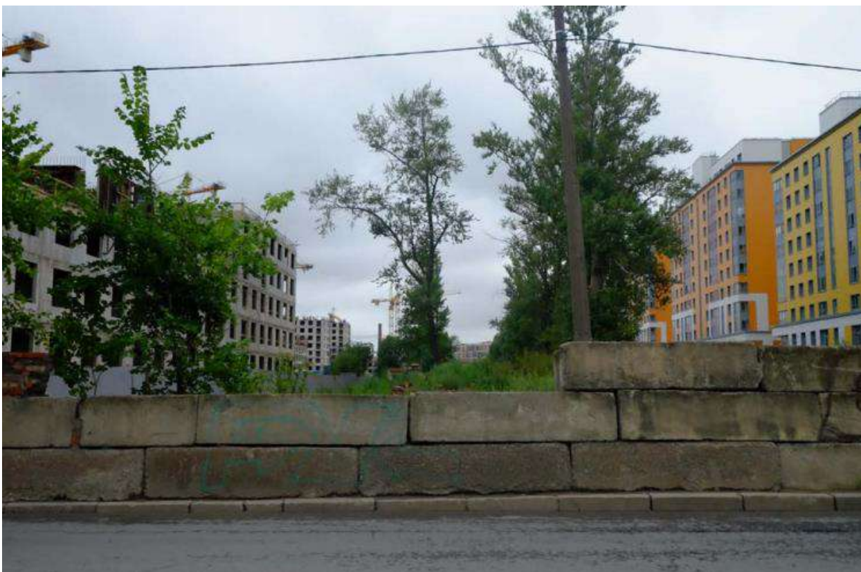
Илл. 93. Две казармы для служащих. Вид с юга. 2021 г. (источник: архив КГИОП. Вх. от 11.10.2021 № 01-26-2300/21-0-0).
