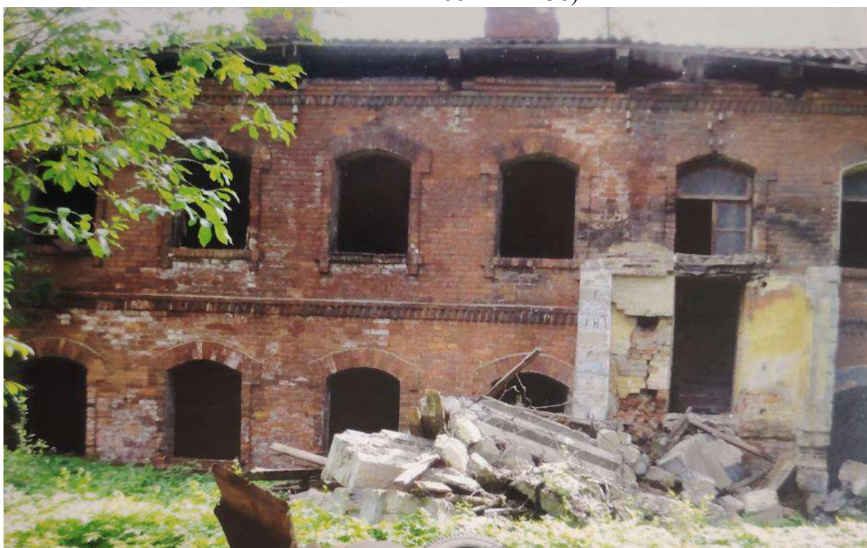
Илл. 77. Вид на западный фасад восточного корпуса. 2013 г. (источник: архив КГИОП. П. 1155. Н-14436).
