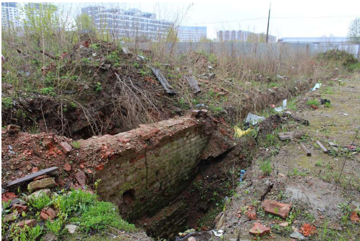
Фото 19. Вид на выявленный объект культурного наследия «Две казармы для служащих Варшавского вокзала с юго-запада», фрагменты фундаменты и кирпичной стены западного корпуса.
