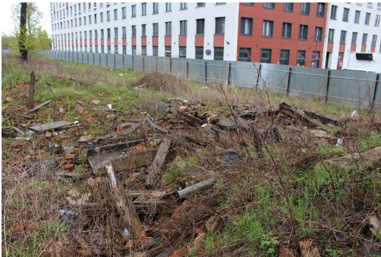
Фото 25. Вид на выявленный объект культурного наследия «Две казармы для служащих Варшавского вокзала с юго-запада», вид на запад.
