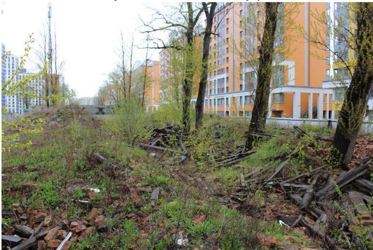
Фото 20. Вид на выявленный объект культурного наследия «Две казармы для служащих Варшавского вокзала с юго-запада», вид на север.
