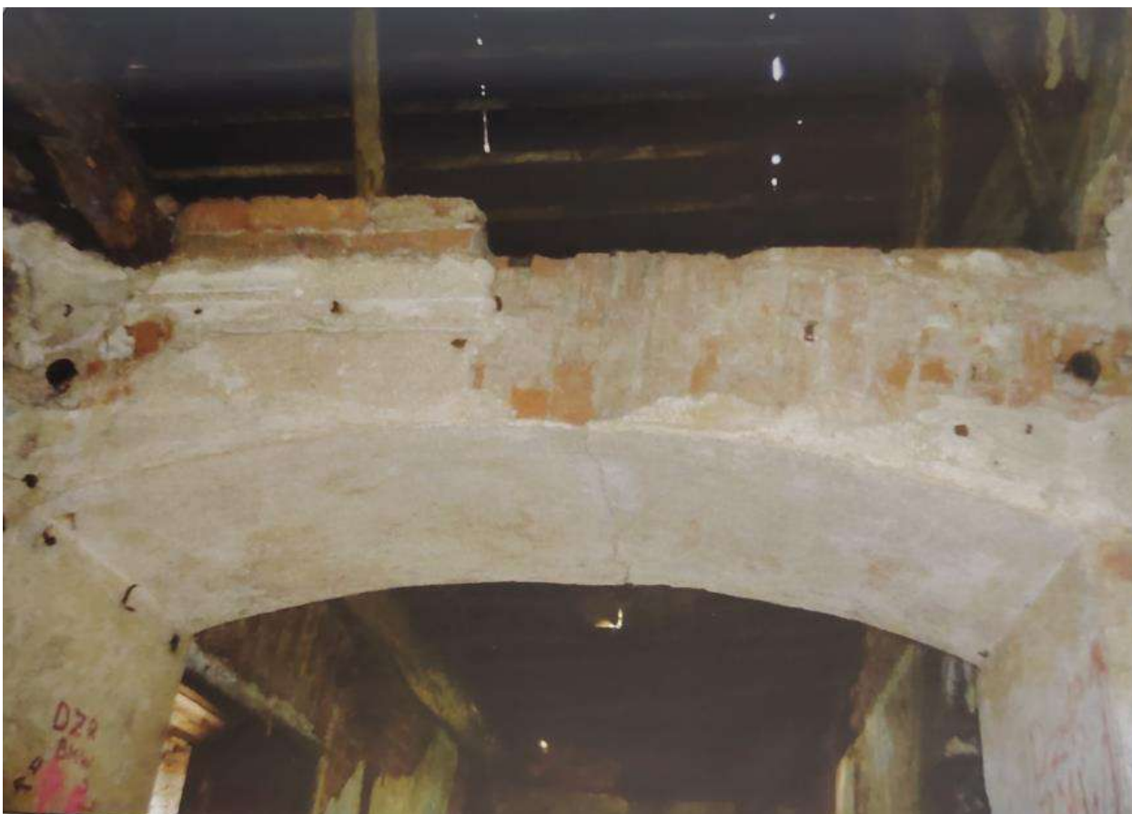
Илл. 67. Две казармы для служащих. Внутренние помещения западного корпуса. 2013 г. (источник: архив КГИОП. П. 1155. Н-14436).
