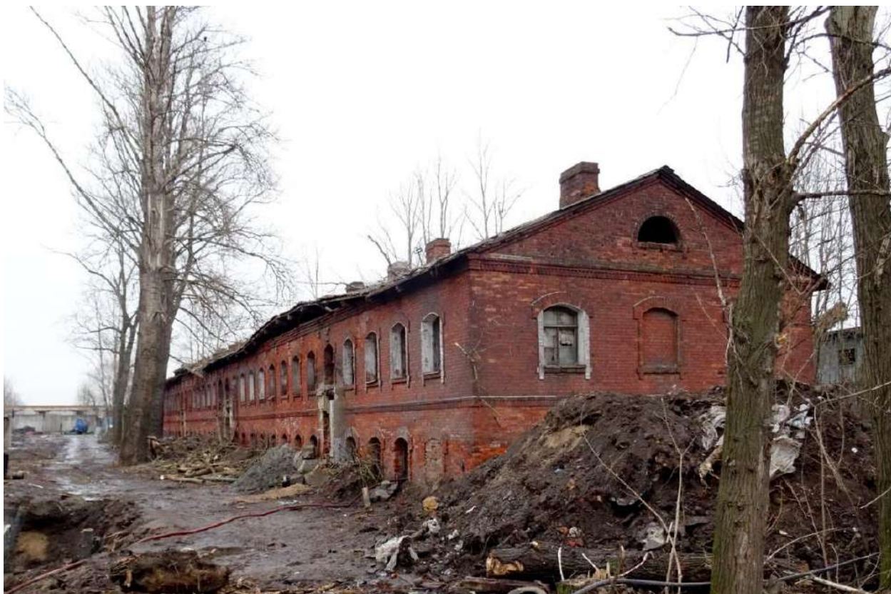
Илл. 87. Две казармы для служащих Варшавского вокзала. Вид на восточный корпус. Март 2017 г. (источник: https://www.citywalls.ru/house28073.html ).
