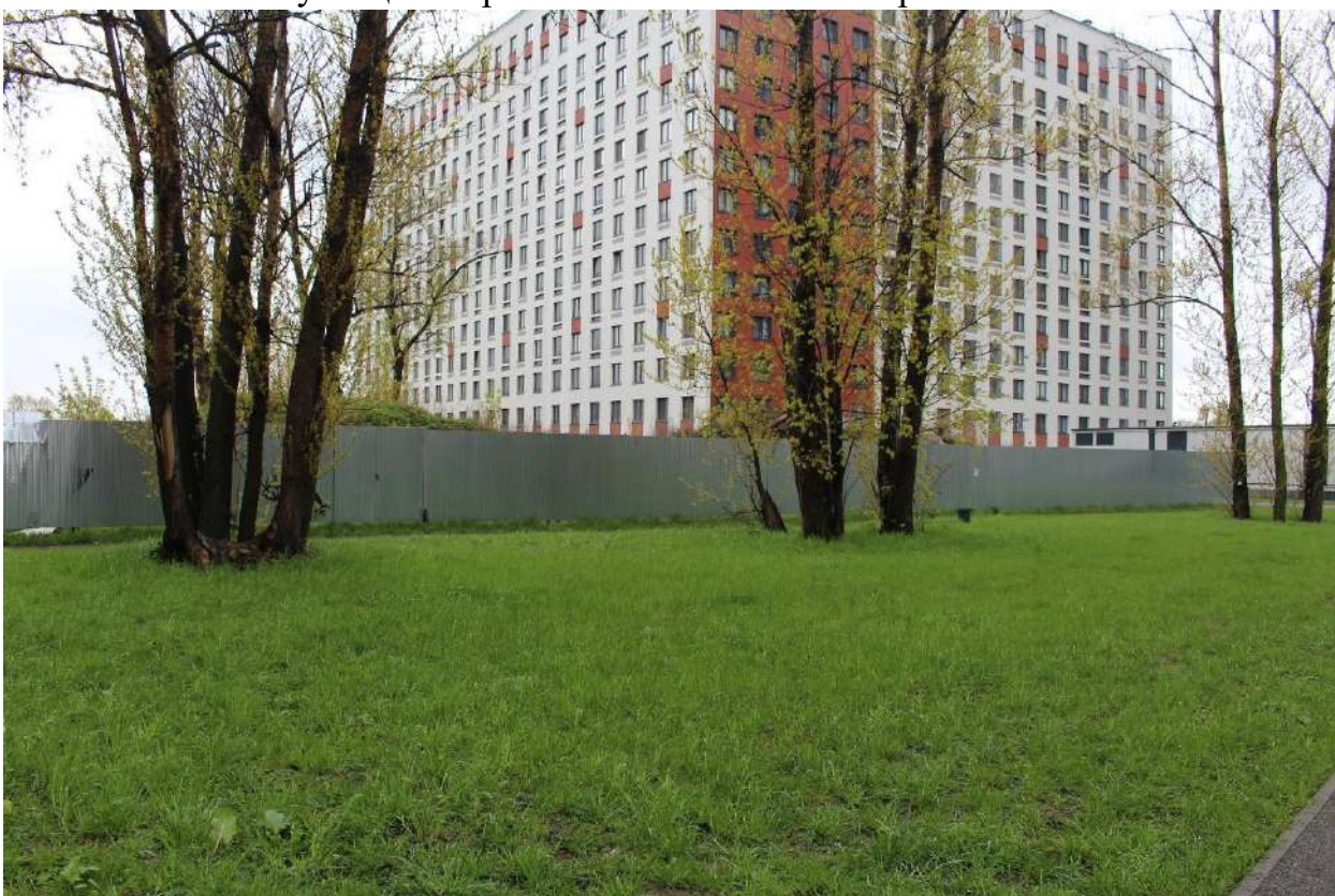
Фото 2. Вид на выявленный объект культурного наследия «Две казармы для служащих Варшавского вокзала с северо-востока».
