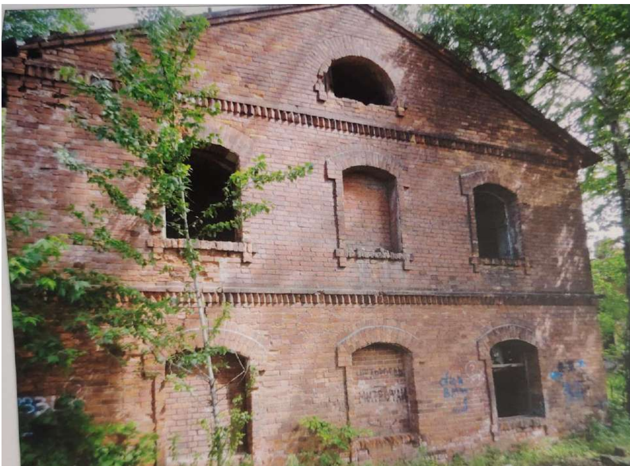
Илл. 54. Две казармы для служащих. Южный торцевой фасад западного корпуса. 2013 г. (источник: архив КГИОП. П. 1155. Н-14436).
