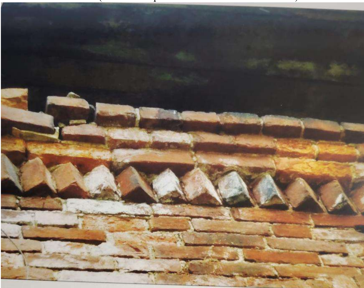
Илл. 62. Фрагмент венчающего карниза западного корпуса. 2013 г. (источник: архив КГИОП. П. 1155. Н-14436).
