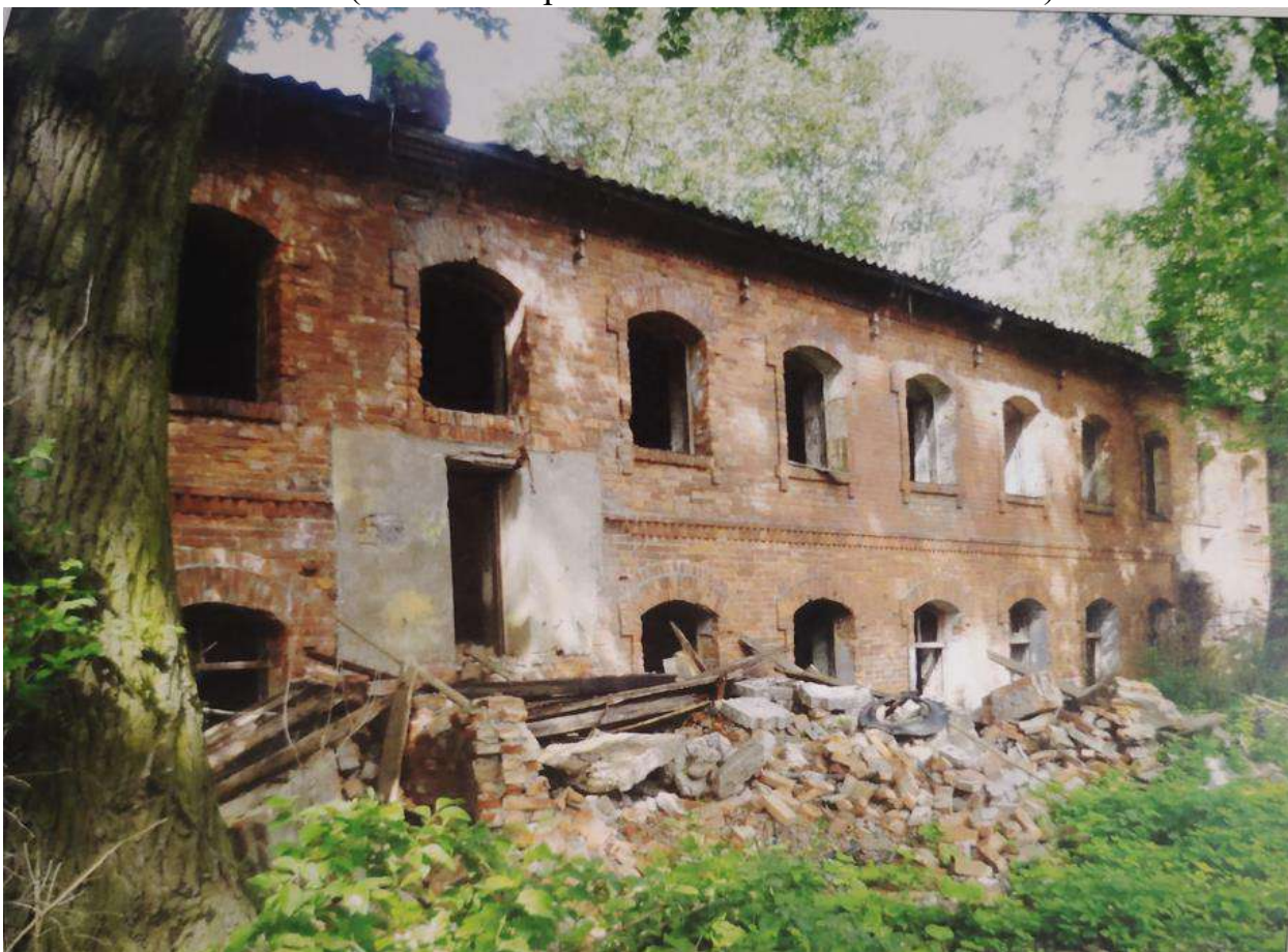
Илл. 60. Две казармы для служащих. Восточный фасад западного корпуса. 2013 г. (источник: архив КГИОП. П. 1155. Н-14436).
