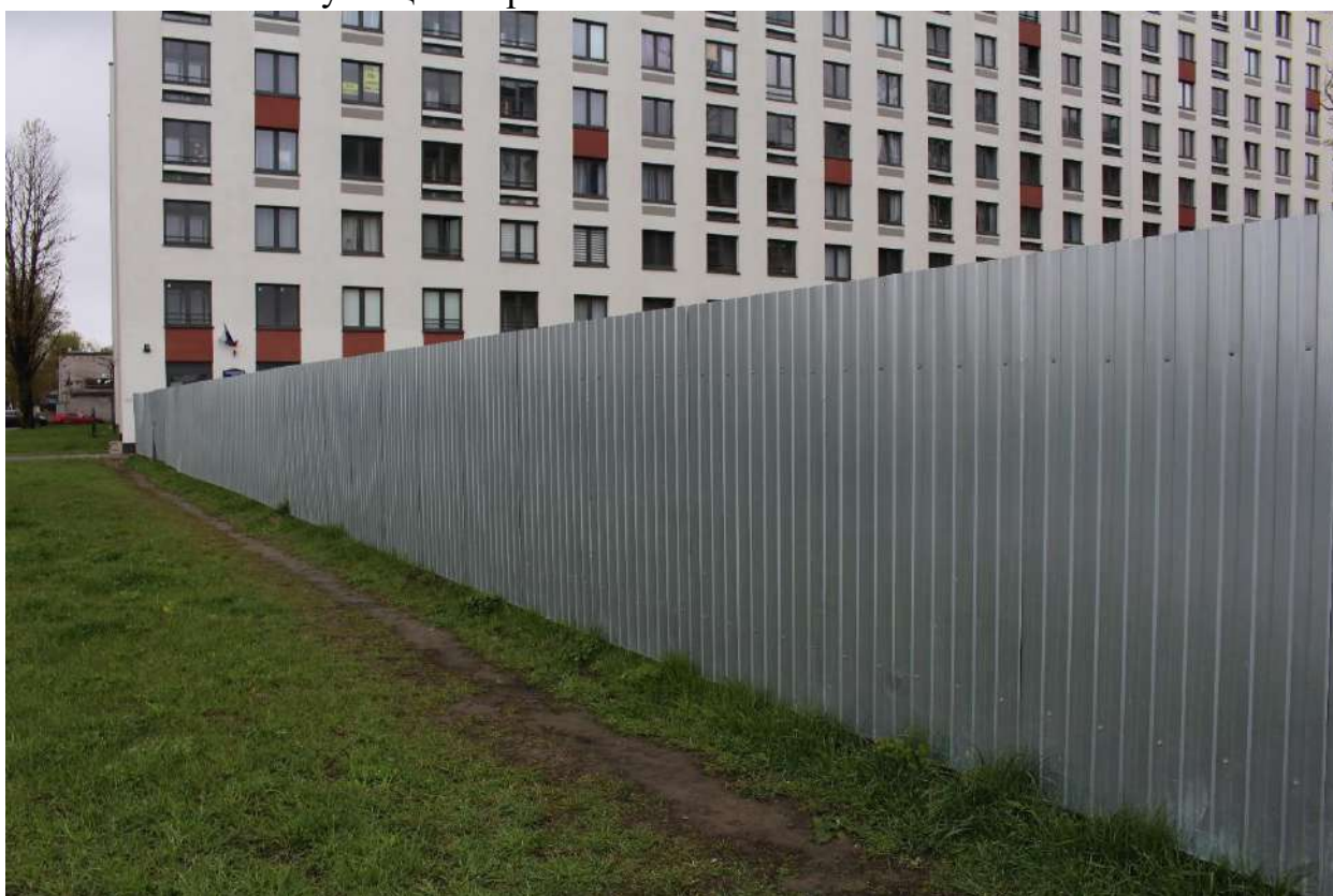
Фото 4. Вид на выявленный объект культурного наследия «Две казармы для служащих Варшавского вокзала с юго-востока».
