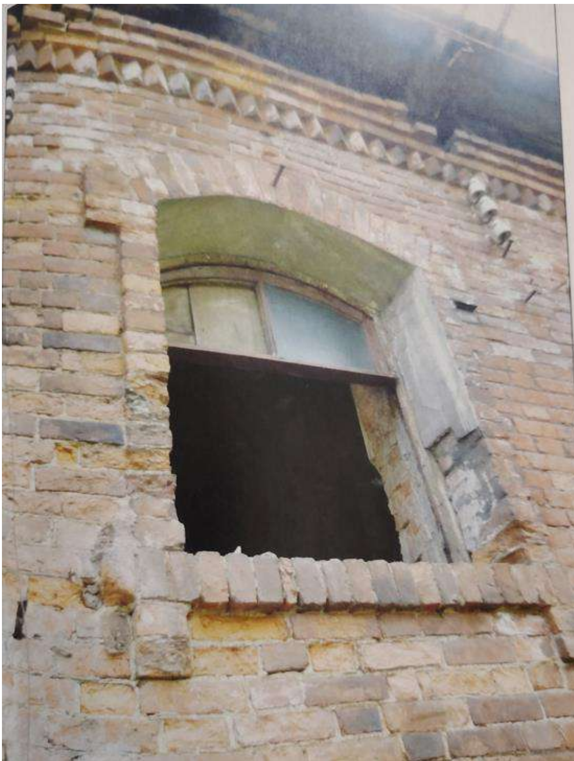
Илл. 80. Вид на окно 2-го этажа восточного корпуса. 2013 г. (источник: архив КГИОП. П. 1155. Н-14436).
