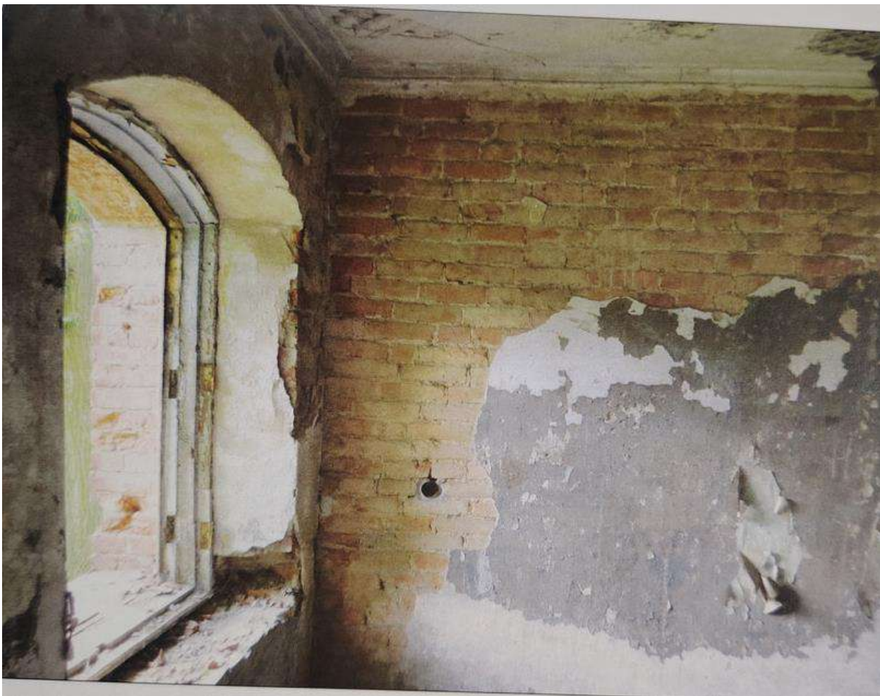
Илл. 70. Две казармы для служащих. Внутренние помещения 2-го этажа западного корпуса. 2013 г. (источник: архив КГИОП. П. 1155. Н-14436).
