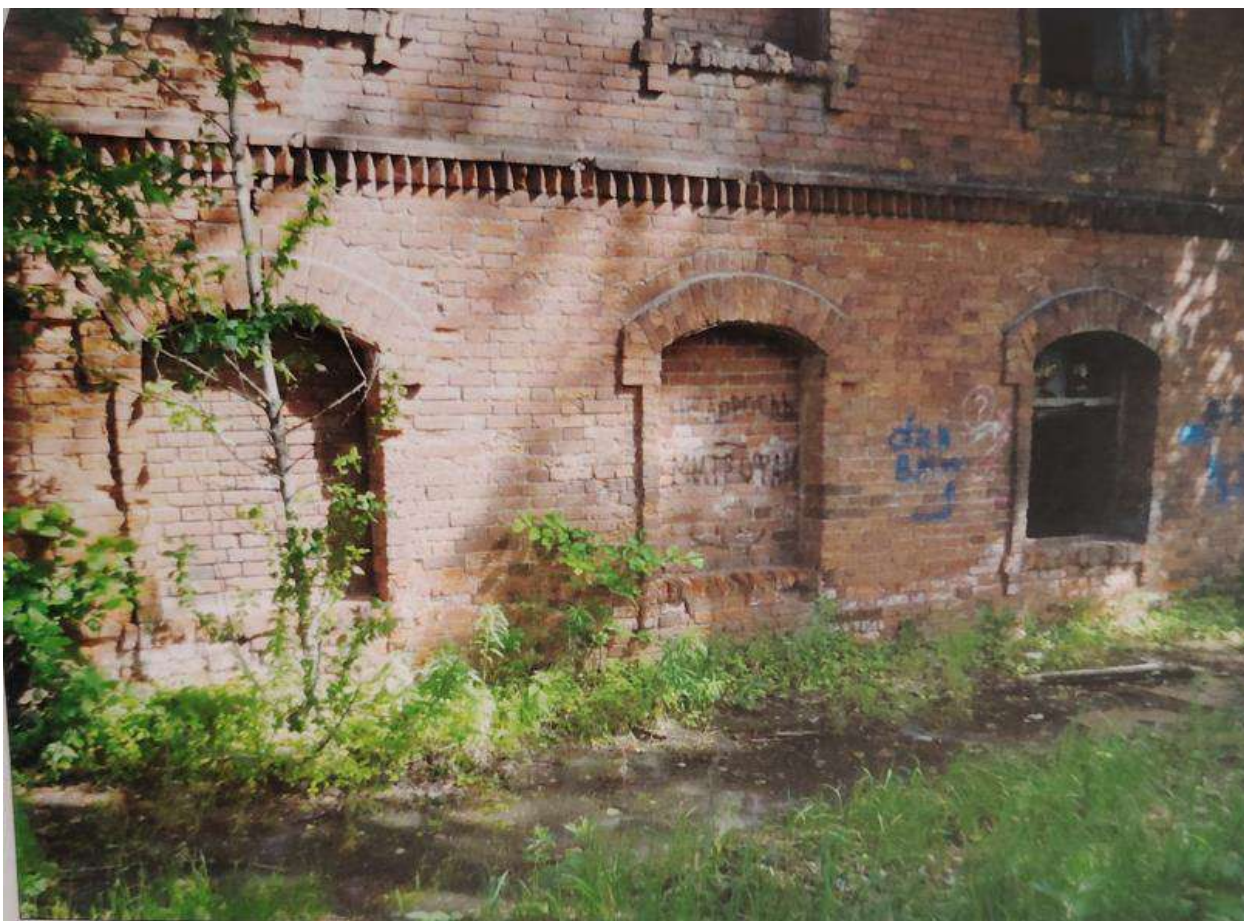
Илл. 56. Две казармы для служащих. Южный торцевой фасад западного корпуса. 2013 г. (источник: архив КГИОП. П. 1155. Н-14436).
