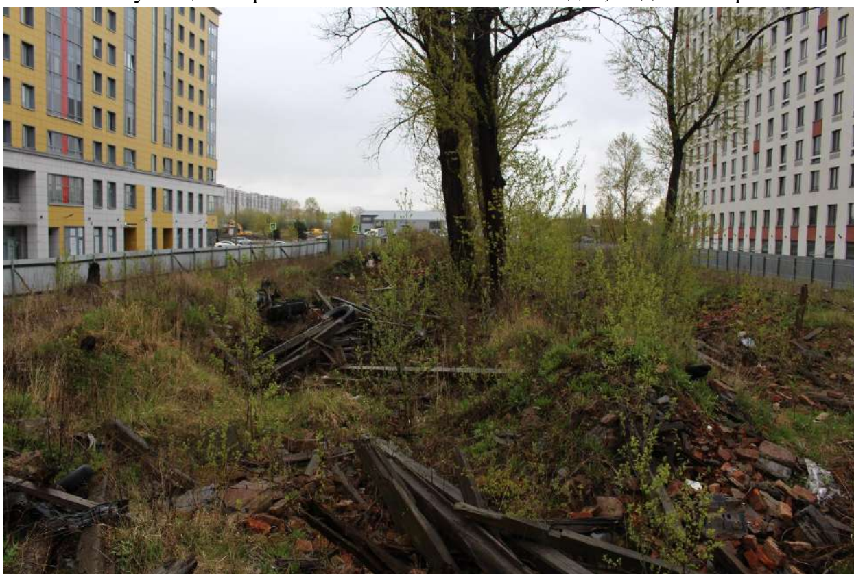
Фото 24. Вид на выявленный объект культурного наследия «Две казармы для служащих Варшавского вокзала с юго-запада», вид с севера.
