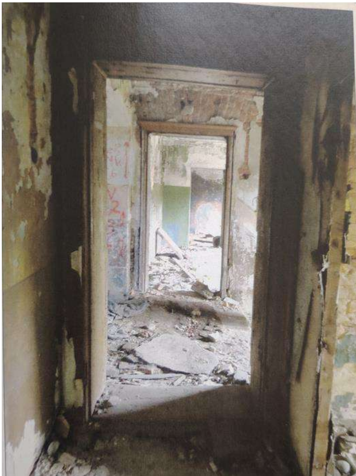
Илл. 69. Две казармы для служащих. Внутренние помещения 2-го этажа западного корпуса. 2013 г. (источник: архив КГИОП. П. 1155. Н-14436).
