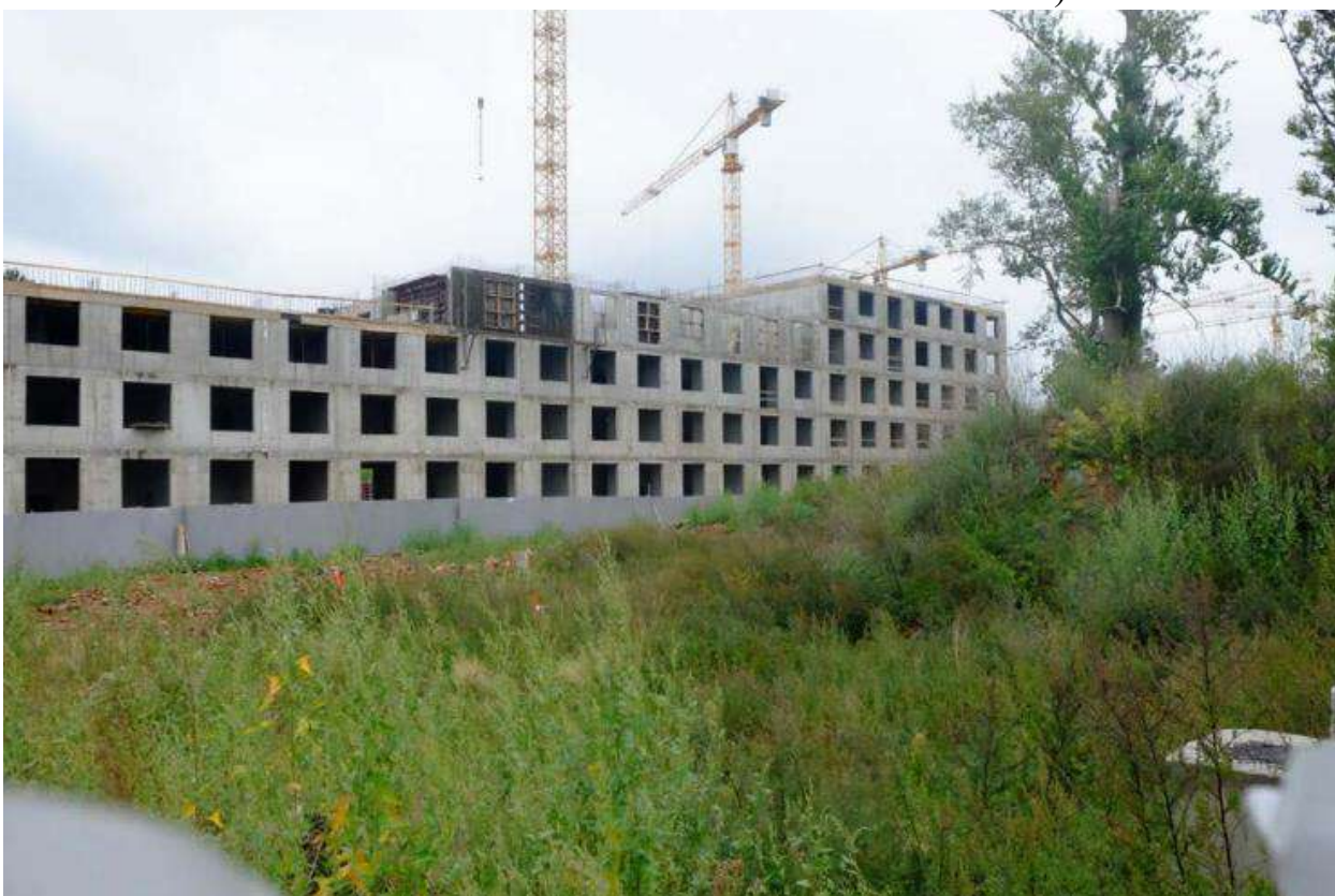
Илл. 94. Две казармы для служащих. Вид с юго-востока. 2021 г. (источник: архив КГИОП. Вх. от 11.10.2021 № 01-26-2300/21-0-0).
