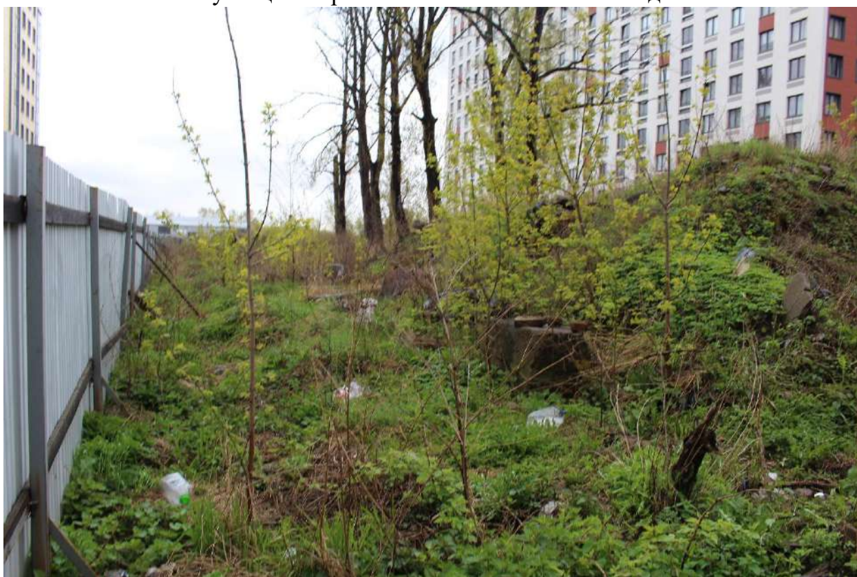
Фото 6. Вид на выявленный объект культурного наследия «Две казармы для служащих Варшавского вокзала с юго-запада» с северо-востока.
