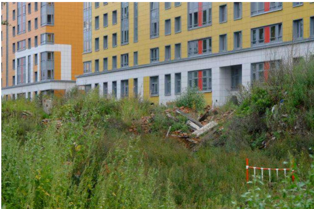
Илл. 97. Две казармы для служащих. Вид с юго-запада. 2021 г. (источник: архив КГИОП. Вх. от 11.10.2021 № 01-26-2300/21-0-0).
