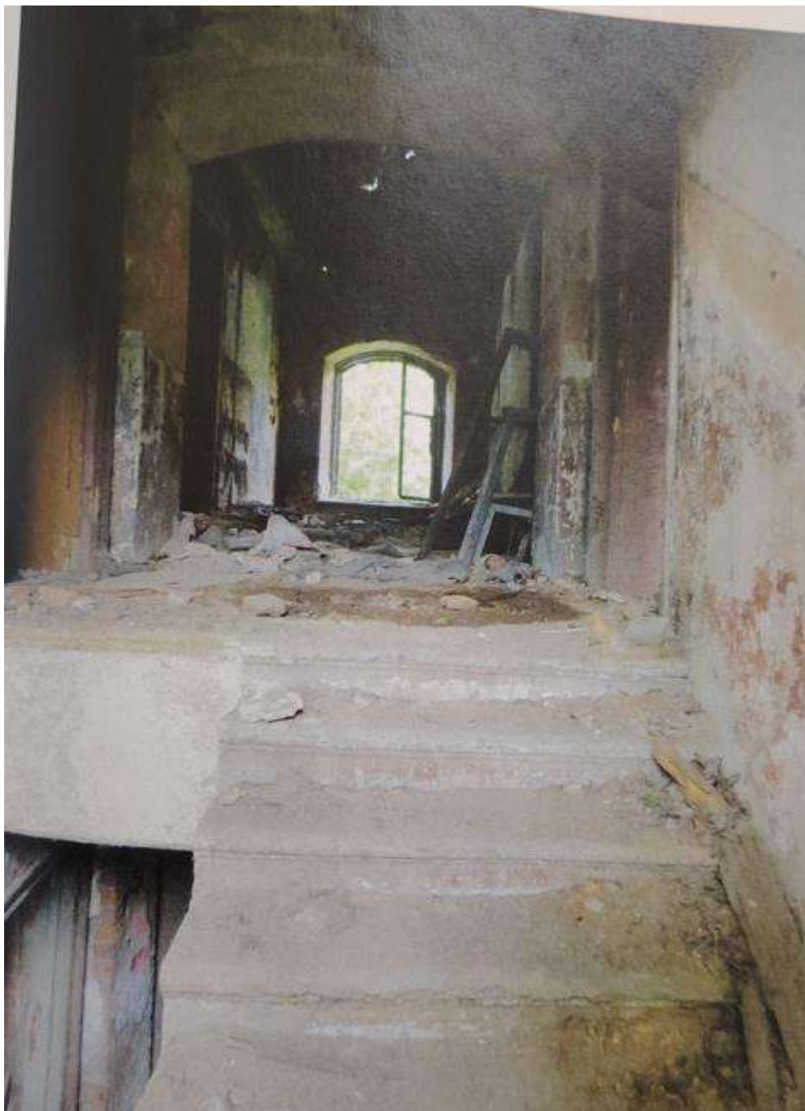
Илл. 73. Две казармы для служащих. Внутренние помещения 2-го этажа западного корпуса. 2013 г. (источник: архив КГИОП. П. 1155. Н-14436).
