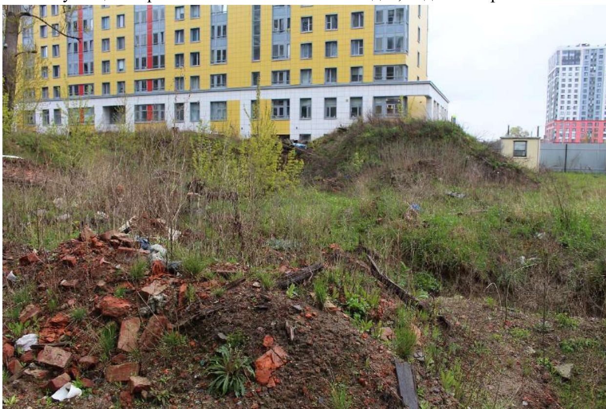
Фото 18. Вид на выявленный объект культурного наследия «Две казармы для служащих Варшавского вокзала с юго-запада», вид на восток.
