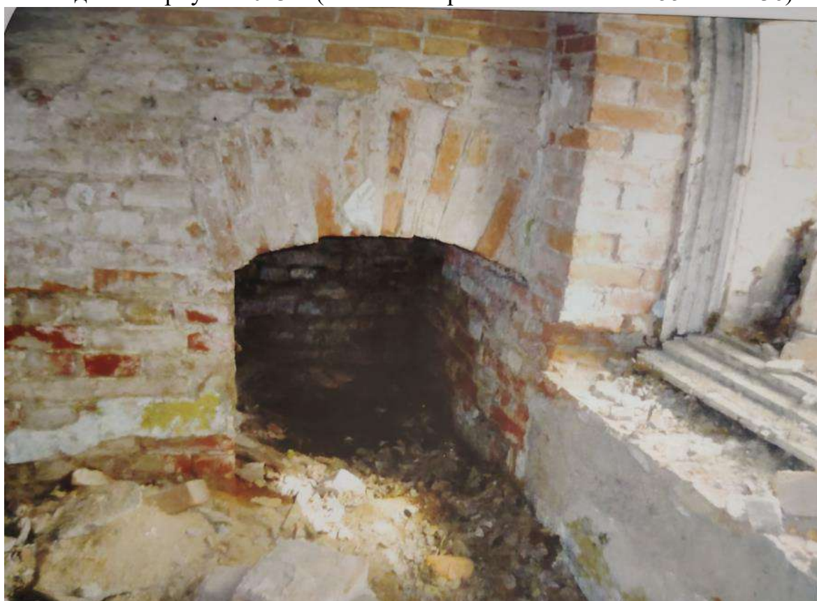
Илл. 66. Две казармы для служащих. Внутренние помещения 1-го этажа западного корпуса. 2013 г. (источник: архив КГИОП. П. 1155. Н-14436).
