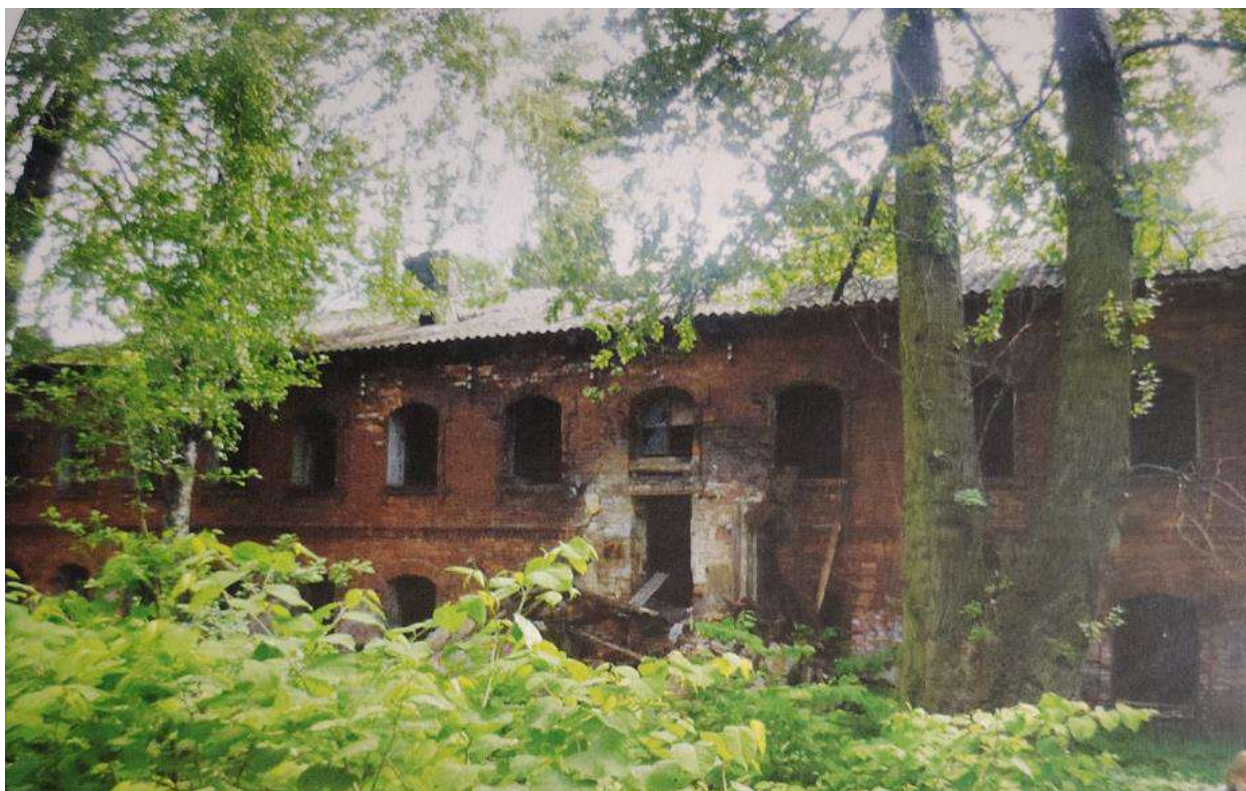
Илл. 78. Вид на западный фасад восточного корпуса. 2013 г. (источник: архив КГИОП. П. 1155. Н-14436).
