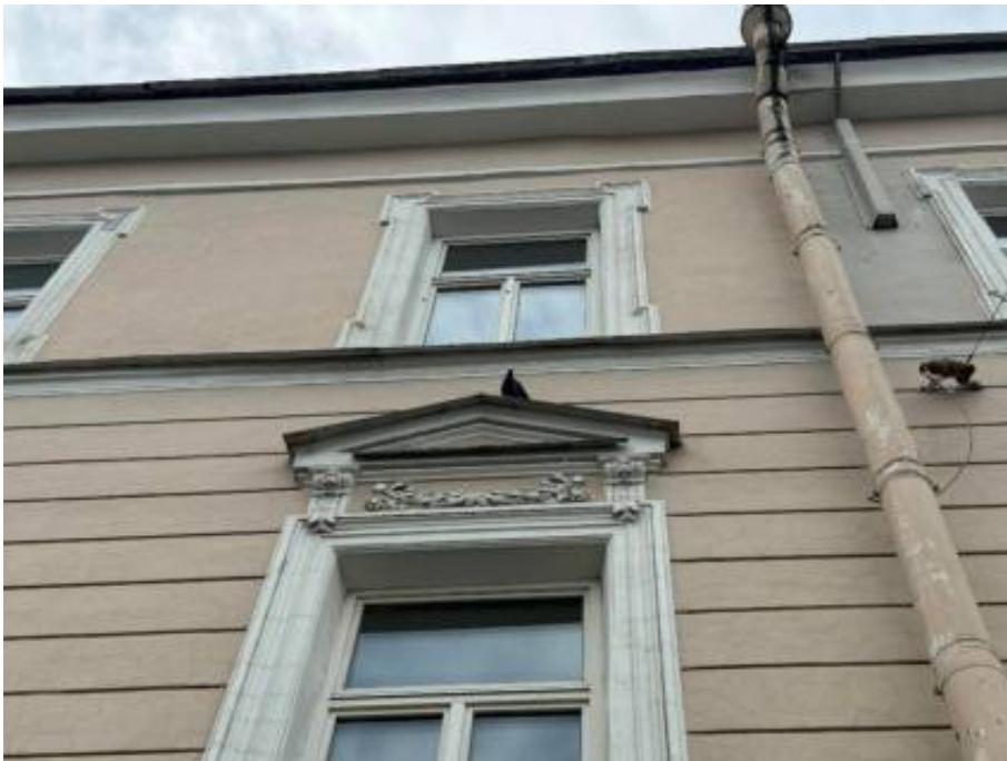
43. «Офицерская казарма», входящая в состав объекта культурного наследия регионального значения «Комплекс казарм Семеновского и Егерского полков», Загородный проспект, дом 54, литера А. Северо-восточный фасад. Фрагмент. Фото 02.04.2026г.
