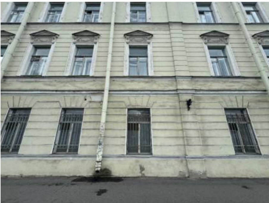
34. «Офицерская казарма», входящая в состав объекта культурного наследия регионального значения «Комплекс казарм Семеновского и Егерского полков», Загородный проспект, дом 54, литера А. Северо-восточный фасад. Фрагмент. Фото 02.04.2026г.
