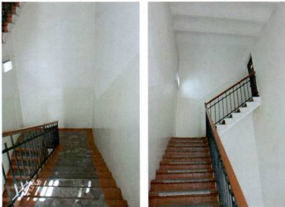
Фото №21, 22. Черная лестница.
