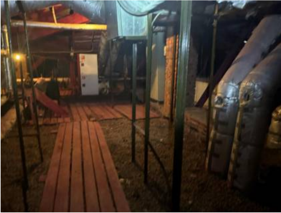
51. «Офицерская казарма», входящая в состав объекта культурного наследия регионального значения «Комплекс казарм Семеновского и Егерского полков», Загородный проспект, дом 54, литера А. Чердак. Общий вид. Фото 02.04.2026г.
