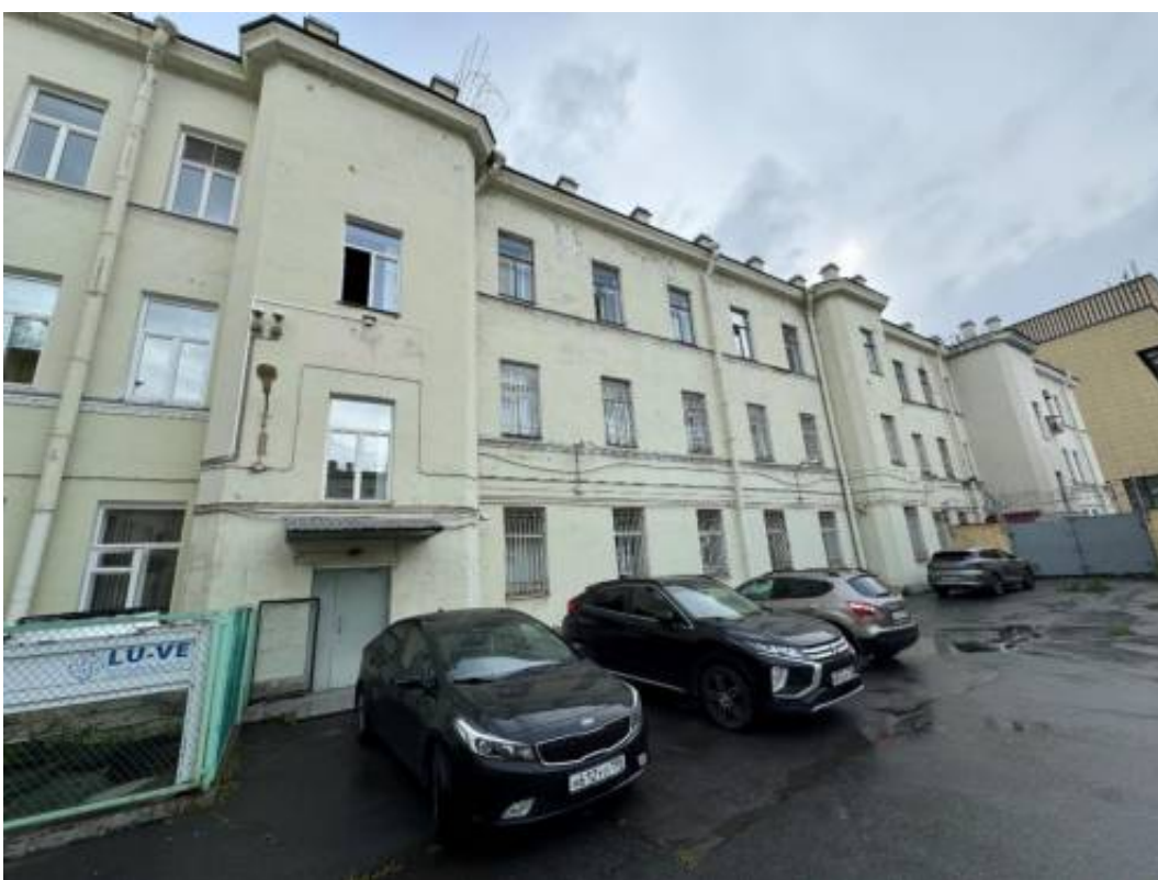
12. «Офицерская казарма», входящая в состав объекта культурного наследия регионального значения «Комплекс казарм Семеновского и Егерского полков», Загородный проспект, дом 54, литера А. Дворовый фасад. Общий вид. Фото 02.04.2026г.
