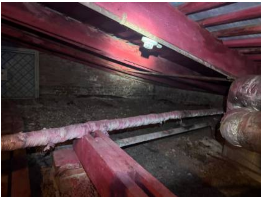
53. «Офицерская казарма», входящая в состав объекта культурного наследия регионального значения «Комплекс казарм Семеновского и Егерского полков», Загородный проспект, дом 54, литера А. Чердак. Общий вид. Фото 02.04.2026г.
