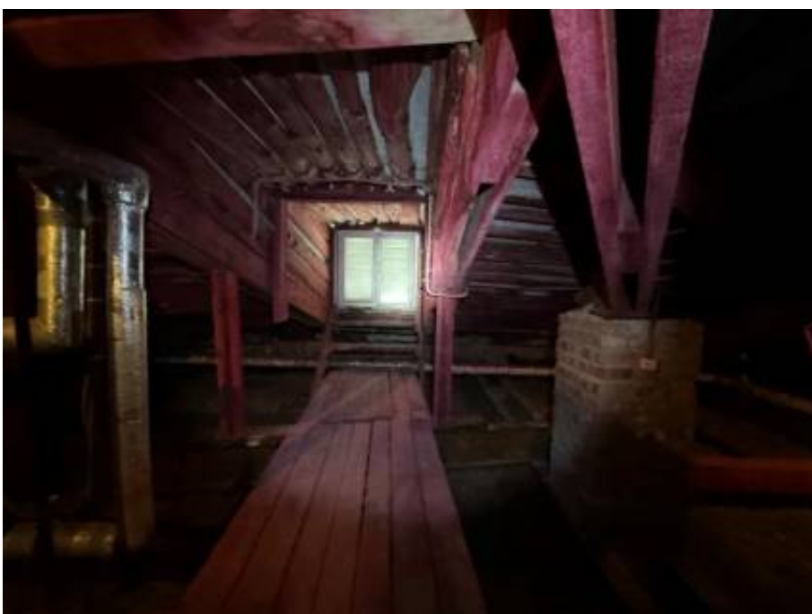
54. «Офицерская казарма», входящая в состав объекта культурного наследия регионального значения «Комплекс казарм Семеновского и Егерского полков», Загородный проспект, дом 54, литера А. Чердак. Общий вид. Фото 02.04.2026г.
