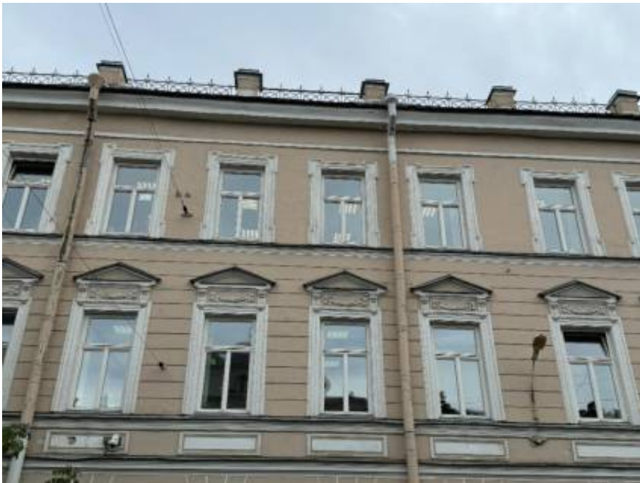
15. «Офицерская казарма», входящая в состав объекта культурного наследия регионального значения «Комплекс казарм Семеновского и Егерского полков», Загородный проспект, дом 54, литера А. Северо-западный фасад. Фрагмент. Фото 02.04.2026г.
