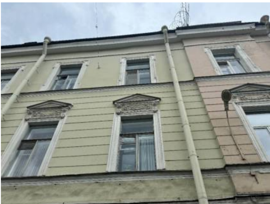
36. «Офицерская казарма», входящая в состав объекта культурного наследия регионального значения «Комплекс казарм Семеновского и Егерского полков», Загородный проспект, дом 54, литера А. Северо-восточный фасад. Фрагмент. Фото 02.04.2026г.
