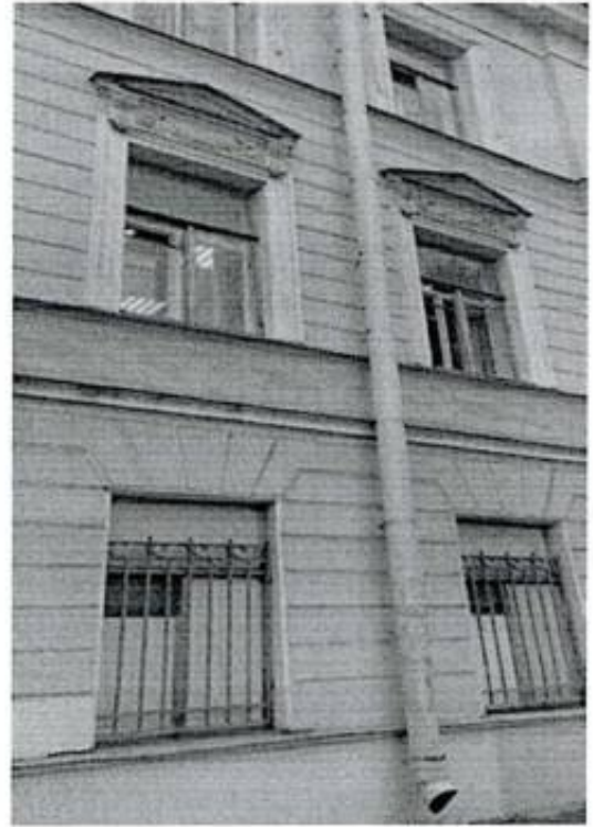
5. Фрагмент лицевого фасада со стороны Введенского канала.
