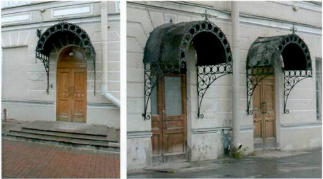
Фото №7, 8. Входные группы лицевых фасадов.
