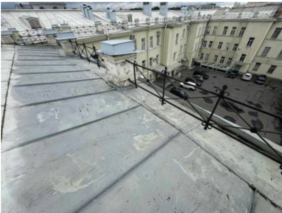
46. «Офицерская казарма», входящая в состав объекта культурного наследия регионального значения «Комплекс казарм Семеновского и Егерского полков», Загородный проспект, дом 54, литера А. Крыша. Общий вид. Фото 02.04.2026г.
