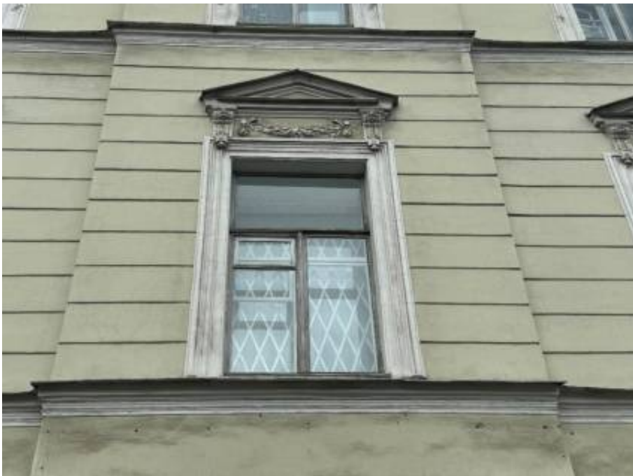
32. «Офицерская казарма», входящая в состав объекта культурного наследия регионального значения «Комплекс казарм Семеновского и Егерского полков», Загородный проспект, дом 54, литера А. Северо-восточный фасад. Фрагмент. Фото 02.04.2026г.
