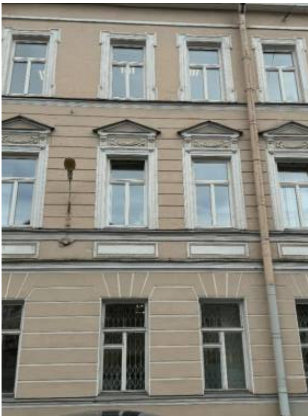
20. «Офицерская казарма», входящая в состав объекта культурного наследия регионального значения «Комплекс казарм Семеновского и Егерского полков», Загородный проспект, дом 54, литера А. Северо-западный фасад. Фрагмент. Фото 02.04.2026г.
