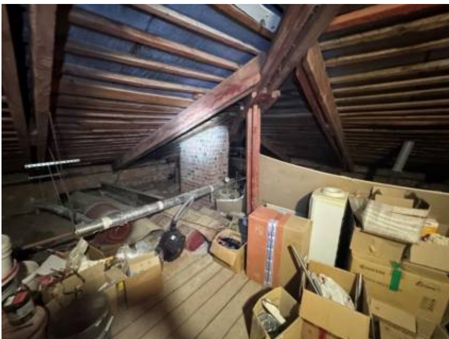
47. «Офицерская казарма», входящая в состав объекта культурного наследия регионального значения «Комплекс казарм Семеновского и Егерского полков», Загородный проспект, дом 54, литера А. Чердак. Общий вид. Фото 02.04.2026г.
