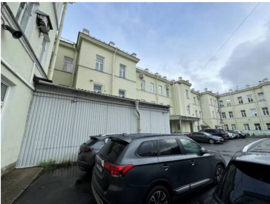
7. «Офицерская казарма», входящая в состав объекта культурного наследия регионального значения «Комплекс казарм Семеновского и Егерского полков», Загородный проспект, дом 54, литера А. Дворовый фасад. Общий вид. Фото 02.04.2026г.
