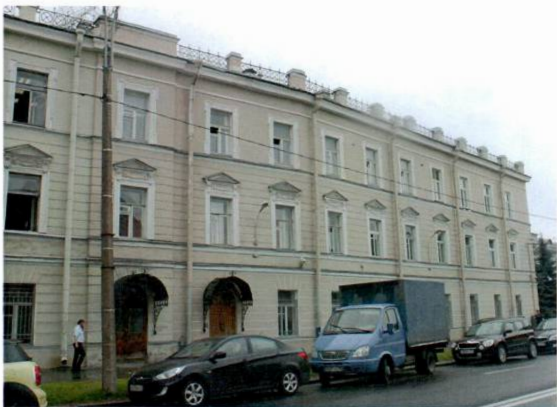
Фото №6. Лицевой фасад. Вид со стороны Введенского канала.
