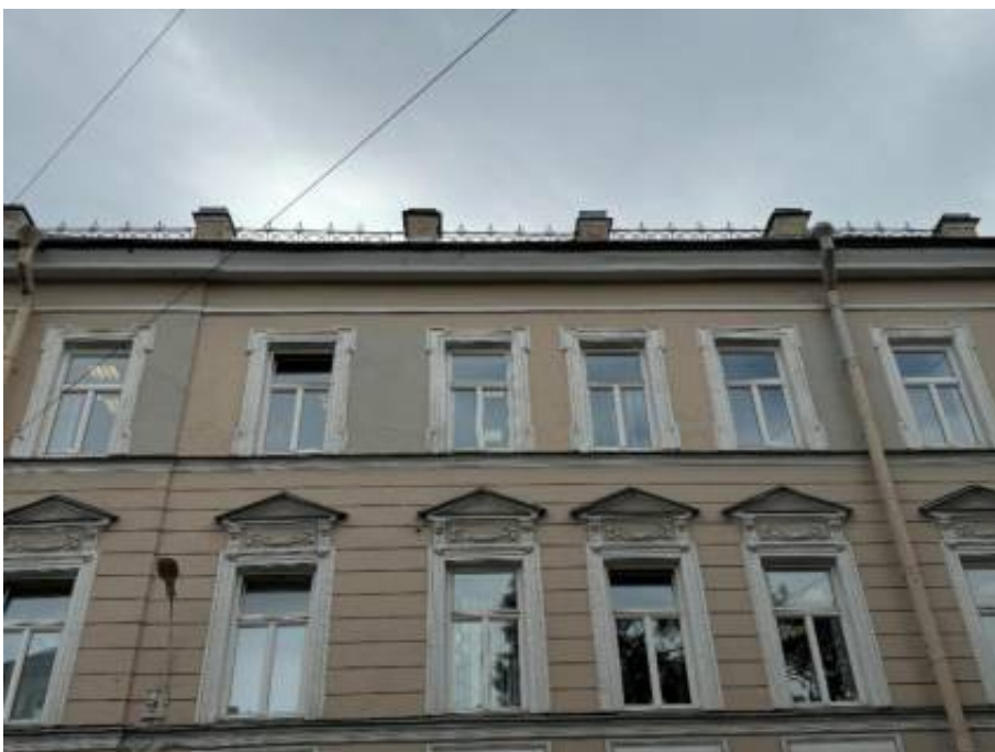
21. «Офицерская казарма», входящая в состав объекта культурного наследия регионального значения «Комплекс казарм Семеновского и Егерского полков», Загородный проспект, дом 54, литера А. Северо-западный фасад. Фрагмент. Фото 02.04.2026г.
