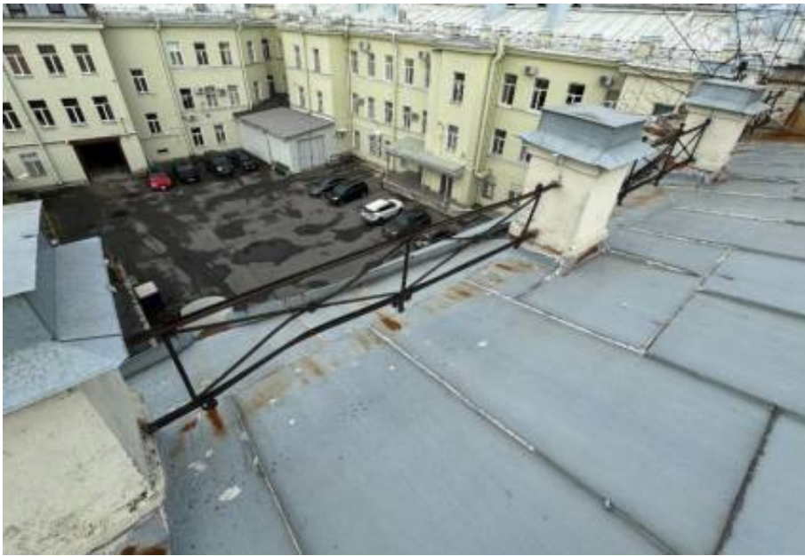
45. «Офицерская казарма», входящая в состав объекта культурного наследия регионального значения «Комплекс казарм Семеновского и Егерского полков», Загородный проспект, дом 54, литера А. Крыша. Общий вид. Фото 02.04.2026г.
