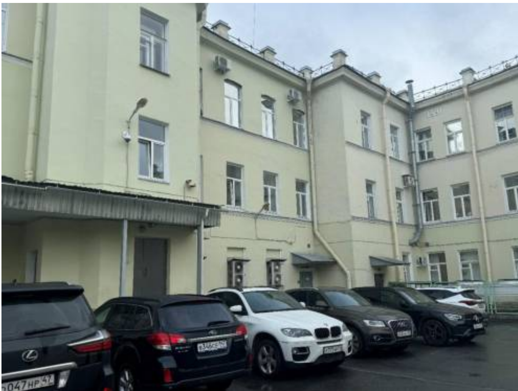
10. «Офицерская казарма», входящая в состав объекта культурного наследия регионального значения «Комплекс казарм Семеновского и Егерского полков», Загородный проспект, дом 54, литера А. Дворовый фасад. Общий вид. Фото 02.04.2026г.
