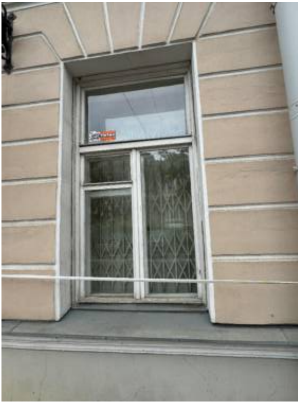
19. «Офицерская казарма», входящая в состав объекта культурного наследия регионального значения «Комплекс казарм Семеновского и Егерского полков», Загородный проспект, дом 54, литера А. Северо-западный фасад. Фрагмент. Фото 02.04.2026г.
