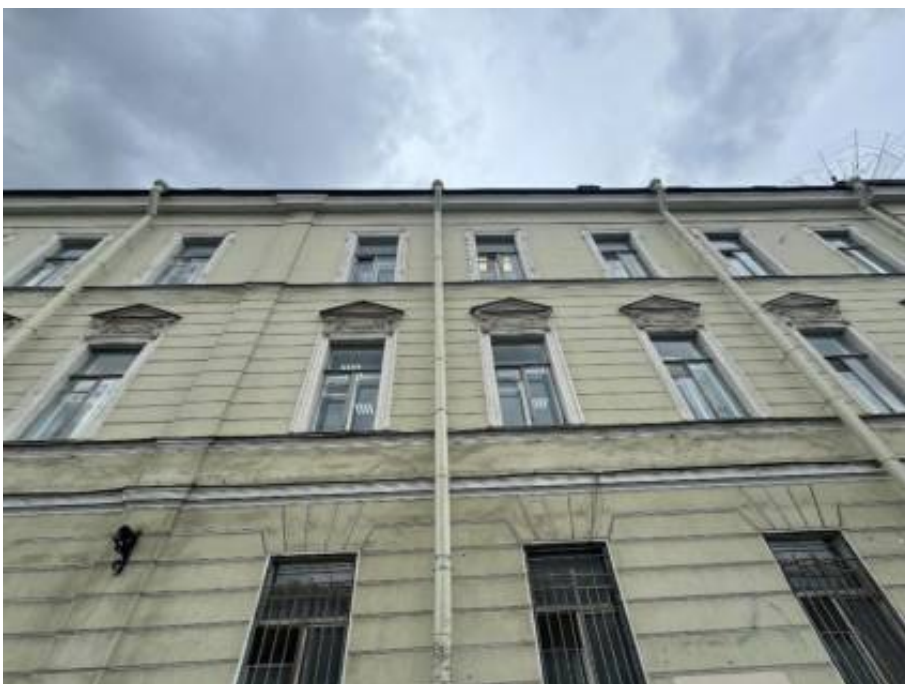
35. «Офицерская казарма», входящая в состав объекта культурного наследия регионального значения «Комплекс казарм Семеновского и Егерского полков», Загородный проспект, дом 54, литера А. Северо-восточный фасад. Фрагмент. Фото 02.04.2026г.
