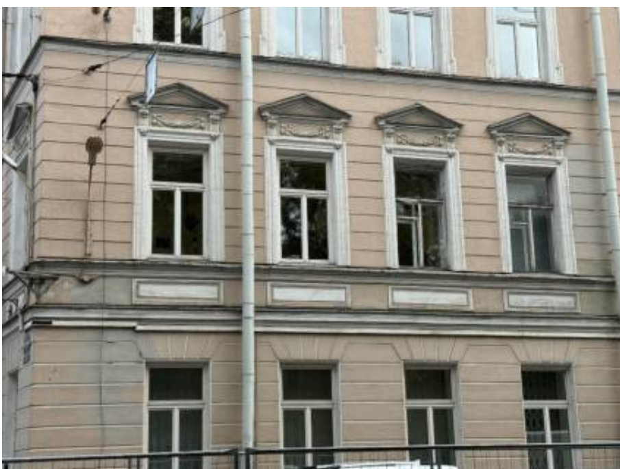
24. «Офицерская казарма», входящая в состав объекта культурного наследия регионального значения «Комплекс казарм Семеновского и Егерского полков», Загородный проспект, дом 54, литера А. Юго-западный фасад. Фрагмент. Фото 02.04.2026г.
