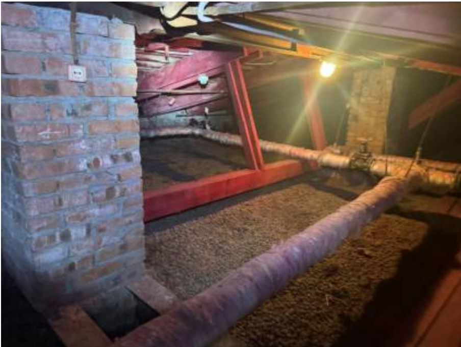
52. «Офицерская казарма», входящая в состав объекта культурного наследия регионального значения «Комплекс казарм Семеновского и Егерского полков», Загородный проспект, дом 54, литера А. Чердак. Общий вид. Фото 02.04.2026г.
