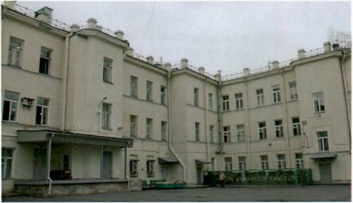
Фото №3. Дворовые фасады.
