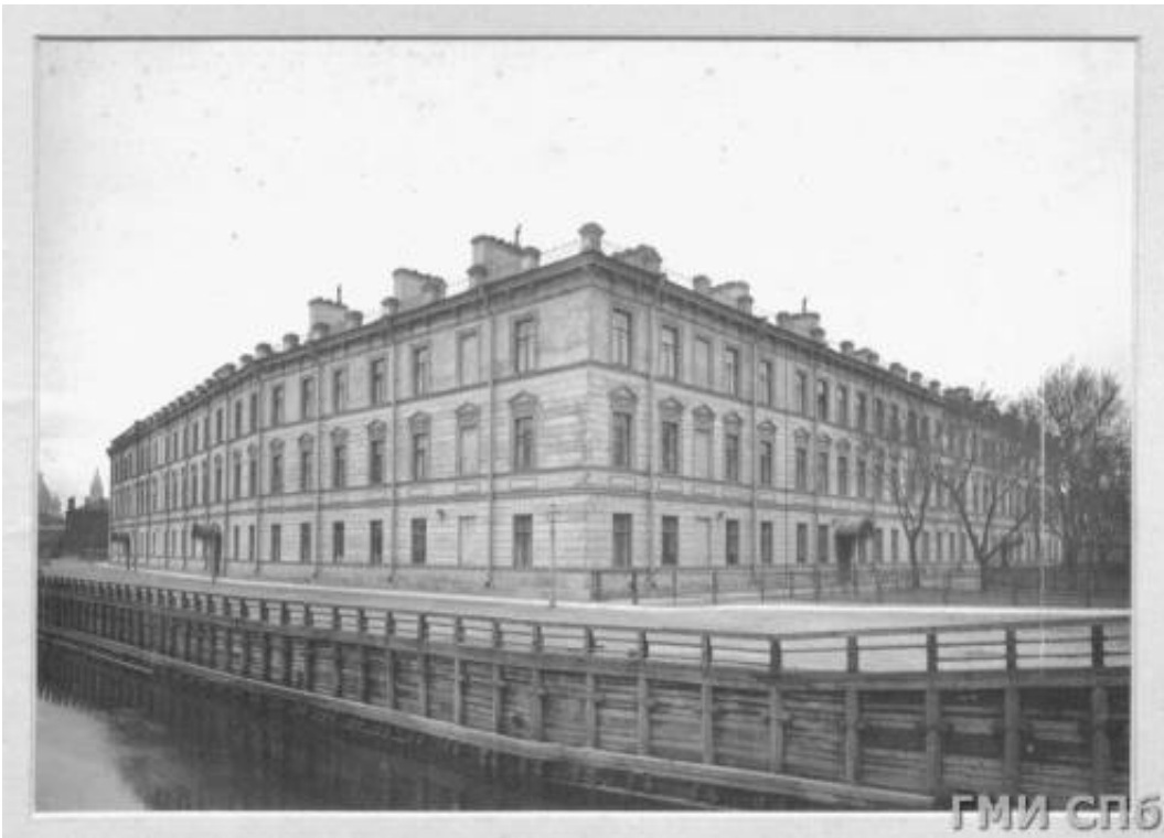
11. Вид на здание северо-востока (фасады со стороны Загородного пр. и Введенского канала). Фото начала XX в. ГМИ СПб. Лист № 7 альбома "Виды казарм и лагерных строений [лейб-гвардии Семеновского полка]". Инв.№-II-A-16729 ф.
