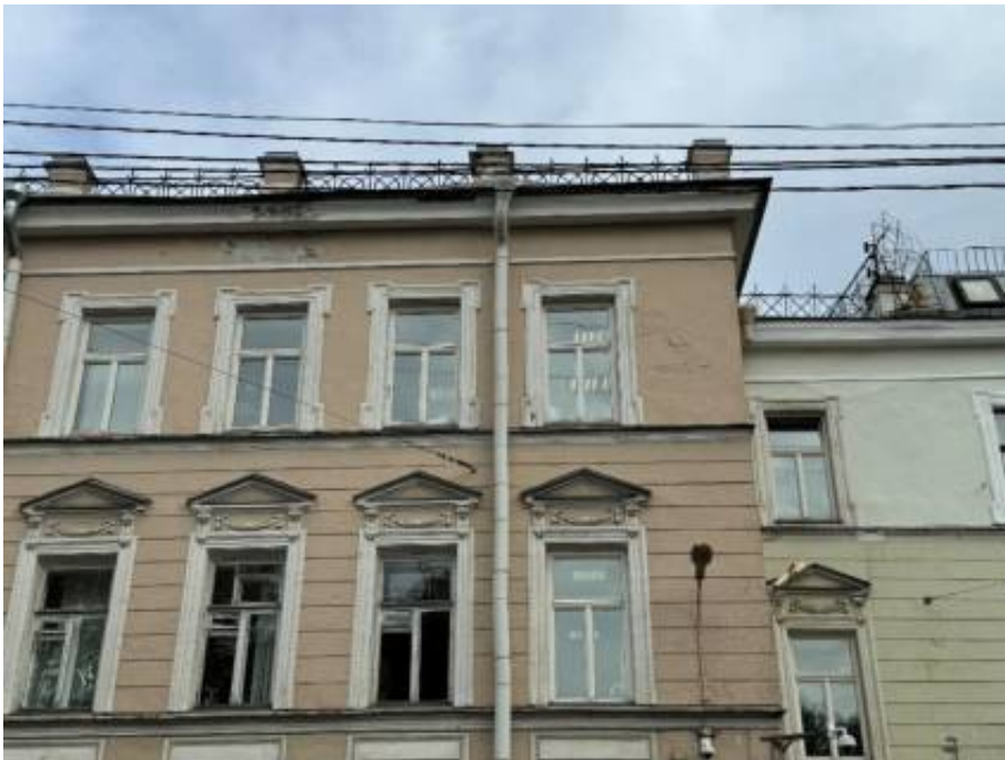
27. «Офицерская казарма», входящая в состав объекта культурного наследия регионального значения «Комплекс казарм Семеновского и Егерского полков», Загородный проспект, дом 54, литера А. Юго-западный фасад. Фрагмент. Фото 02.04.2026г.
