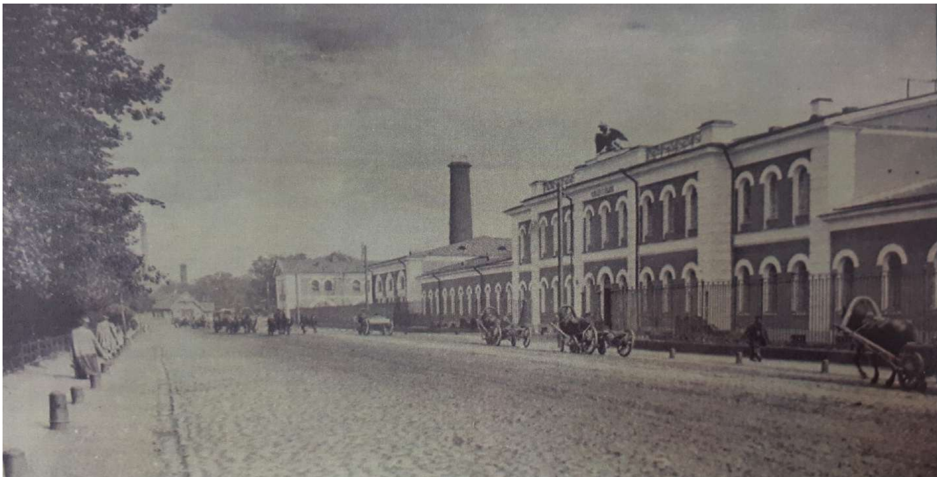
6. Здание главных мастерских. Фото 1872 г. //Историко-культурные исследования по объектам культурного наследия с целью определения предметов охраны. ОКН «Арсенал». Архитектурная мастерская Н.Ф. Никитина. 2009 г.
