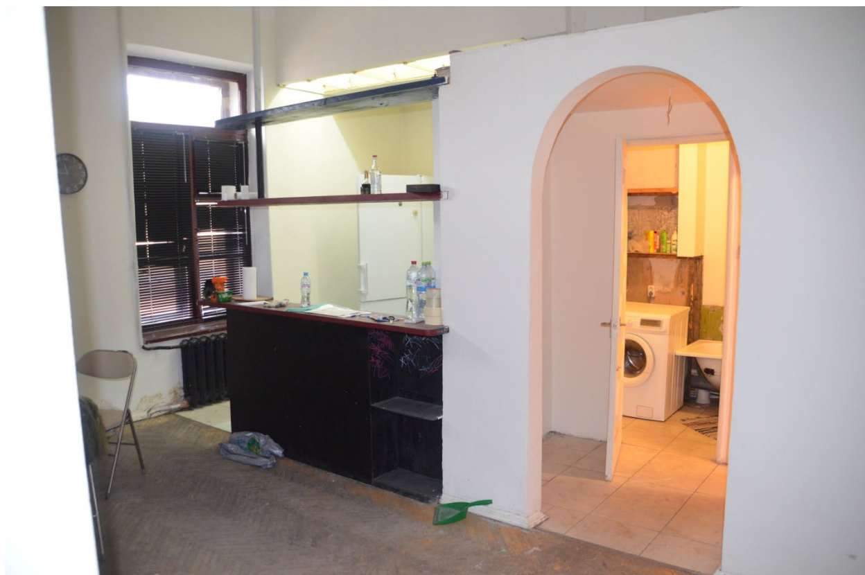
4. Помещение №5 кв. №11 в уровне 4-го этажа выявленного объекта культурного наследия «Дом Лесниковых», расположенного по адресу: г. Санкт-Петербург, пер. Сергея Тюленина, д. 4/23, литера А. 24.09.2025.
