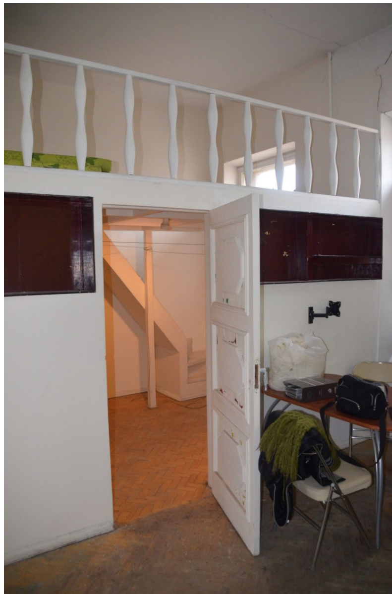
6. Помещение №5 кв. №11 в уровне 4-го этажа выявленного объекта культурного наследия «Дом Лесниковых», расположенного по адресу: г. Санкт-Петербург, пер. Сергея Тюленина, д. 4/23, литера А. 24.09.2025.
