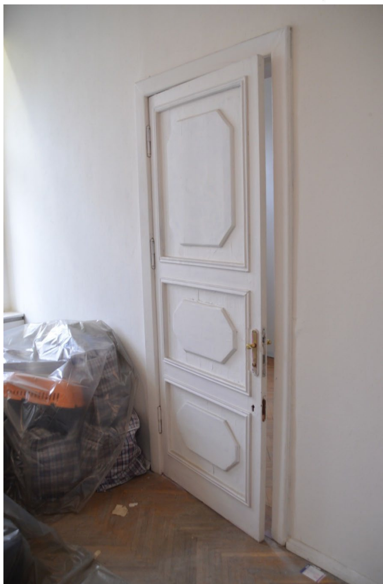
12. Помещение №3 кв. №11 в уровне 4-го этажа выявленного объекта культурного наследия «Дом Лесниковых», расположенного по адресу: г. Санкт-Петербург, пер. Сергея Тюленина, д. 4/23, литера А. 24.09.2025.
