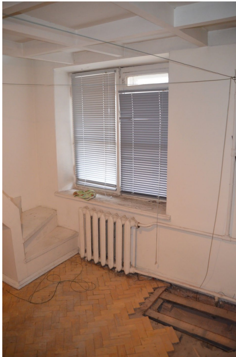
7. Помещение №1 кв. №11 в уровне 4-го этажа выявленного объекта культурного наследия «Дом Лесниковых», расположенного по адресу: г. Санкт-Петербург, пер. Сергея Тюленина, д. 4/23, литера А. 24.09.2025.
