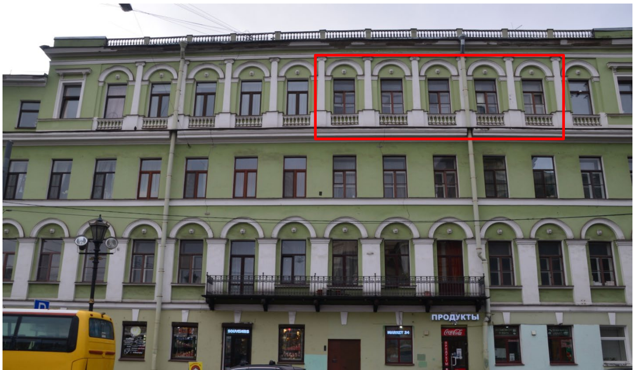
1. Оконные заполнения кв. №11 в уровне 4-го этажа выявленного объекта культурного наследия «Дом Лесниковых», расположенного по адресу: г. Санкт-Петербург, пер. Сергея Тюленина, д. 4/23, литера А. 24.09.2025.
