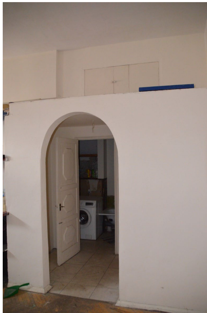
3. Помещение №9 кв. №11 в уровне 4-го этажа выявленного объекта культурного наследия «Дом Лесниковых», расположенного по адресу: г. Санкт-Петербург, пер. Сергея Тюленина, д. 4/23, литера А. 24.09.2025.
