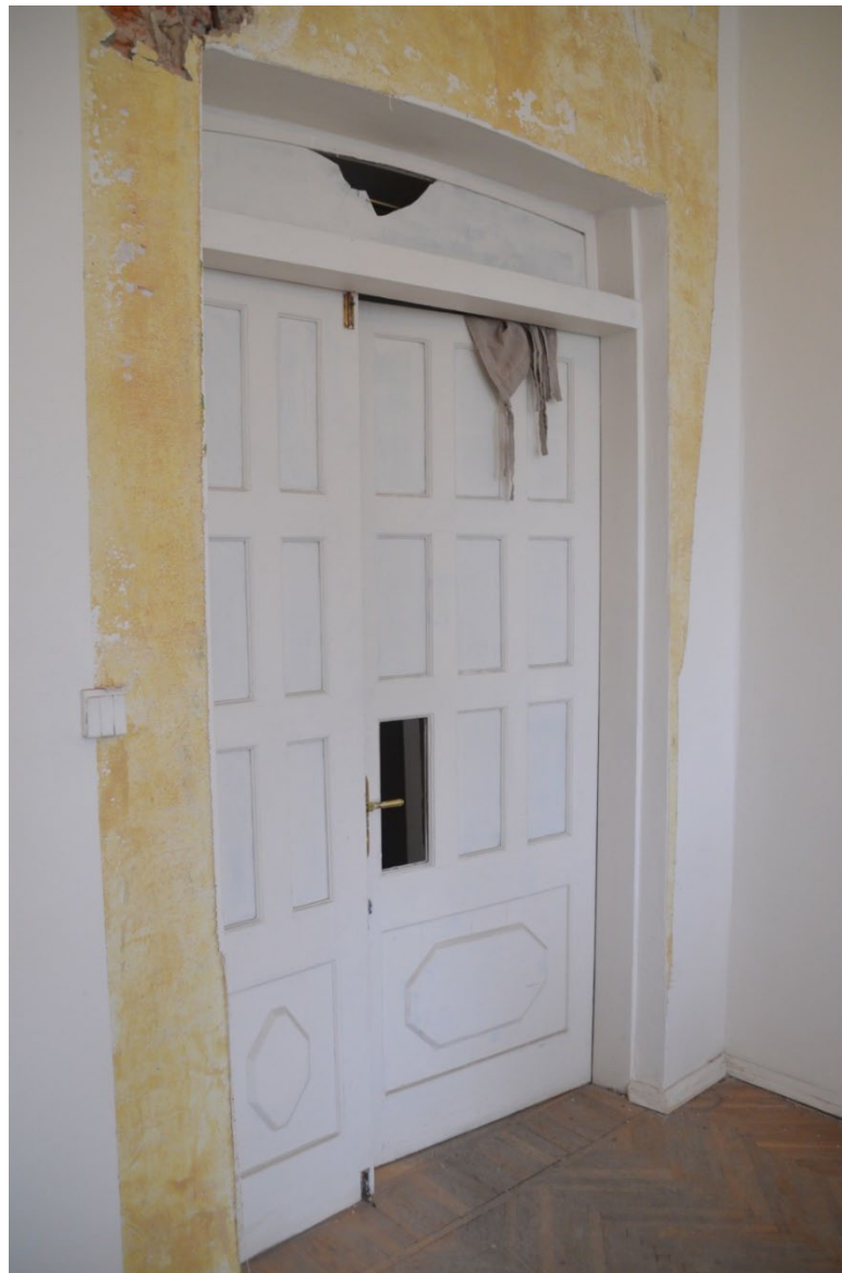
10. Помещение №3 кв. №11 в уровне 4-го этажа выявленного объекта культурного наследия «Дом Лесниковых», расположенного по адресу: г. Санкт-Петербург, пер. Сергея Тюленина, д. 4/23, литера А. 24.09.2025.
