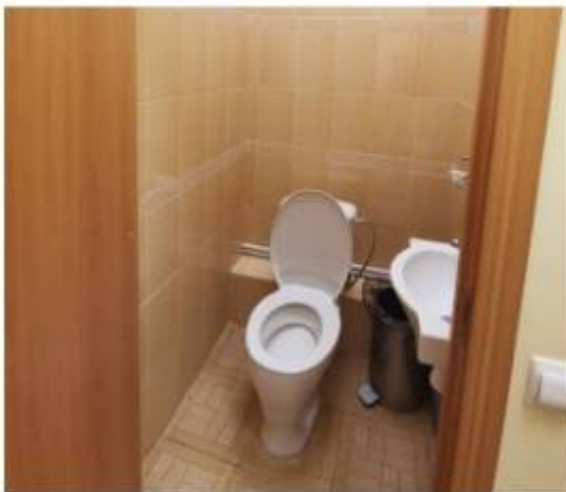
Фото 33. Пом. 17. Санузел. Общий вид.
