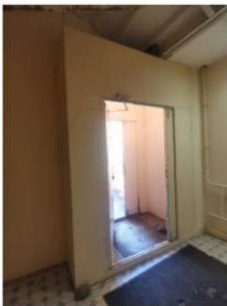
Фото 57. Пом. 6.2. Тамбур. Вид в сторону дверного заполнения.
