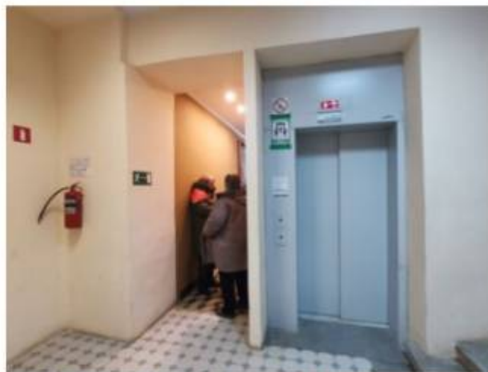
Фото 60. Пом. 7.4. Лестница ЛК-7. Общий вид.
