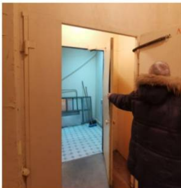
Фото 63. Пом. Пом. 7.2. Тамбур лестницы ЛК-7.
