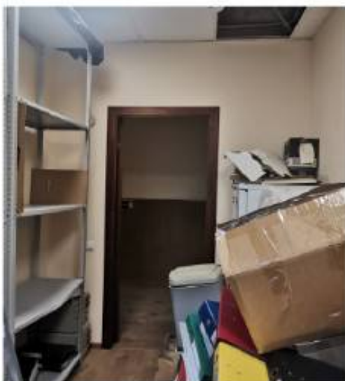
Фото 17. Пом. 6. Кабинет. Общий вид в сторону выхода.
