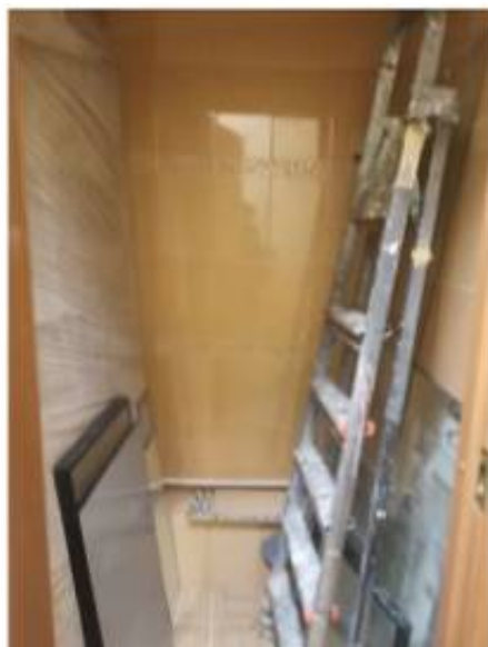
Фото 13. Пом. 7. Санузел. Общий вид.
