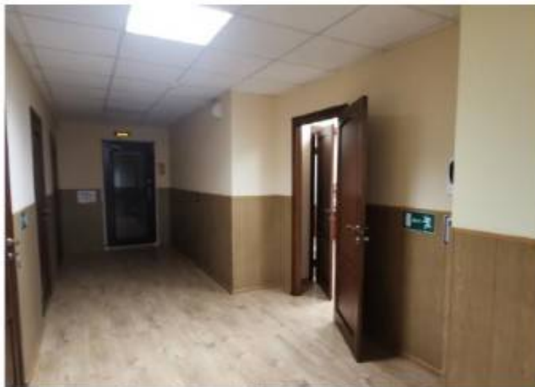
Фото 8. Пом. 1. Коридор. Общий вид.
