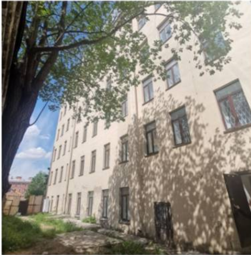
Фото 17. Юго-западный фасад здания. Фрагмент. Вид в сторону Чкаловского проспекта.
