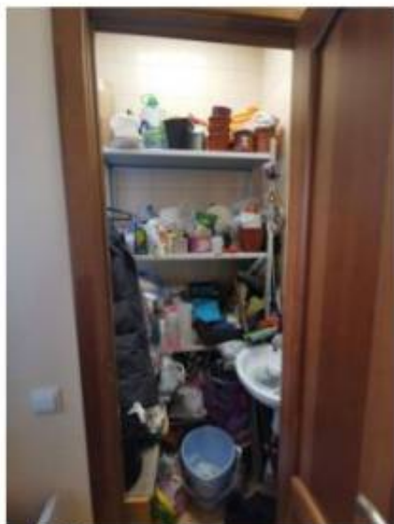
Фото 41. Пом. 18. Комната уборочного инвентаря. Общий вид.
