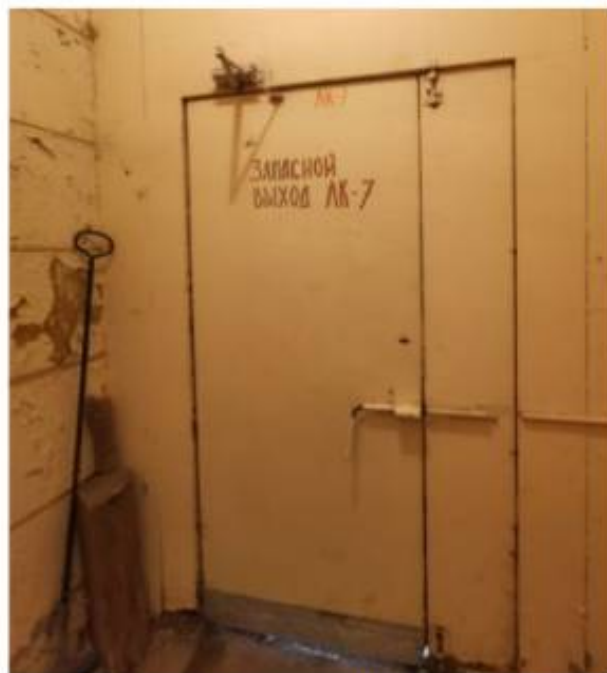
Фото 62. Выход с лестницы ЛК-7 во внутренний двор.
