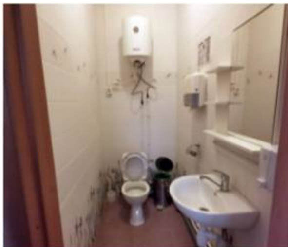
Фото 41. Пом. 24. Санузел. Общий вид.
