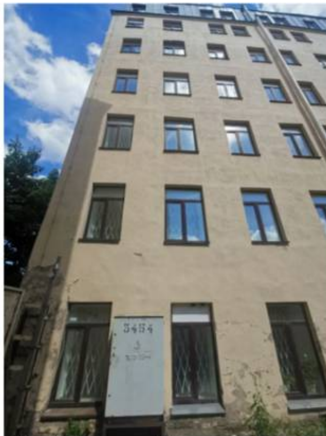
Фото 18. Юго-западный фасад здания. Фрагмент.
