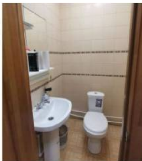
Фото 27. Пом. 10. Санузел. Общий вид.
