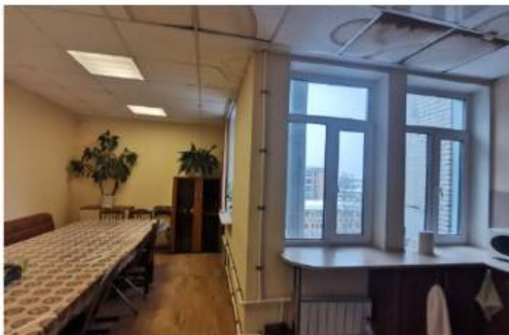
Фото 57. Пом. 24. Комната отдыха. Общий вид в сторону обеденного зала.
