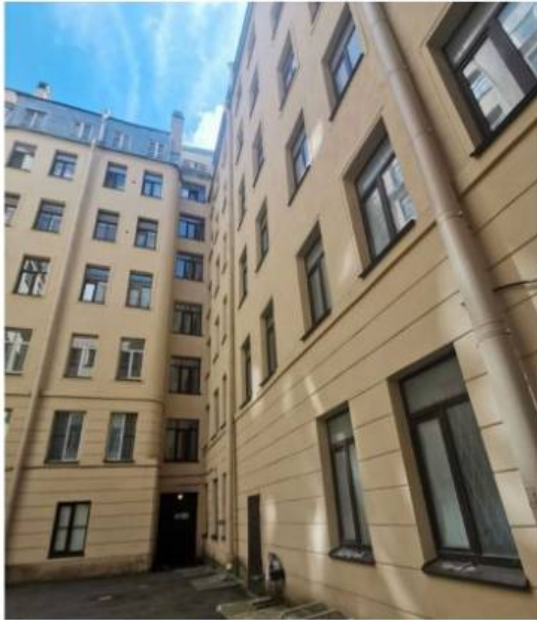
Фото 5. Фрагмент северо-восточного фасада здания во внутреннем дворе.
