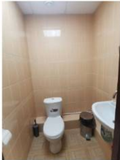
Фото 51. Пом. 23. Санузел. Общий вид.
