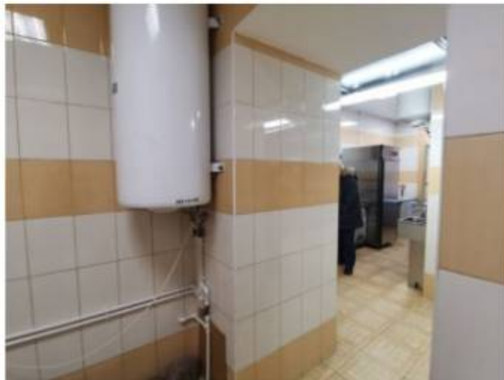
Фото 22. Пом. 12. Тамбур. Общий вид.
