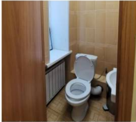
Фото 34. Пом. 16. Санузел. Общий вид.
