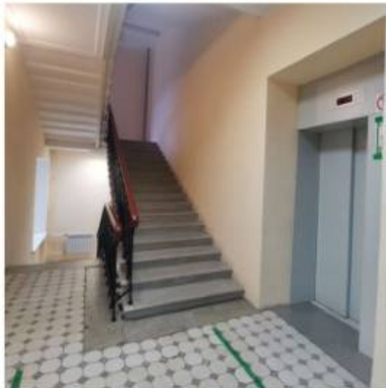
Фото 25. Пом. 6.6. Общий вид площадки лестницы ЛК-6. Справа – лифт.
