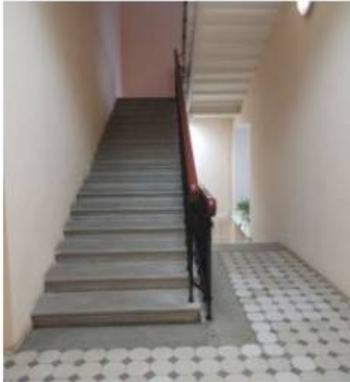
Фото 1. Пом. 7.9. Общий вид лестницы ЛК-7.
