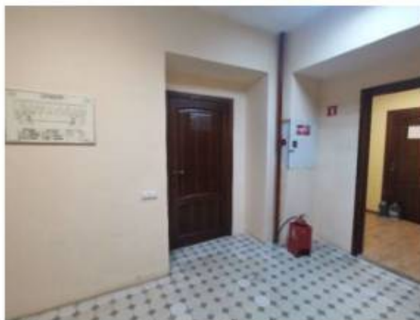
Фото 2. Пом. 7.10. Лестничная клетка ЛК-7. Вид в сторону дверных проемов.
