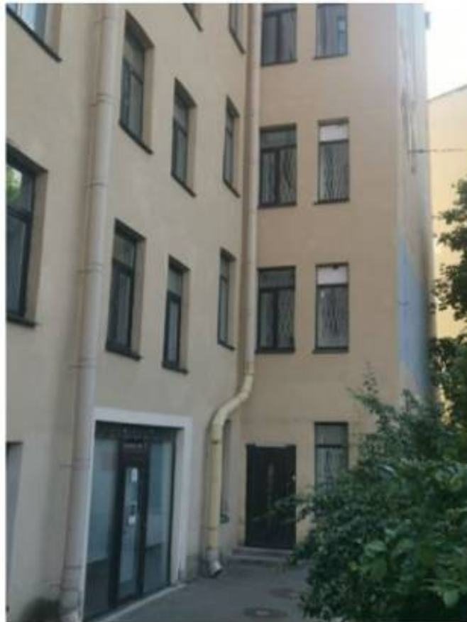
Фото 13. Фрагмент северо-восточного фасада здания.
