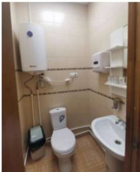
Фото 30. Пом. 11. Санузел. Общий вид.
