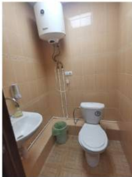
Фото 32. Пом. 14. Санузел. Общий вид.
