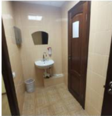
Фото 31. Пом. 13. Тамбур санузла.
