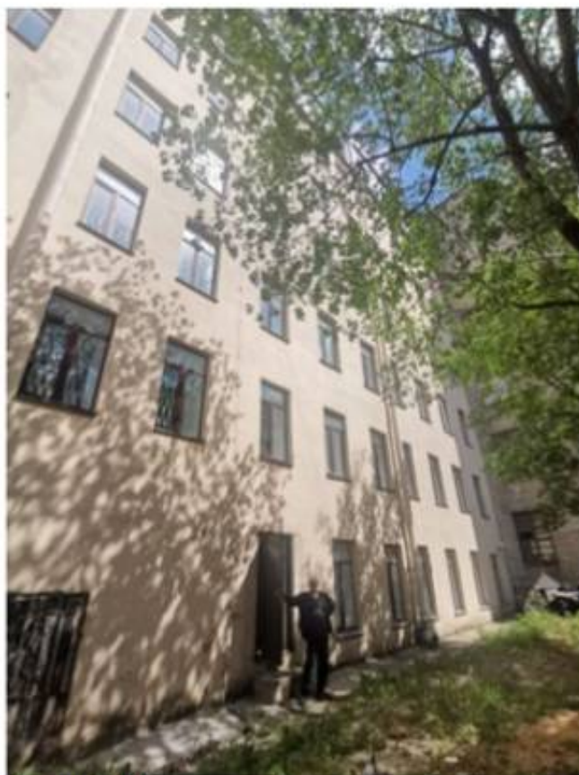
Фото 16. Юго-западный фасад здания. Фрагмент. Вид с запада.
