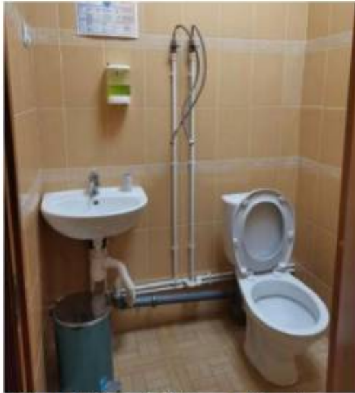
Фото 43. Пом.15. Санузел. Общий вид.
