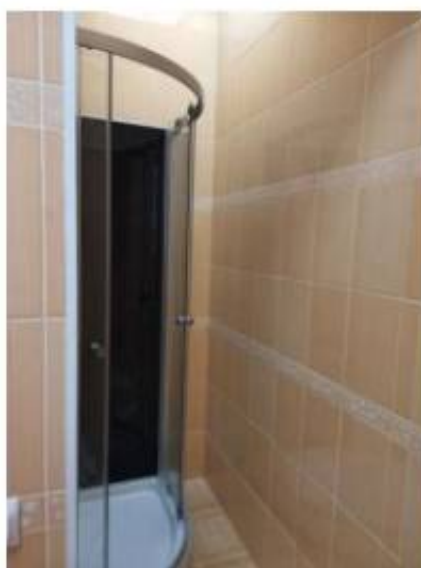
Фото 42. Пом.17. Душевая. Общий вид.
