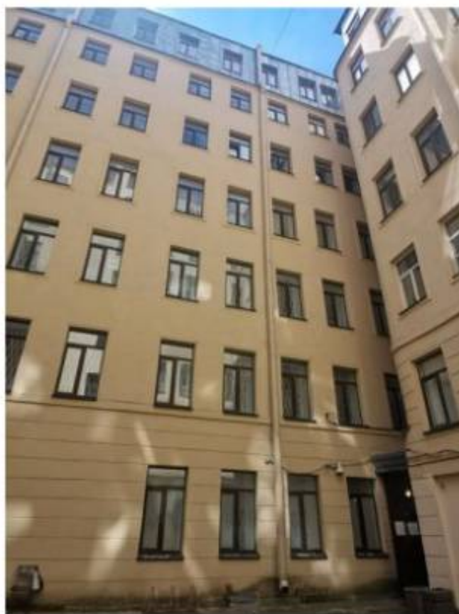
Фото 10. Фрагмент северо-восточного фасада здания во внутреннем дворе. Вид с востока.
