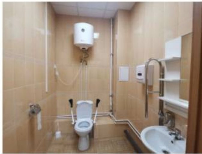
Фото 35. Пом. 19. Санузел для МГН. Общий вид.
