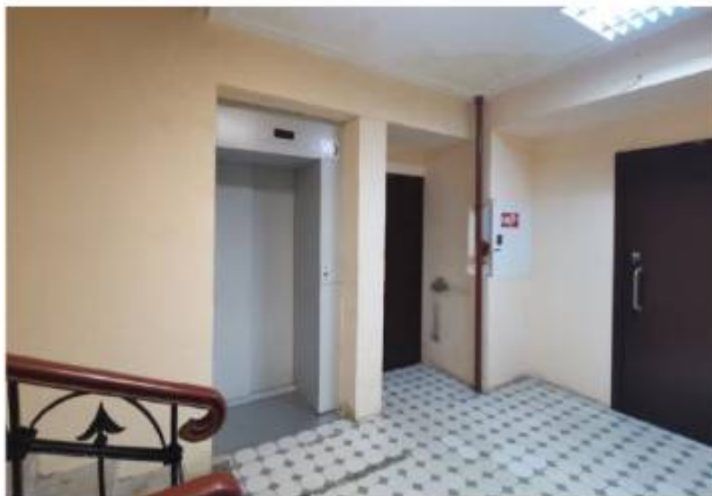
Фото 45. Пом. 6.10. Общий вид площадки лестницы ЛК-7. Вид в сторону лифта.
