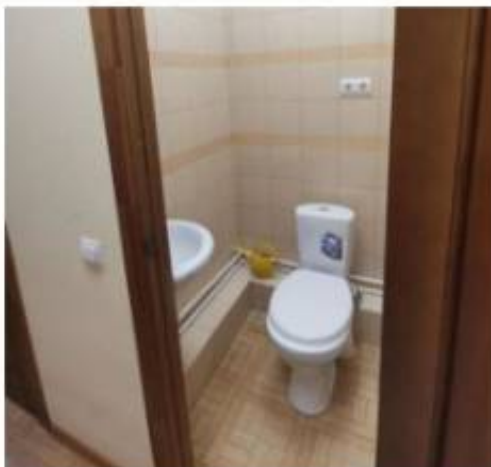
Фото 39. Пом. 20. Санузел. Общий вид.
