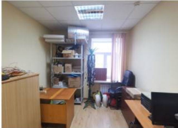
Фото 16. Пом. 6. Аудитория. Общий вид в сторону окна.
