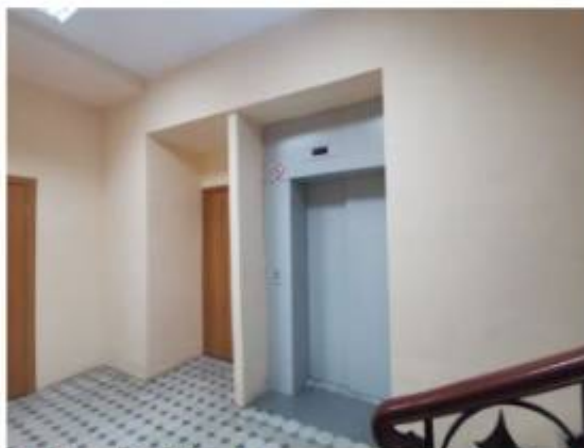
Фото 3. Пом. 7.6. Общий вид лестничной площадки ЛК-7. Справа - шахта лифта.
