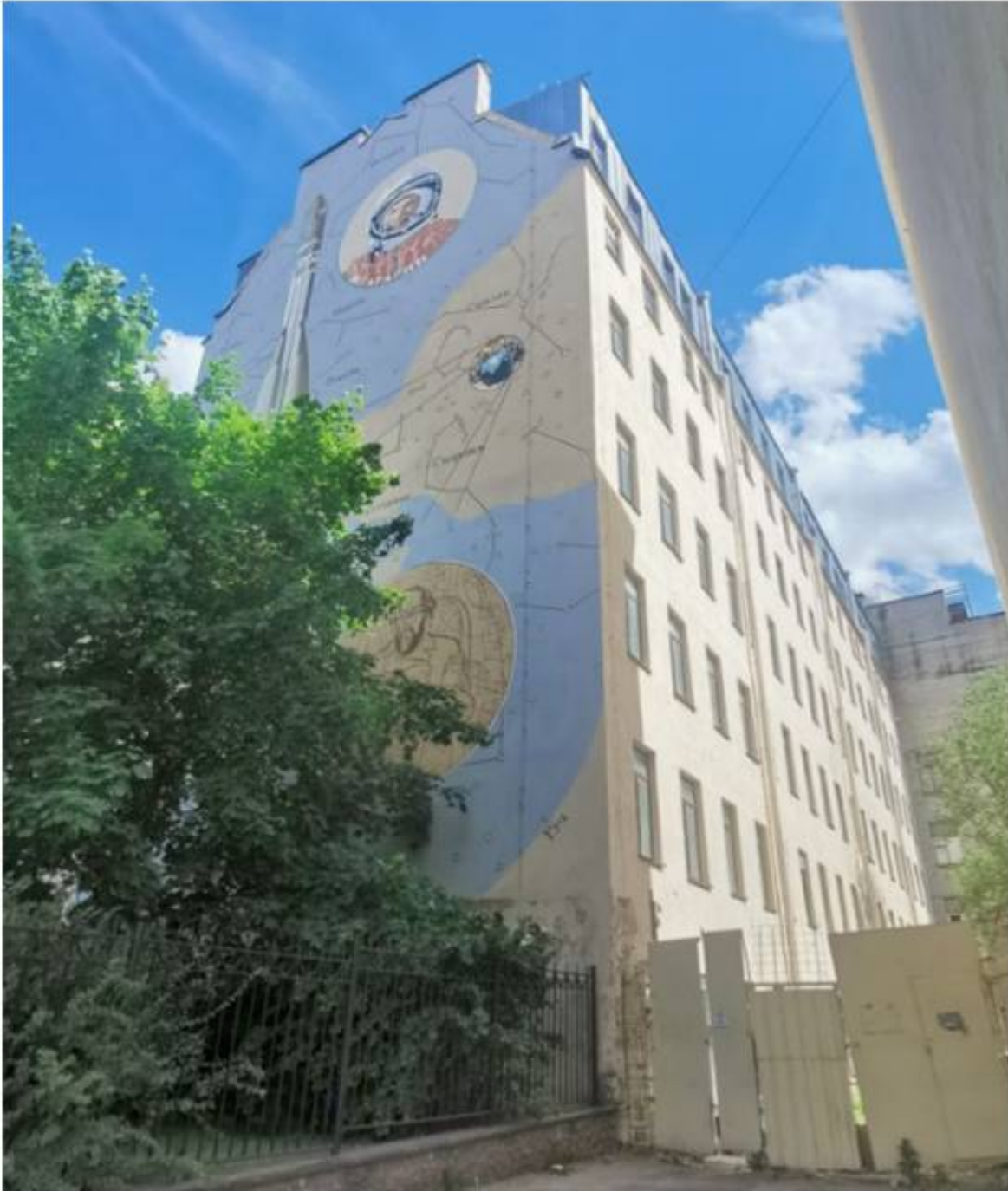
Фото 21. Общий вид торцевого северо-западного фасада, выходящего на Чкаловский проспект.
