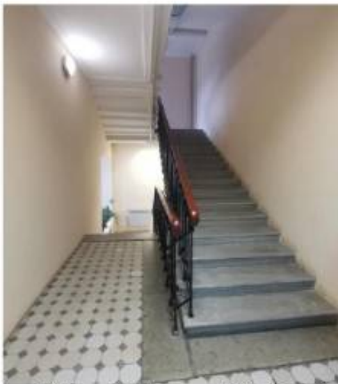
Фото 40. Пом. 6.8. Лестница ЛК-6. Общий вид.
