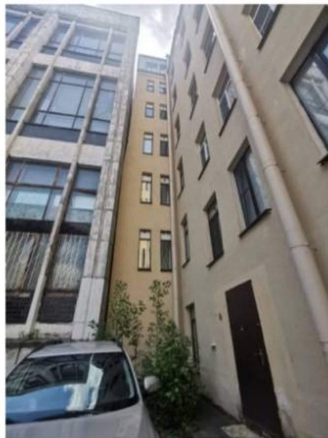
Фото 2. Фрагмент юго-восточного фасада здания.
