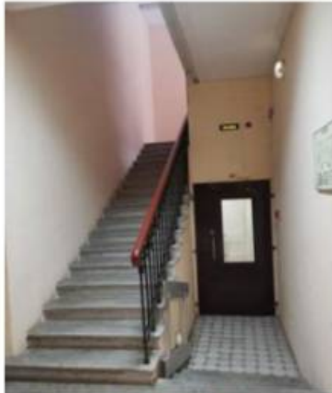
Фото 58. Пом. 7.4. Лестница ЛК-6. Общий вид.
