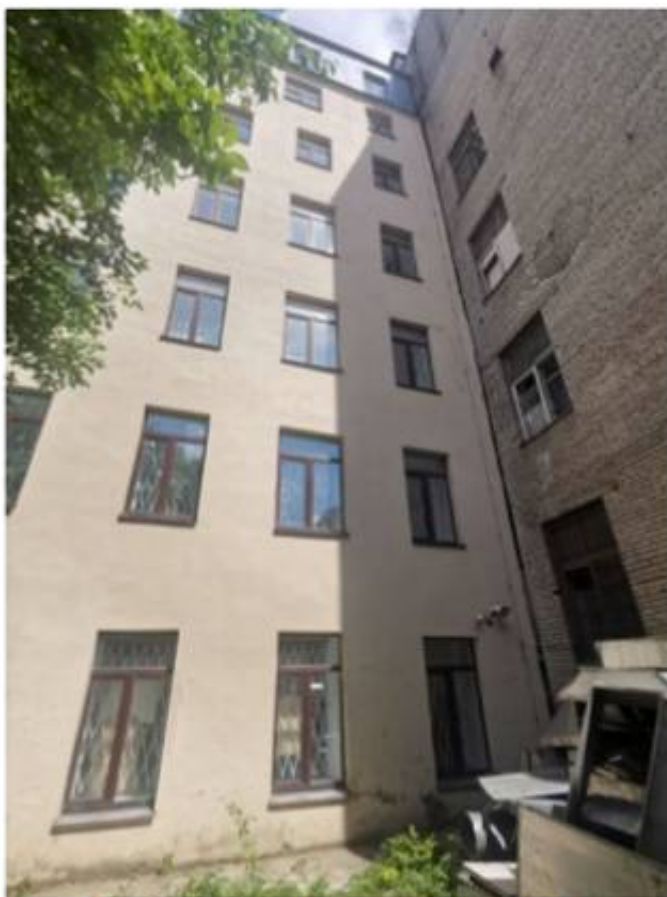
Фото 15. Фрагмент юго-западного фасада здания. Вид с юго-запада.
