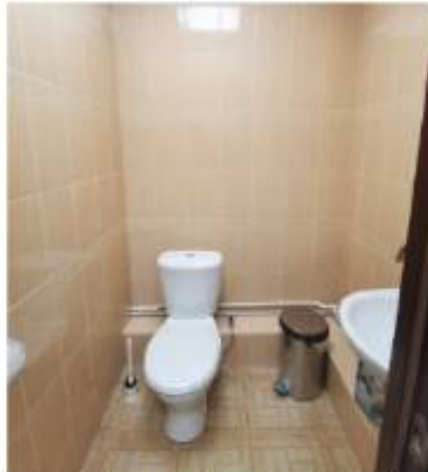
Фото 52. Пом. 24. Санузел. Общий вид.
