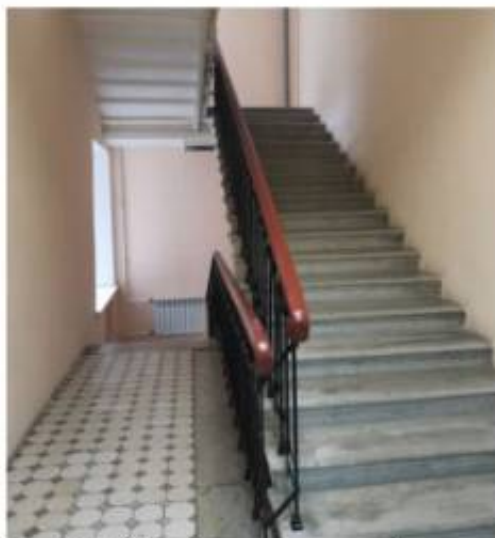
Фото 32. Пом.6.4. Общий вид лестничной площадки ЛК-6.
