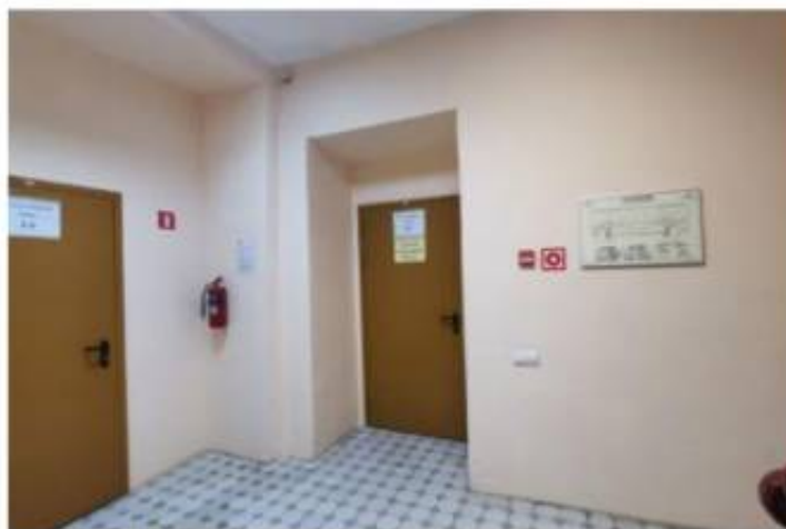
Фото 32.2. Пом. 6.5. Общий вид площадки лестницы ЛК-6.
