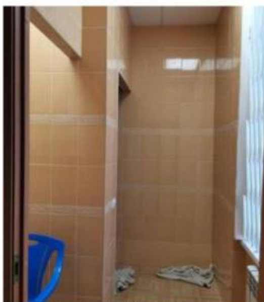
Фото 41. Пом.18. Тамбур. Общий вид.
