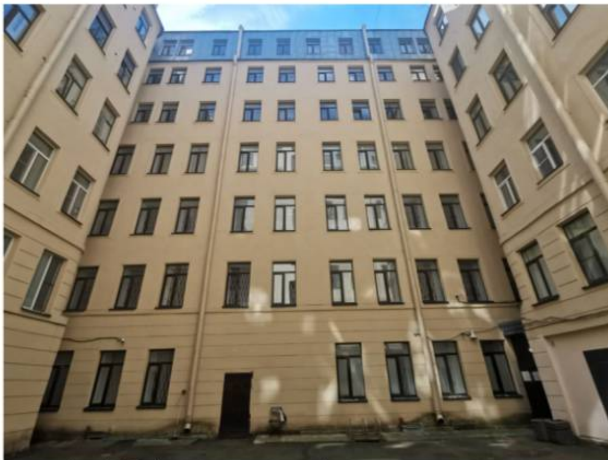
Фото 4. Общий вид северо-восточного фасада здания во внутреннем дворе.
