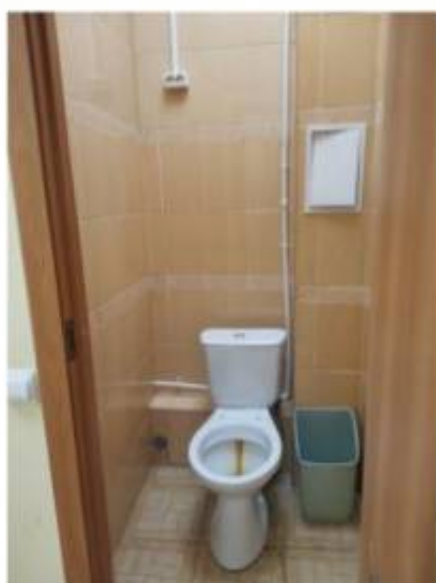
Фото 14. Пом. 8. Санузел. Общий вид.
