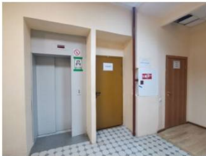
Фото 27. Пом. 6.6. Общий вид площадки лестницы ЛК-6.
