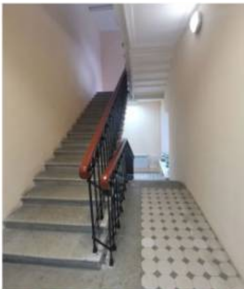
Фото 1. Пом. 7.10. Лестничная клетка ЛК-7. Общий вид.
