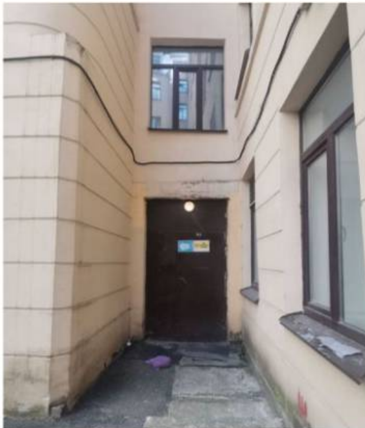
Фото 6. Фрагмент северо-восточного фасада здания во внутреннем дворе. Вход на лестницу ЛК-6.
