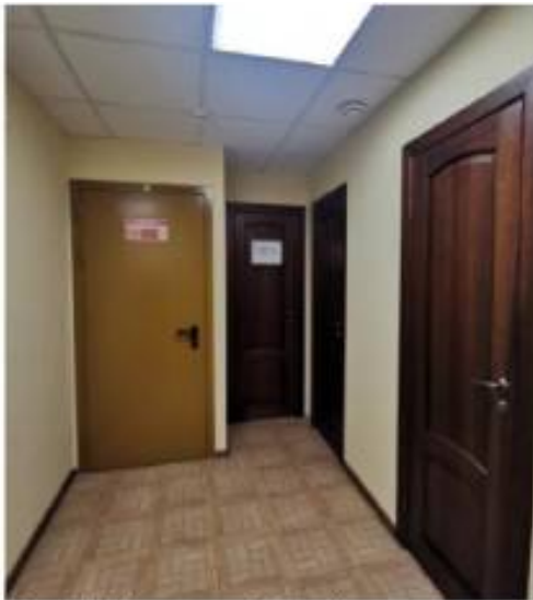
Фото 48. Пом. 20. Коридор. Общий вид в сторону санузлов.
