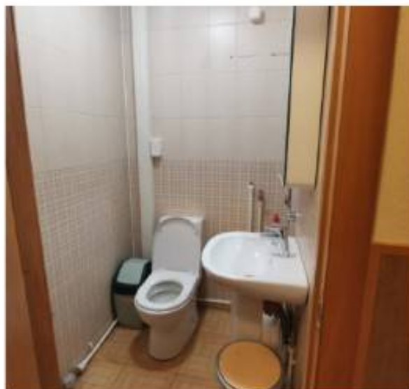
Фото 42. Пом. 19. Санузел. Общий вид.
