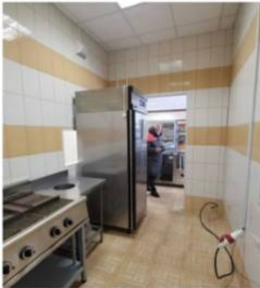
Фото 25. Пом. 11. Класс производственного обучения. Общий вид в сторону выхода.
