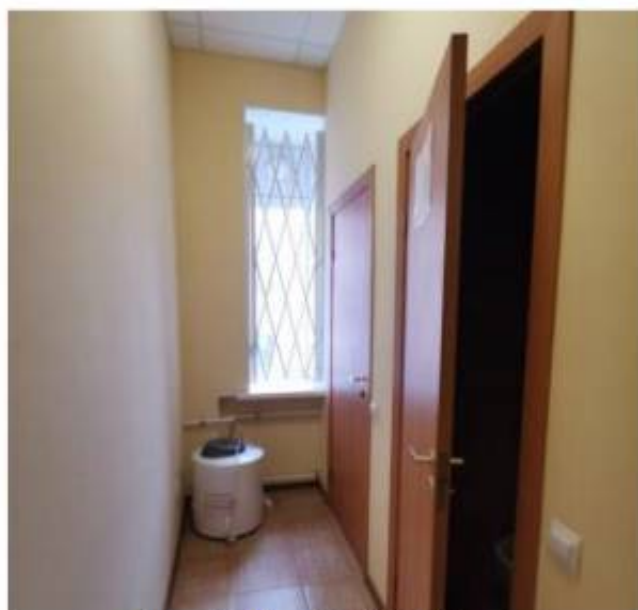
Фото 35. Пом. 13. Общий вид.
