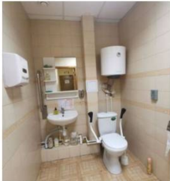
Фото 38. Пом. 21. Санузел для МГН. Общий вид.
