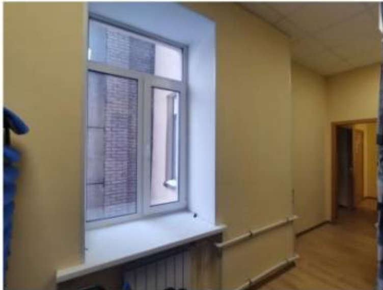
Фото 37. Пом. 14. Кабинет. Общий вид.
