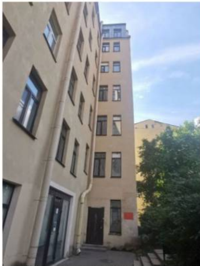
Фото 12. Фрагмент северо-восточного фасада здания.
