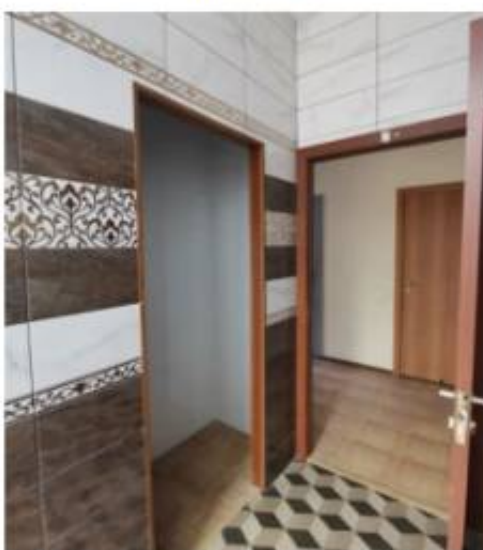
Фото 35.1. Пом. 16. Демонстрационный зал (буфет). Общий вид в сторону подсобных помещений.
