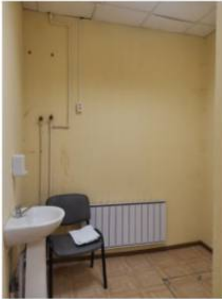
Фото 10. Пом. 5. Коридор. Фрагмент помещения.
