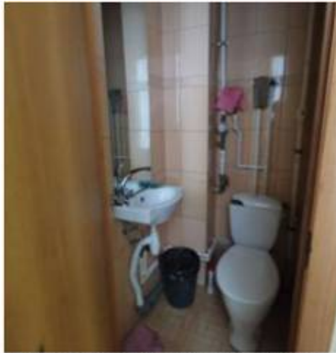
Фото 52. Пом. 30. Санузел. Общий вид.
