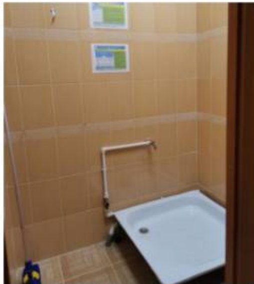
Фото 44. Пом.14. Комната уборочного инвентаря. Общий вид.
