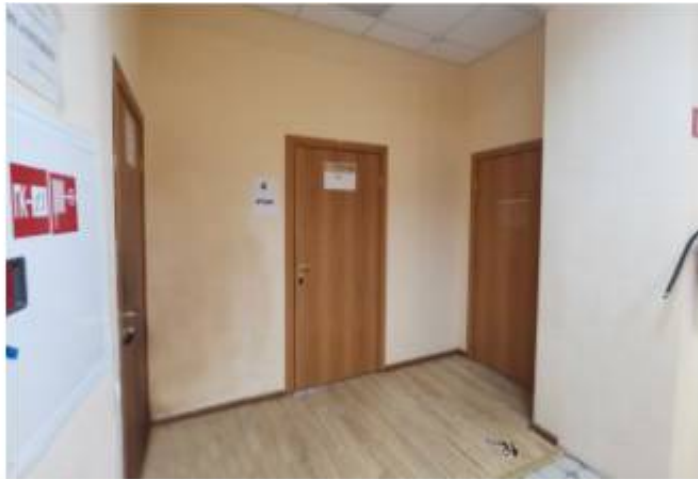
Фото 28. Пом. 6.6. Общий вид площадки лестницы ЛК-6. Входы в учебные кабинеты.
