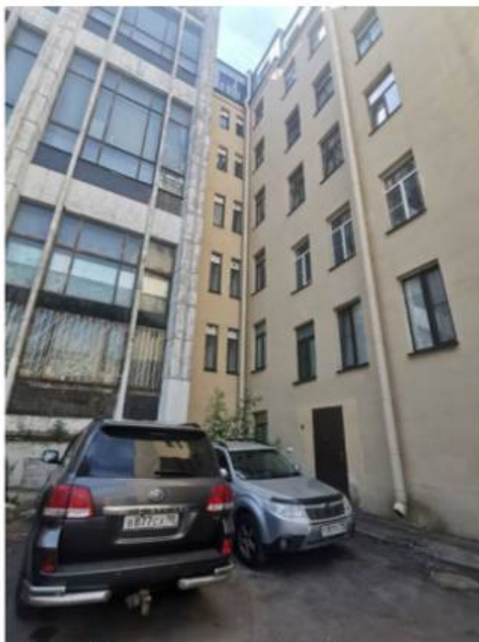
Фото 3. Фрагмент юго-восточного фасада здания.
