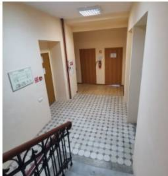
Фото 3. Пом. 7.8. Общий вид площадки лестницы ЛК-7.
