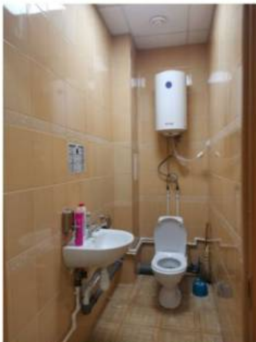
Фото 31. Пом.10. Санузел. Общий вид.
