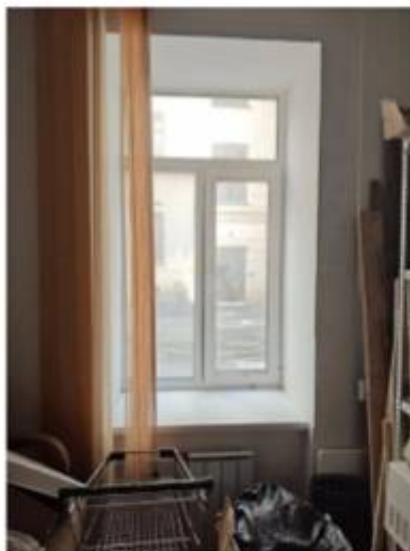
Фото 42.2. Пом. 26. Кладовая. Вид на оконный проем.
