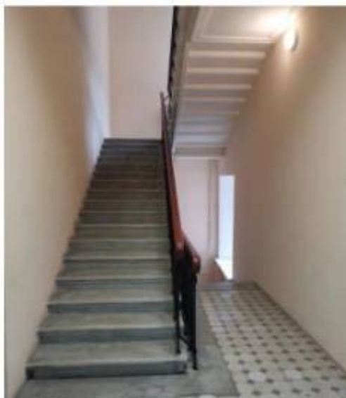
Фото 1. Пом. 7.7. Общий вид лестницы ЛК-7.
