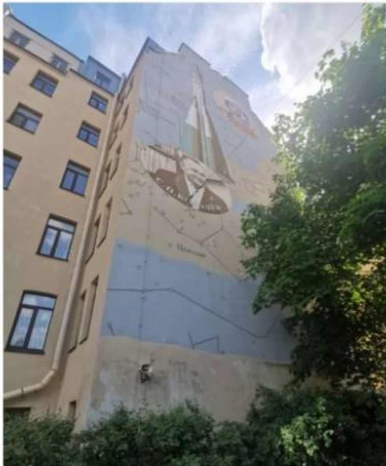
Фото 20. Общий вид торцевого северо-западного фасада, выходящего на Чкаловский проспект.
