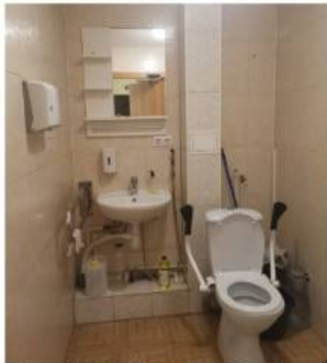
Фото 54. Пом. 26. Санузел. Общий вид.
