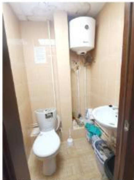
Фото 53. Пом. 25. Санузел. Общий вид.
