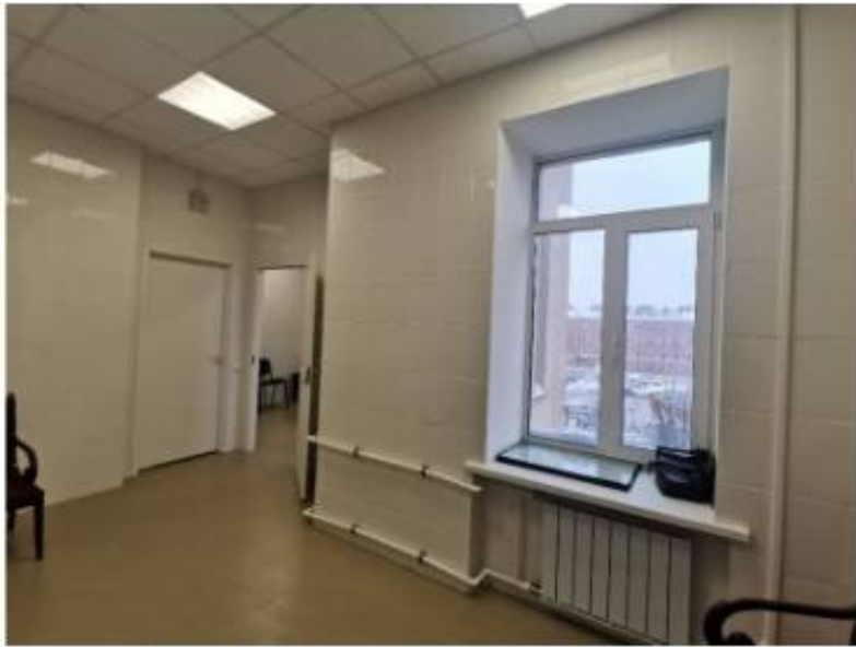
Фото 16. Пом. 6. Кабинет. Общий вид.
