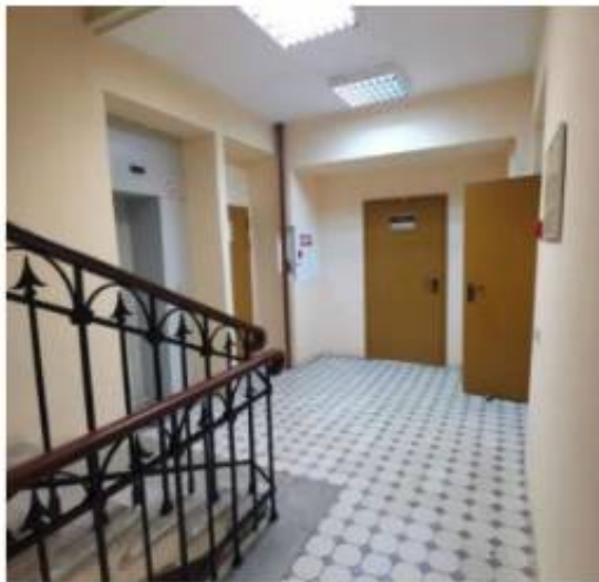
Фото 34. Пом. 7.9. Лестница ЛК-7. Общий вид лестничной площадки.
