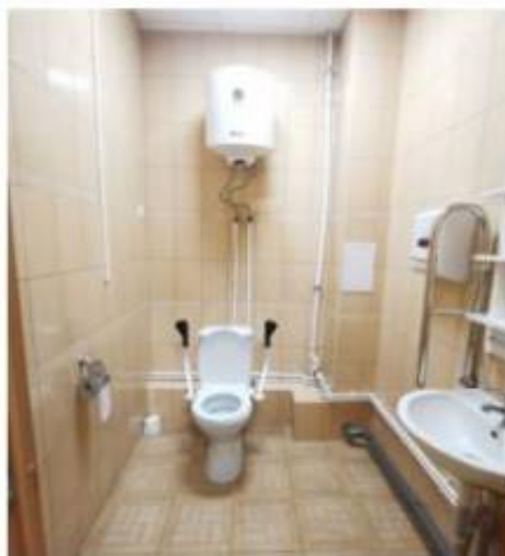
Фото 39. Пом. 17. Санузел для МГН. Общий вид.
