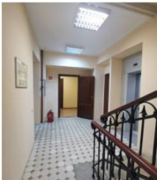
Фото 3. Пом. 7.10. Лестничная клетка ЛК-7. Общий вид.
