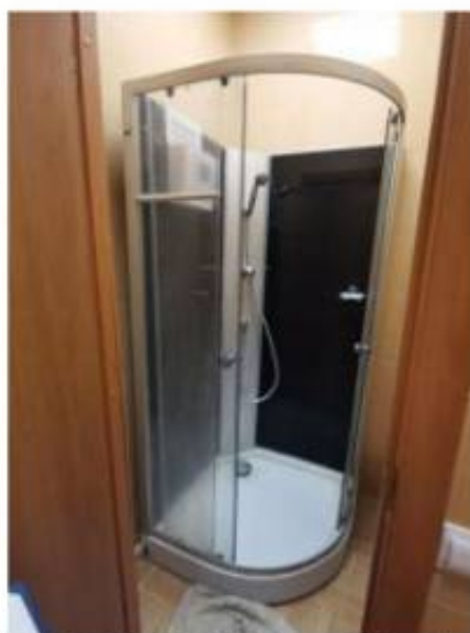
Фото 39. Пом.21. Душевая. Общий вид.
