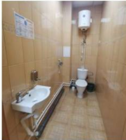
Фото 28. Пом. 8. Санузел. Общий вид
