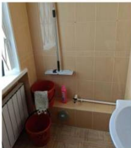
Фото 38. Пом. 14. Санузел. Общий вид.
