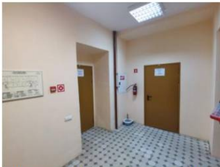
Фото 4. Пом. 7.7. Общий вид площадки лестницы ЛК-7.
