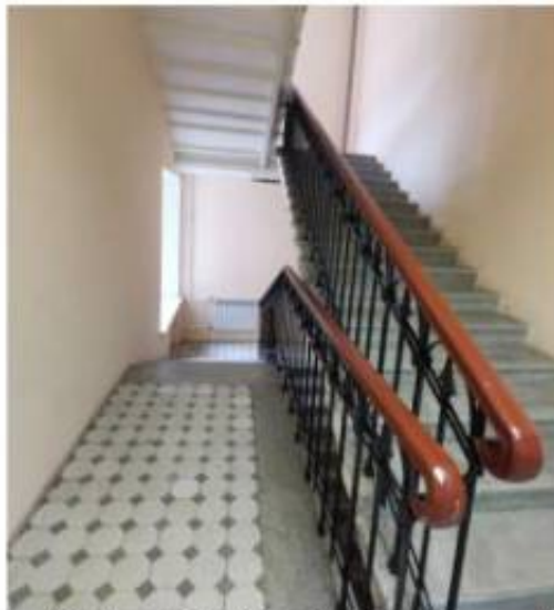
Фото 30. Пом. 6.5. Общий вид лестницы ЛК-6
