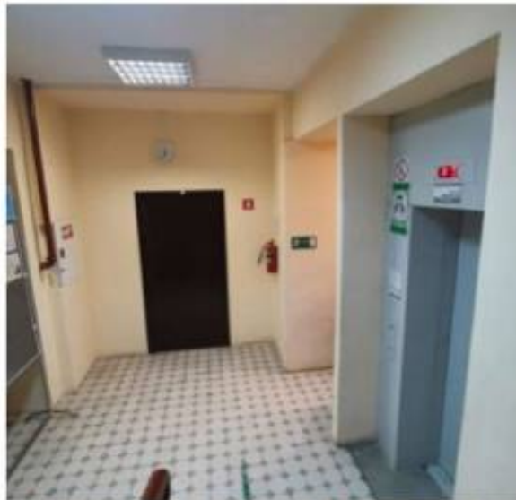
Фото 59. Пом. 7.4. Лестница ЛК-7. Общий вид.
