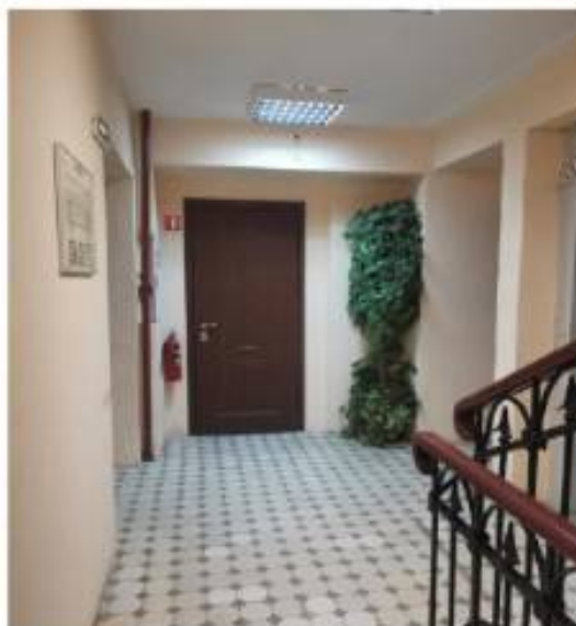
Фото 1. Пом. 7.11. Общий вид лестницы ЛК-7.
