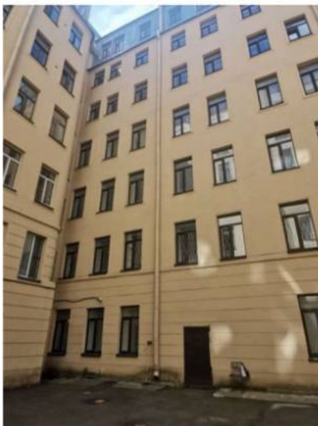
Фото 9. Фрагмент северо-восточного фасада здания во внутреннем дворе. Вид с севера.
