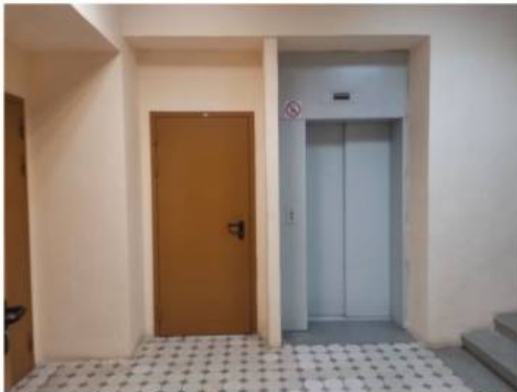
Фото 2. Пом. 7.9. Общий вид площадки лестницы ЛК-7. Вид в сторону лифтовой шахты.
