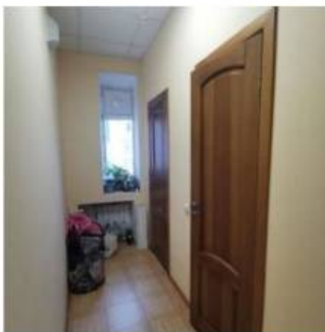
Фото 42. Пом. 17. Коридор. Общий вид.
