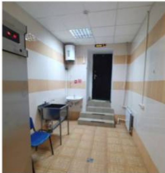
Фото 29. Пом. 15. Тамбур. Общий вид. Выход.
