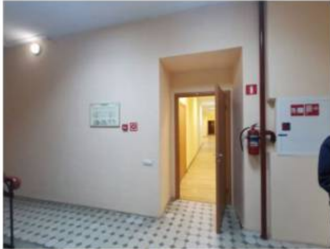
Фото 4. Пом. 7.6. Общий вид лестничной площадки ЛК-7.
