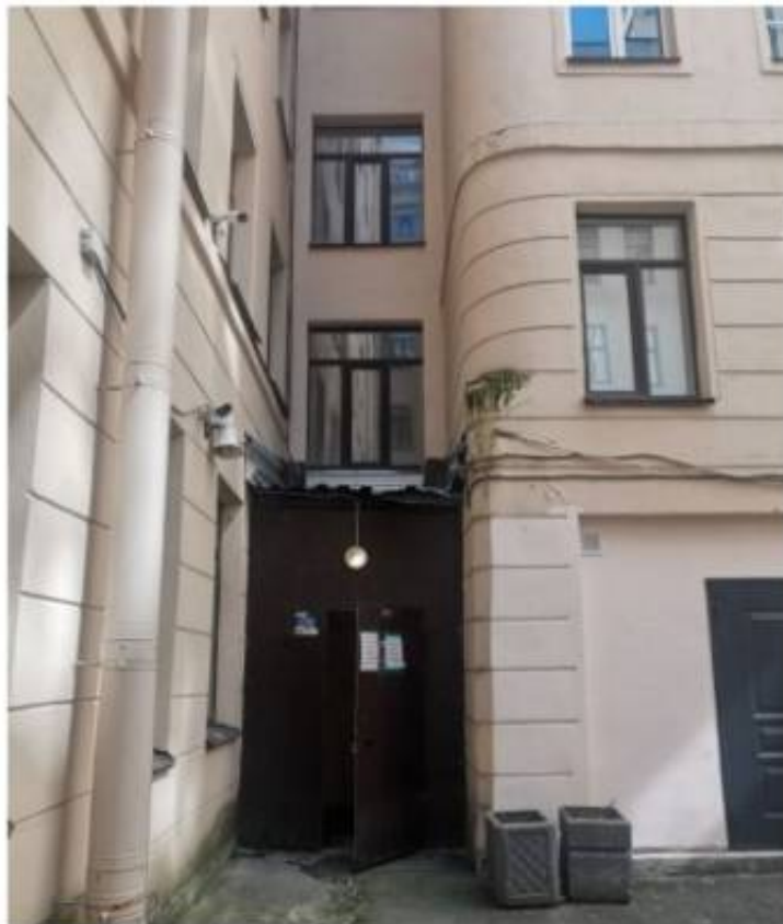
Фото 8. Фрагмент северо-восточного фасада здания во внутреннем дворе. Вход на лестницу ЛК-7.
