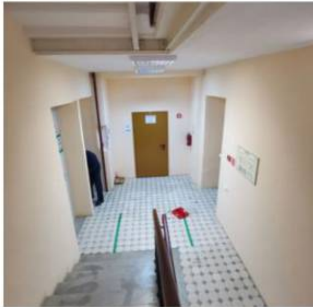
Фото 31. Пом. 6.5. Общий вид площадки лестницы ЛК-6
