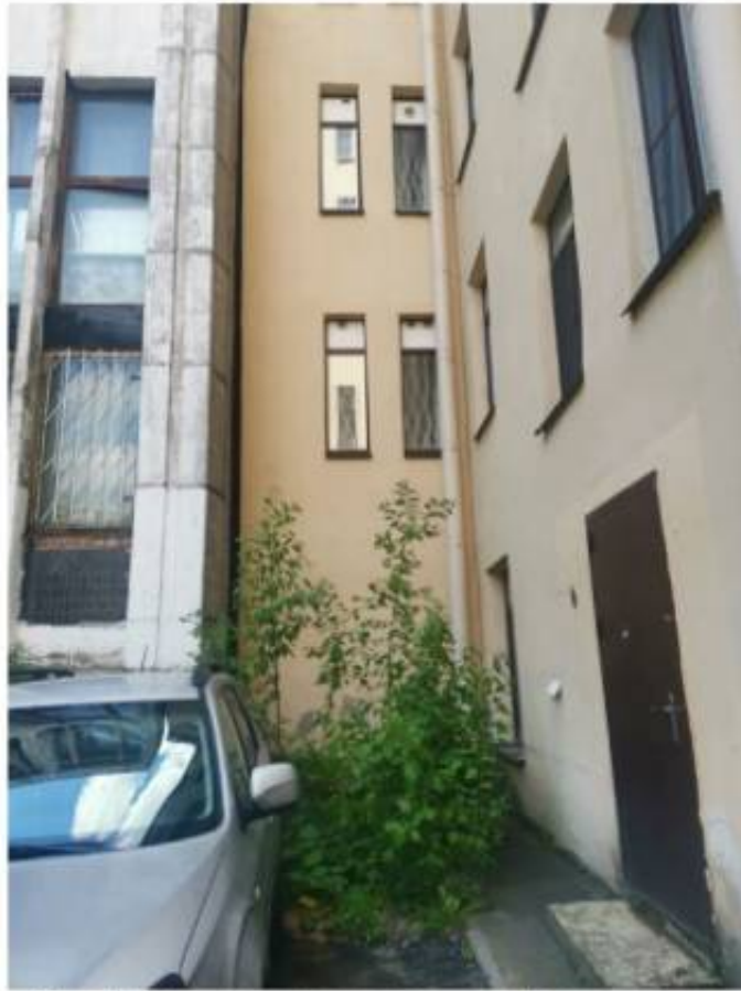
Фото 1. Фрагмент юго-восточного фасада здания.
