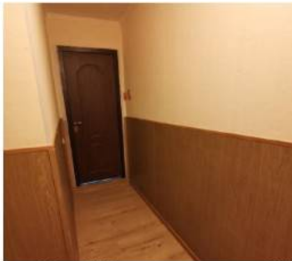
Фото 43. Пом. 17. Выход в сторону лестницы ЛК-7.
