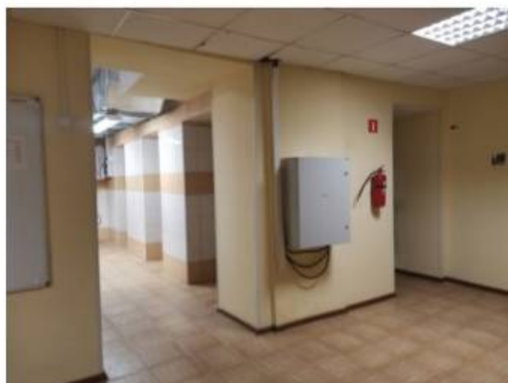
Фото 3. Пом. 1. Холл. Общий вид помещения. Проход к Пом. 2
