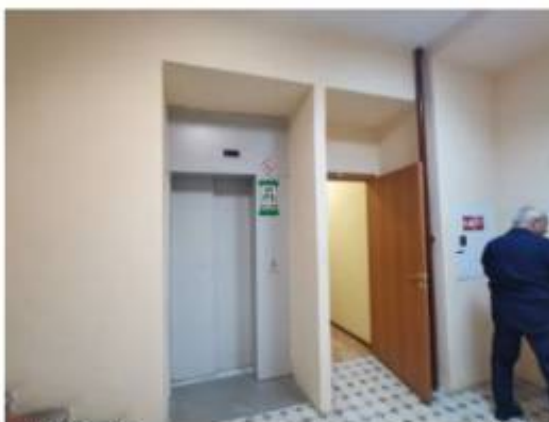
Фото 33. Пом.6.4. Общий вид лестничной площадки ЛК-6 в сторону лифта
