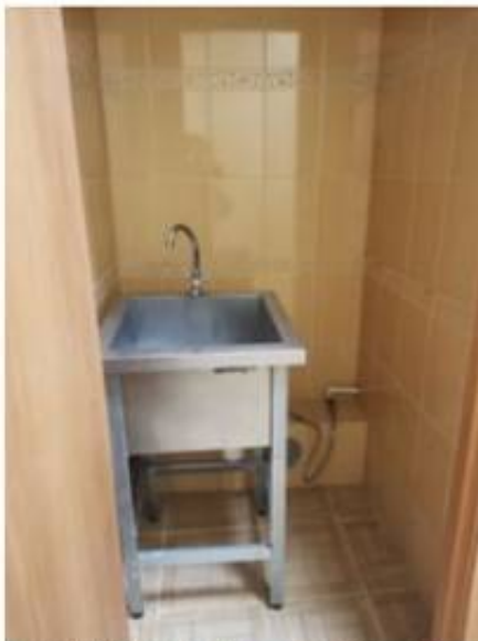
Фото 12. Пом. 6. Санузел. Общий вид.
