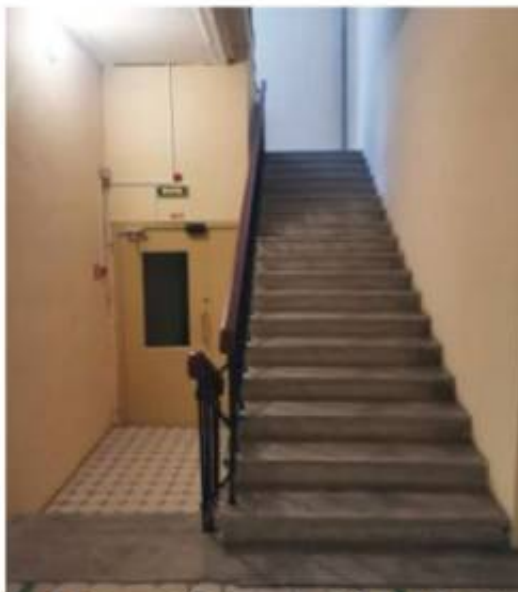
Фото 54. Пом. 6.3. Лестница ЛК-6. Общий вид.
