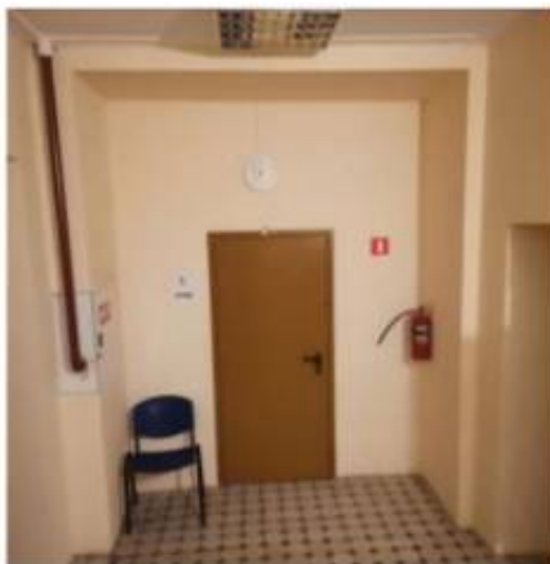
Фото 55. Пом. 6.3. Лестница ЛК-6. Общий вид.
