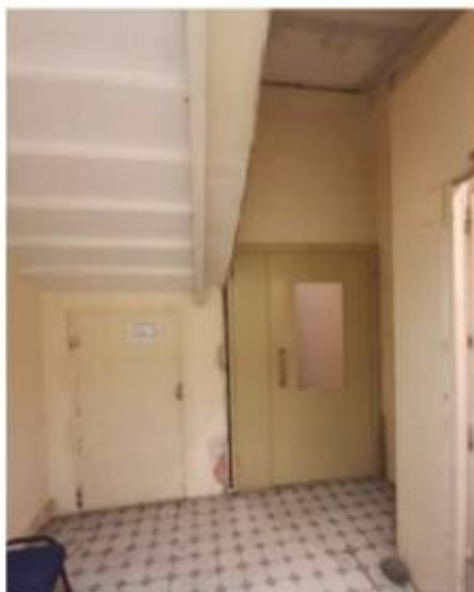
Фото 56. Пом. 6.2. Тамбур. Общий вид.
