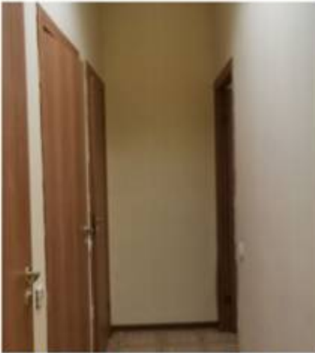
Фото 11. Пом. 5. Коридор. Фрагмент помещения.
