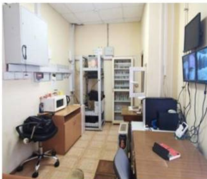
Фото 51. Пом. 29. Комната охраны. Общий вид.
