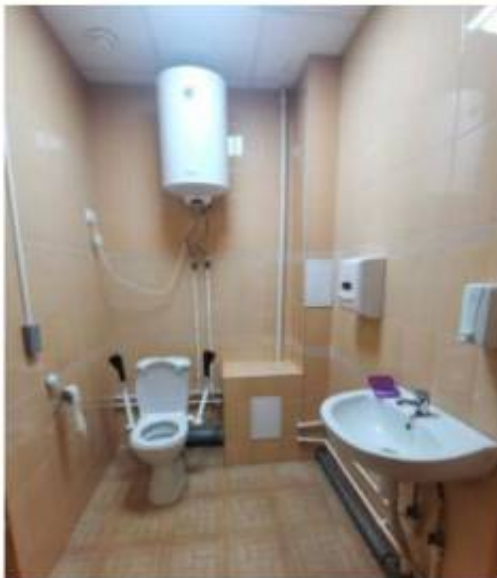
Фото 37. Пом.23. Санузел. Общий вид.
