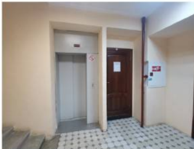
Фото 41. Пом. 6.8. Лестница ЛК-6. Общий вид лестничной площадки в сторону лифта.
