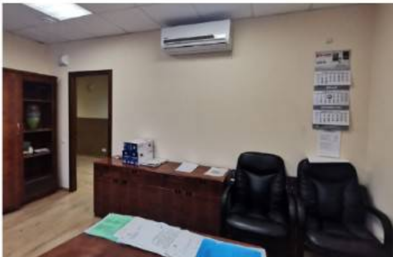
Фото 14. Пом. 4. Кабинет. Общий вид в сторону выхода.
