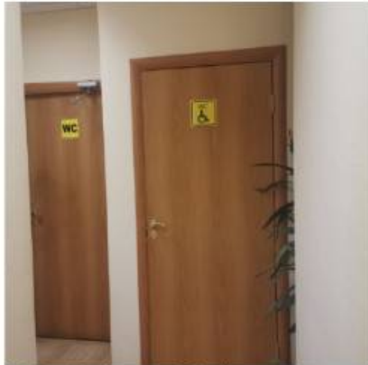
Фото 52. Пом. 23. Коридор. Общий вид в сторону санузлов.
