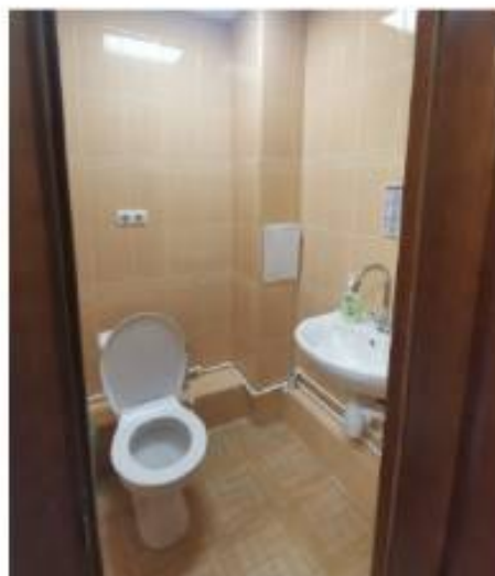
Фото 33. Пом. 15. Санузел. Общий вид.
