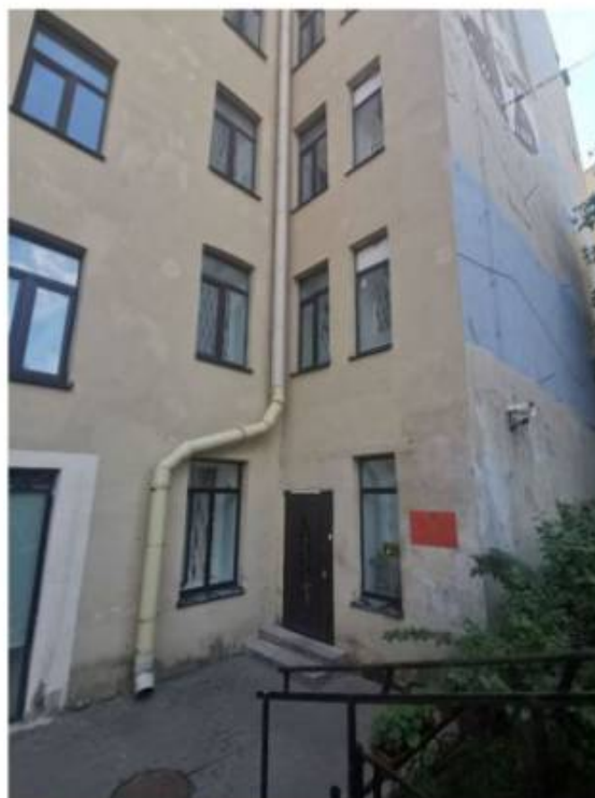
Фото 14. Фрагмент северо-восточного фасада здания. Вид с севера
