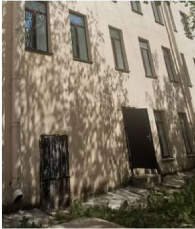
Фото 19. Юго-западный фасад здания. Фрагмент. Вход в здание.
