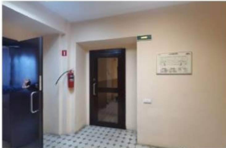
Фото 46. Пом. 6.10. Общий вид лестницы ЛК-7.
