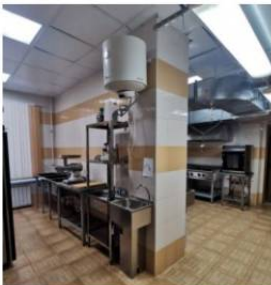
Фото 7. Пом. 2. Класс производственного обучения. Общий вид помещения.
