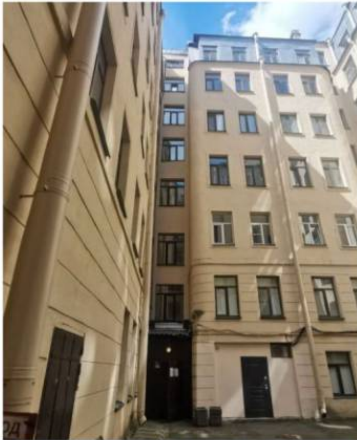
Фото 7. Фрагмент северо-восточного фасада здания во внутреннем дворе.
