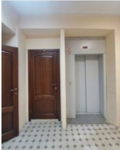
Фото 4. Пом. 7.10. Лестничная клетка ЛК-7. Вид в сторону лифтовой шахты.
