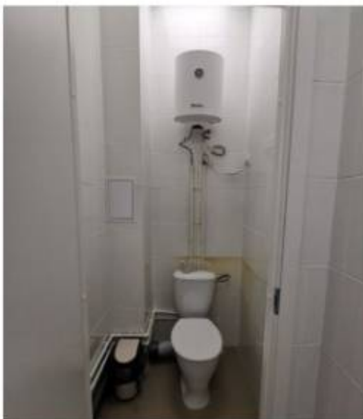
Фото 14. Пом. 4. Санузел. Общий вид.
