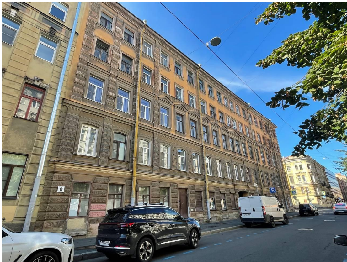
Фото 5. Лицевой фасад объекта культурного наследия регионального значения «Дом, где в 1893-1894 гг. бывал Ленин В.И.» (по Подольской ул.)
