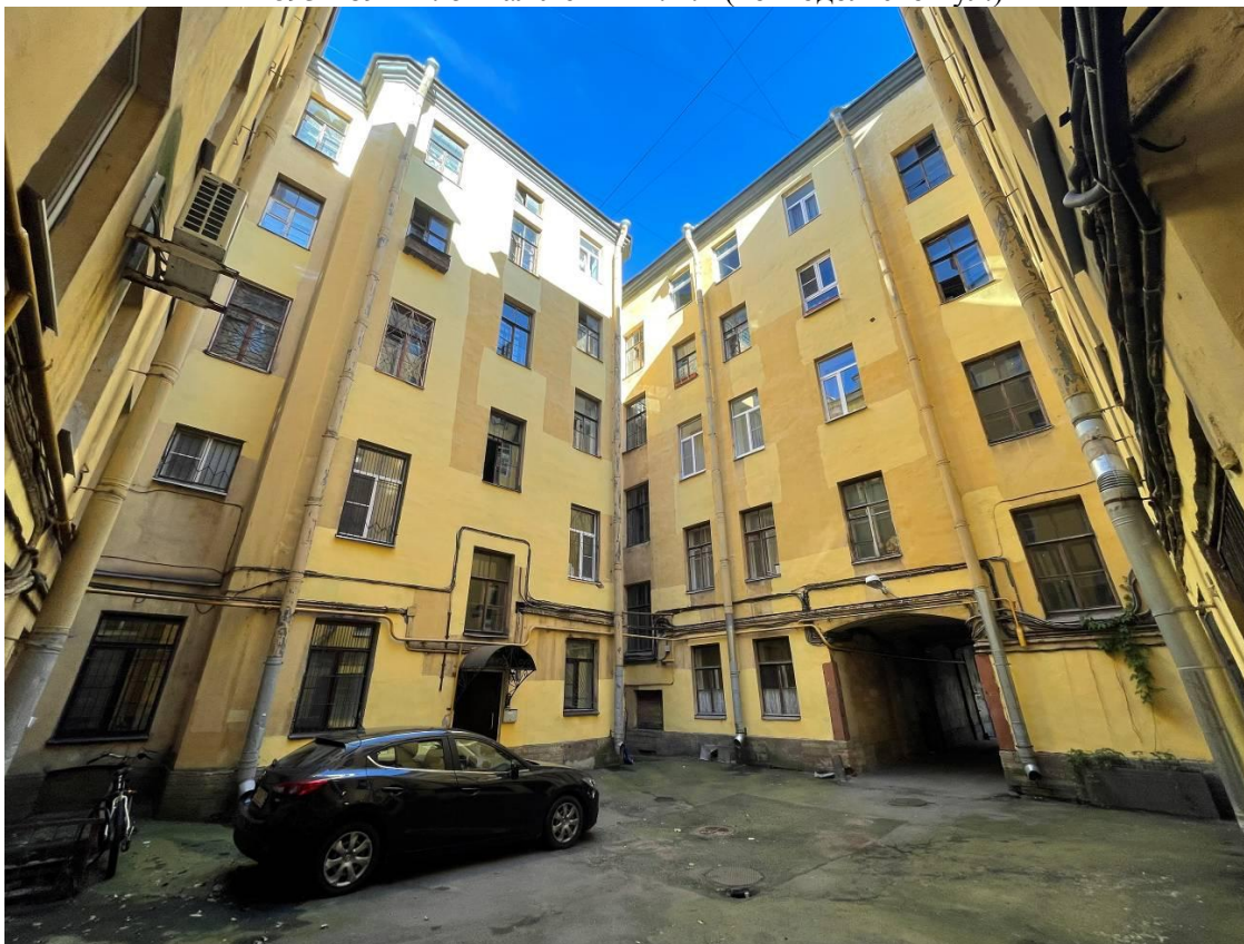
Фото 6. Фрагмент дворового фасада объекта культурного наследия регионального значения «Дом, где в 1893-1894 гг. бывал Ленин В.И.»
