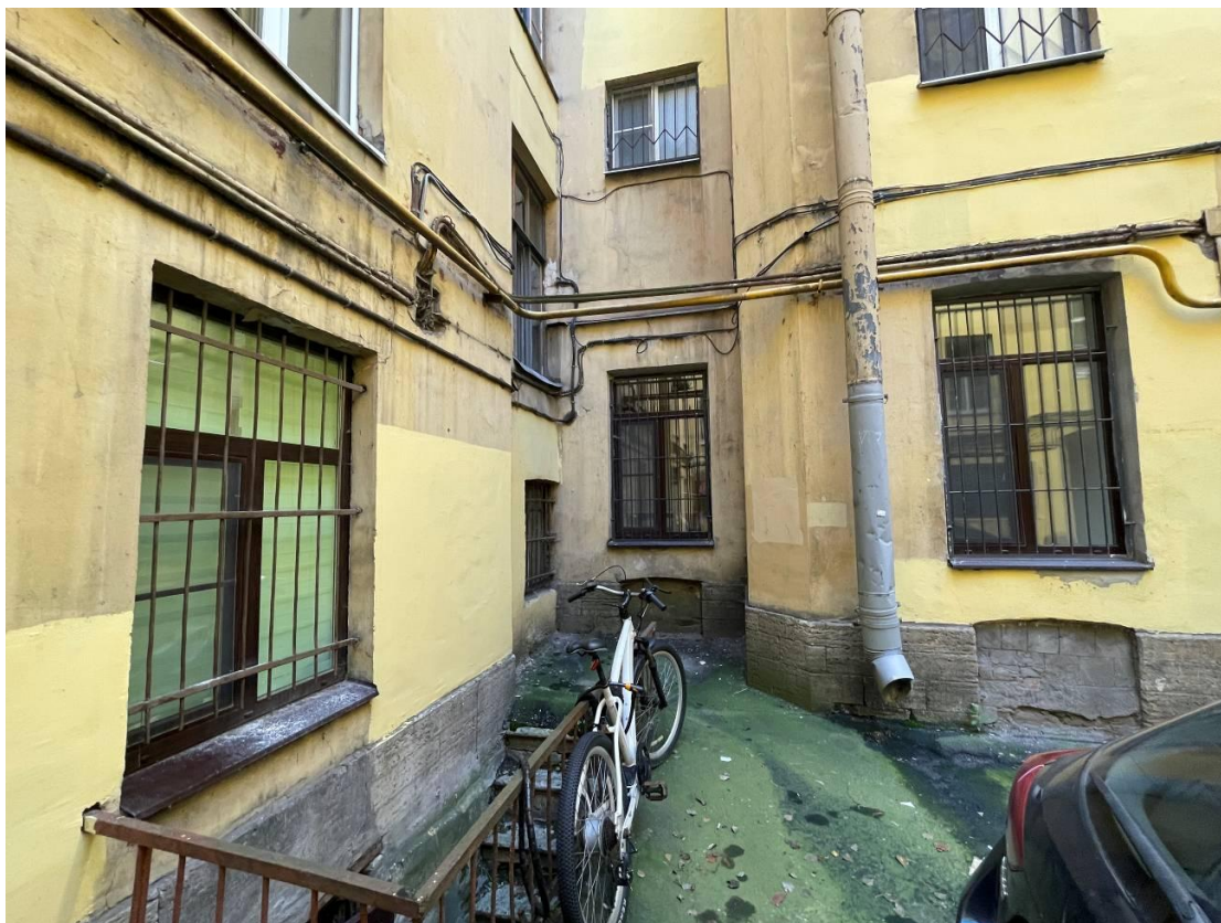
Фото 7. Фрагмент дворового фасада объекта культурного наследия регионального значения «Дом, где в 1893-1894 гг. бывал Ленин В.И.»
