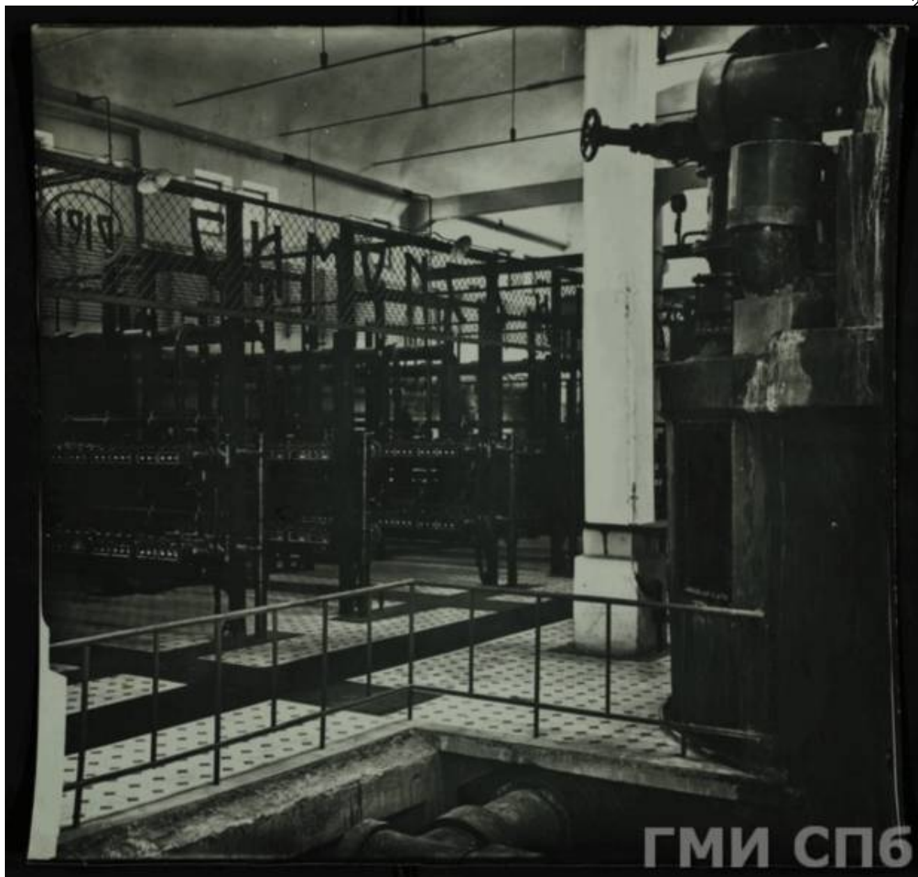
Илл. 60. Фильтроозонная станция, 1910-1911 гг. Госкаталог РФ. ГМИ СПб Инв.№-II-Б-4492ф
