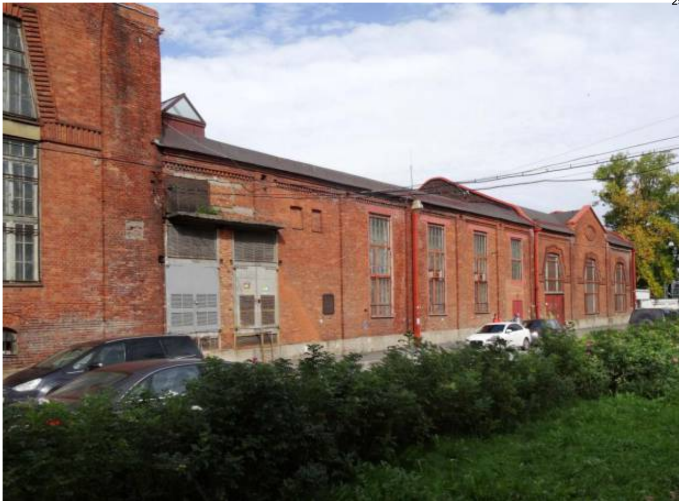
Илл. 95. Фильтрационная станция, 2016 г. [Электронный ресурс] URL: https://www.citywalls.ru/house7235.html?s=07of1i7r7ndm14gf1hm8plo2f
