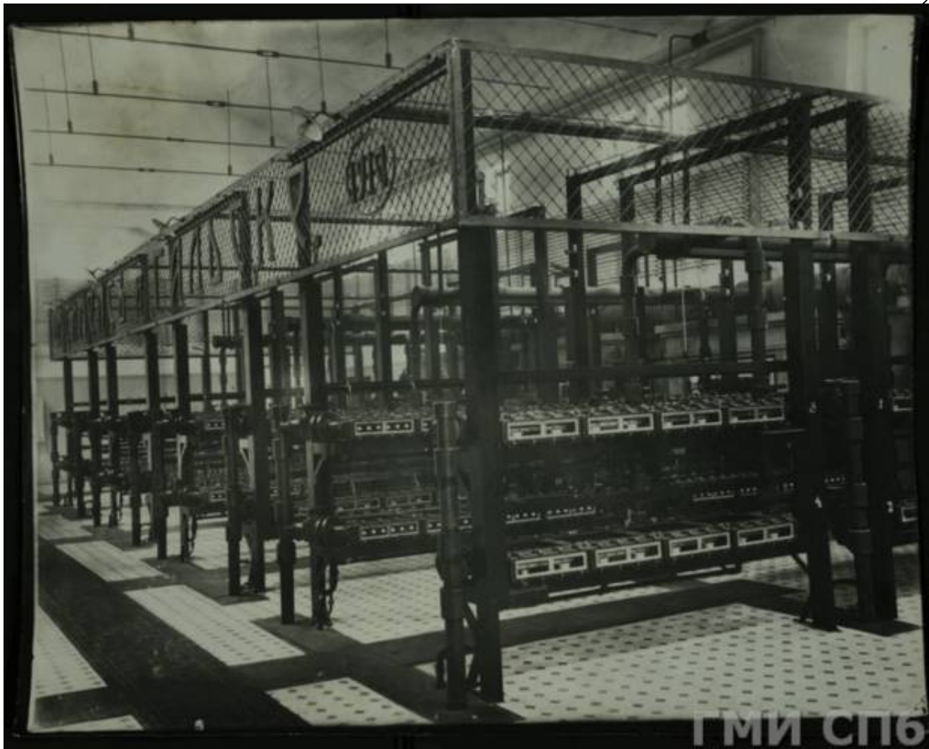
Илл. 59. Фильтроозонная станция, 1910-1911 гг. Госкаталог РФ. ГМИ СПб Инв.№-II-Б-4262ф
