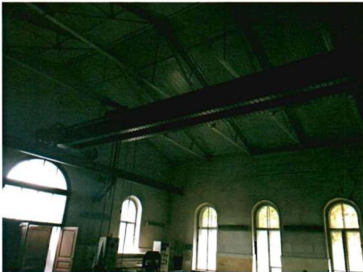
6. Помещение 5-Н (29), историческое оборудование – кран-балки.
