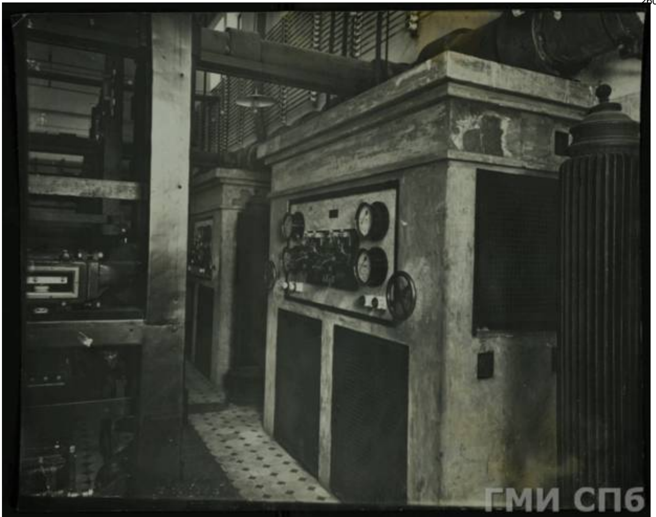
Илл. 58. Фильтроозонная станция, 1910-1911 гг. Госкаталог РФ. ГМИ СПб Инв.№-II-Б-4499ф
