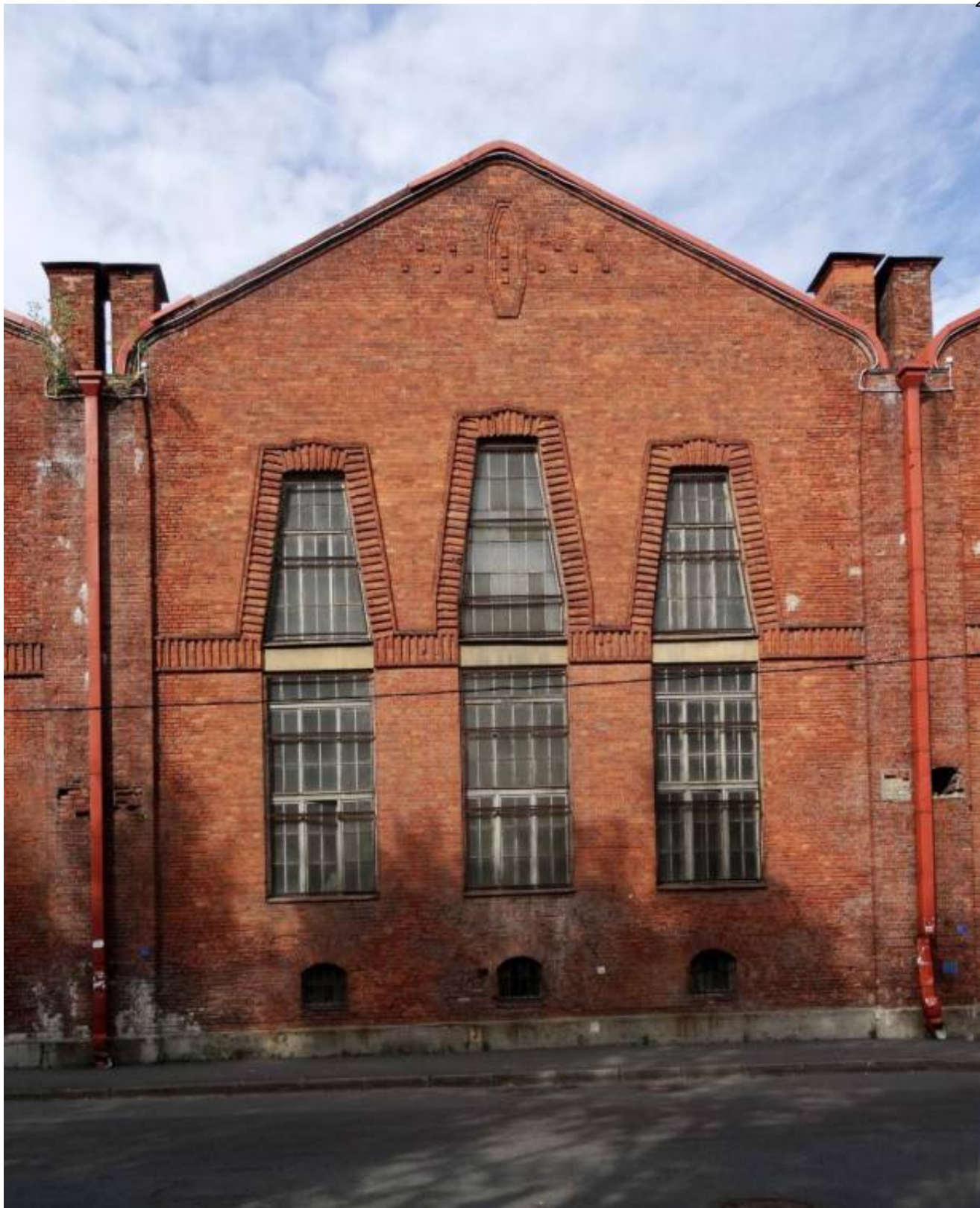
Илл. 94. Фильтроозонная станция, 2016 г. [Электронный ресурс] URL: https://www.citywalls.ru/house7235.html?s=07of1i7r7ndm14gf1hm8plo2f
