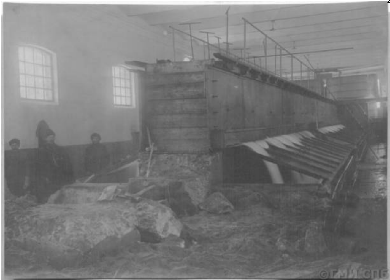
Илл. 57. Санкт-Петербургские городские водопроводы. Установка для озонирования воды на главной водопроводной станции, конец XIX века. Госкаталог РФ. ГМИ СПб Инв.№-II-A-19145ф
