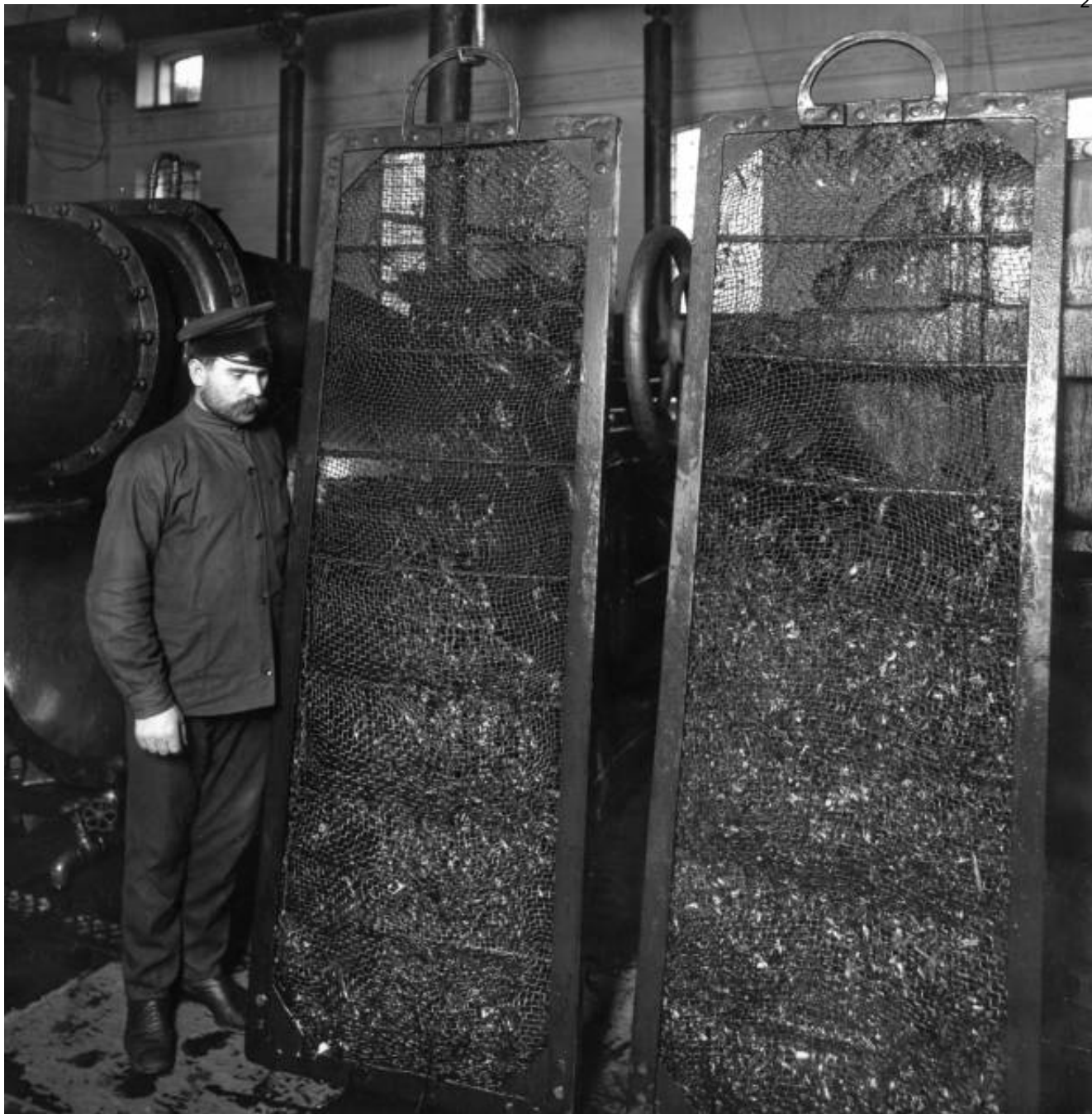
Илл. 78. Чистка фильтров. Экспозиция в Музее воды, начало XX века.
