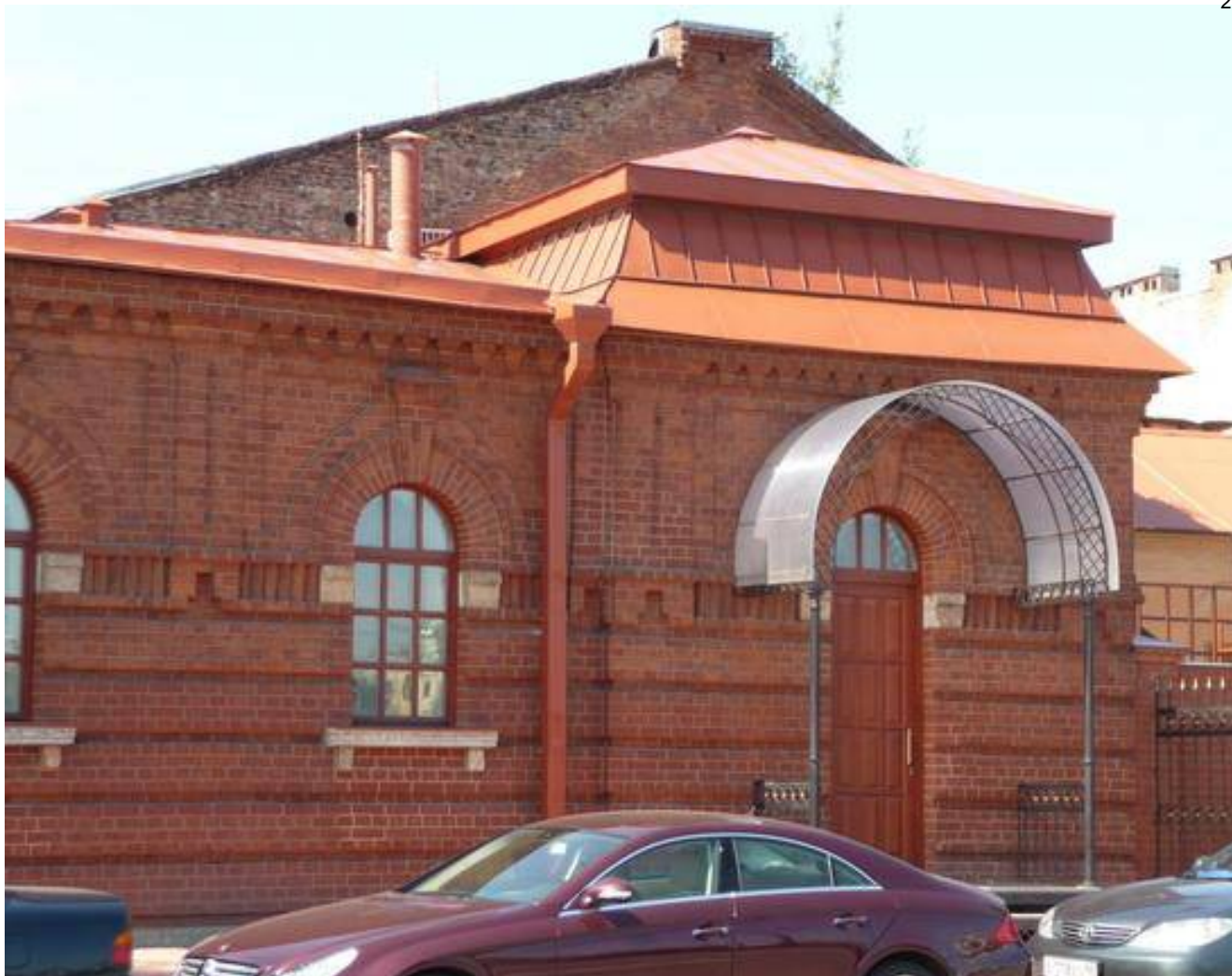
Илл. 97. Фильтрационная станция, 2016 г. [Электронный ресурс] URL: https://www.citywalls.ru/house7235.html?s=07of1i7r7ndm14gf1hm8plo2f
