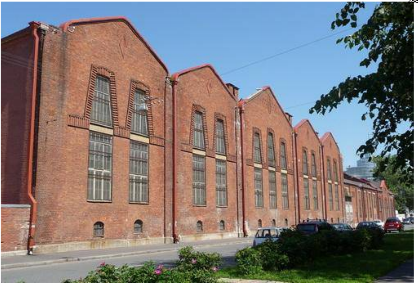
Илл. 91. Фильтрационная станция, 2016 г. [Электронный ресурс] URL: https://www.citywalls.ru/house7235.html?s=07of1i7r7ndm14gf1hm8plo2f
