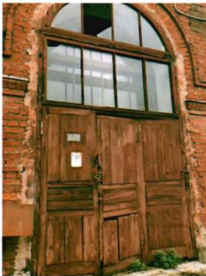
2. Дверное заполнение по лицевому фасаду.
