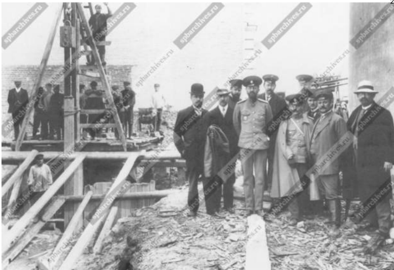
Илл. 81. Группа инженеров-строителей станции, 1912 г. ЦГАКФФД СПб. Фотодокументы. Опись 1Д-8. Ед.хр. 6781
