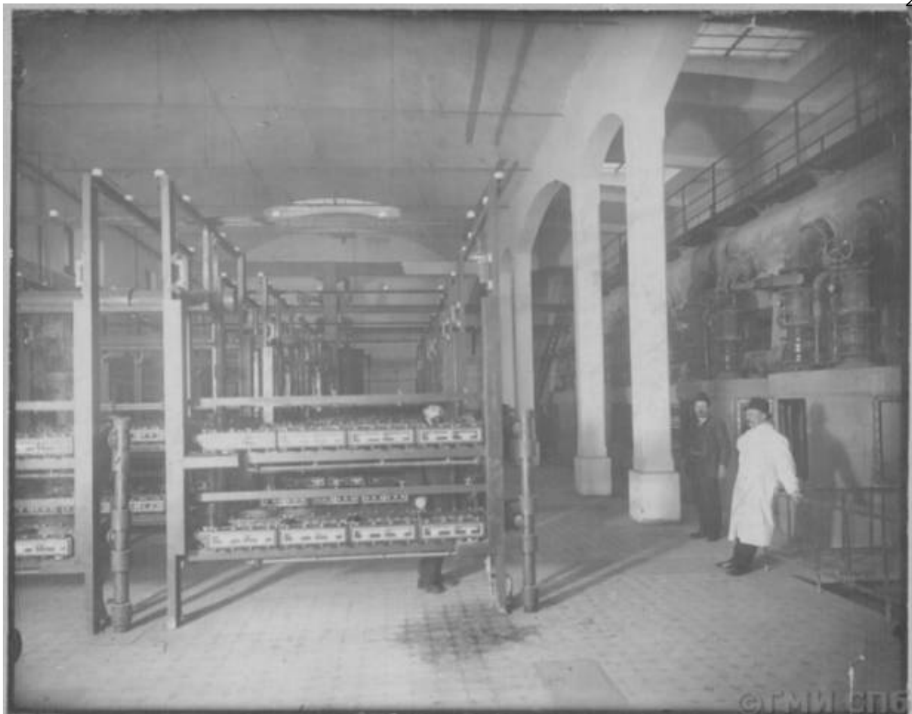
Илл. 56. Санкт-Петербургская фильтроозонная станция (Пеньковская ул., 8). Внутренний вид., 1910 г. – Госкаталог РФ. ГМИ СПб Инв.№-II-A-192262ф
