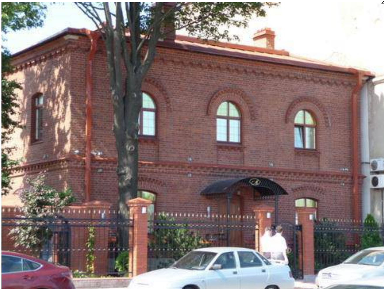
Илл. 99. Фильтрационная станция, 2016 г. [Электронный ресурс] URL: https://www.citywalls.ru/house7235.html?s=07of1i7r7ndm14gf1hm8plo2f
