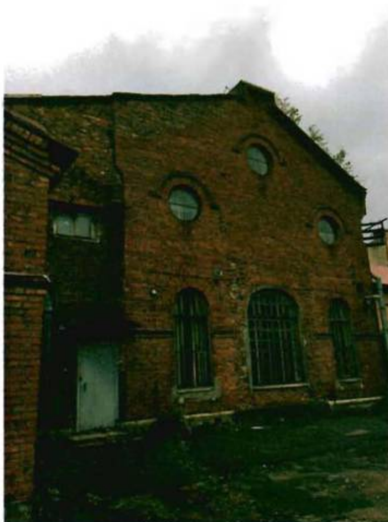
4. Фрагмент лицевого фасада.
