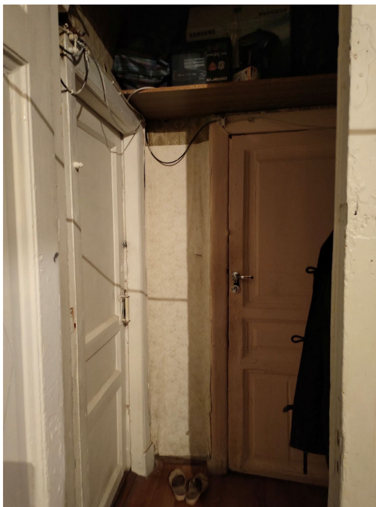
8. Выявленный объект культурного наследия «Дом Тампера» (г. Санкт-Петербург, Якубовича ул., д. 22). Помещение кв.№5
