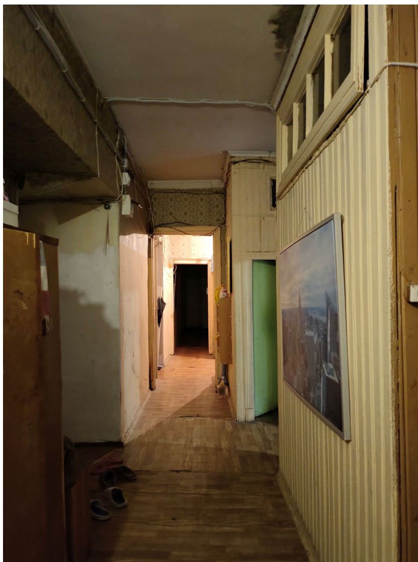
15. Выявленный объект культурного наследия «Дом Тампера» (г. Санкт-Петербург, Якубовича ул., д. 22). Помещение кв.№5
