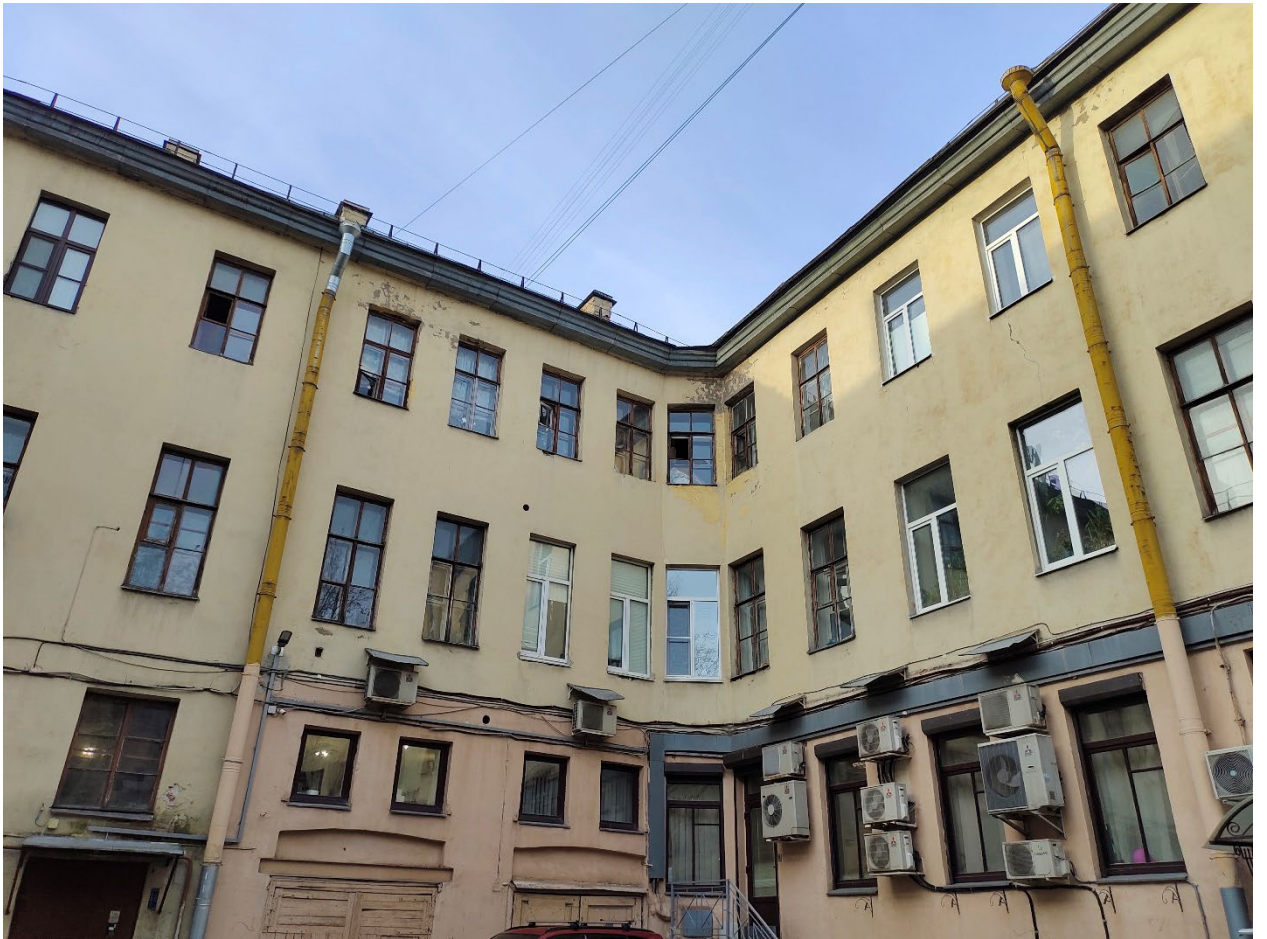
3. Выявленный объект культурного наследия «Дом Тампера» (г. Санкт-Петербург, Якубовича ул., д. 22). Дворовый фасад.
