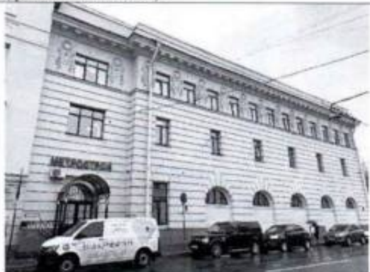
Фото 4. Северо-восточный фасад (фото от 12.05.2022).
