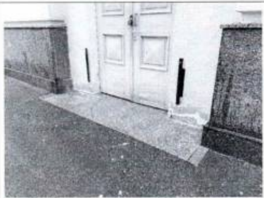
Фото 8. Крыльцо со стороны юго-западного фасада (фото от 12.05.2022).
