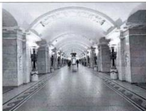
Фото 31. Перронный зал(фото от 12.05.2022).
