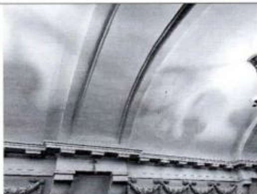
Фото 32. Перронный зал (фото от 12.05.2022).
