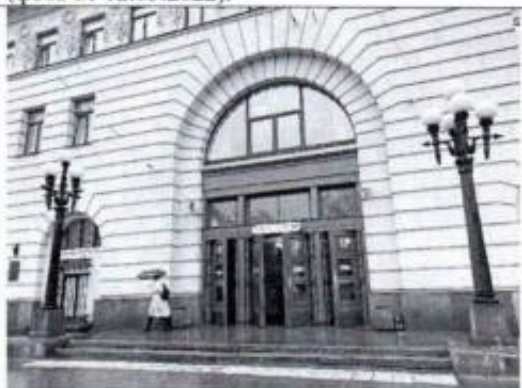
Фото 6. Крыльцо со стороны северо-западного фасада (фото от 12.05.2022).
