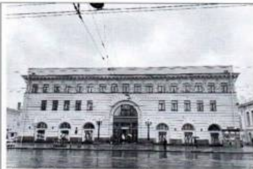
Фото 1. Северо-западный фасад (фото от 12.05.2022).
