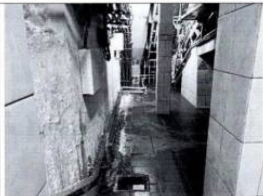
Фото 44. Помещение подвала (2-Н (21)) (фото от 05.09.2022).
