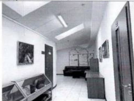
Фото 77. Помещение мансардного этажа (фото от 12.05.2022).
