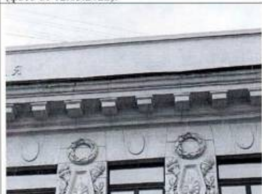
Фото 12. Фрагмент юго-восточного фасада (фото от 12.05.2022).
