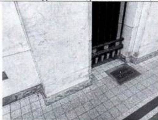
Фото 41. Перронный зал (фото от 12.05.2022).
