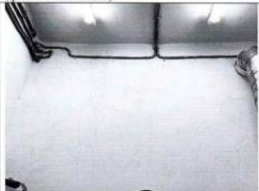
Фото 30. Помещение подвала (2-Н (65) (фото от 12.05.2022).
