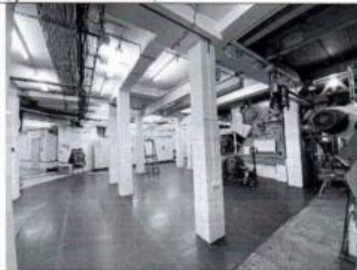
Фото 29. Помещение подвала (2-Н (21) (фото от 12.05.2022).
