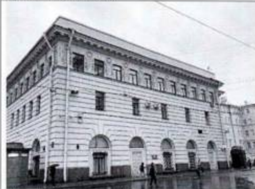
Фото 3. Юго-западный фасад (фото от 12.05.2022).
