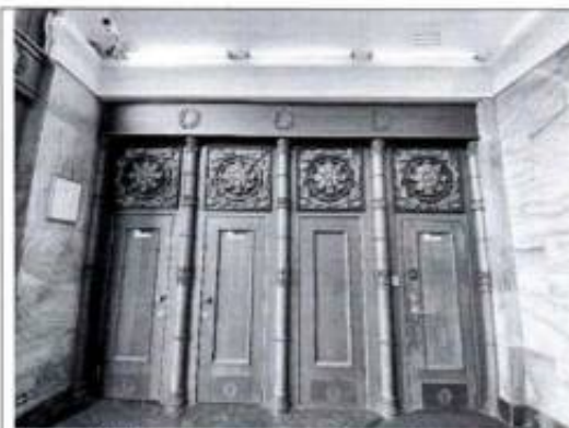
Фото 49. Помещение вестибюля (пом. 2-Н (1) (фото от 12.05.2022).
