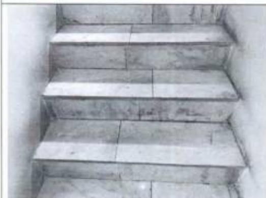
Фото 23. Лестница (пом. 3-Н (1)) (фото от 12.05.2022).
