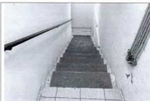
Фото 19. Лестница (пом. 2-Н (50)) (фото от 12.05.2022).
