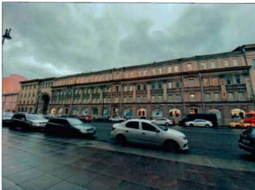
4. Западный лицевой фасад части объекта культурного наследия.
