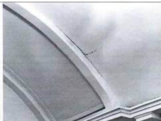
Фото 43. Перронный зал (фото от 05.09.2022).
