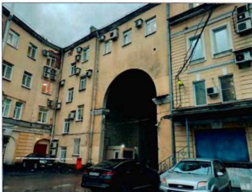
7. Восточный дворовой фасад части объекта культурного наследия.
