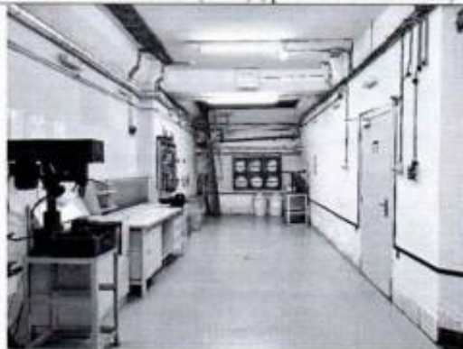
Фото 27. Помещение подвала (2-Н (61) (фото от 05.09.2022).
