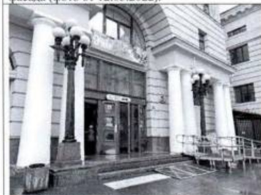
Фото 9. Фрагмент юго-восточного фасада (фото от 12.05.2022).
