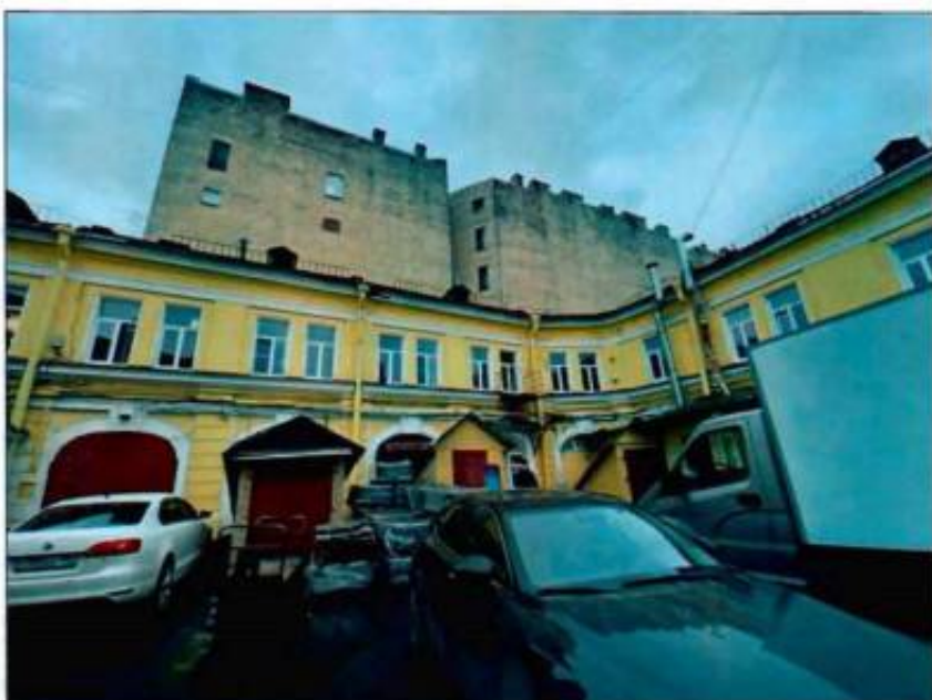
9. Фрагмент юго-восточного фасада части объекта культурного наследия.
