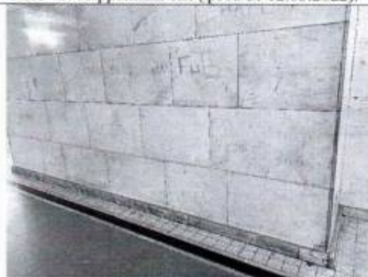
Фото 42. Перронный зал (фото от 12.05.2022).
