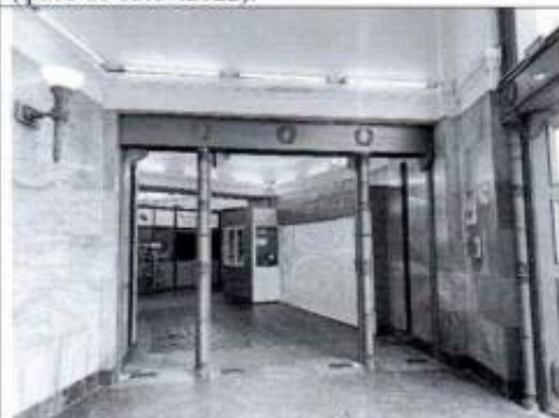
Фото 47. Помещение вестибюля (пом. 2-Н (1)) (фото от 12.05.2022).
