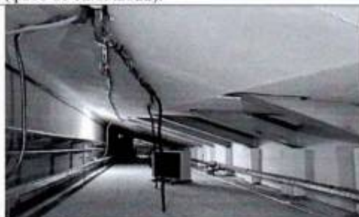
Фото 17. Фрагмент конструкции крыши (фото от 12.05.2022).
