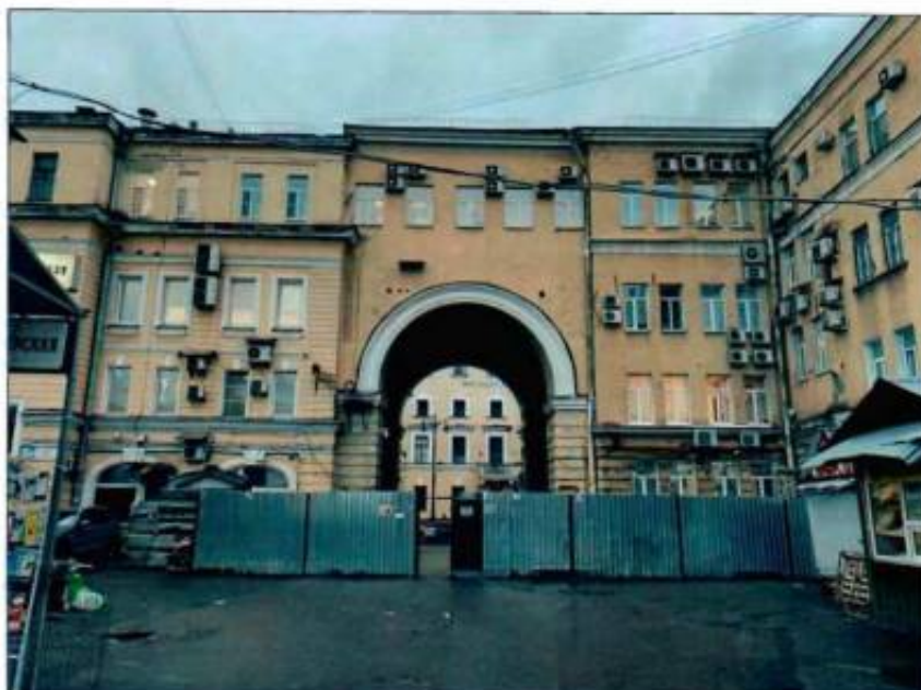
2. Восточный дворовой фасад части объекта культурного наследия.
