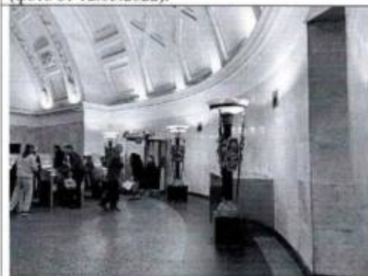
Фото 51. Помещение эскалаторного зала (пом. 2-Н (31) (фото от 12.05.2022).
