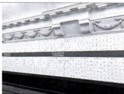
Фото 38. Перронный зал (фото от 12.05.2022).
