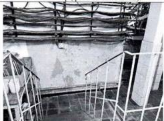
Фото 28. Помещение подвала (2-Н (21) (фото от 05.09.2022).
