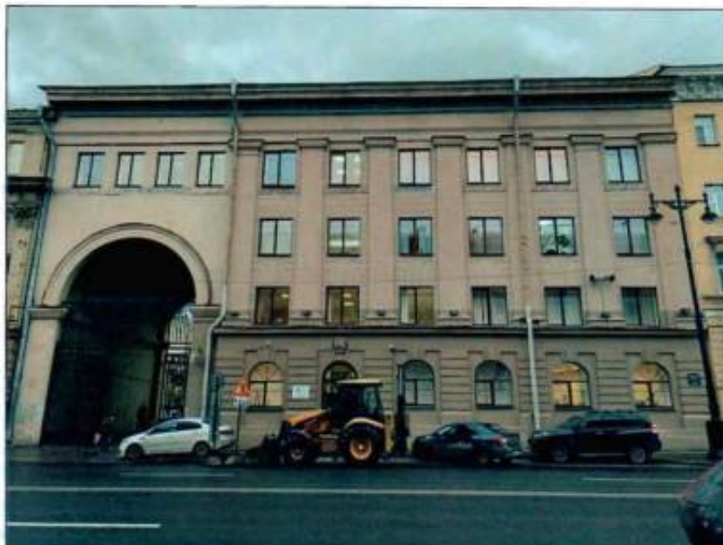
6. Западный лицевой фасад части объекта культурного наследия.
