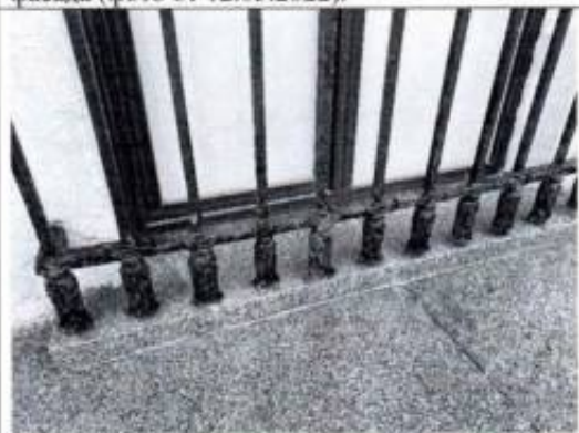
Фото 10. Фрагмент северо-западного фасада (фото от 12.05.2022).
