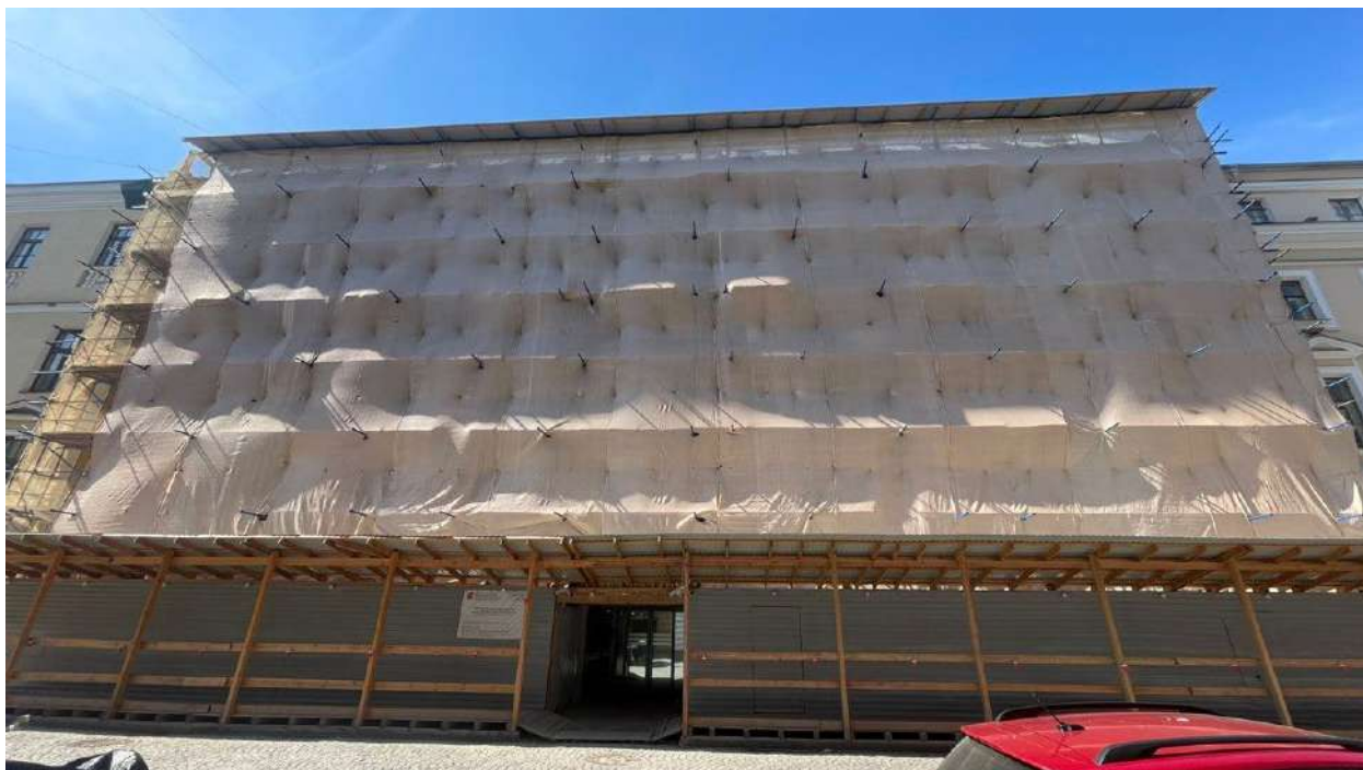
Фото 1. Общий вид на лицевой фасад объекта с ул. Галерной.
