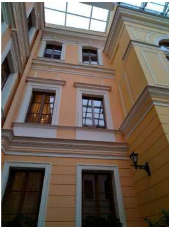
Фото 18. Фрагмент дворового фасада объекта.
