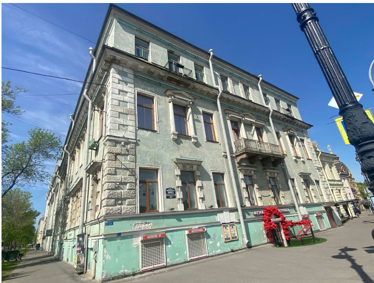
2. Юго- восточный лицевой фасад объекта культурного наследия регионального значения «Дом Ф.А. Голицына (Э. Паннаша)», расположенный по адресу: г. Санкт-Петербург, 16-я линия В.О., д. 1/33, литера А. 27.05.2026
