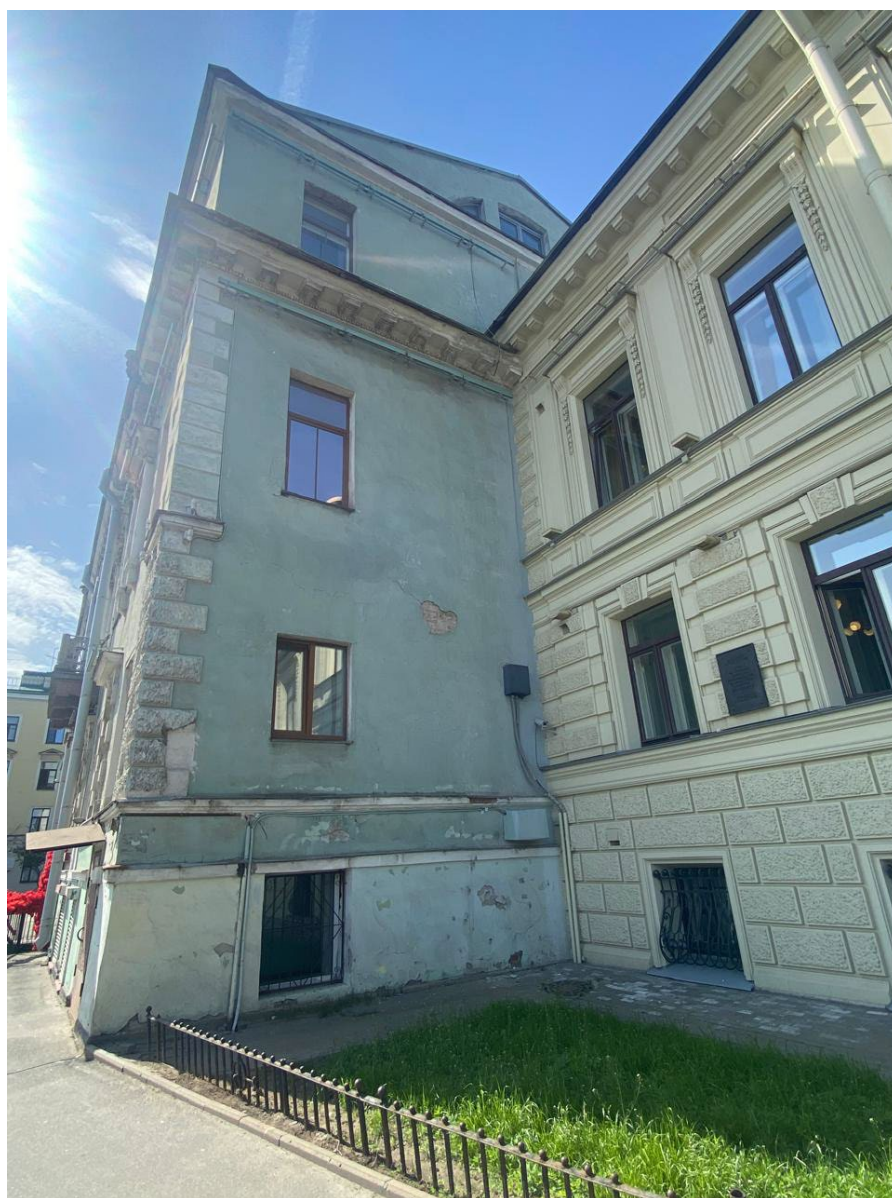
3. Юго-восточный лицевой фасад объекта культурного наследия регионального значения «Дом Ф.А. Голицына (Э. Паннаша)», расположенный по адресу: г. Санкт-Петербург, 16-я линия В.О., д. 1/33, литера А. 27.05.2026
