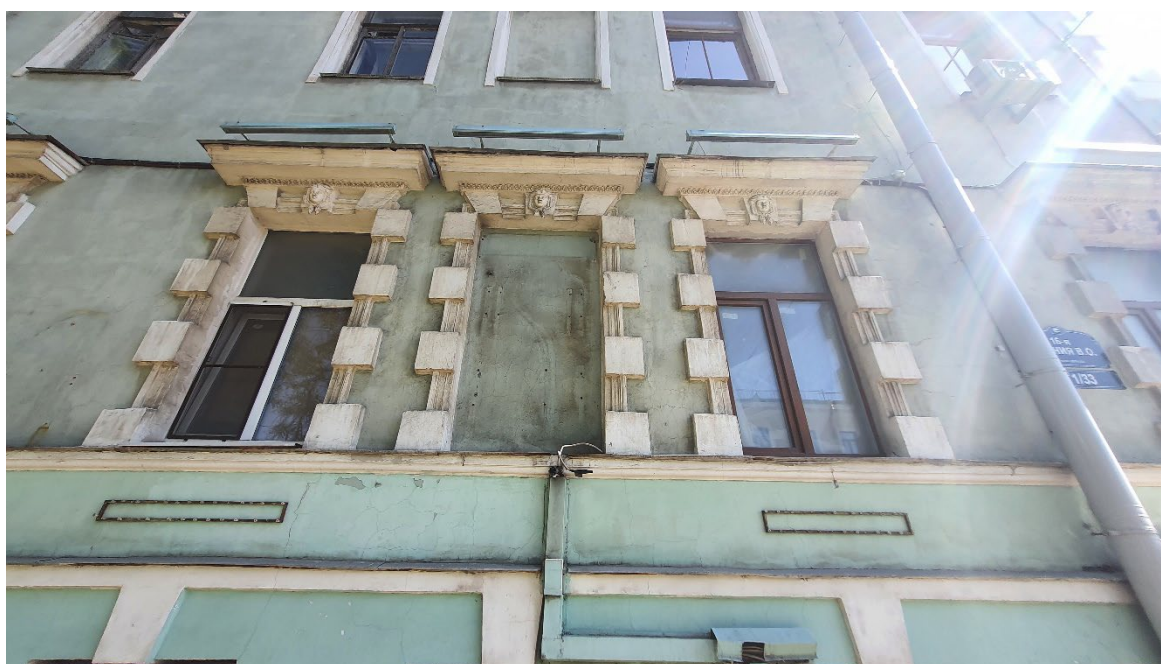
6. Юго- западный лицевой фасад объекта культурного наследия регионального значения «Дом Ф.А. Голицына (Э. Паннаша)», расположенный по адресу: г. Санкт-Петербург, 16-я линия В.О., д. 1/33, литера А. Фрагмент. 27.05.2026
