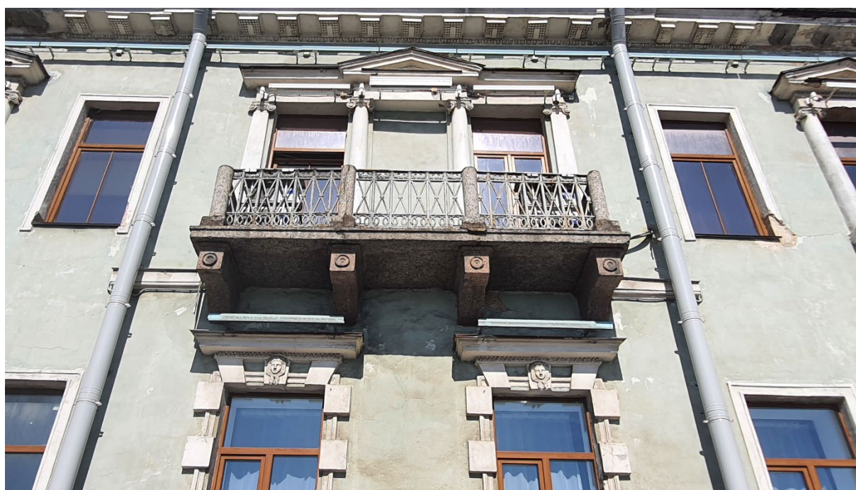
4. Юго-восточный лицевой фасад объекта культурного наследия регионального значения «Дом Ф.А. Голицына (Э. Паннаша)», расположенный по адресу: г. Санкт-Петербург, 16-я линия В.О., д. 1/33, литера А. Фрагмент. 27.05.2026
