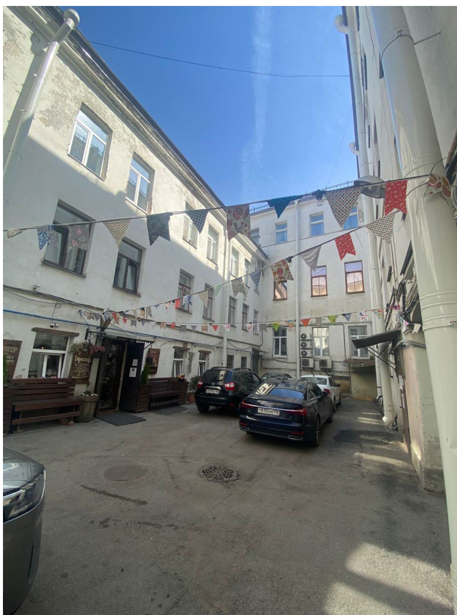
13. Дворовый фасады объекта культурного наследия регионального значения «Дом Ф.А. Голицына (Э. Паннаша)», расположенный по адресу: г. Санкт-Петербург, 16-я линия В.О., д. 1/33, литера А. Фрагмент. 27.05.2026
