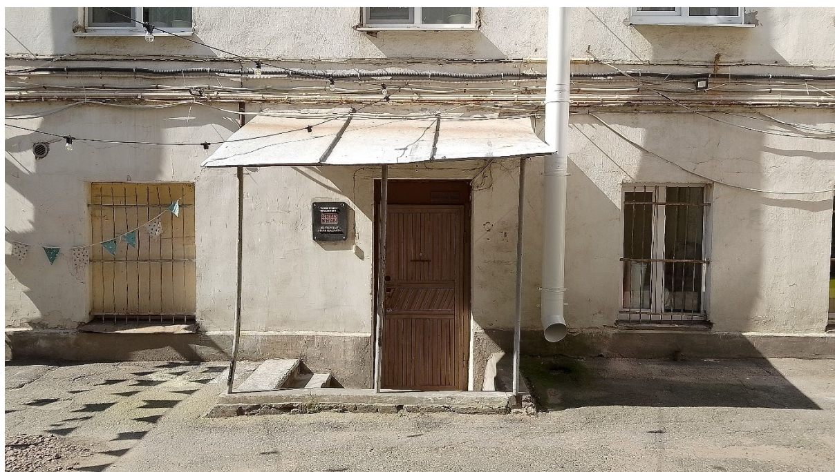
16. Прямок дворового фасада объекта культурного наследия регионального значения «Дом Ф.А. Голицына (Э. Паннаша)», расположенный по адресу: г. Санкт-Петербург, 16-я линия В.О., д. 1/33, литера А. Фрагмент. 27.05.2026
