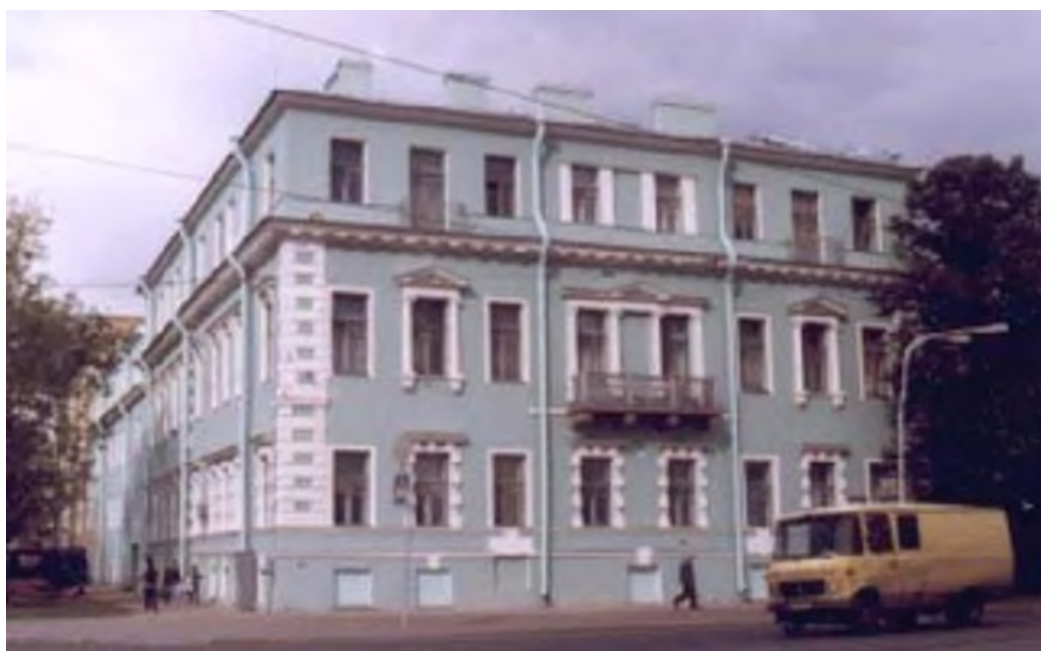
12. Дом Ф.А. Голицына (Э. Паннаша), расположенный по адресу: Санкт-Петербург, 16-я линия В.О., дом 1/33, литера А. Дата съёмки: 1990 г. / [Электронный ресурс] URL https://photo.gradpetra.net/views/9502.html
