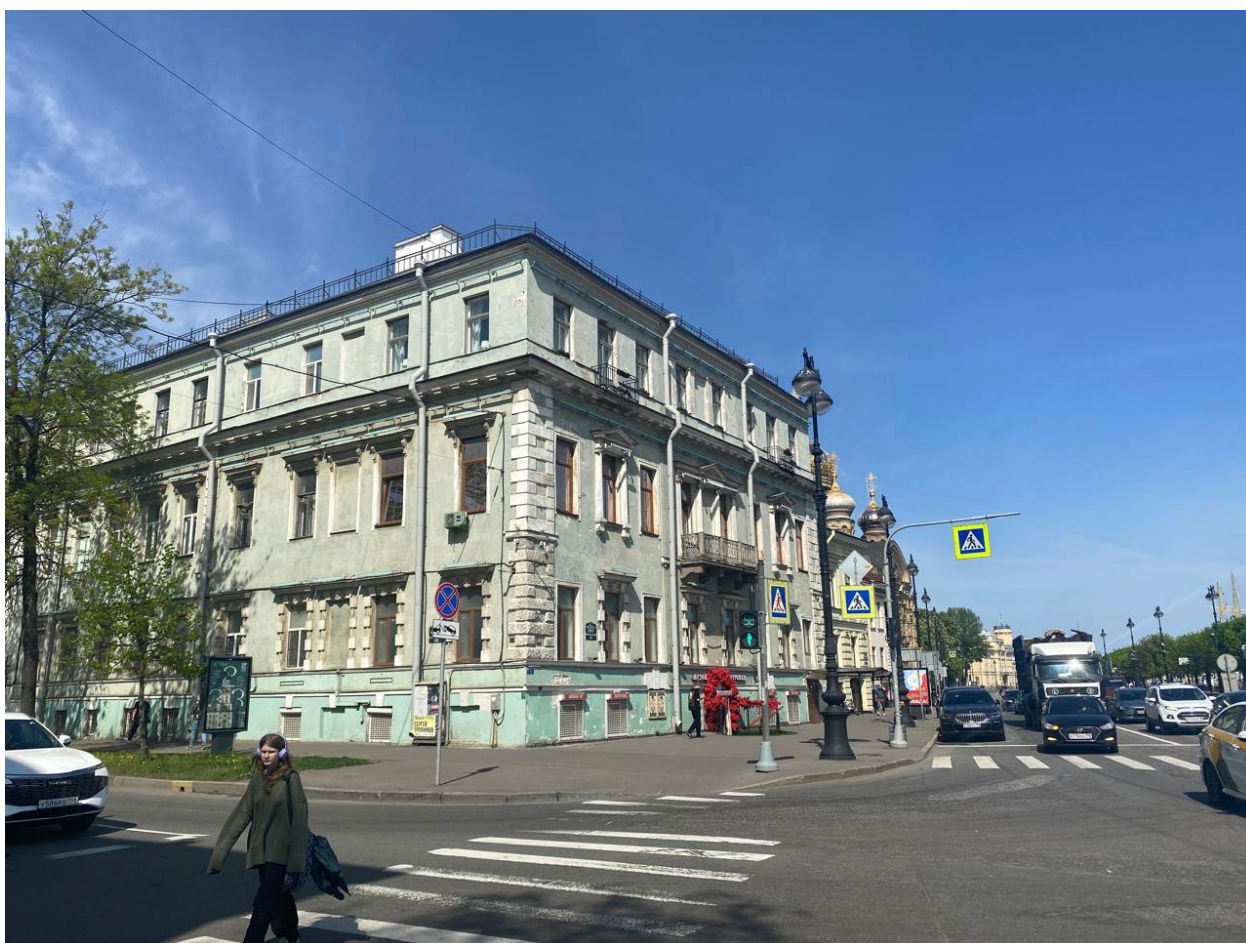
1. Юго-восточный и юго-западный лицевые фасады объекта культурного наследия регионального значения «Дом Ф.А. Голицына (Э. Паннаша)», расположенный по адресу: г. Санкт-Петербург, 16-я линия В.О., д. 1/33, литера А. 27.05.2026
