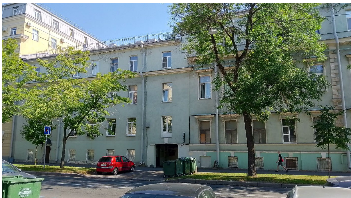
8. Юго- западный лицевой фасад объекта культурного наследия регионального значения «Дом Ф.А. Голицына (Э. Паннаша)», расположенный по адресу: г. Санкт-Петербург, 16-я линия В.О., д. 1/33, литера А. Фрагмент. 27.05.2026
