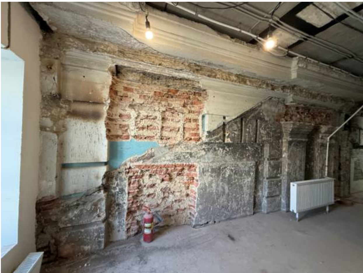
Фото 52. Объект по адресу: г.Санкт-Петербург, переулок Кваренги, дом 4, литера И. Помещение 2-Н (2).
