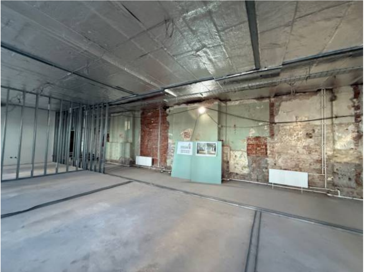
Фото 36. Объект по адресу: г.Санкт-Петербург, переулок Кваренги, дом 4, литера И. Помещение 1-Н (14,15,16,17).
