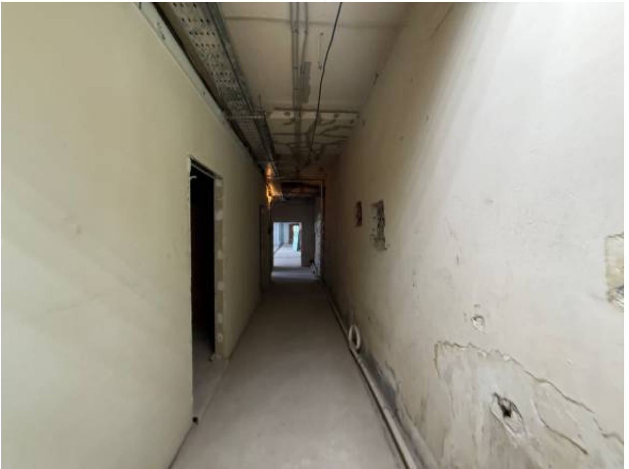
Фото 31. Объект по адресу: г.Санкт-Петербург, переулок Кваренги, дом 4, литера И. Помещение 1-Н (22).
