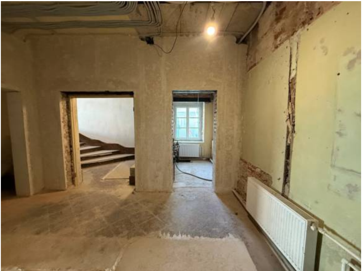
Фото 48. Объект по адресу: г.Санкт-Петербург, переулок Кваренги, дом 4, литера И. Помещение 1-Н (3,4,5).
