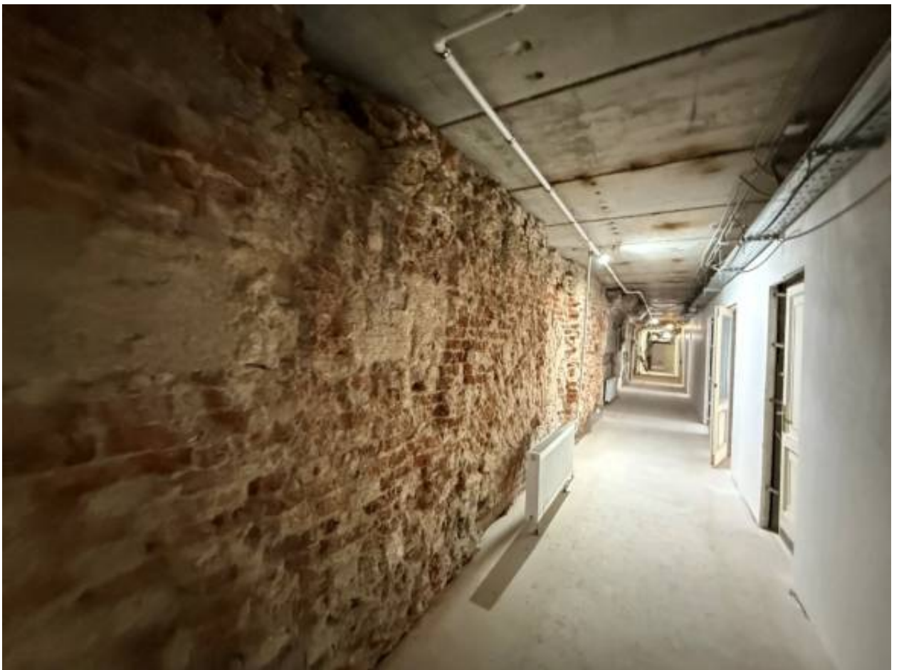
Фото 63. Объект по адресу: г.Санкт-Петербург, переулок Кваренги, дом 4, литера И. Помещение 2-Н (7).
