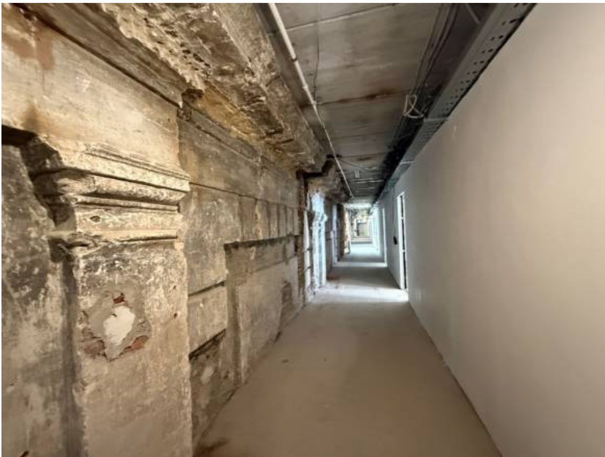
Фото 58. Объект по адресу: г.Санкт-Петербург, переулок Кваренги, дом 4, литера И. Помещение 2-Н (2).
