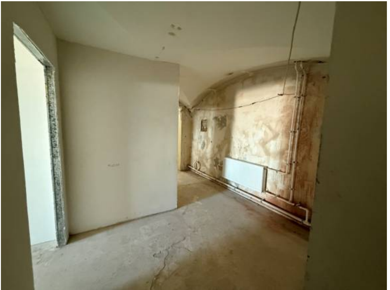
Фото 23. Объект по адресу: г.Санкт-Петербург, переулок Кваренги, дом 4, литера И. Помещение 1-Н (31).
