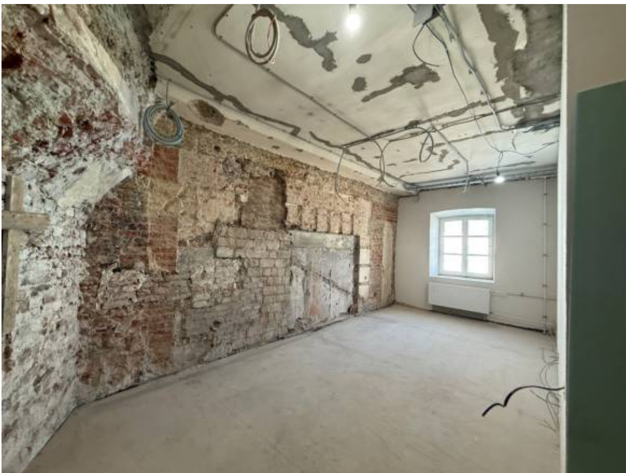
Фото 83. Объект по адресу: г.Санкт-Петербург, переулок Кваренги, дом 4, литера И. Помещение 2-Н (35).
