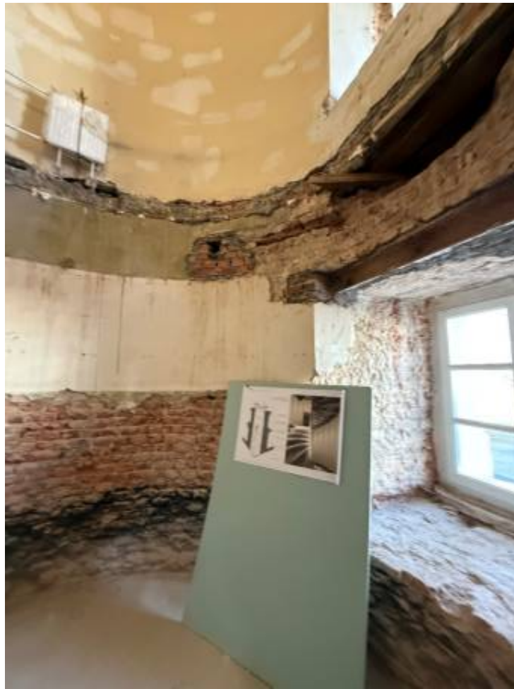
Фото 11. Объект по адресу: г.Санкт-Петербург, переулок Кваренги, дом 4, литера И. Помещение 1-Н (38).
