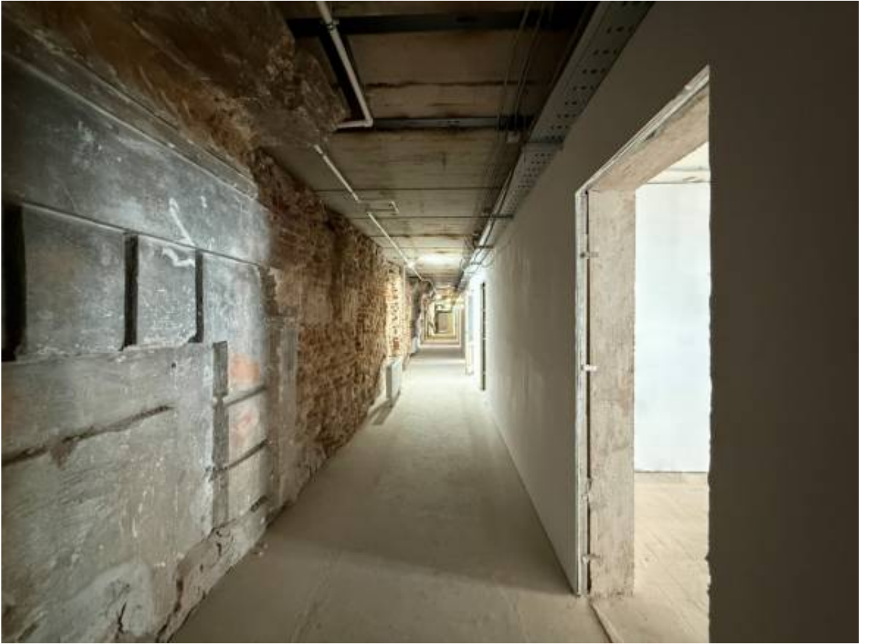
Фото 62. Объект по адресу: г.Санкт-Петербург, переулок Кваренги, дом 4, литера И. Помещение 2-Н (7).
