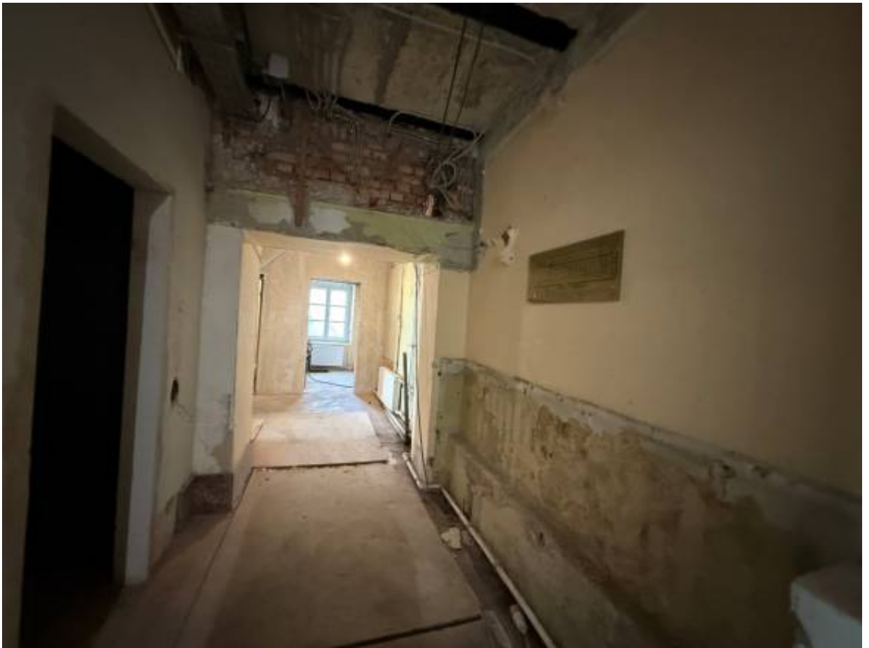
Фото 47. Объект по адресу: г.Санкт-Петербург, переулок Кваренги, дом 4, литера И. Помещение 1-Н (14).
