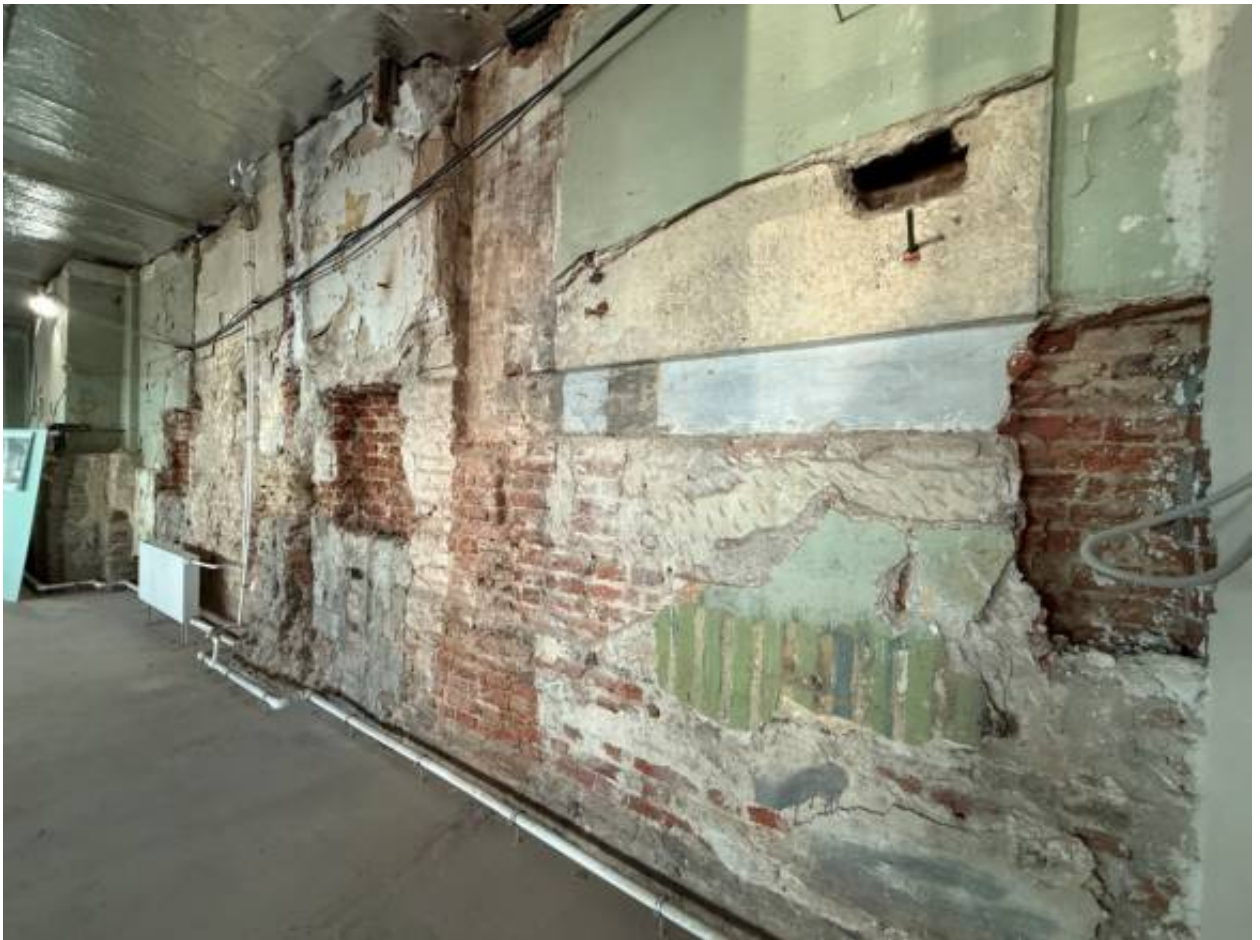
Фото 35. Объект по адресу: г.Санкт-Петербург, переулок Кваренги, дом 4, литера И. Помещение 1-Н (14,16).
