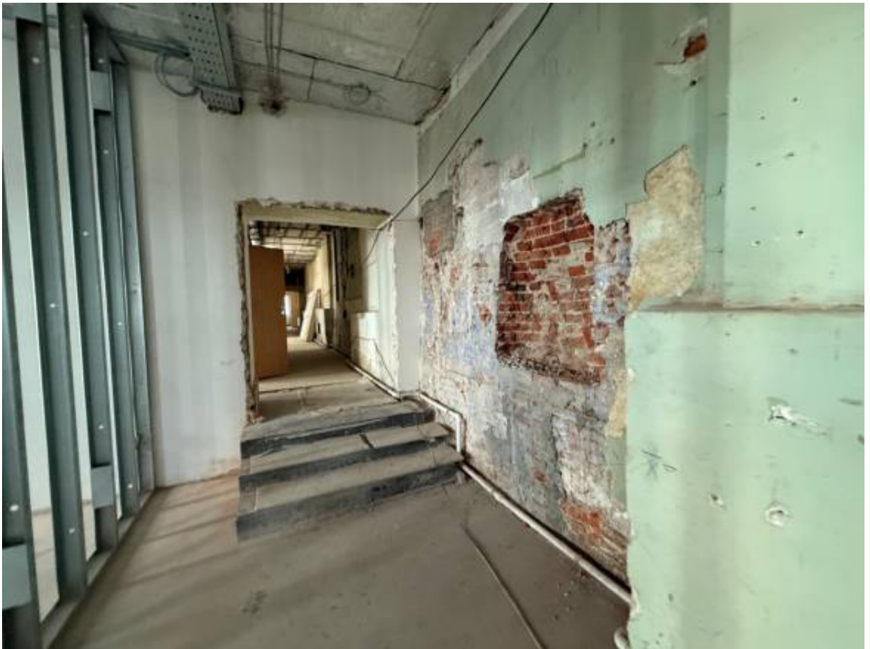
Фото 40. Объект по адресу: г.Санкт-Петербург, переулок Кваренги, дом 4, литера И. Помещение 1-Н (14).
