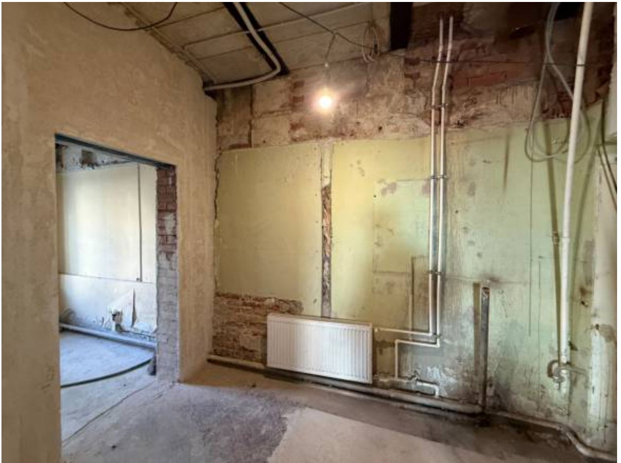
Фото 49. Объект по адресу: г.Санкт-Петербург, переулок Кваренги, дом 4, литера И. Помещение 1-Н (4,5).
