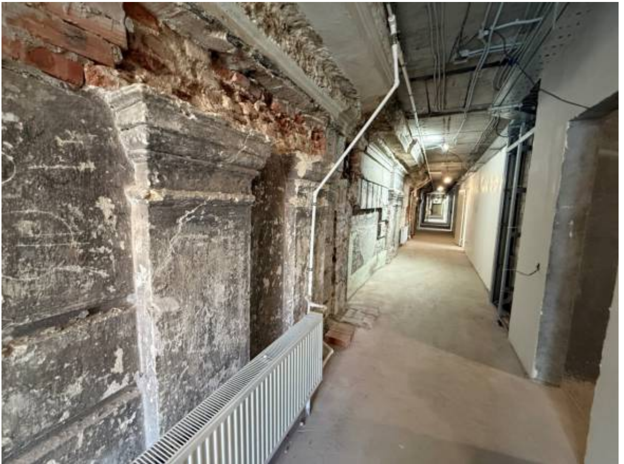
Фото 54. Объект по адресу: г.Санкт-Петербург, переулок Кваренги, дом 4, литера И. Помещение 2-Н (2).
