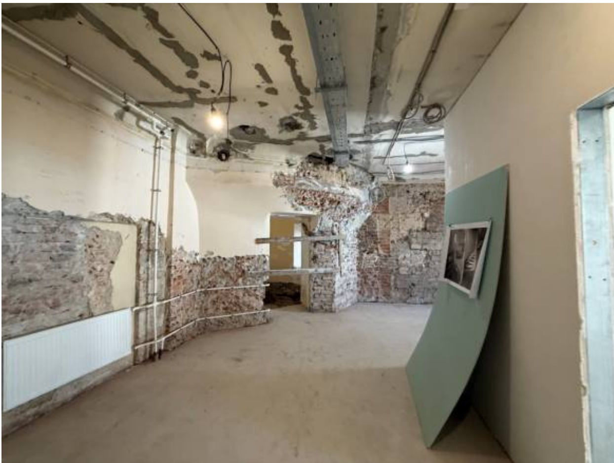
Фото 82. Объект по адресу: г.Санкт-Петербург, переулок Кваренги, дом 4, литера И. Помещение 2-Н (34,35).
