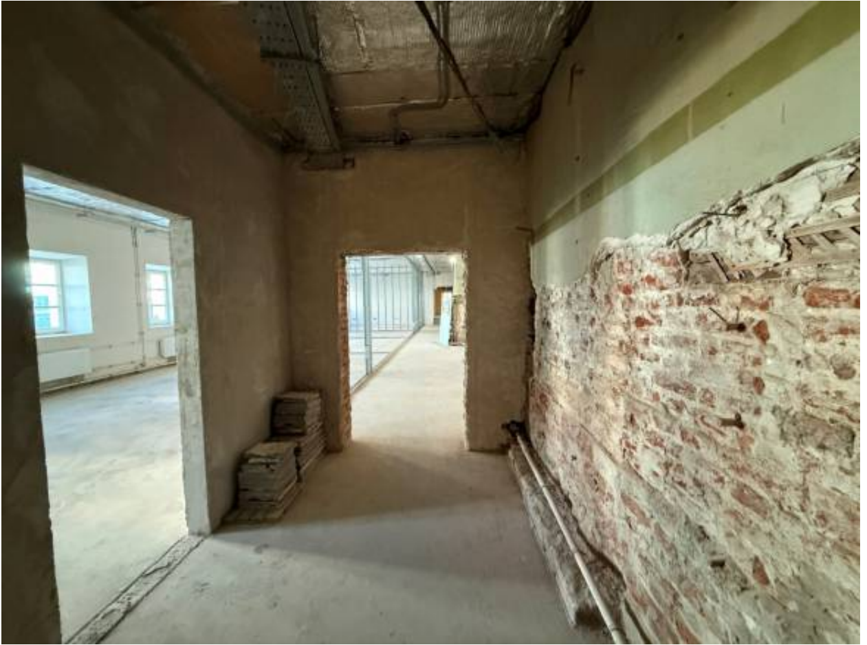
Фото 33. Объект по адресу: г.Санкт-Петербург, переулок Кваренги, дом 4, литера И. Помещение 1-Н (18).
