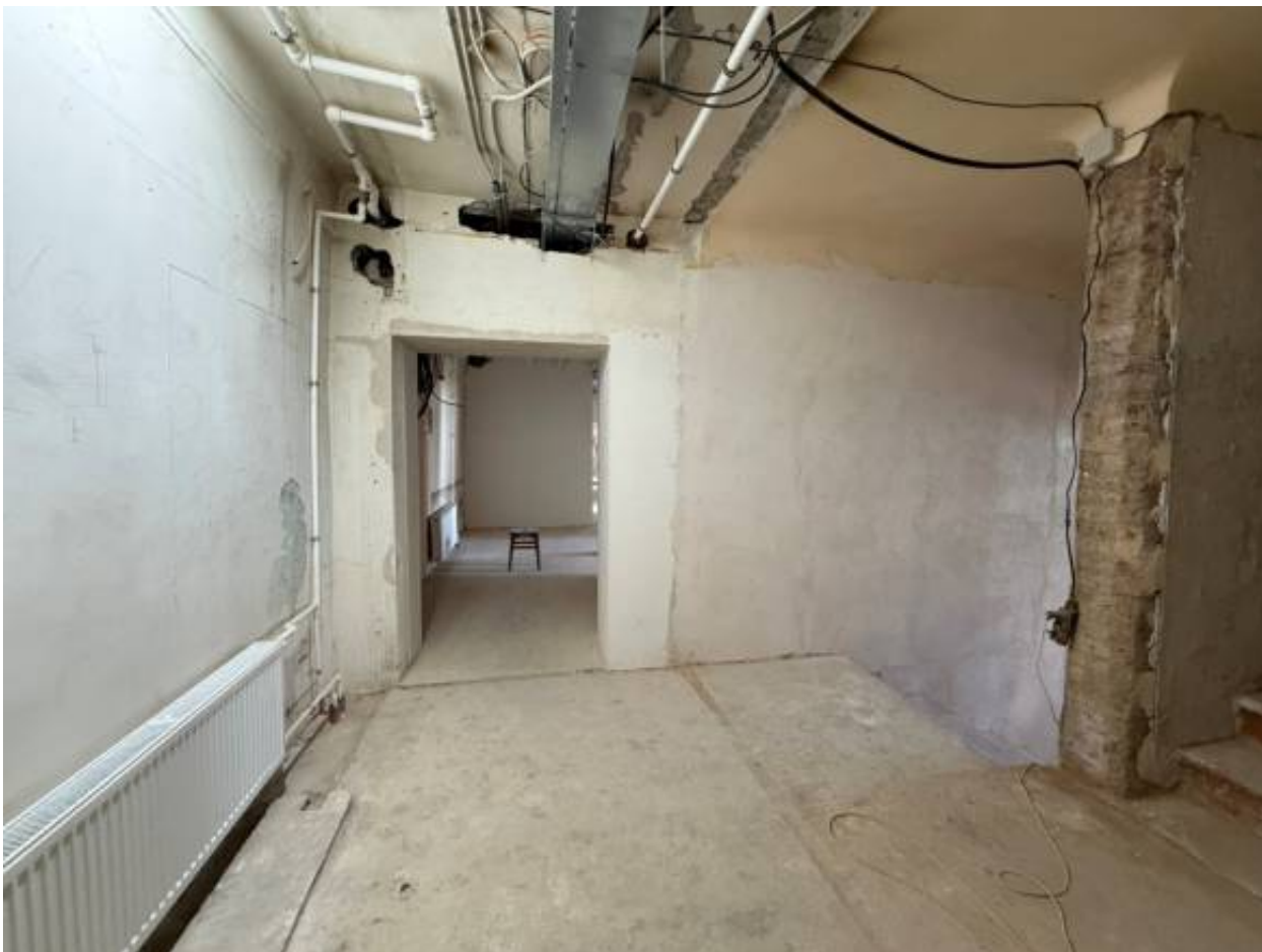
Фото 75. Объект по адресу: г.Санкт-Петербург, переулок Кваренги, дом 4, литера И. Помещение 2-Н (28).
