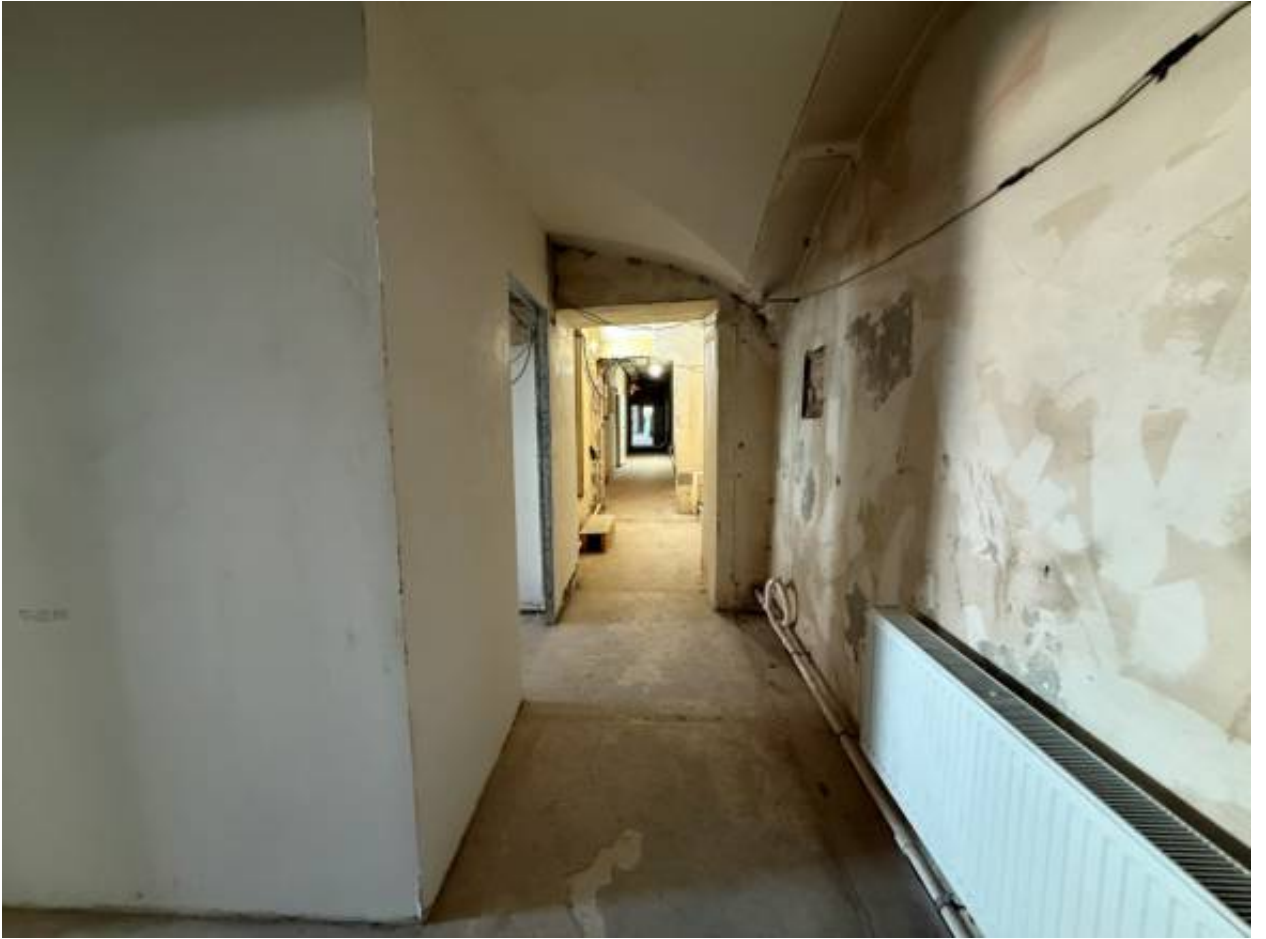
Фото 25. Объект по адресу: г.Санкт-Петербург, переулок Кваренги, дом 4, литера И. Помещение 1-Н (31).
