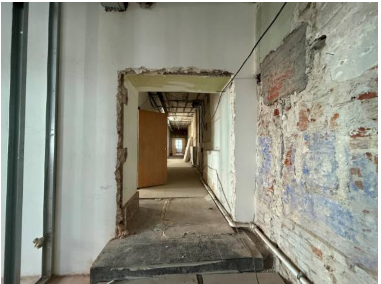
Фото 43. Объект по адресу: г.Санкт-Петербург, переулок Кваренги, дом 4, литера И. Помещение 1-Н (14).
