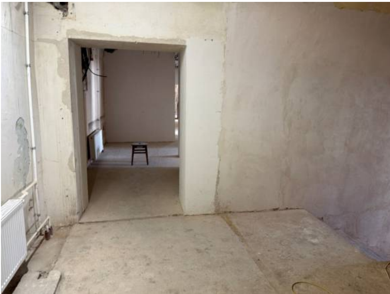
Фото 72. Объект по адресу: г.Санкт-Петербург, переулок Кваренги, дом 4, литера И. Помещение 2-Н (28).
