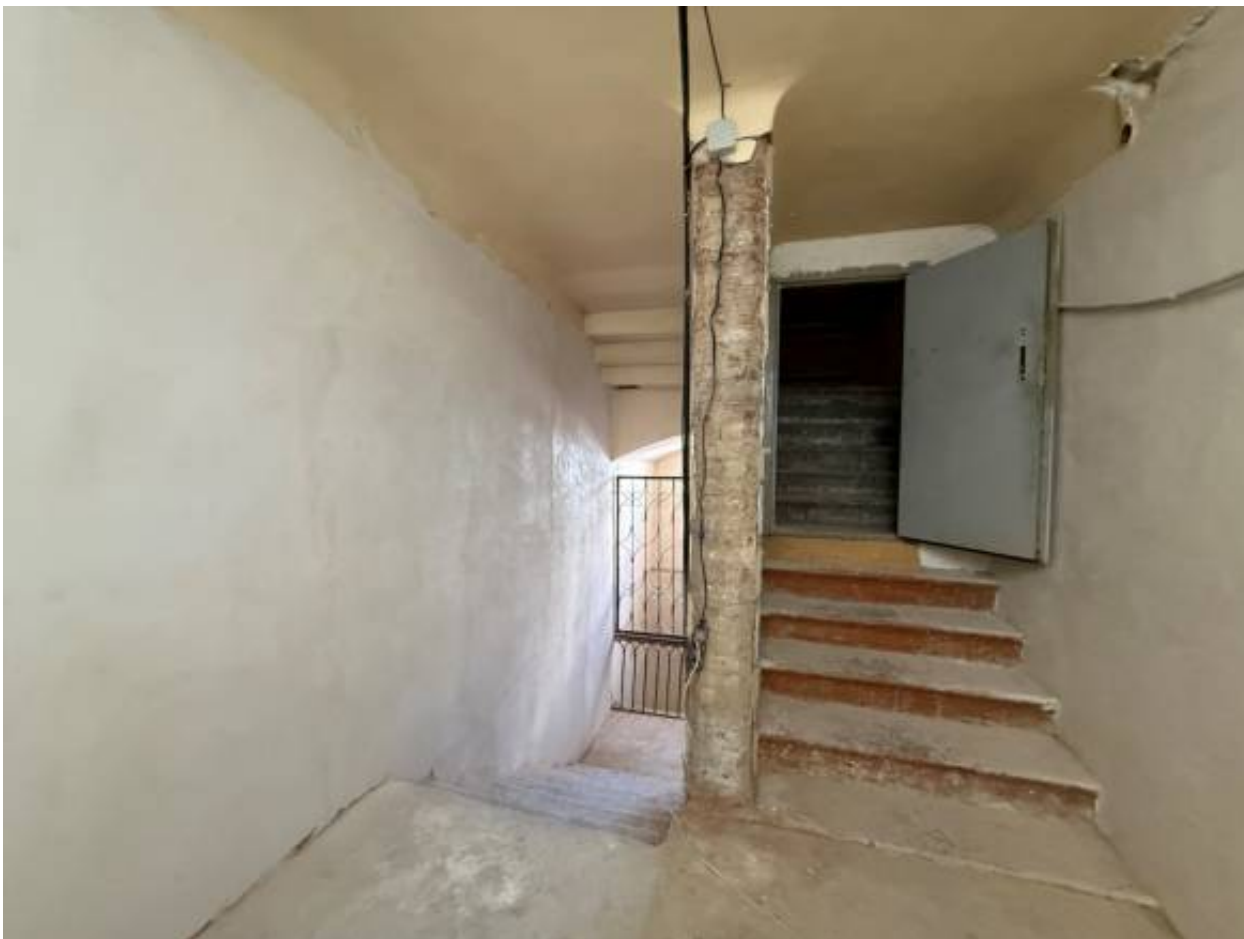
Фото 74. Объект по адресу: г.Санкт-Петербург, переулок Кваренги, дом 4, литера И. Помещение 2-Н (28).
