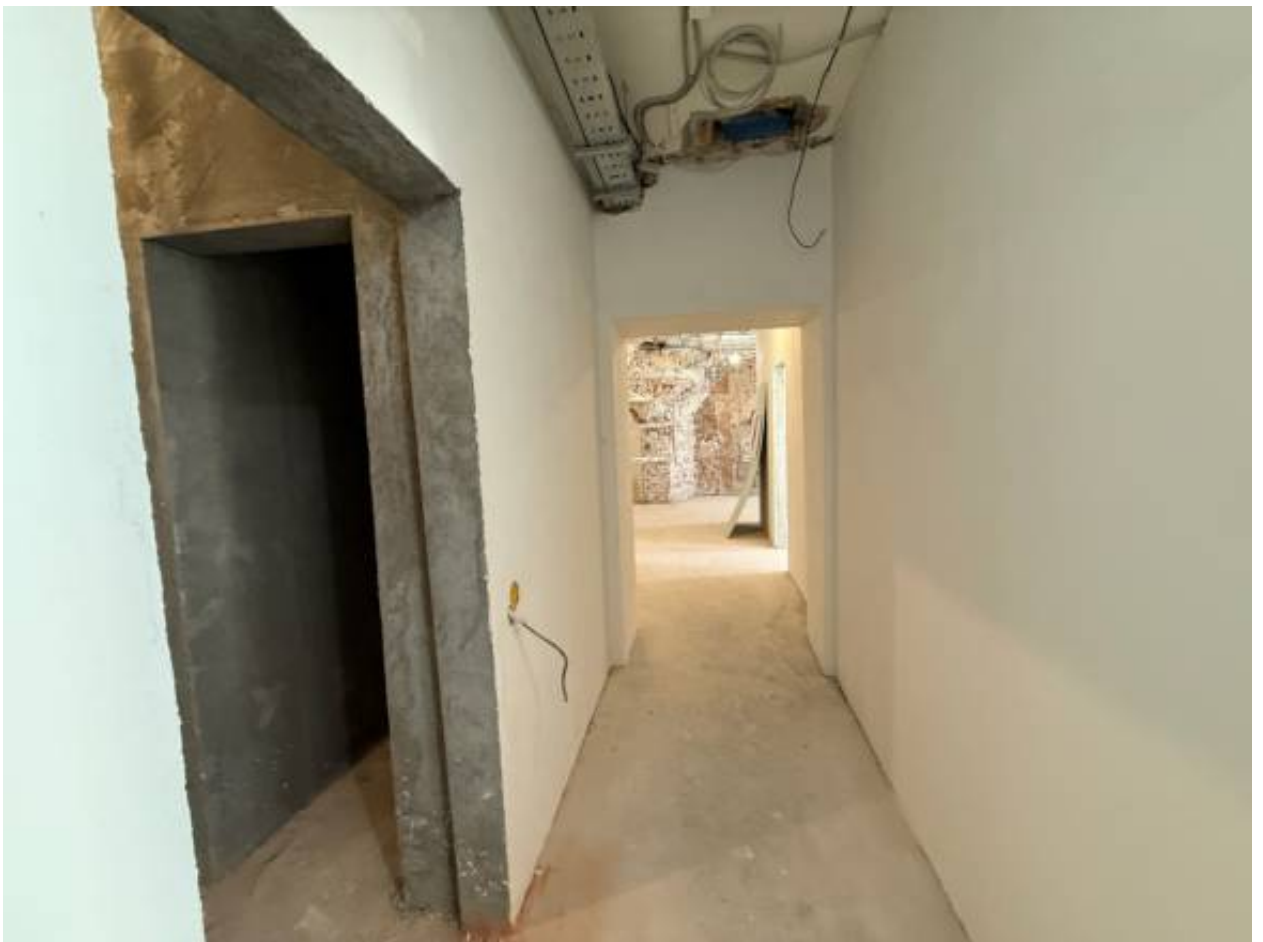
Фото 79. Объект по адресу: г.Санкт-Петербург, переулок Кваренги, дом 4, литера И. Помещение 2-Н (32).
