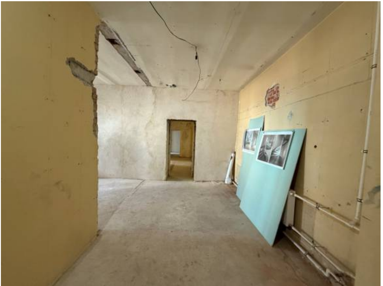
Фото 19. Объект по адресу: г.Санкт-Петербург, переулок Кваренги, дом 4, литера И. Помещение 1-Н (36).
