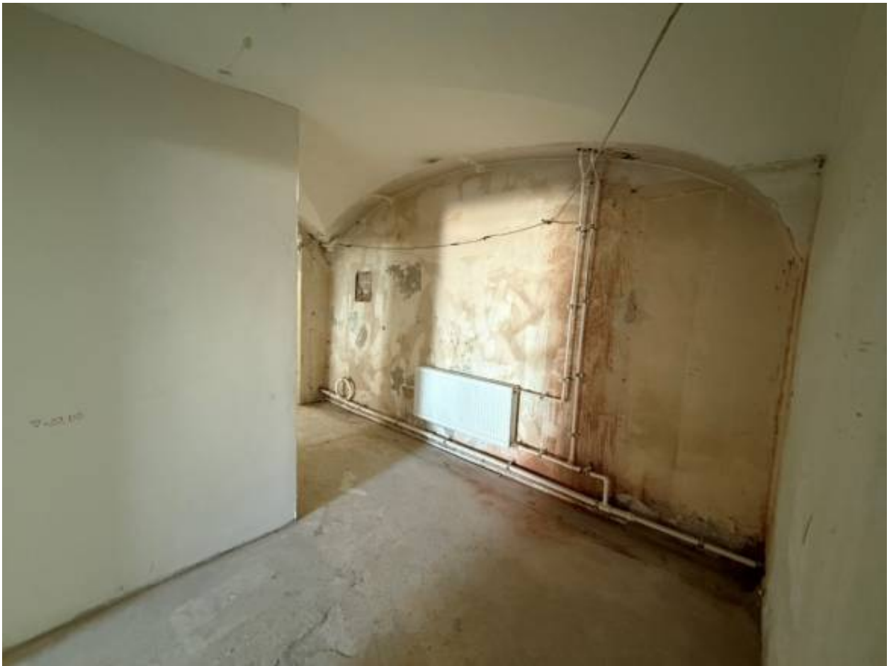
Фото 24. Объект по адресу: г.Санкт-Петербург, переулок Кваренги, дом 4, литера И. Помещение 1-Н (31).
