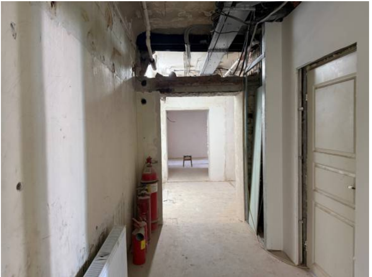
Фото 71. Объект по адресу: г.Санкт-Петербург, переулок Кваренги, дом 4, литера И. Помещение 2-Н (22).
