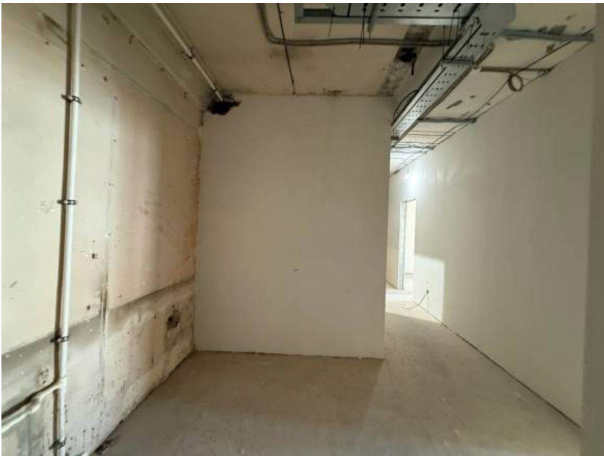
Фото 77. Объект по адресу: г.Санкт-Петербург, переулок Кваренги, дом 4, литера И. Помещение 2-Н (30,31,32).
