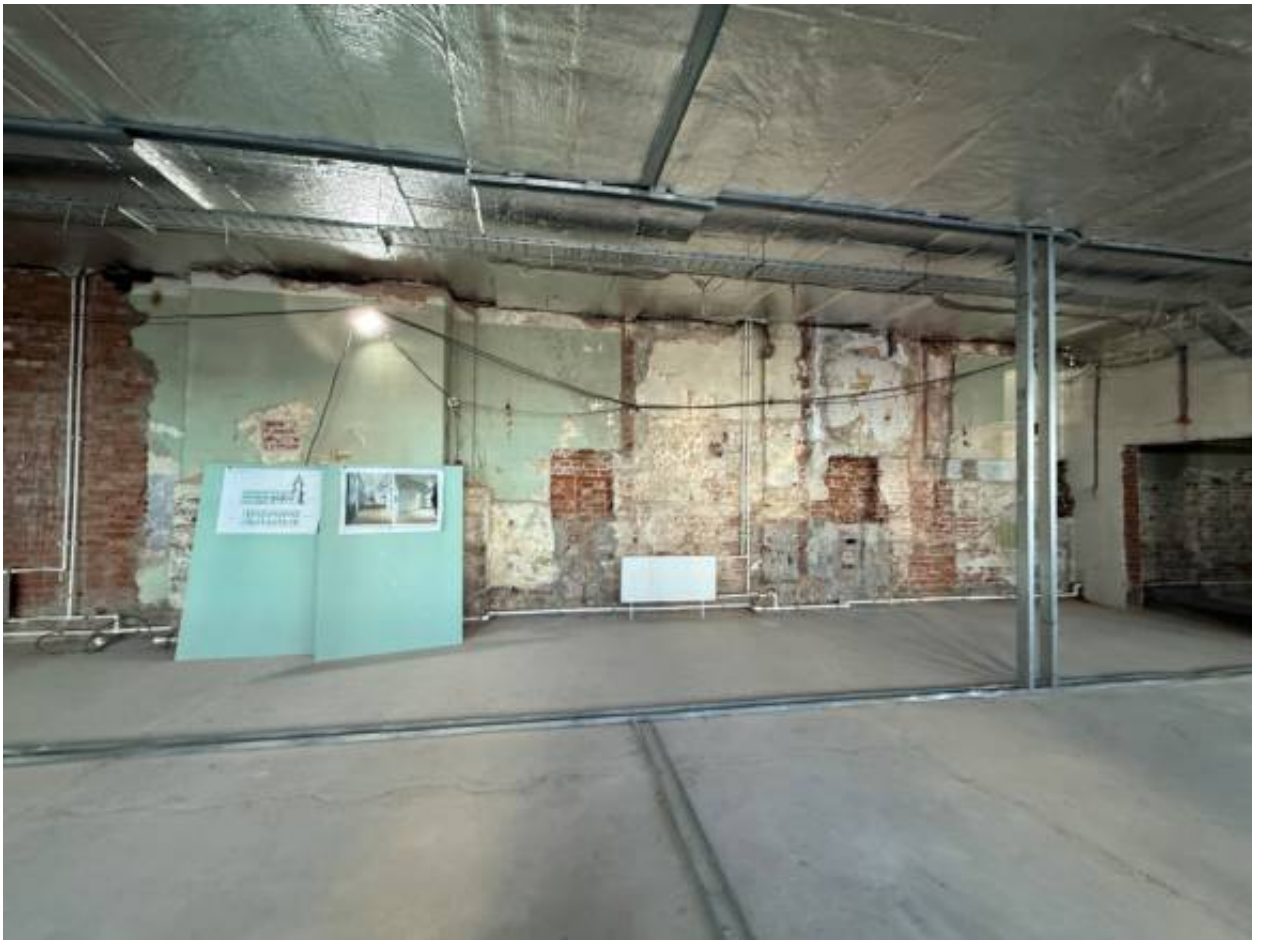
Фото 38. Объект по адресу: г.Санкт-Петербург, переулок Кваренги, дом 4, литера И. Помещение 1-Н (14,15,16,17).
