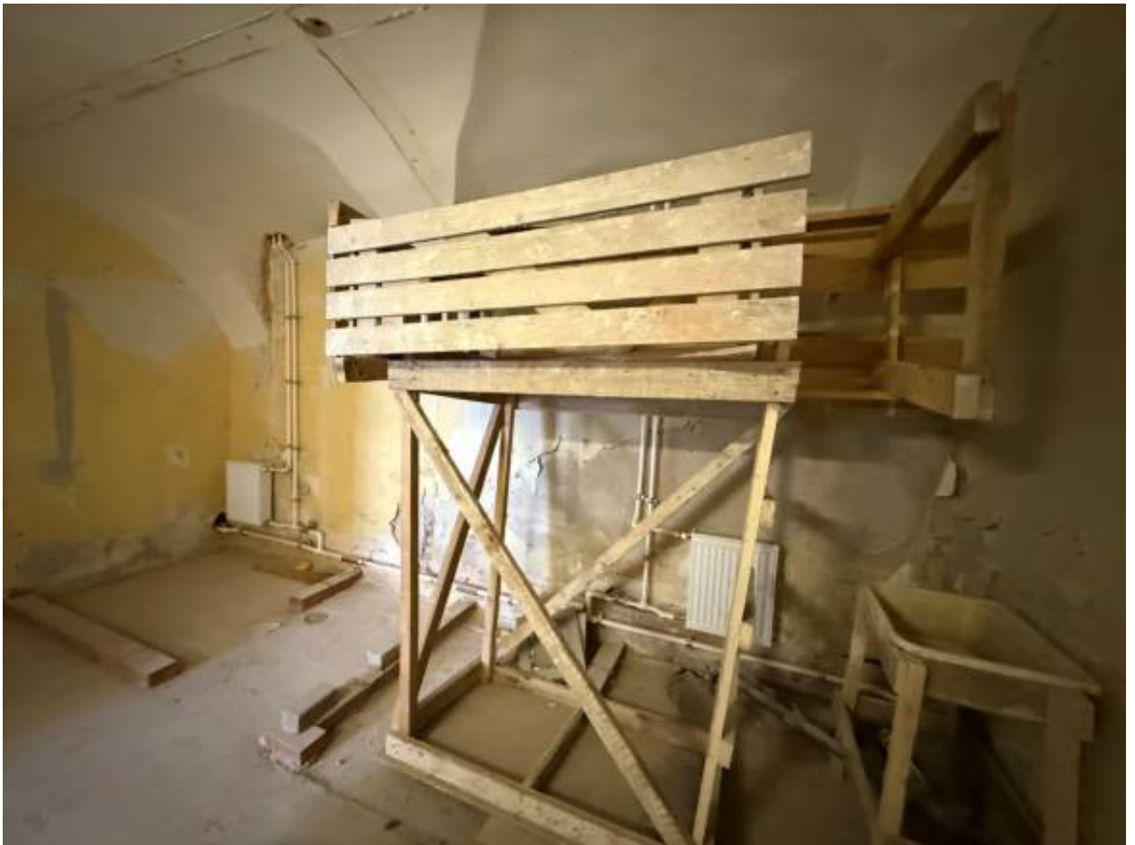
Фото 22. Объект по адресу: г.Санкт-Петербург, переулок Кваренги, дом 4, литера И. Помещение 1-Н (34,35).
