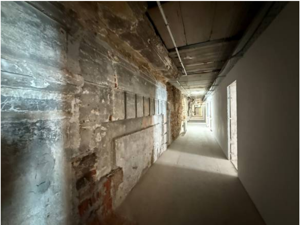
Фото 60. Объект по адресу: г.Санкт-Петербург, переулок Кваренги, дом 4, литера И. Помещение 2-Н (7).
