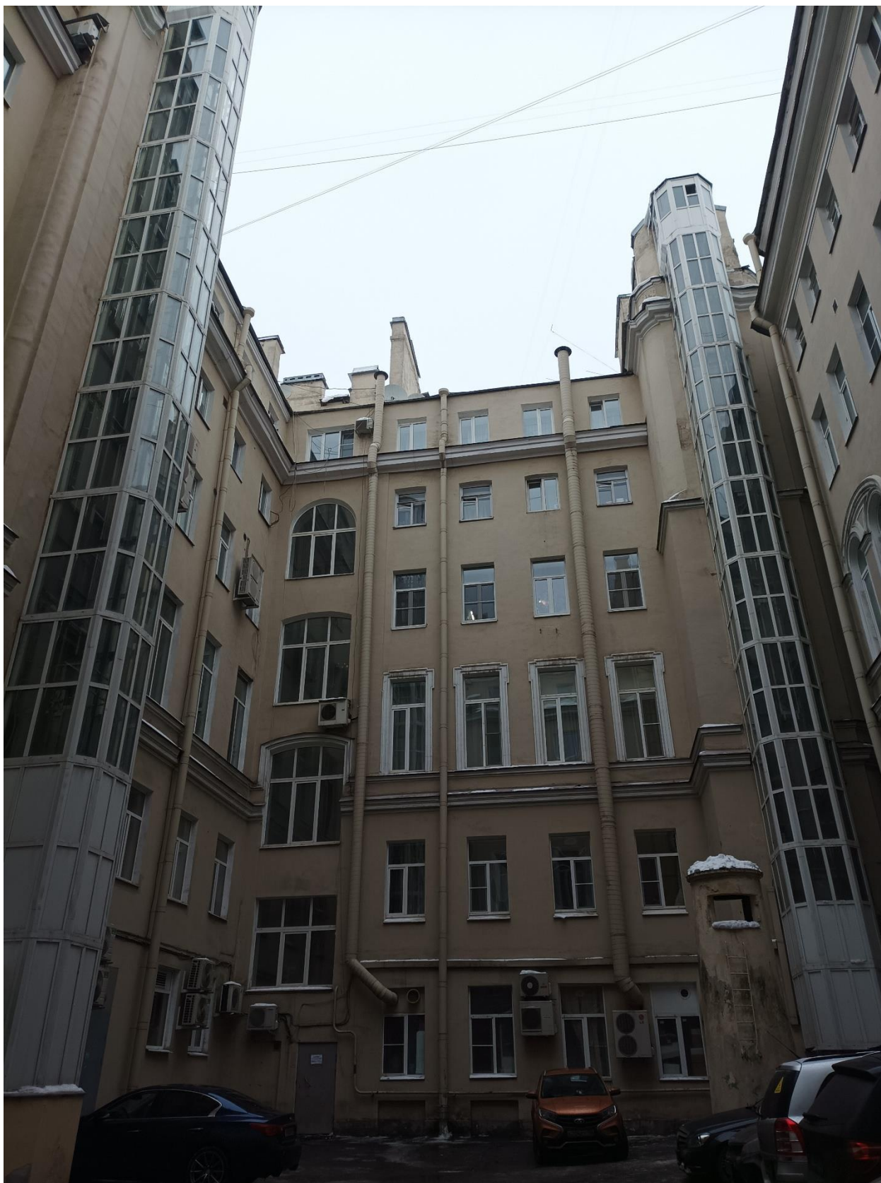
Фото 3. Вид на дворовый фасад объекта культурного наследия регионального значения «Дом Е.С. Егорова».
