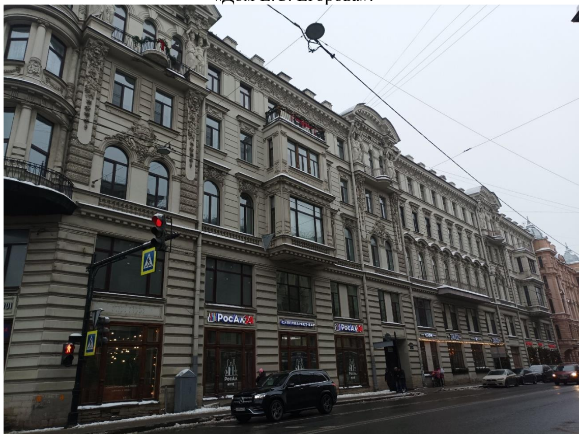
Фото 2. Вид на лицевой фасад объекта культурного наследия регионального значения «Дом Е.С. Егорова» по улице Некрасова.
