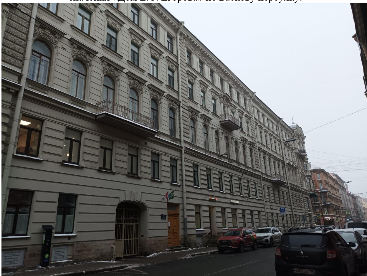
Фото 12. Вид на лицевой фасад объекта культурного наследия регионального значения «Дом Е.С. Егорова» по Баскову переулку.
