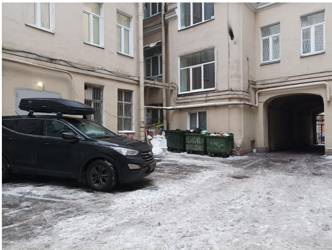
Фото 15. Вид на дворовый фасад объекта культурного наследия регионального значения «Дом Е.С. Егорова».
