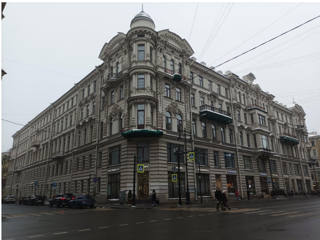
Фото 9. Вид на лицевые фасады объекта культурного наследия регионального значения «Дом Е.С. Егорова» на углу Баскова переулка и улицы Восстания.
