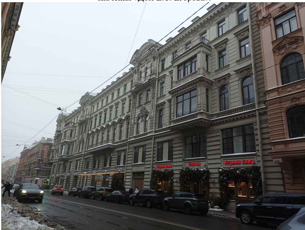
Фото 18. Вид на лицевой фасад объекта культурного наследия регионального значения «Дом Е.С. Егорова» по улице Некрасова.
