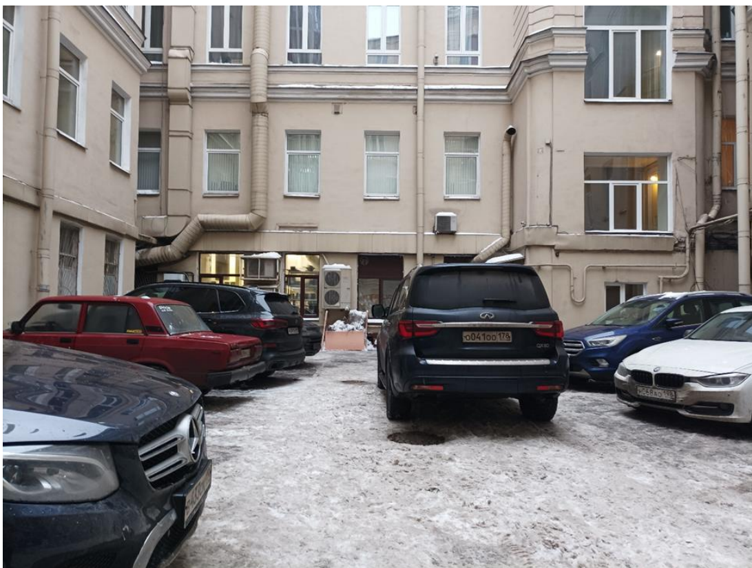
Фото 17. Вид на дворовый фасад объекта культурного наследия регионального значения «Дом Е.С. Егорова».
