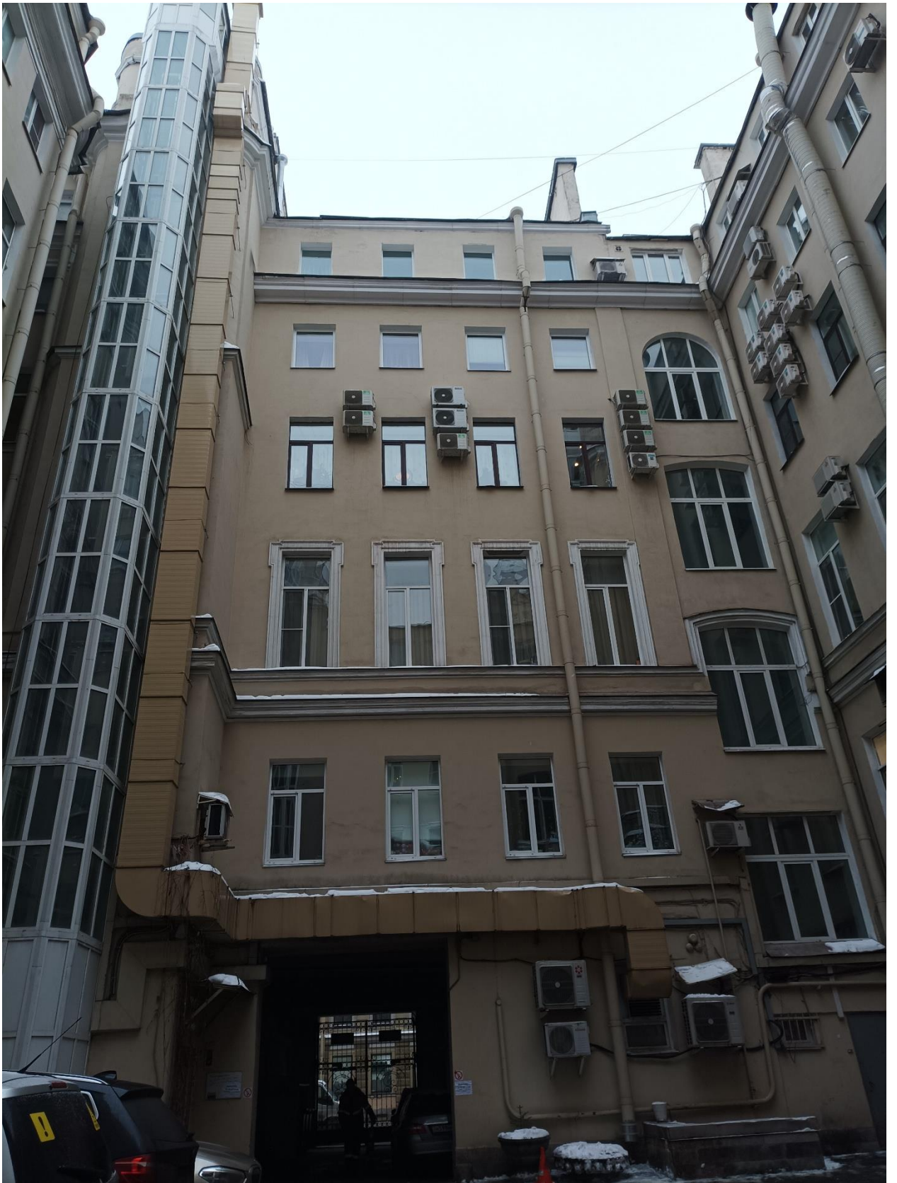
Фото 4. Вид на дворовый фасад объекта культурного наследия регионального значения «Дом Е.С. Егорова».
