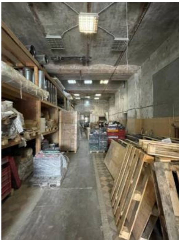
Фото 15. Интерьер 1 этажа объекта культурного наследия регионального значения «Гараж (корпус 266)», входящего в состав объекта культурного наследия регионального значения «Комплекс товарищества Российско-Американской резиновой мануфактуры «Треугольник»
