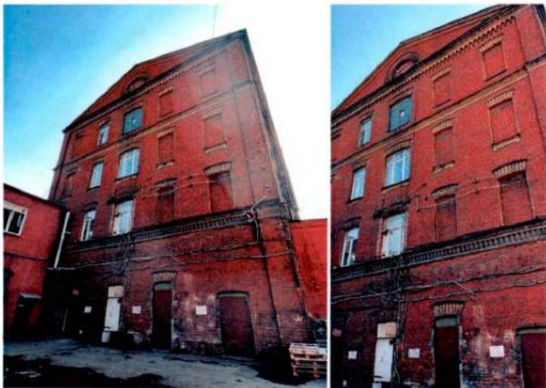
Фото 5, 6. Северо-восточный торцевой фасад объекта культурного наследия.
