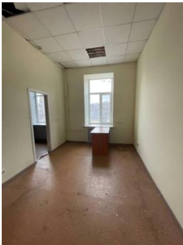
Фото 51. Интерьер 3 этажа объекта культурного наследия регионального значения «Гараж (корпус 266)», входящего в состав объекта культурного наследия регионального значения «Комплекс товарищества Российско-Американской резиновой мануфактуры «Треугольник»
