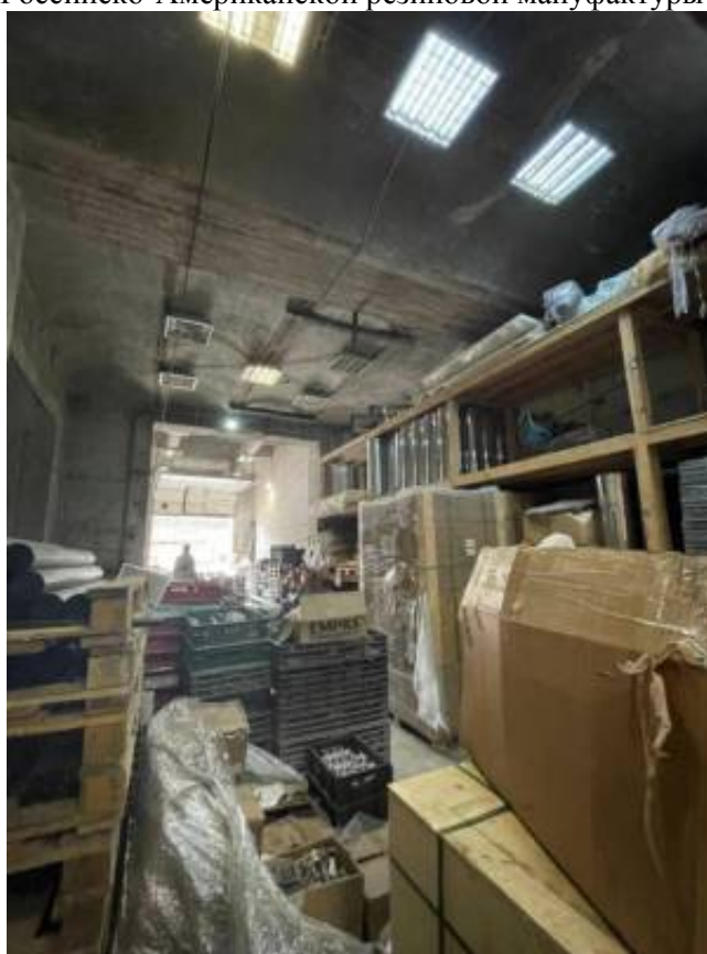
Фото 16. Интерьер 1 этажа объекта культурного наследия регионального значения «Гараж (корпус 266)», входящего в состав объекта культурного наследия регионального значения «Комплекс товарищества Российско-Американской резиновой мануфактуры «Треугольник»
