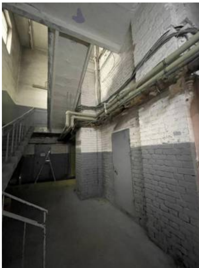
Фото 7. Интерьер 1 этажа объекта культурного наследия регионального значения «Гараж (корпус 266)», входящего в состав объекта культурного наследия регионального значения «Комплекс товарищества Российско-Американской резиновой мануфактуры «Треугольник»
