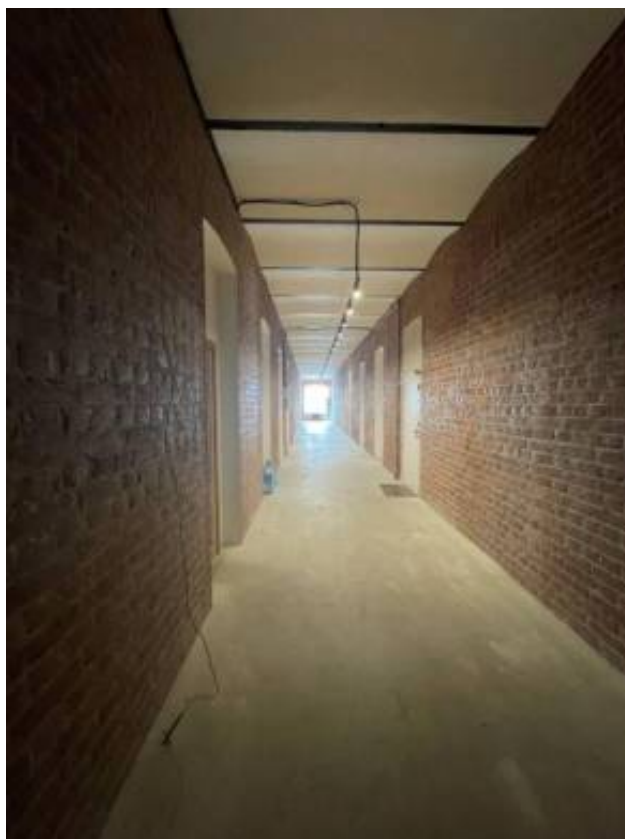
Фото 68. Интерьер 4 этажа объекта культурного наследия регионального значения «Гараж (корпус 266)», входящего в состав объекта культурного наследия регионального значения «Комплекс товарищества Российско-Американской резиновой мануфактуры «Треугольник»
