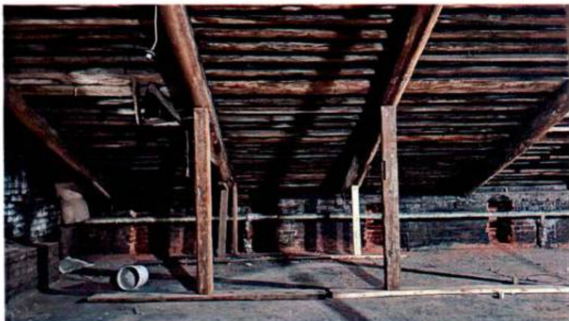
Фото 17. Стропильная система объекта культурного наследия.
