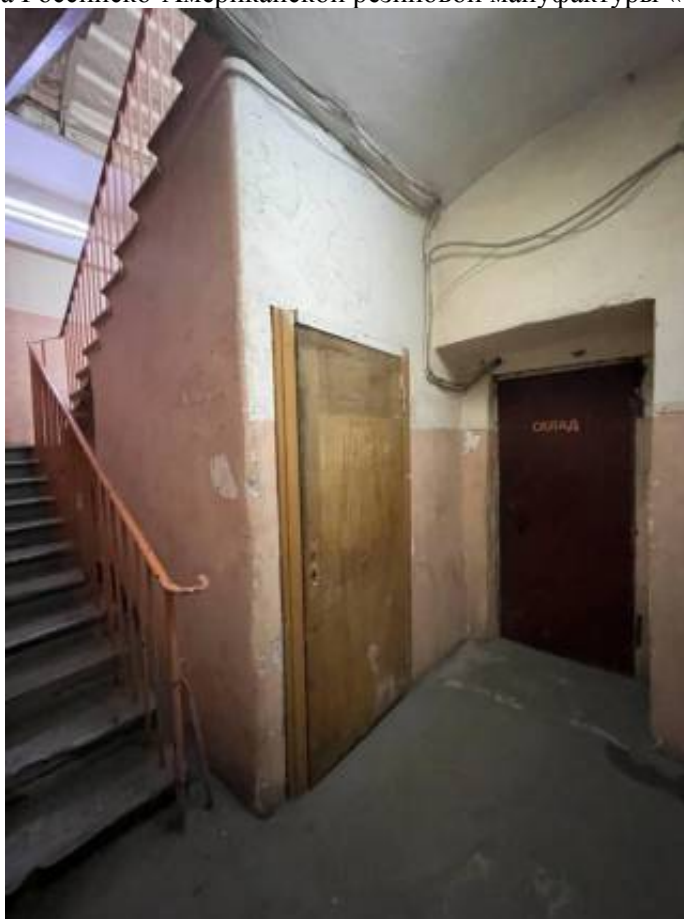
Фото 14. Интерьер 1 этажа объекта культурного наследия регионального значения «Гараж (корпус 266)», входящего в состав объекта культурного наследия регионального значения «Комплекс товарищества Российско-Американской резиновой мануфактуры «Треугольник»
