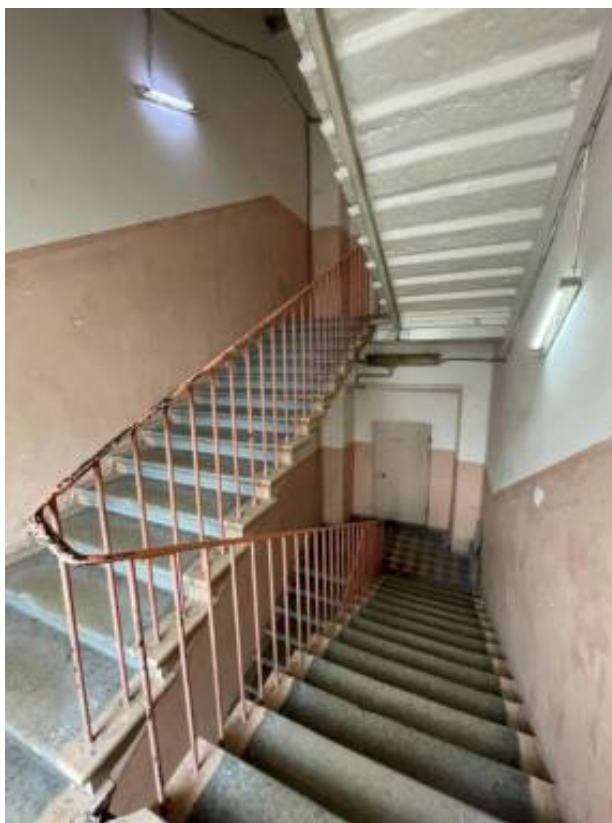
Фото 37. Интерьер 2 этажа объекта культурного наследия регионального значения «Гараж (корпус 266)», входящего в состав объекта культурного наследия регионального значения «Комплекс товарищества Российско-Американской резиновой мануфактуры «Треугольник»
