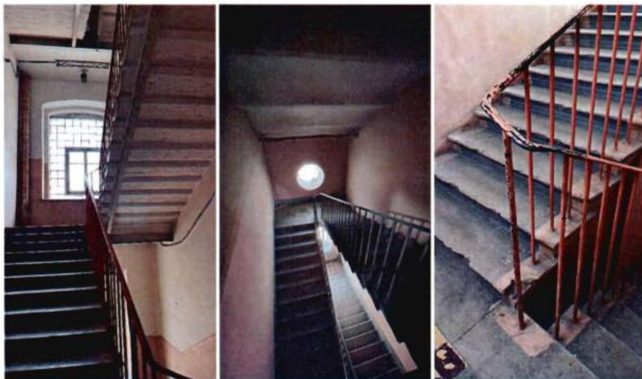
11, 12, 13. Лестницы объекта культурного наследия.
