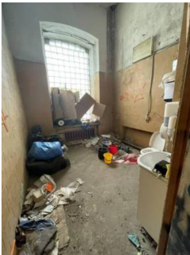
Фото 11. Интерьер 1 этажа объекта культурного наследия регионального значения «Гараж (корпус 266)», входящего в состав объекта культурного наследия регионального значения «Комплекс товарищества Российско-Американской резиновой мануфактуры «Треугольник»
