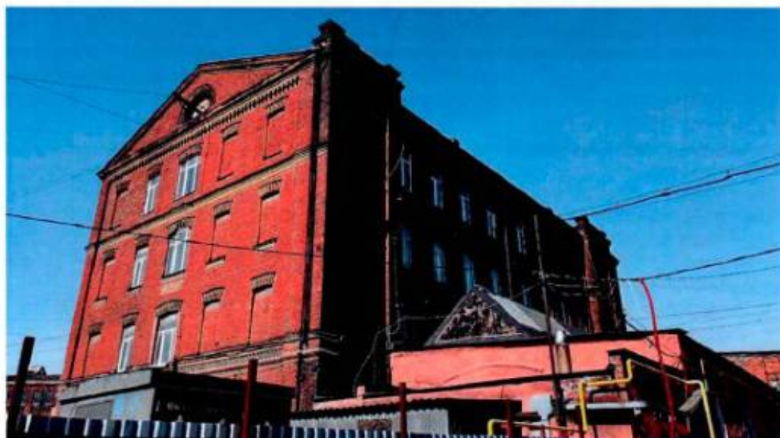
Фото 1. Общий вид на торцевой юго-восточный и северо-восточный фасады объекта культурного наследия.
