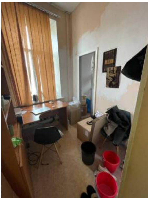
Фото 47. Интерьер 3 этажа объекта культурного наследия регионального значения «Гараж (корпус 266)», входящего в состав объекта культурного наследия регионального значения «Комплекс товарищества Российско-Американской резиновой мануфактуры «Треугольник»
