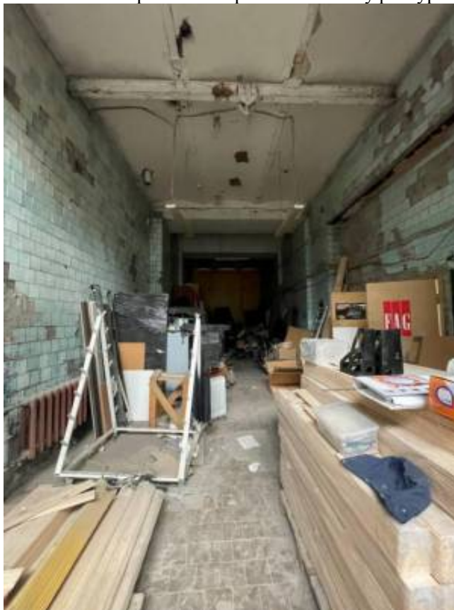
Фото 10. Интерьер 1 этажа объекта культурного наследия регионального значения «Гараж (корпус 266)», входящего в состав объекта культурного наследия регионального значения «Комплекс товарищества Российско-Американской резиновой мануфактуры «Треугольник»
