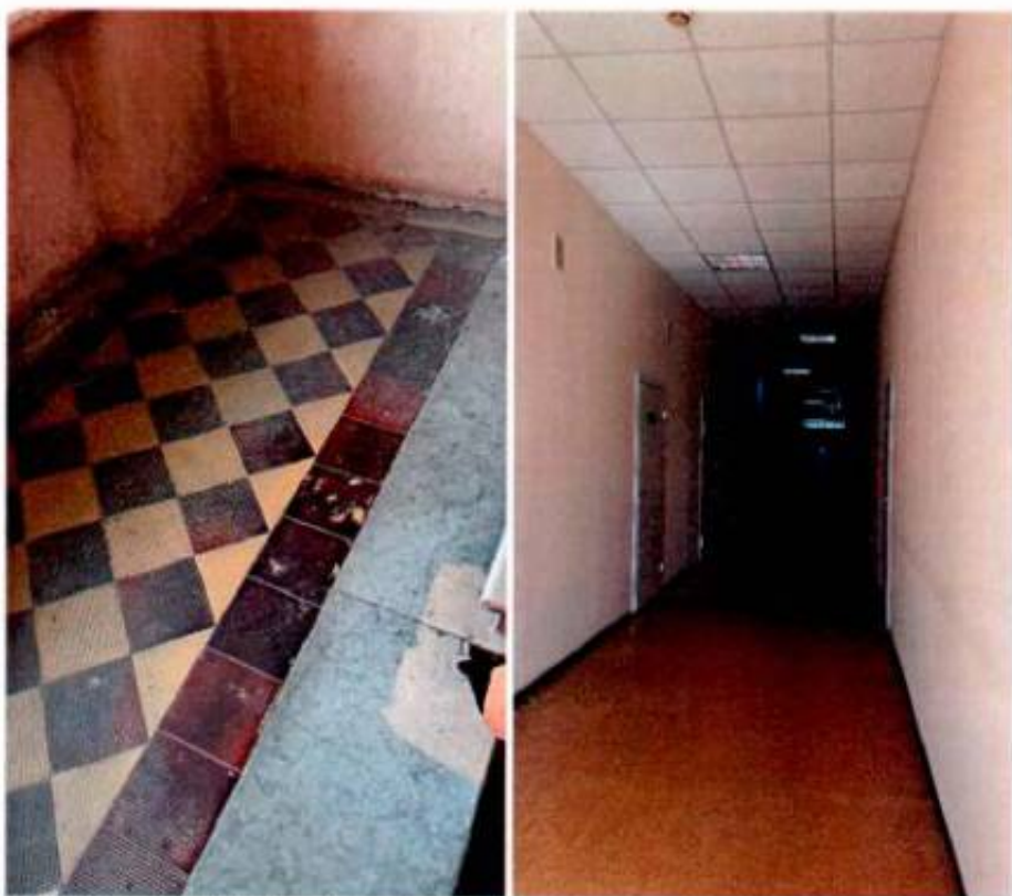
Фото 14. Покрытие межэтажных площадок лестниц объекта культурного наследия.
