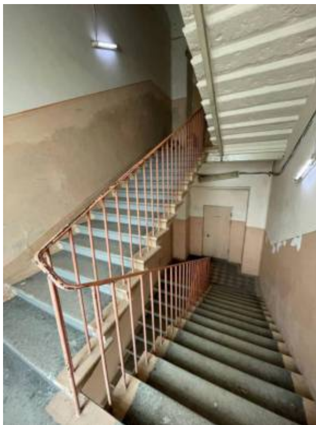
Фото 59. Интерьер 3 этажа объекта культурного наследия регионального значения «Гараж (корпус 266)», входящего в состав объекта культурного наследия регионального значения «Комплекс товарищества Российско-Американской резиновой мануфактуры «Треугольник»
