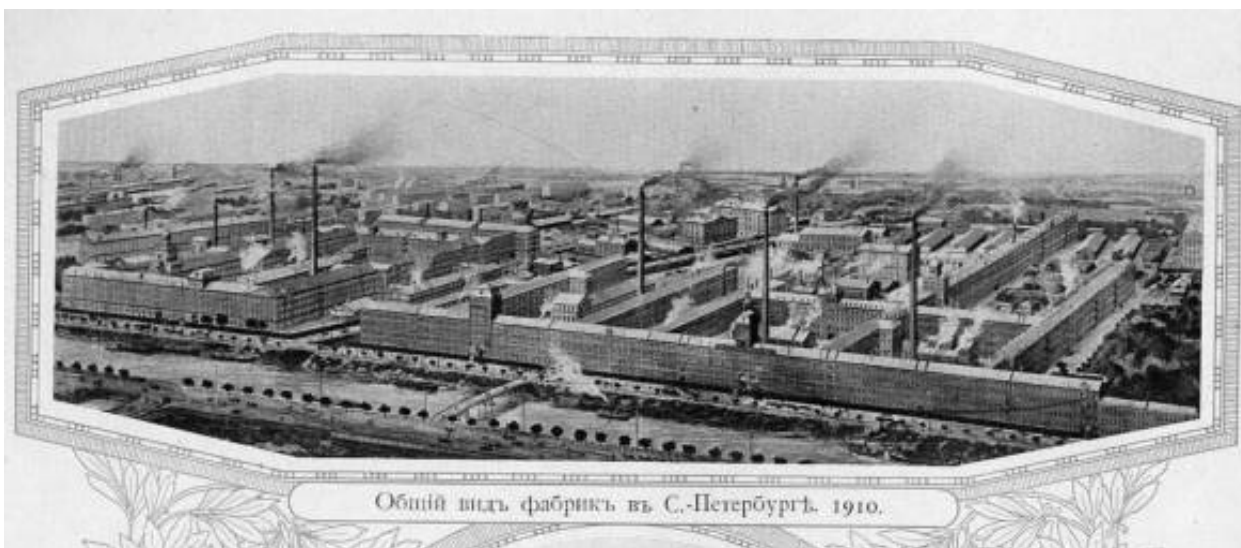
14. 1910 г. — Российско-Американская резиновая мануфактура "Треугольник". Производственные здания и школа // Citywalls.ru – архитектурный сайт Петербурга [Электронный ресурс]. URL: https://www.citywalls.ru/house2597.html .
