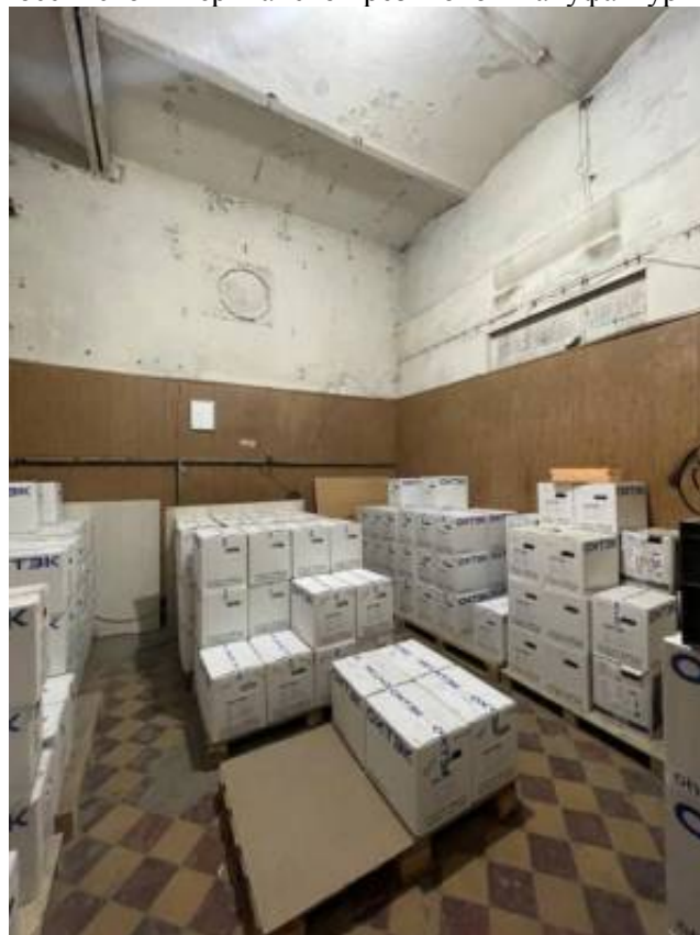
Фото 22. Интерьер 1 этажа объекта культурного наследия регионального значения «Гараж (корпус 266)», входящего в состав объекта культурного наследия регионального значения «Комплекс товарищества Российско-Американской резиновой мануфактуры «Треугольник»
