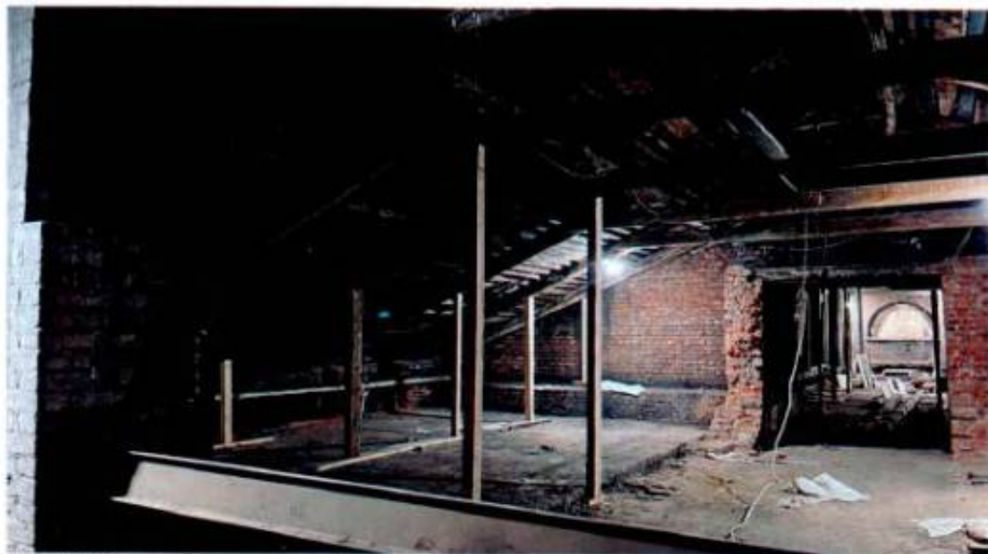
Фото 16. Стропильная система объекта культурного наследия.
