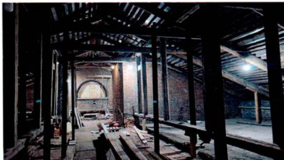
Фото 18. Стропильная система объекта культурного наследия.
