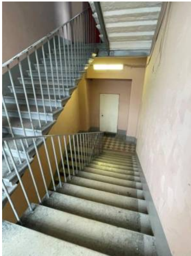
Фото 46. Интерьер 3 этажа объекта культурного наследия регионального значения «Гараж (корпус 266)», входящего в состав объекта культурного наследия регионального значения «Комплекс товарищества Российско-Американской резиновой мануфактуры «Треугольник»
