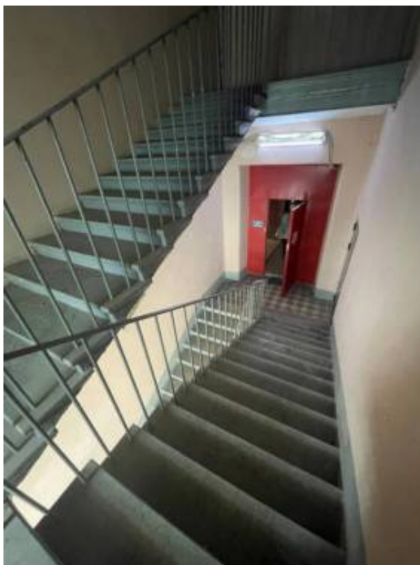
Фото 67. Интерьер 4 этажа объекта культурного наследия регионального значения «Гараж (корпус 266)», входящего в состав объекта культурного наследия регионального значения «Комплекс товарищества Российско-Американской резиновой мануфактуры «Треугольник»
