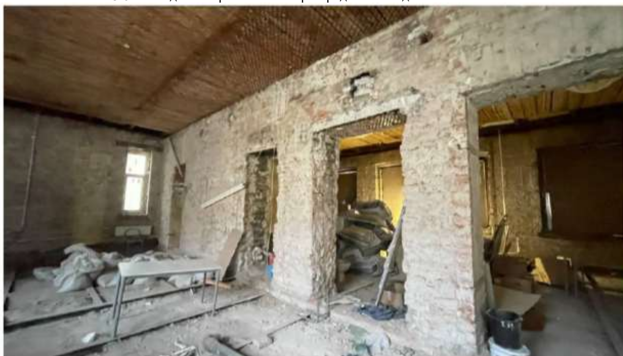
Илл. 31. Объект культурного наследия регионального значения «Особняк Л.Н. Симонова (Столыпиных)», расположенный по адресу: Санкт-Петербург, Гагаринская ул., 5, лит. А. Общий вид помещения в осях 3-5/Б-В с демонтированными перегородками и отделочными слоями.
