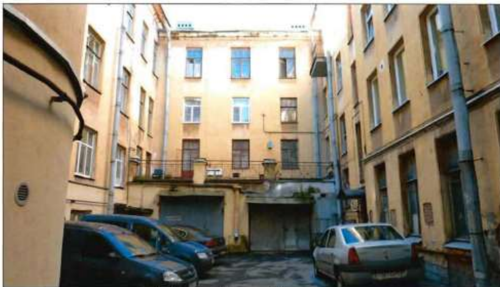
3. Дворовые фасады. Вид с востока.
