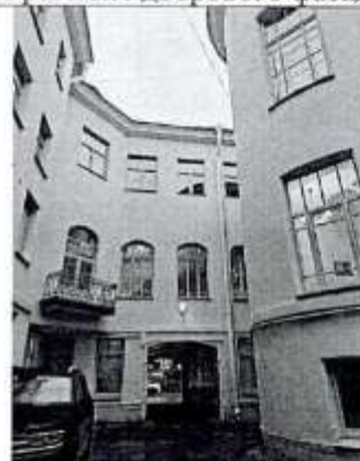
Фрагмент дворового фасада
