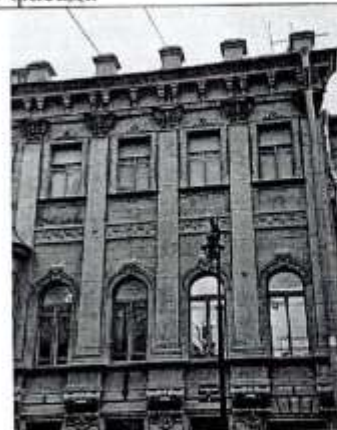
Фрагмент лицевого фасада
