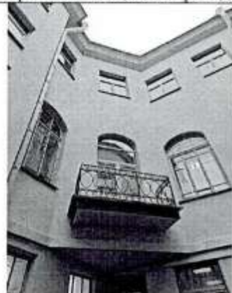
Фрагмент дворового фасада
