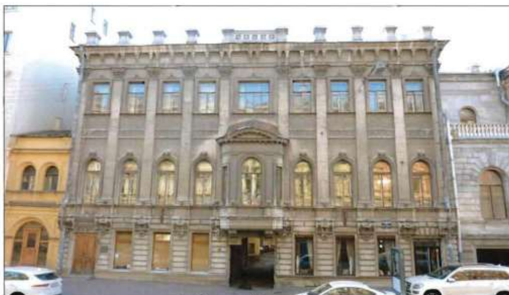
1. Восточный лицевой фасад.
