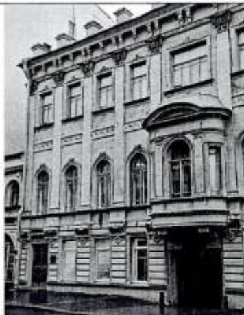
Фрагмент дворового фасада
