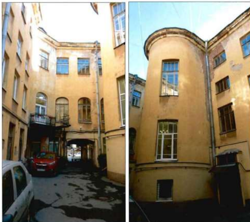
4,5. Дворовые фасады. Вид с запада.
