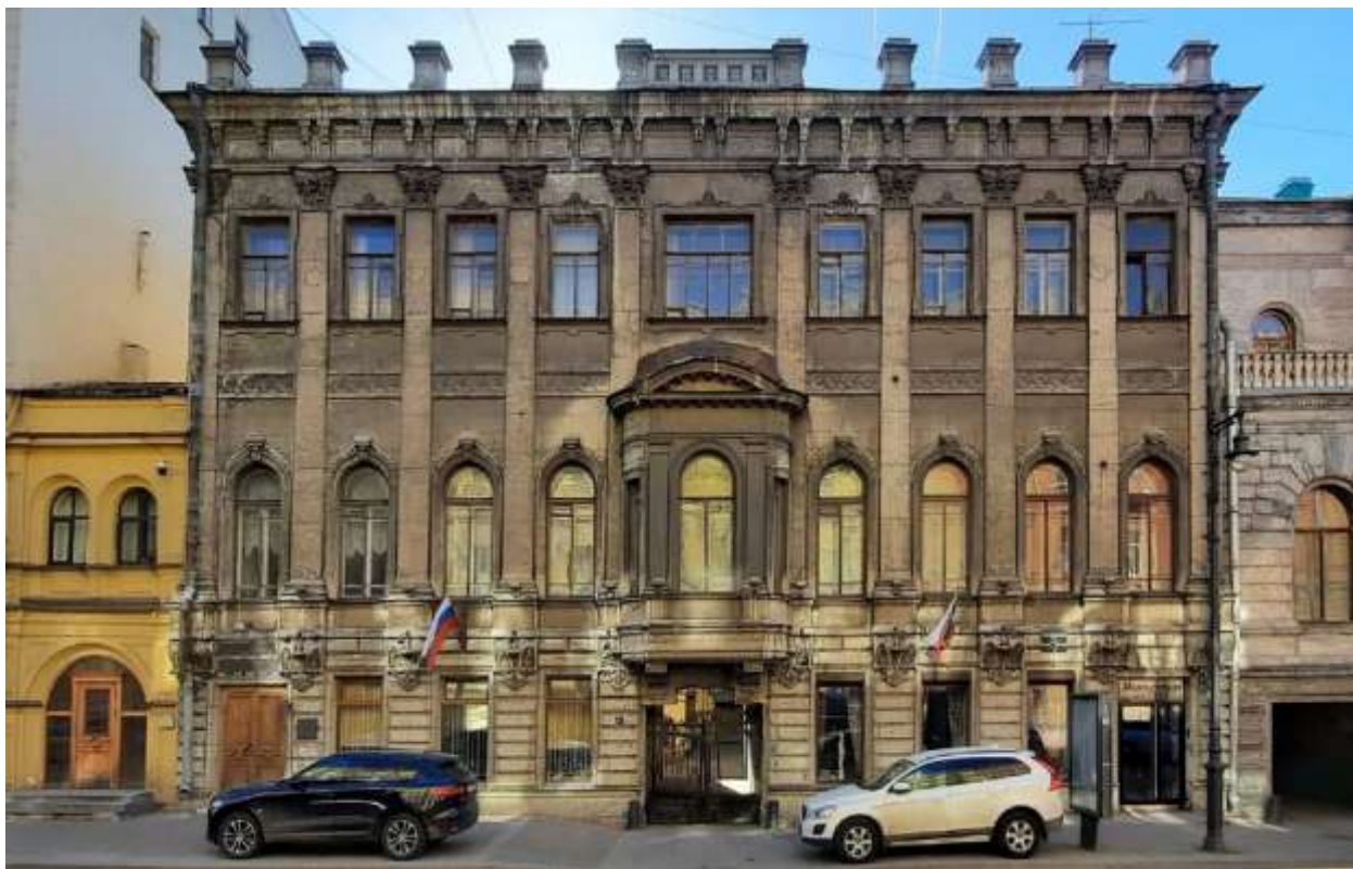
Илл. 16. Объект культурного наследия регионального значения «Особняк Л.Н. Симонова (Столыпинных)», расположенный по адресу: Санкт-Петербург, Гагаринская ул., 5, лит. А. Фото 2022 г. Источник: https://www.citywalls.ru/photo600848.html?s=ikultd6iehhe5vd510mgagm47s
