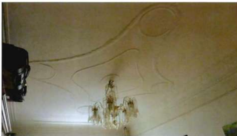
26. Лепной декор потолка. (квартира № 15).
