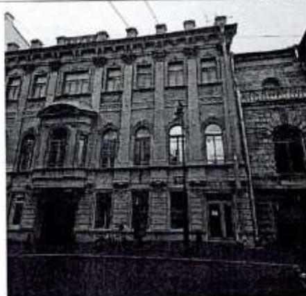
Фрагмент лицевого фасада
