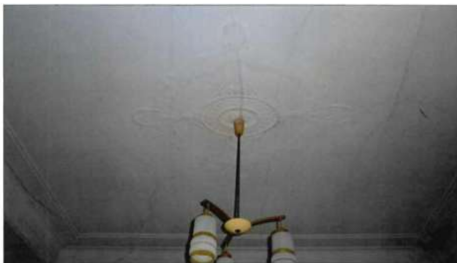
24. Лепная потолочная розетка (квартира № 3).
