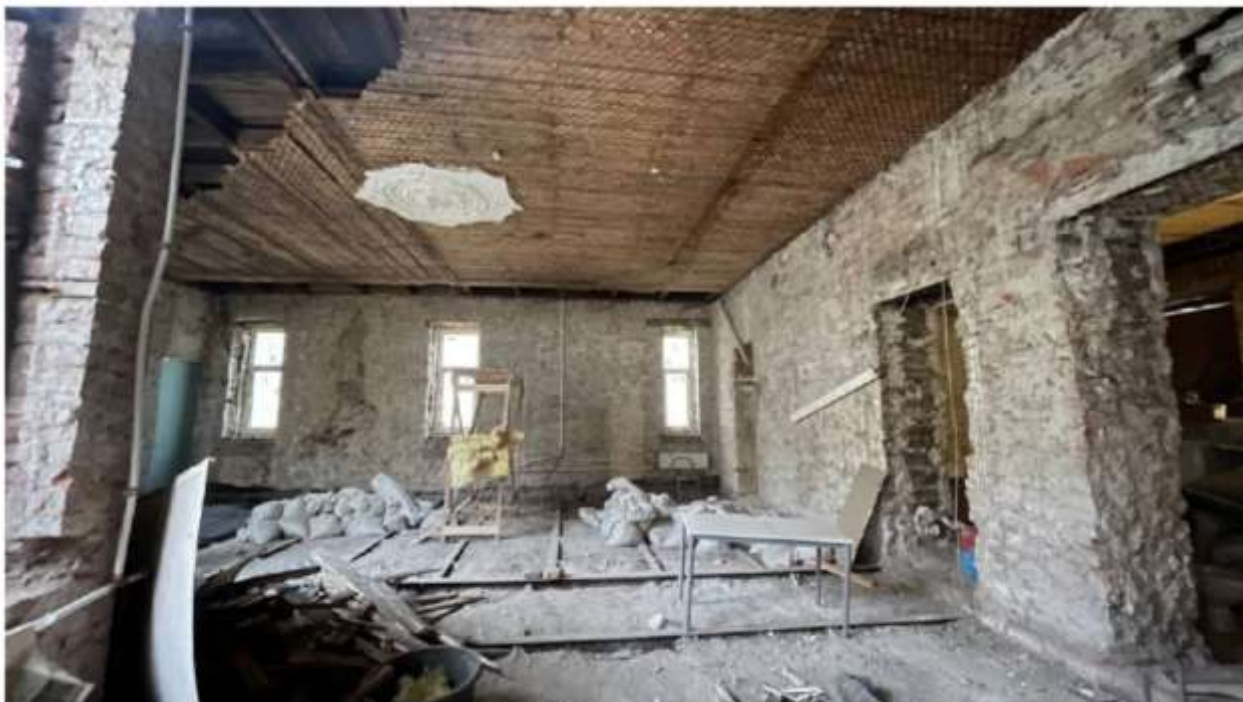
Илл. 28. Объект культурного наследия регионального значения «Особняк Л.Н. Симонова (Столыпиных)», расположенный по адресу: Санкт-Петербург, Гагаринская ул., 5, лит. А. Общий вид помещения в осях 3-4/Б-В с демонтированными перегородками и отделочными слоями.
