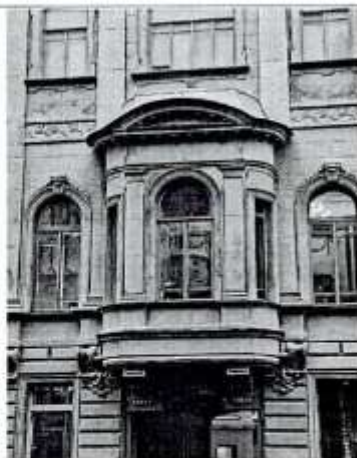
Фрагмент лицевого фасада
