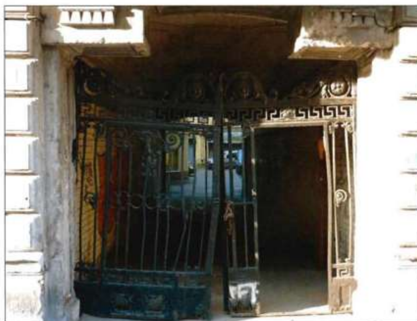
2. Металлические ворота со стороны лицевого фасада.
