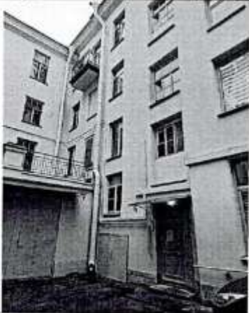
Фрагмент дворового фасада
