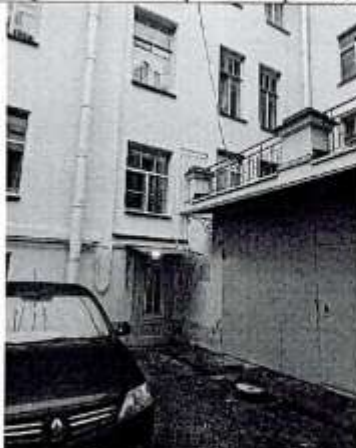
Фрагмент дворового фасада
