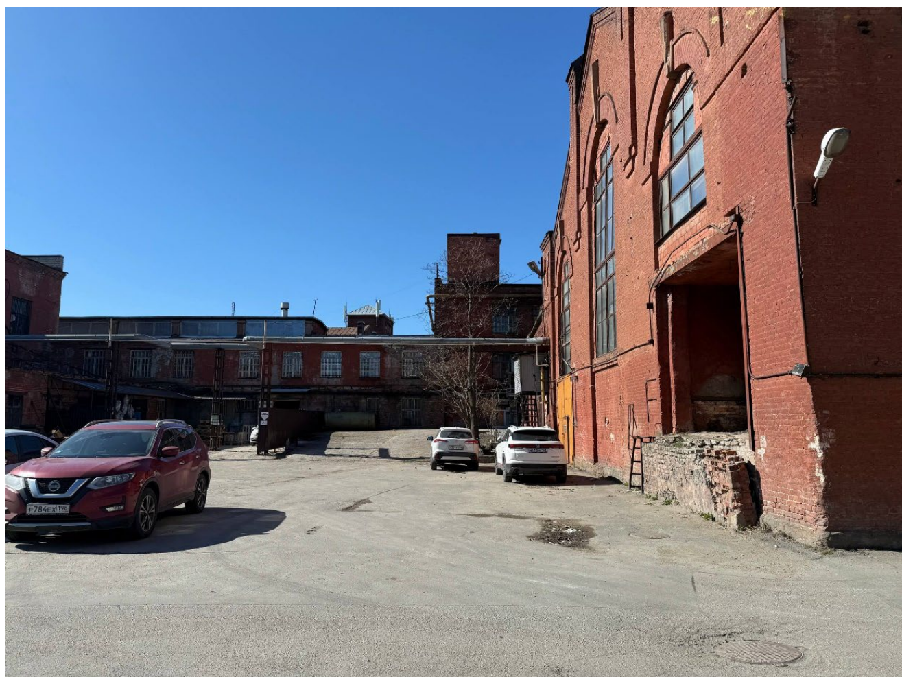
2. Восточные фасады объекта культурного наследия регионального значения «Комплекс построек Кожевенного завода Товарищества «И.А. Осипов и Ко». «Производственный корпус с водонапорной башней», расположенного по адресу: г. Санкт-Петербург, переулок Декабристов, дом 7, литера Т. 14.05.2026
