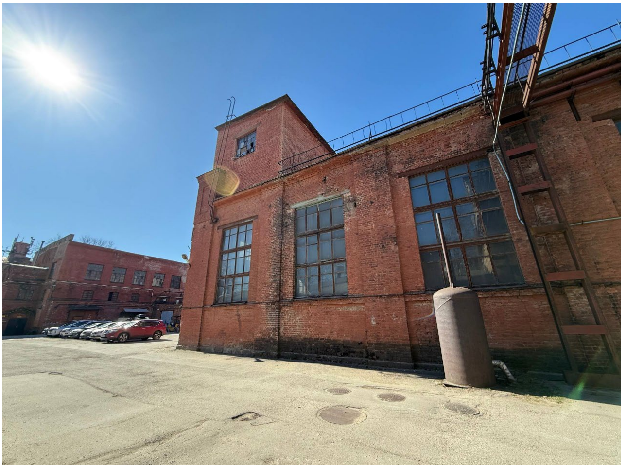
7. Вид на объект культурного наследия регионального значения «Комплекс построек Кожевенного завода Товарищества «И.А. Осипов и Ко». «Котельная» по адресу г. Санкт-Петербург, переулок Декабристов, дом 7, лит. С, от зоны производства работ. 14.05.2026
