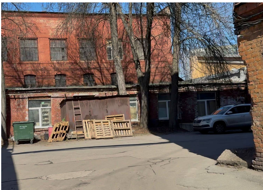
14. Вид от объектов культурного наследия регионального значения «Комплекс построек Кожевенного завода Товарищества «И.А. Осипов и Ко». Службное здание. Мельница. Конюшни и кладовые» по адресу г. Санкт-Петербург, переулок Декабристов, дом 7, лит. К на зону производства работ. 14.05.2026
