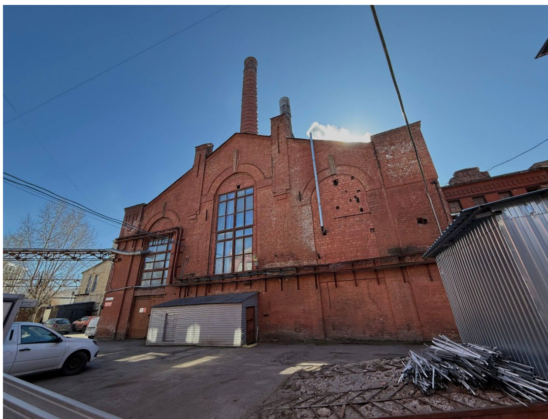
5. Северный фасад объекта культурного наследия регионального значения «Комплекс построек Кожевенного завода Товарищества «И.А. Осипов и Ко». «Котельная» по адресу г. Санкт-Петербург, переулок Декабристов, дом 7, лит. С. 14.05.2026
