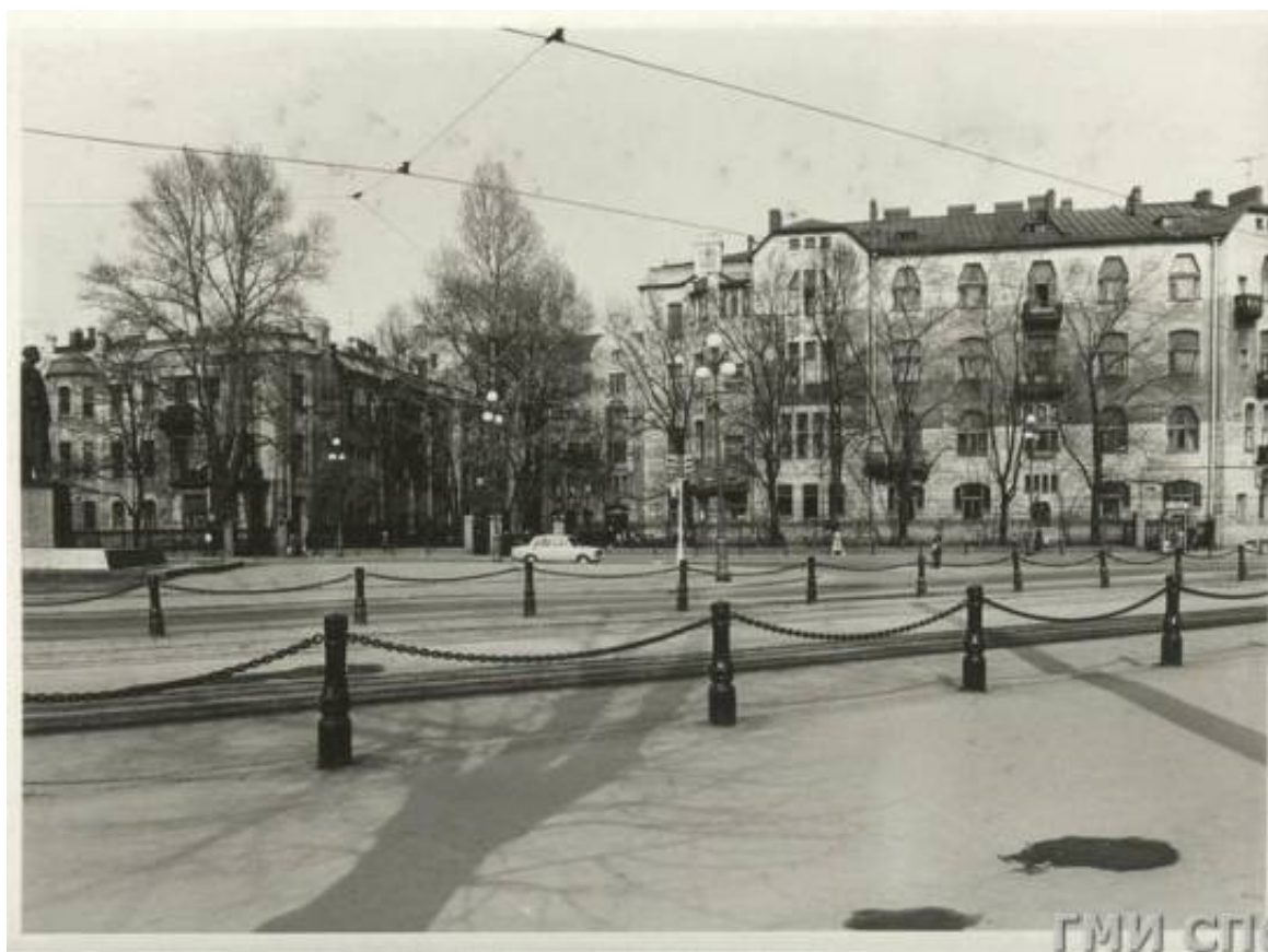
32. Кировский проспект, 1 - 3. Доходный дом Лидваля (архитектор Ф. И. Лидваль). 1986 г. СПб ГБУК «Государственный музей истории Санкт-Петербурга». ГМИ СПб Инв.№-II-Б-38262 ф
