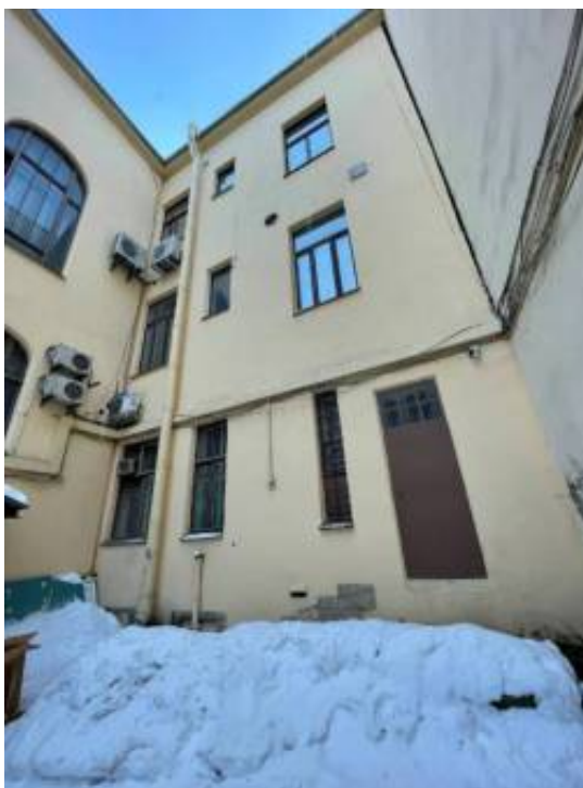
Фото 9. Фрагмент дворового фасада объекта культурного наследия регионального значения «Бывш. дом Лидваля»
