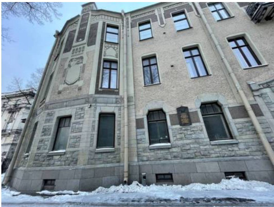
Фото 7. Фрагмент дворового фасада объекта культурного наследия регионального значения «Бывш. дом Лидваля»
