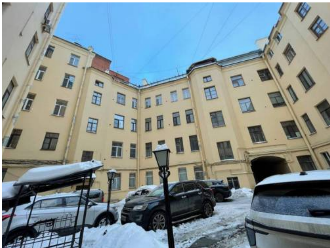
Фото 11. Фрагмент дворового фасада объекта культурного наследия регионального значения «Бывш. дом Лидваля»
