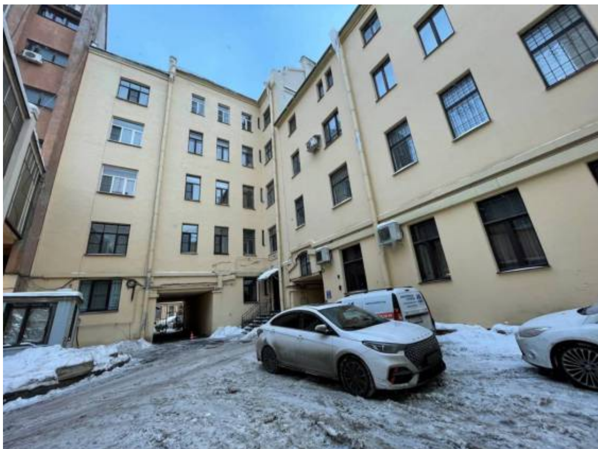
Фото 10. Фрагмент дворового фасада объекта культурного наследия регионального значения «Бывш. дом Лидваля»
