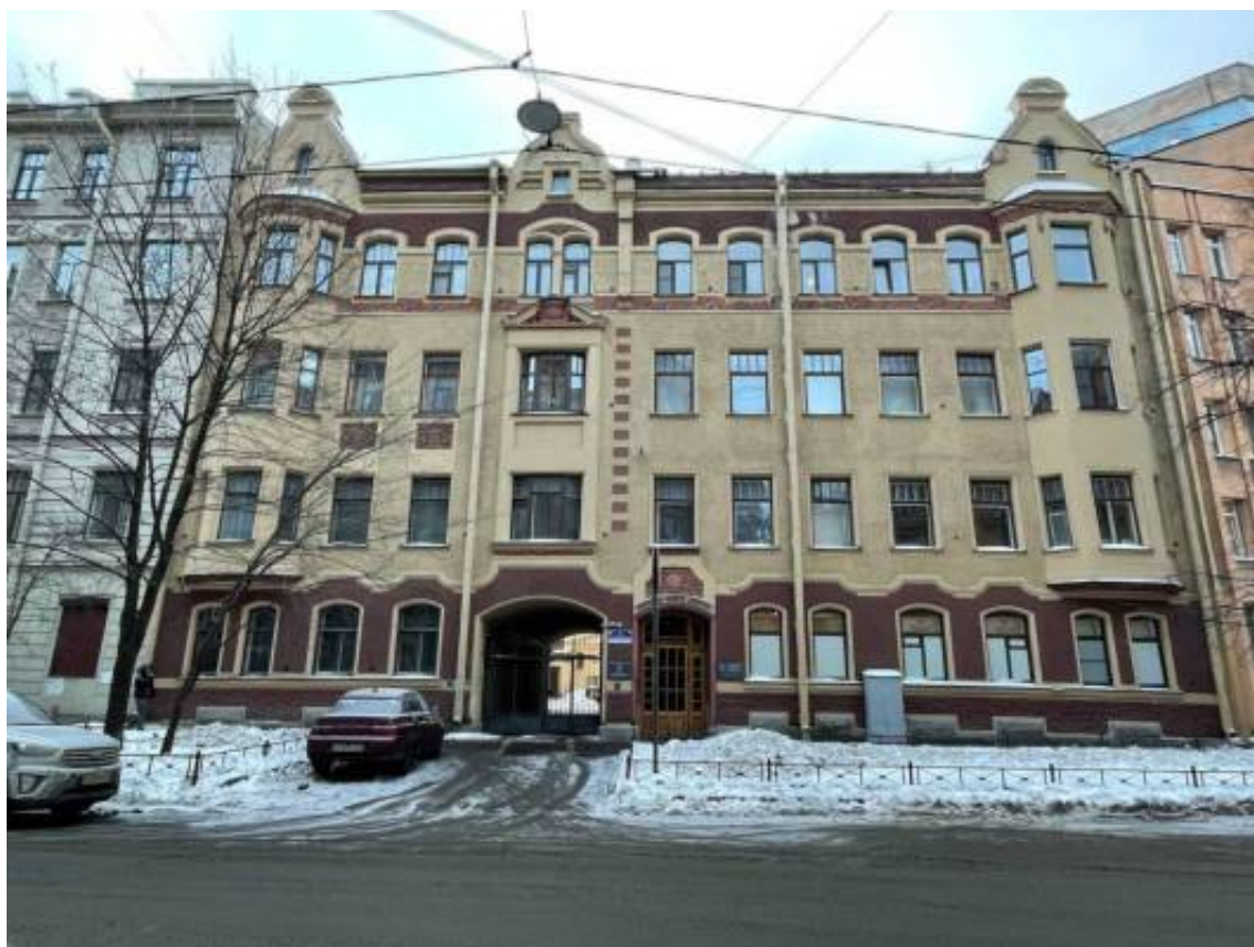
Фото 12. Лицевой фасад объекта культурного наследия регионального значения «Бывш. дом Лидваля» (по Малой Посадской ул.)
