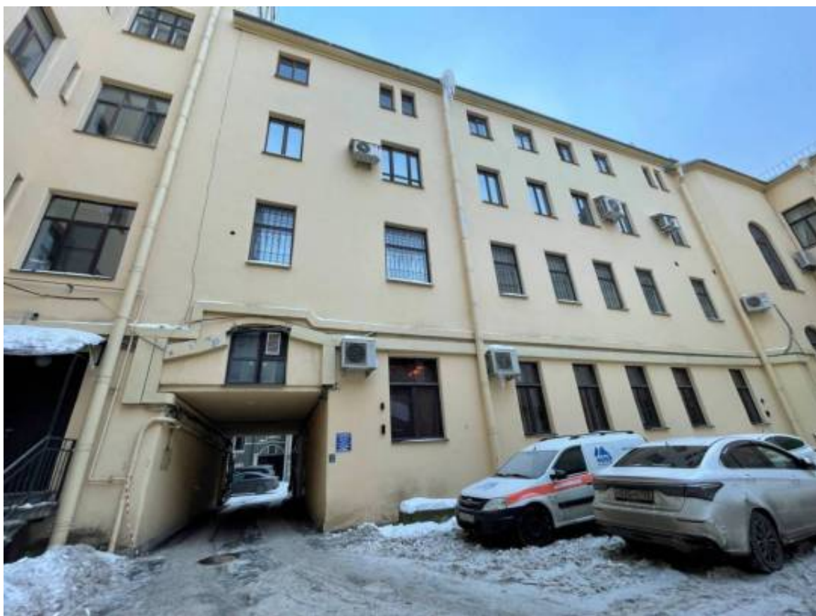
Фото 8. Фрагмент дворового фасада объекта культурного наследия регионального значения «Бывш. дом Лидваля»
