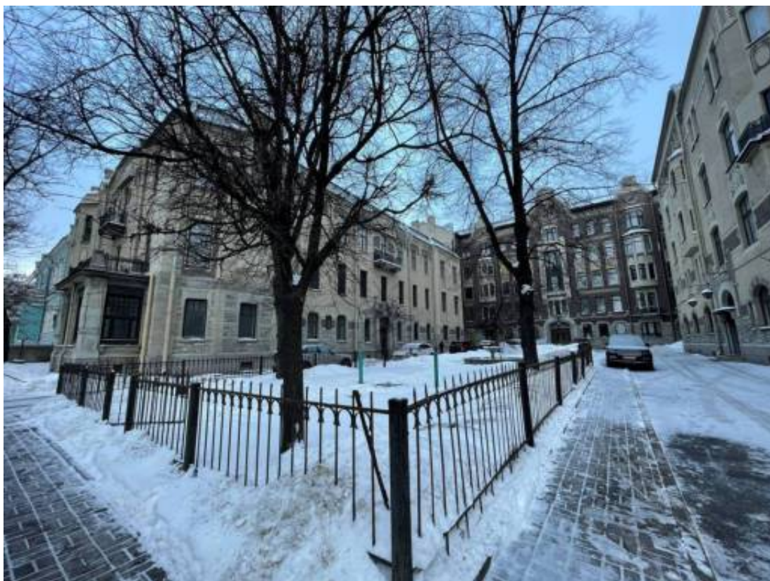
Фото 3. Фрагмент дворового фасада объекта культурного наследия регионального значения «Бывш. дом Лидваля»
