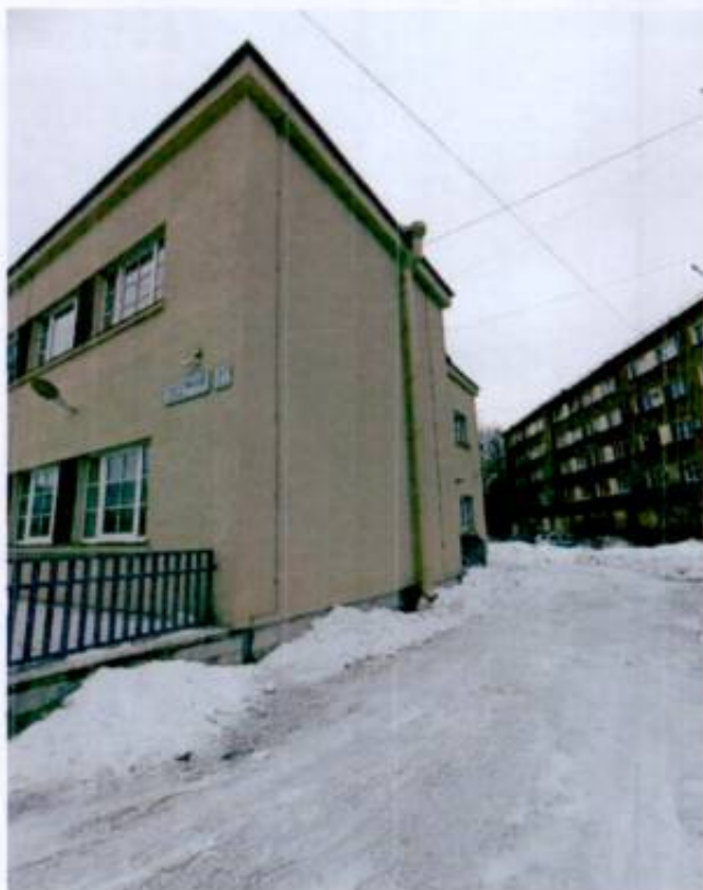
3. Вид на северо-восточный фасад объекта культурного наследия.
