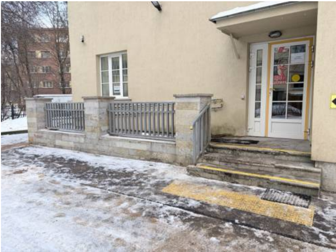
7. Общий вид крыльца К-2.
