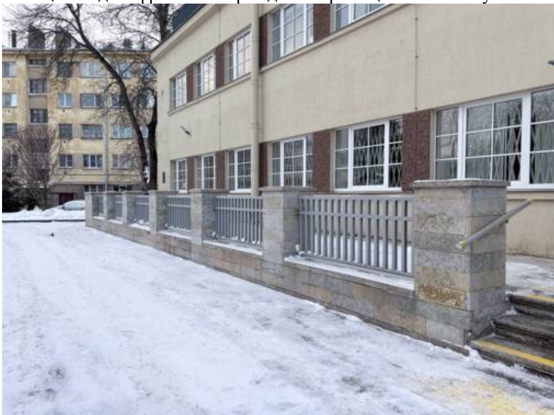
2. Общий вид на фрагмент ограждения крыльца К-1.
