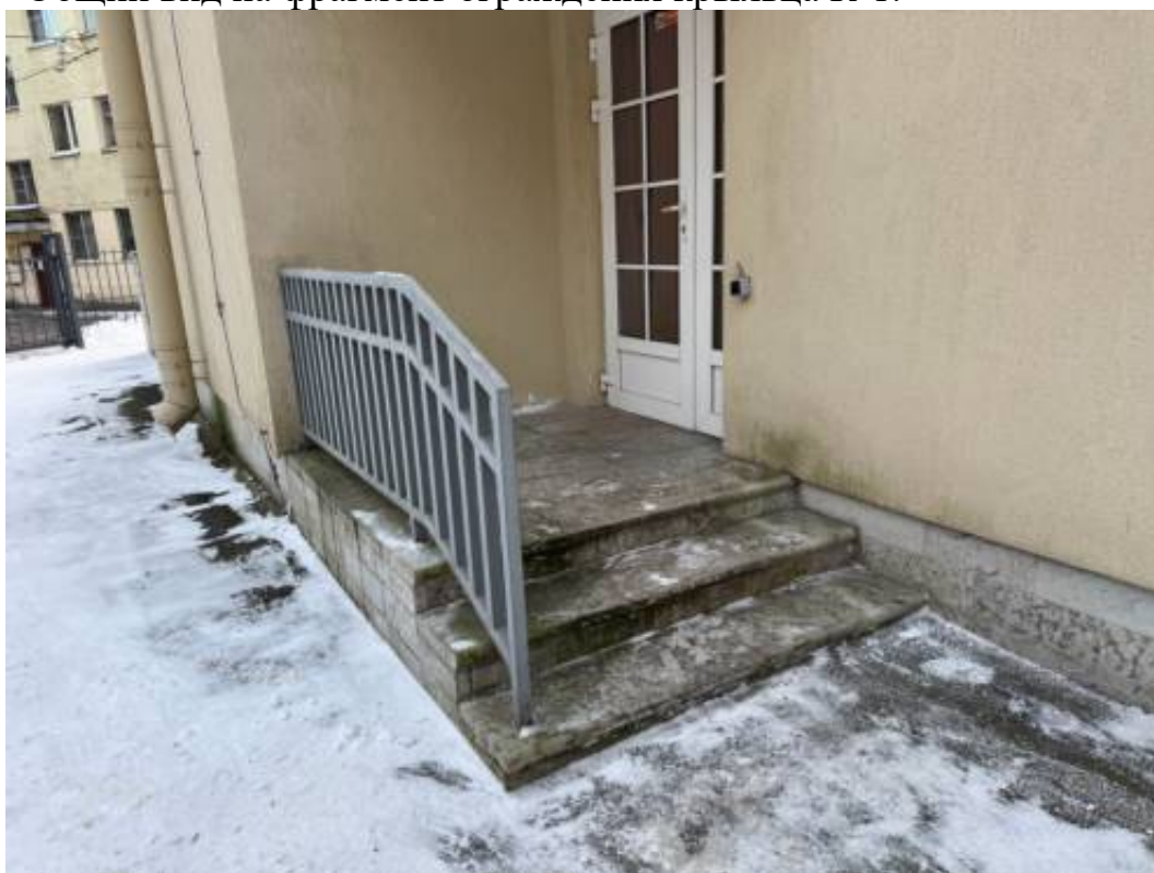
6. Общий вид крыльца К-3.
