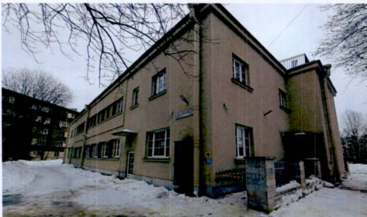
2. Общий вид объекта культурного наследия с северо-западной стороны.
