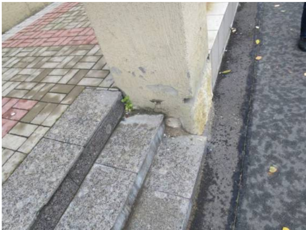
Илл.22. Фото из проекта 2016 г. Проект реставрационного ремонта крыльца здания «Механической прачечной», входящего в состав комплекса «Батенинский жилмассив» по адресу: г. Санкт-Петербург, Лесной проспект, дом 37, литера «К», шифр 42/09.13
