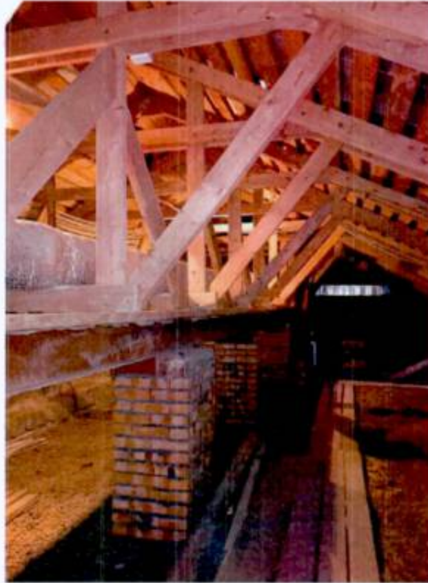
7. Конструкции крыши объекта культурного наследия.
