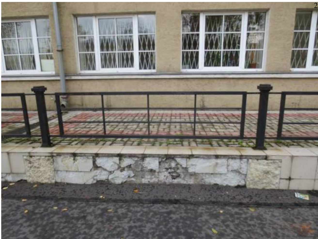
Илл.21. Фото из проекта 2016 г. Проект реставрационного ремонта крыльца здания «Механической прачечной», входящего в состав комплекса «Батенинский жилмассив» по адресу: г. Санкт-Петербург, Лесной проспект, дом 37, литера «К», шифр 42/09.13
