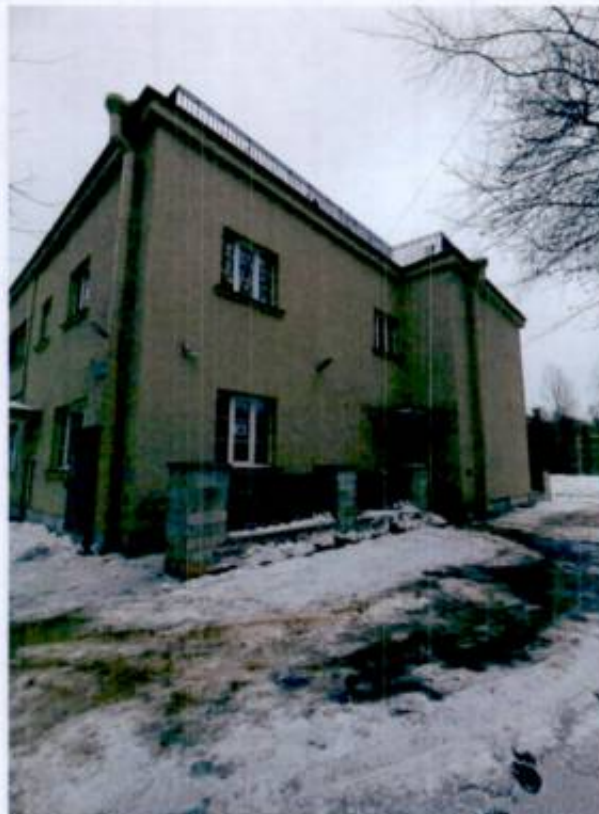
4. Вид на юго-западный фасад объекта культурного наследия.
