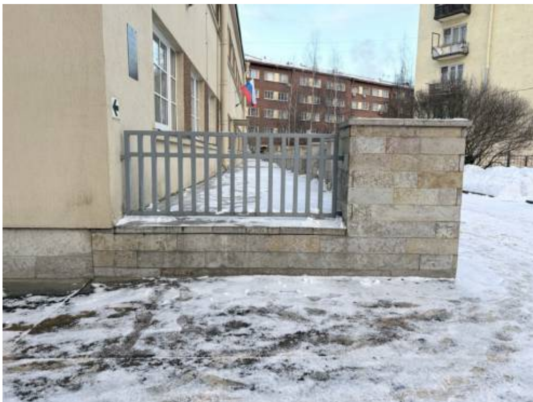
5. Общий вид на фрагмент ограждения крыльца К-1.
