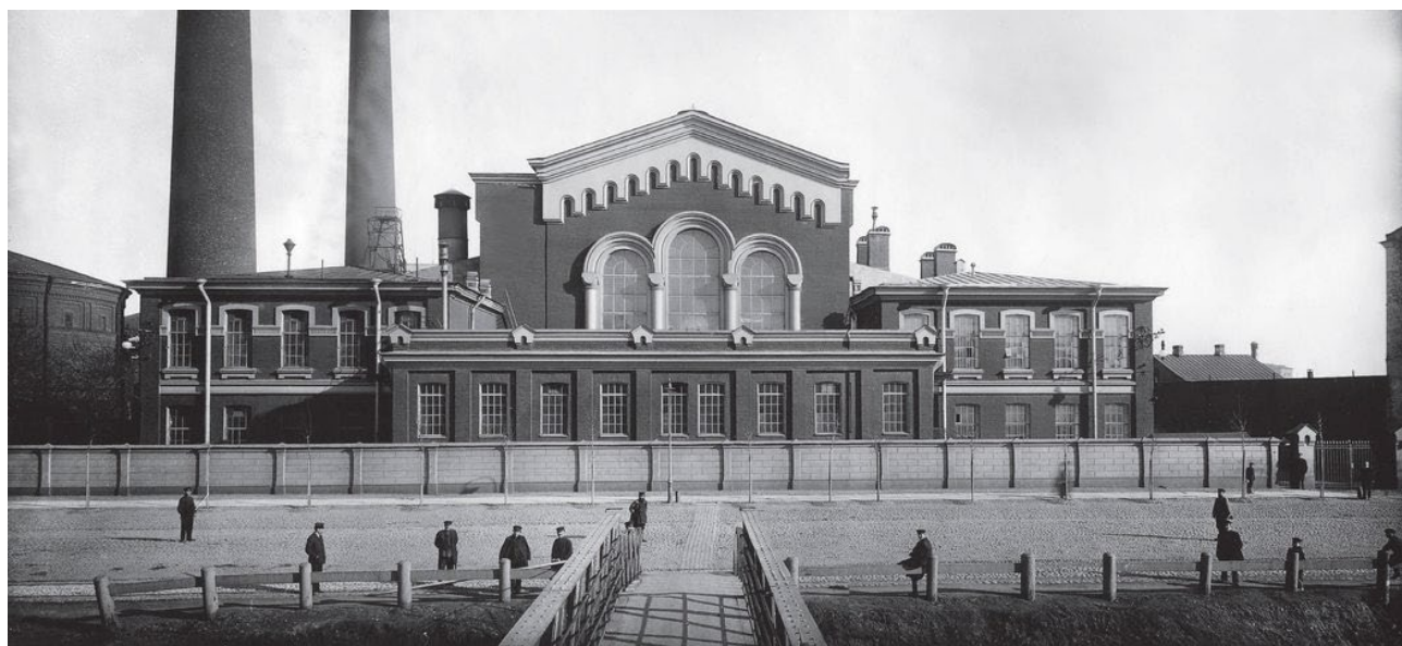
Рис. 28. Здание Центральной электрической станции «Общества электрического освещения 1886 г.» (1911), Россия, Санкт-Петербург, Адмиралтейский район, округ Семёновский. Вариант № 121759. Автор: ателье Буллы. Фото из книги: «Опережая время: фотолетопись энергетики Северо-Запада» / под ред. Н. И. Быстровой. — СПб.: Издательский дом «МедиаЛайн», 2015.
