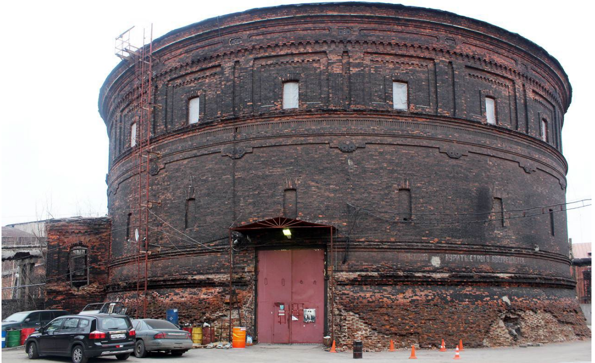
Рис. 32. Главный газовый завод Общества столичного освещения. Газгольдер 2 (наб. Обводного канала, 74, лит. Д). Фото — Виктор М, 25.11.2013. Источник: Citywalls.ru .
