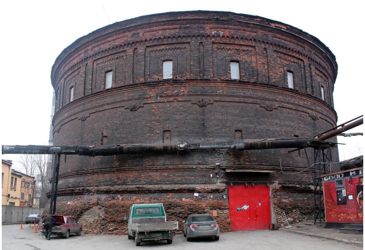
Рис. 33. Главный газовый завод Общества столичного освещения. Газгольдер 2 (наб. Обводного канала, 74, лит. Д). Фото — Виктор М, 25.11.2013. Источник: Citywalls.ru .
