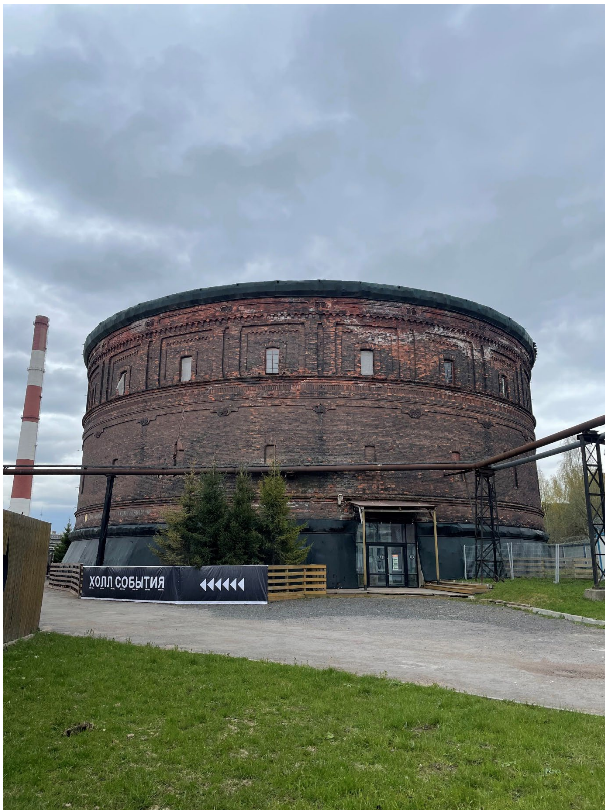
Фото 1. Общий вид на объект.
