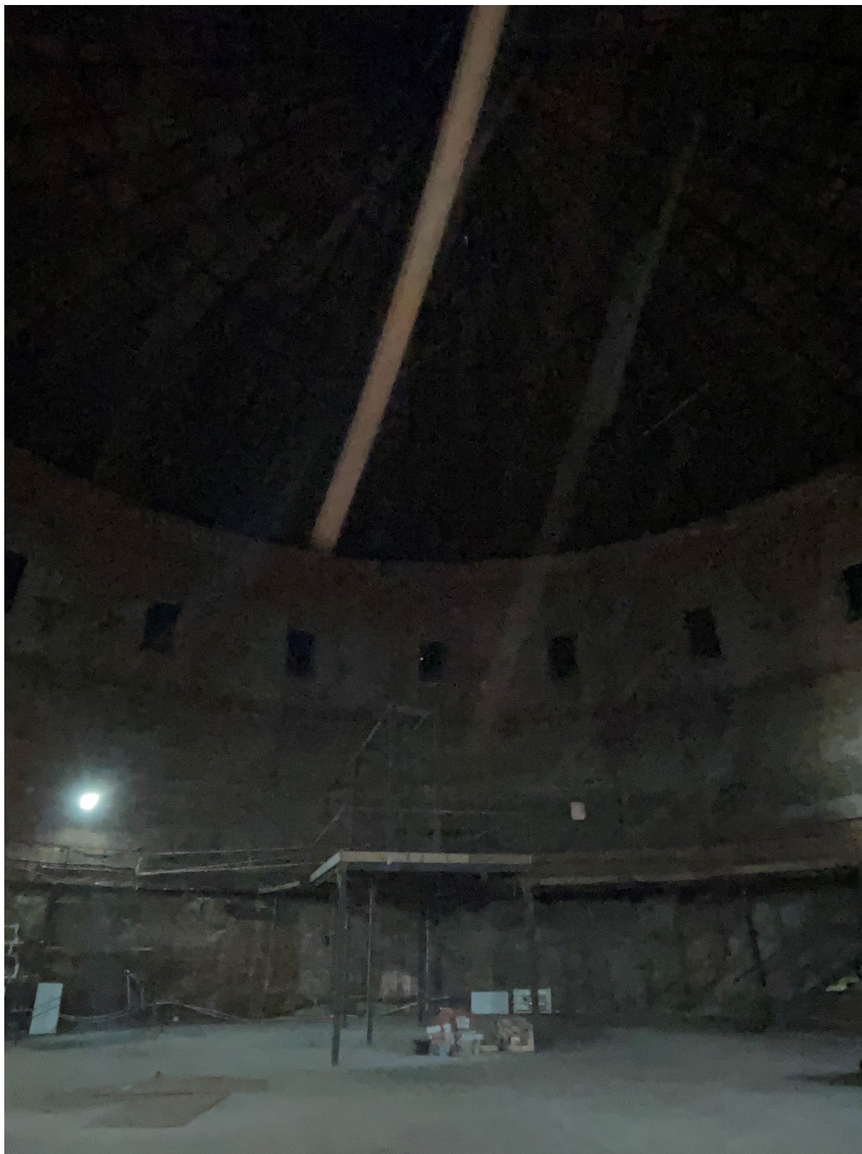
Фото 3. Общий вид на объект.
