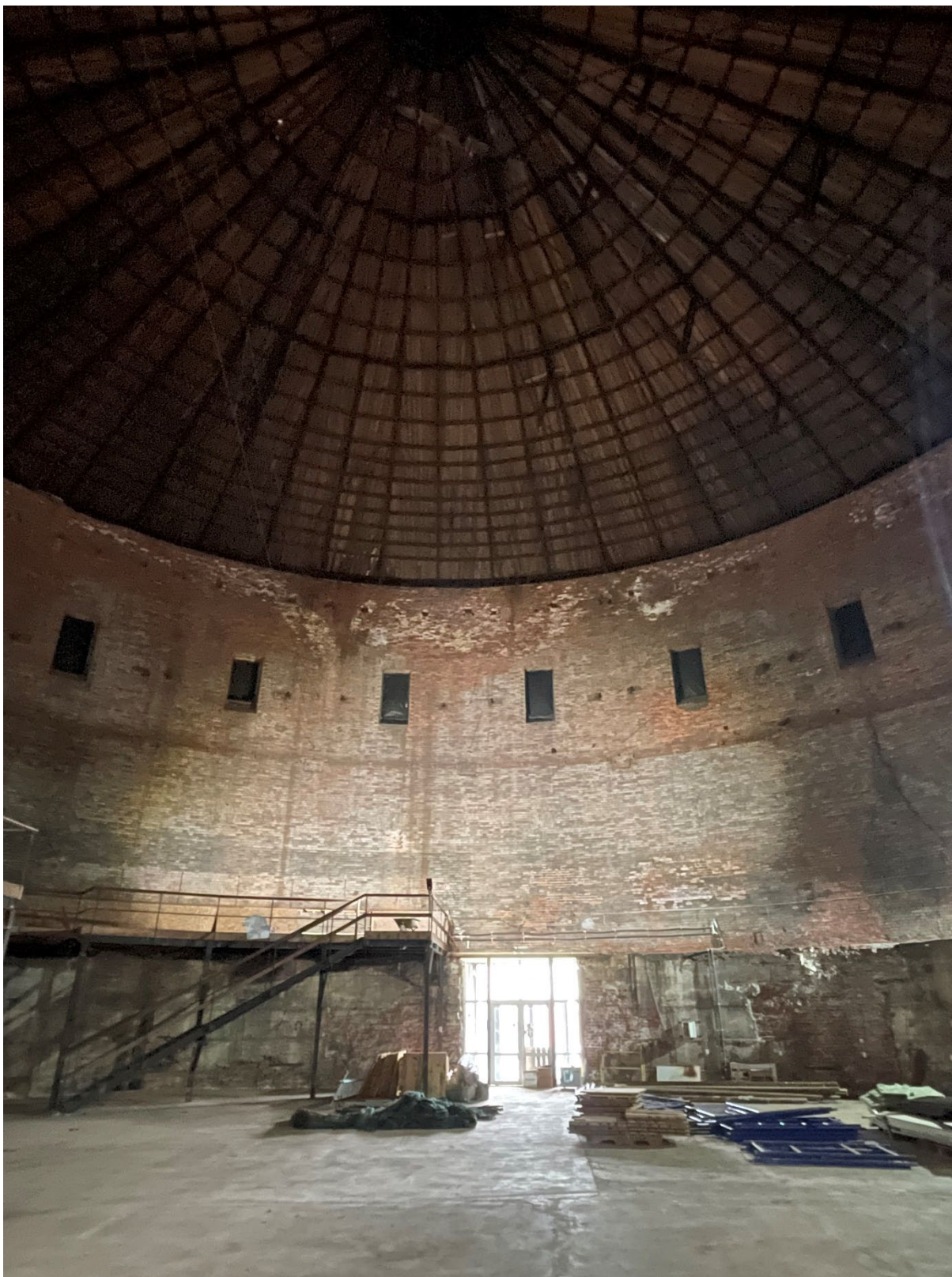
Фото 2. Общий вид на объект.
