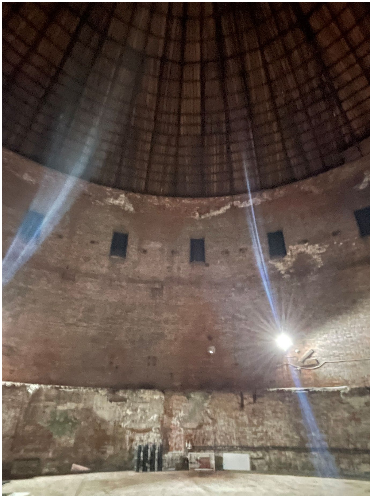
Фото 4. Общий вид на объект.
