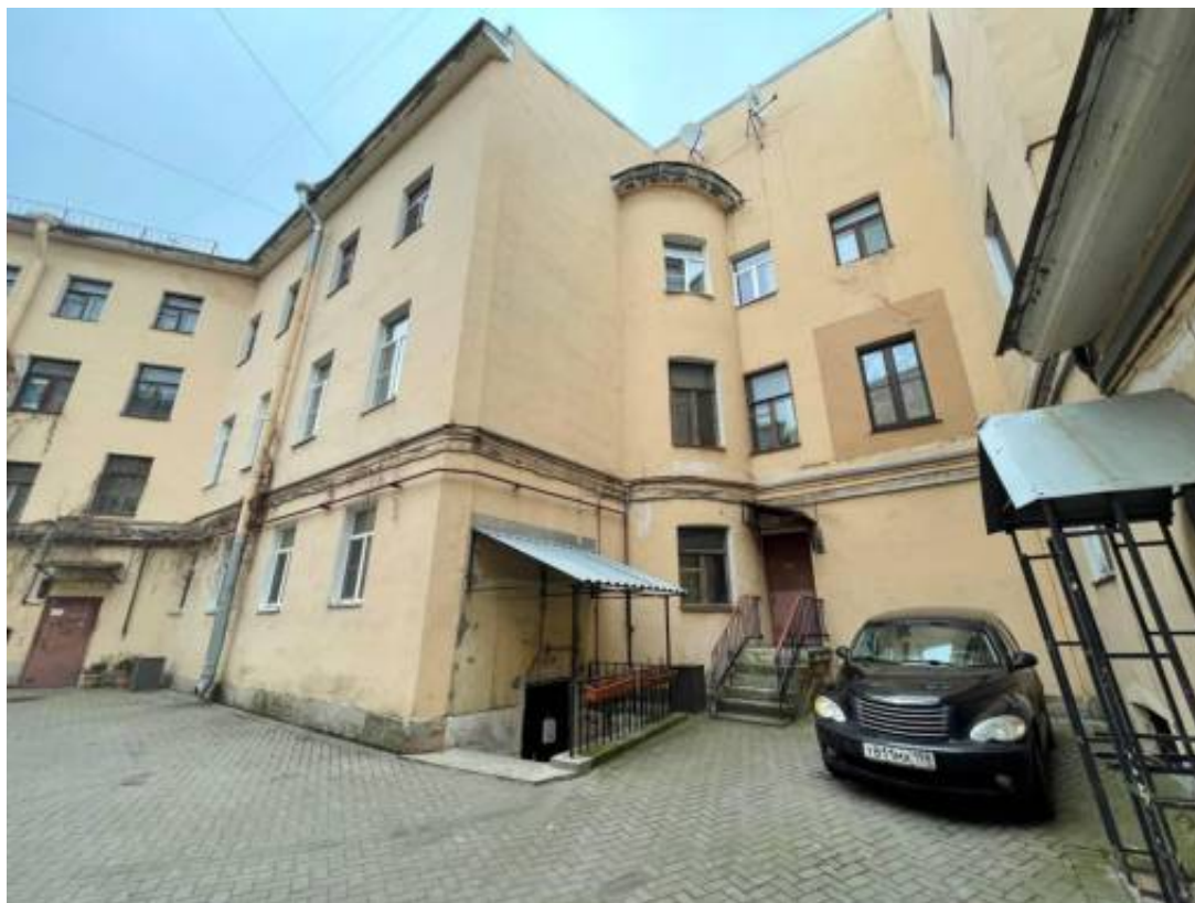
Фото 5. Фрагмент дворового фасада выявленного объекта культурного наследия «Дом А. Эрке»
