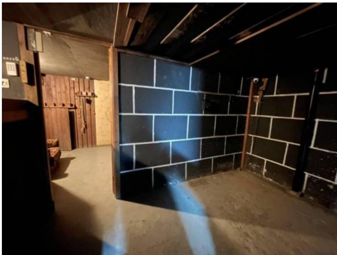
Фото 16. Интерьер пом. 2-Н выявленного объекта культурного наследия «Дом А. Эрке»
