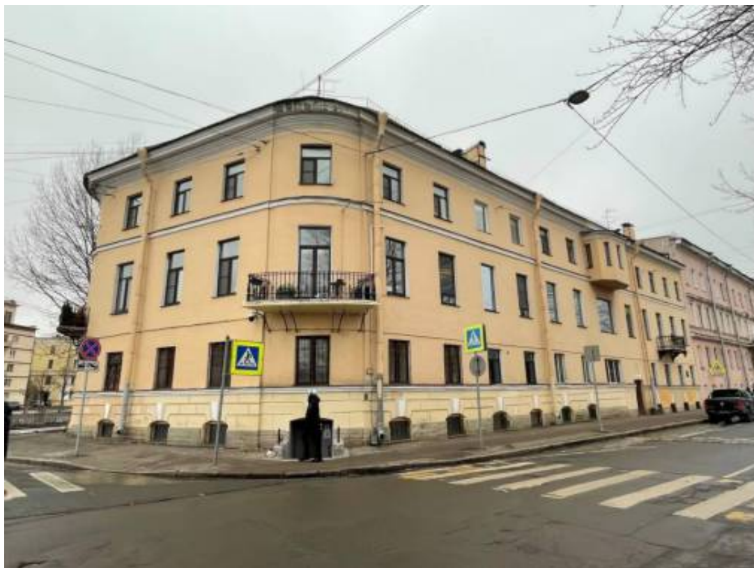
Фото 1. Лицевой фасад выявленного объекта культурного наследия «Дом А. Эрке» (по наб. Крюкова канала)
