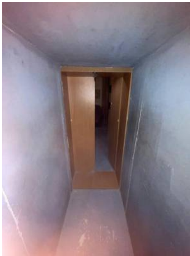
Фото 32. Интерьер пом. 2-Н выявленного объекта культурного наследия «Дом А. Эрке»
