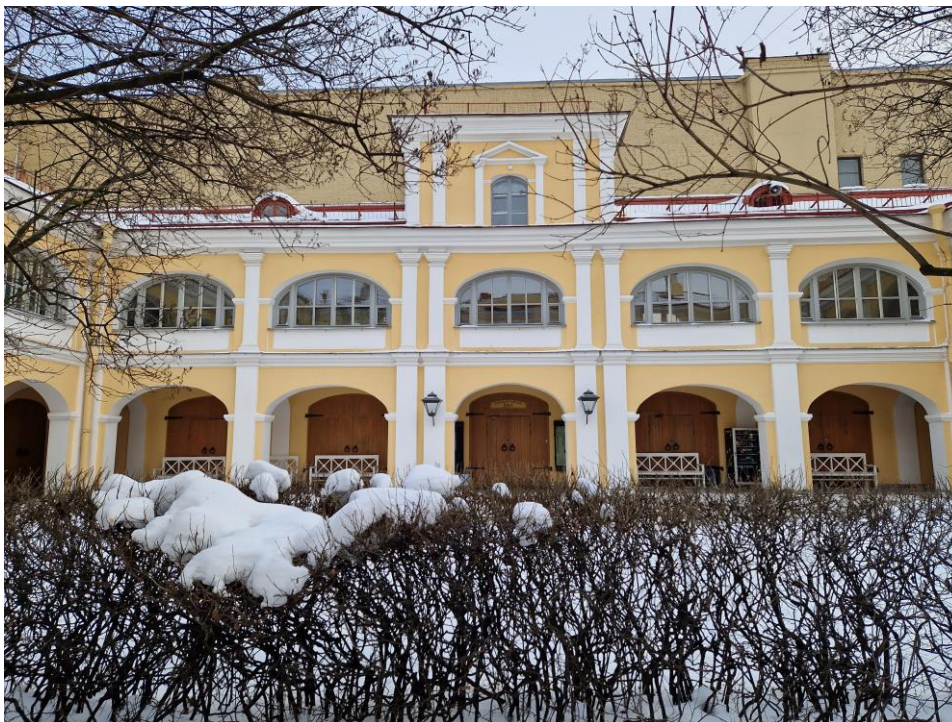
3. Объект культурного наследия федерального значения «Конюшня и каретный сарай», входящий в состав объекта культурного наследия федерального значения «Дом Волконских» по адресу: г. Санкт-Петербург, наб. реки Мойки, д.12, лит. А (наб. реки Мойки, д.12). Центральная часть здания. Общий вид.
