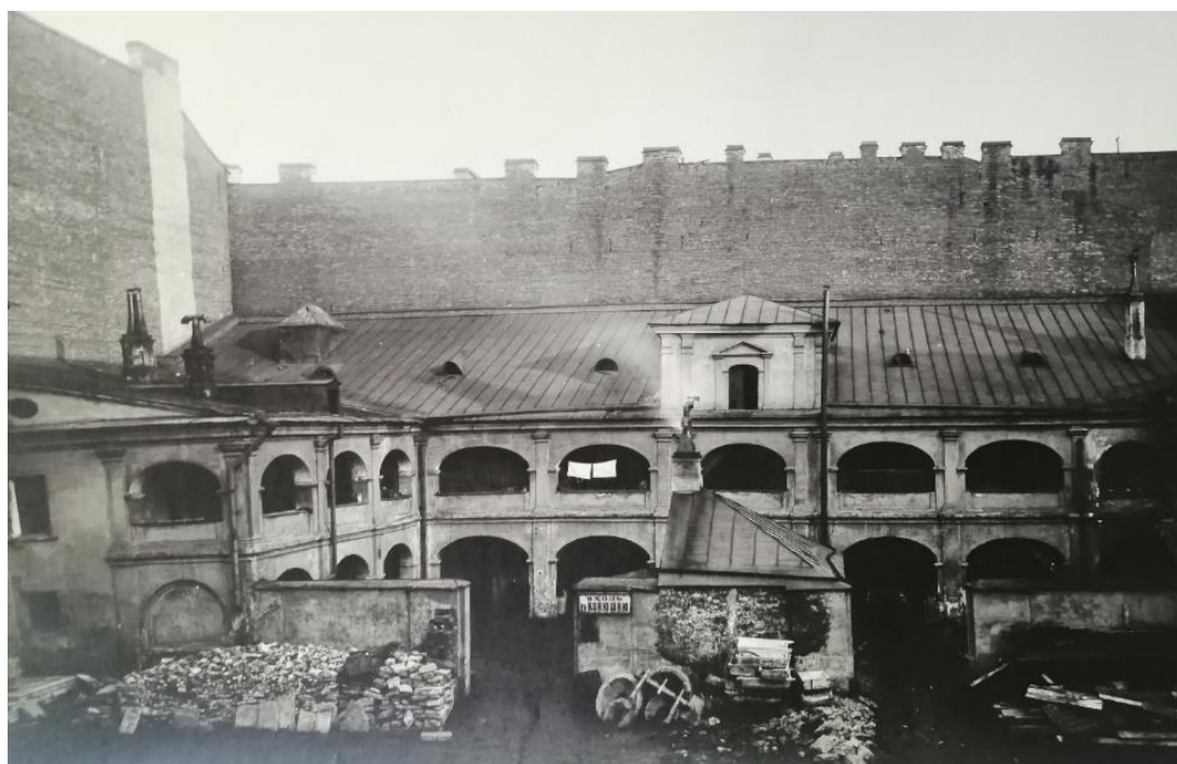
20. Дом на Мойке, 12. Строения в дворе: конюшни с аркадами. На переднем плане: три прясла каменной стены по периметру аркад конюшен частично разделили пространство большого двора. Конюшенный двор частично изолирован. Вверху - бранмауэры соседних домов ещё без пробитых окон. Фотография. 1930-е гг. https://pastvu.com
