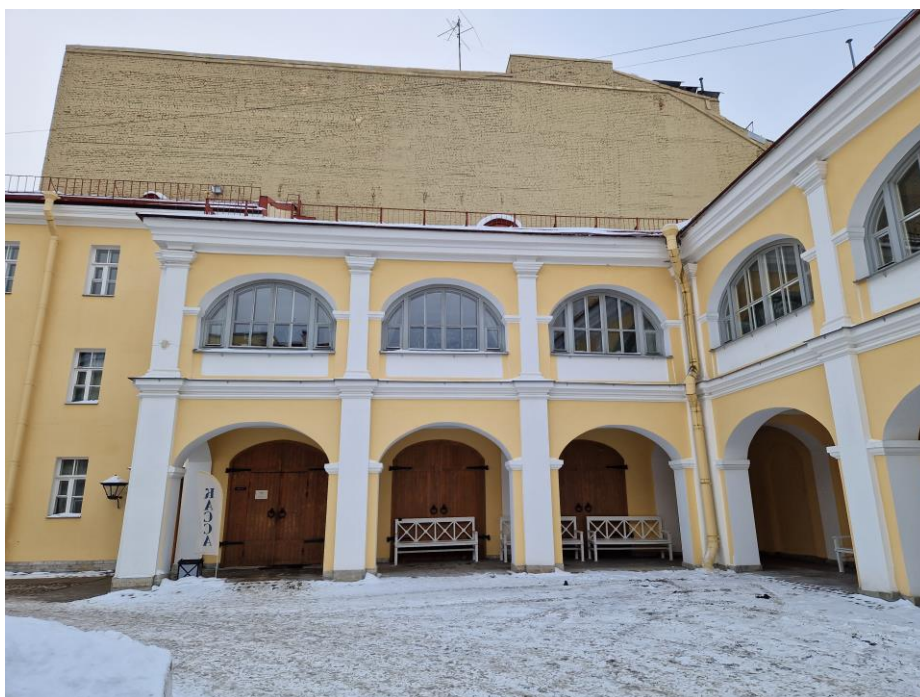
7. Объект культурного наследия федерального значения «Конюшня и каретный сарай», входящий в состав объекта культурного наследия федерального значения «Дом Волконских» по адресу: г. Санкт-Петербург, наб. реки Мойки, д.12, лит. А (наб. реки Мойки, д.12). Восточная часть здания. Двухъярусная аркада с открытой галереей первого этажа. Общий вид.
