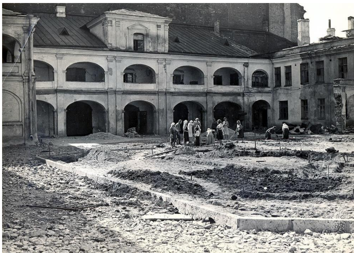
22. Дом на Мойке, 12. «Бироновы» конюшни с аркадами. Большой двор. Процесс создания нового благоустройства - разбивка дорожек «Сада». Справа – одна арка, остаток прежней западной галереи до воссоздания. Малый кирпичный домик по оси конюшен уже снесён. Вид с севера. Фотография. 1947 г. https://www.citywalls.ru/house
