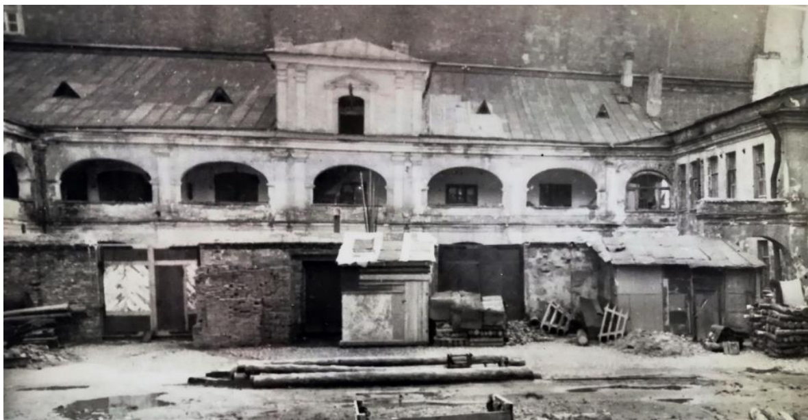
21. Дом на Мойке, 12. Строения в дворе: конюшни с аркадами. На среднем плане: хаотичные навесы и пристройки к нижней аркаде. Вверху слева - бранмауэр соседнего дома и самовольно пробитое окно. Вид с севера. Фотография середины XX в. https://pastvu.com
