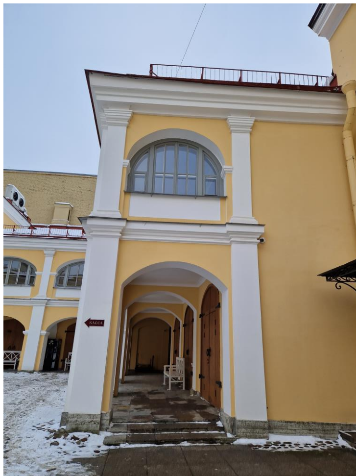
10. Объект культурного наследия федерального значения «Конюшня и каретный сарай», входящий в состав объекта культурного наследия федерального значения «Дом Волконских» по адресу: г. Санкт-Петербург, наб. реки Мойки, д.12, лит. А (наб. реки Мойки, д.12). Западная часть здания. Двухъярусная аркада с открытой галереей первого этажа.
