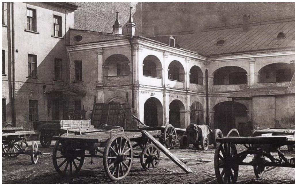
16. Дом на Мойке, 12. Строения в дворе: конюшни с аркадами, щипец с овальным проемом и бранмауэры соседних домов. Позднее, при последней реставрации изменены: расположение проёмов и часть окон заложили. Справа малый кирпичный домик. Вид с северо-запада. Фотография начала XX в. https://www.citywalls.ru/house
