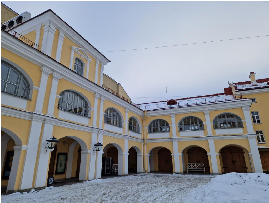
9. Объект культурного наследия федерального значения «Конюшня и каретный сарай», входящий в состав объекта культурного наследия федерального значения «Дом Волконских» по адресу: г. Санкт-Петербург, наб. реки Мойки, д.12, лит. А (наб. реки Мойки, д.12). Западная часть здания. Двухъярусная аркада с открытой галереей первого этажа. Общий вид.
