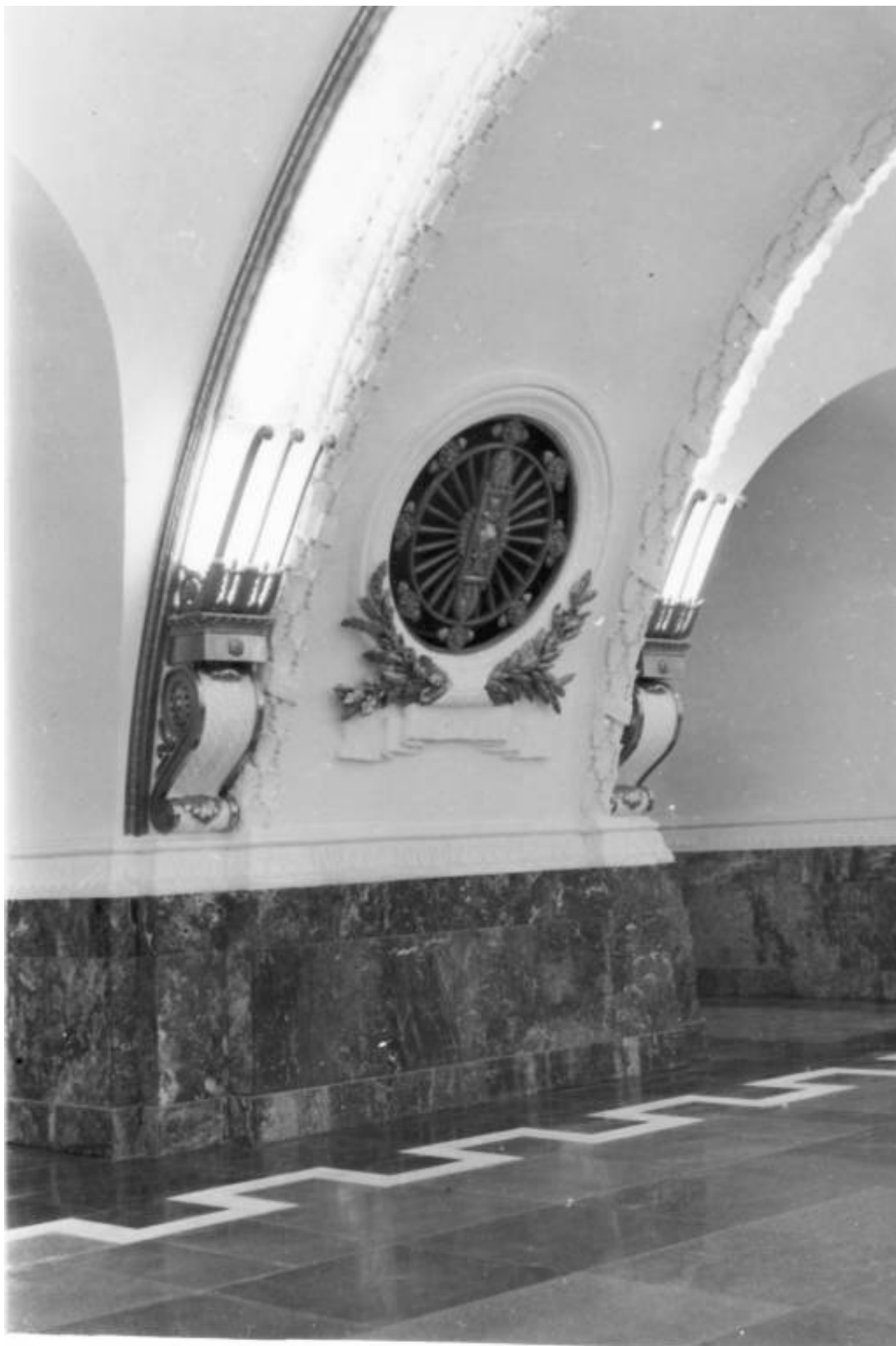
Илл.33. Декоративное убранство пилон в подземном зале станции "Площадь Восстания". Дата съемки: сер.1950-х гг. Автор съемки не установлен. // ЦГАКФФД СПб. Фотодокументы. Опись 1БР-56. Ед.хр.70407
