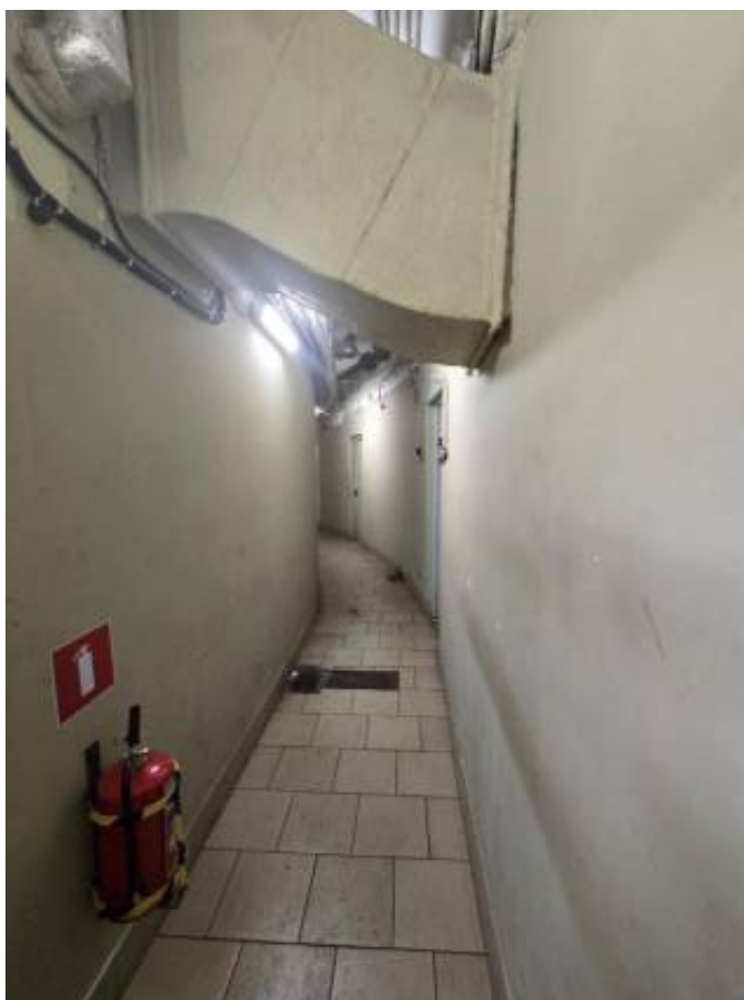
Фото п.2. Подвал, коридор, помещение 1-Н (48).
