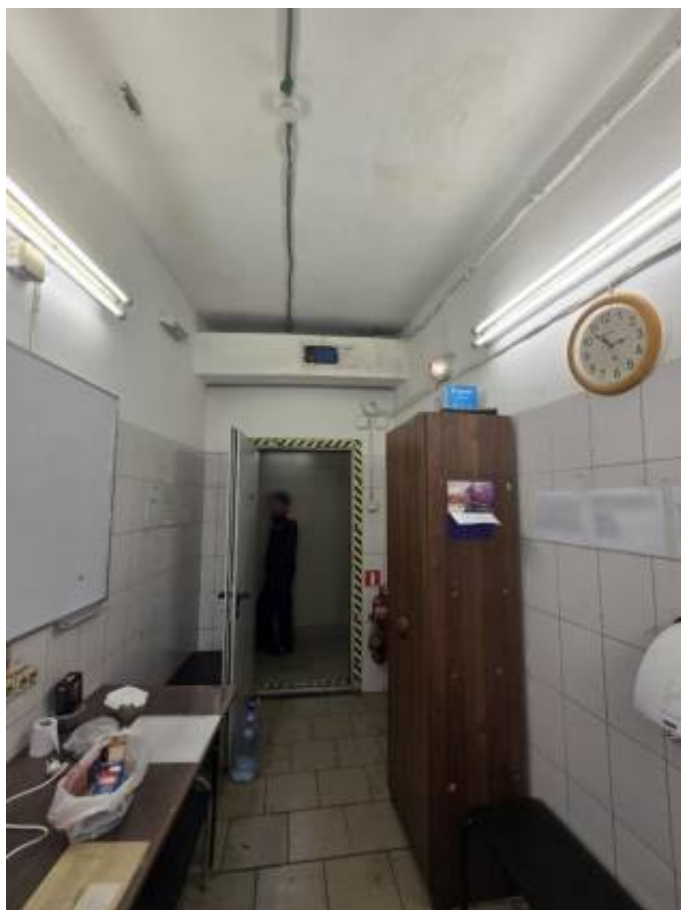
Фото п.18. Подвал, помещение 1-Н (53).
