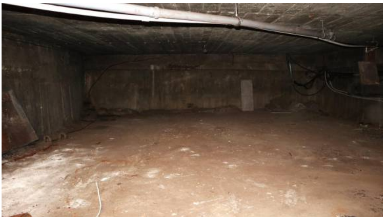
Фото тп.4. Техническое подполье.
