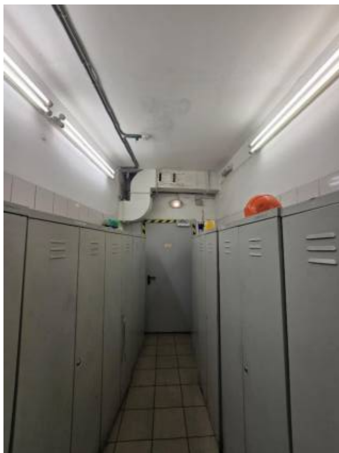
Фото п.14. Подвал, помещение 1-Н (51).
