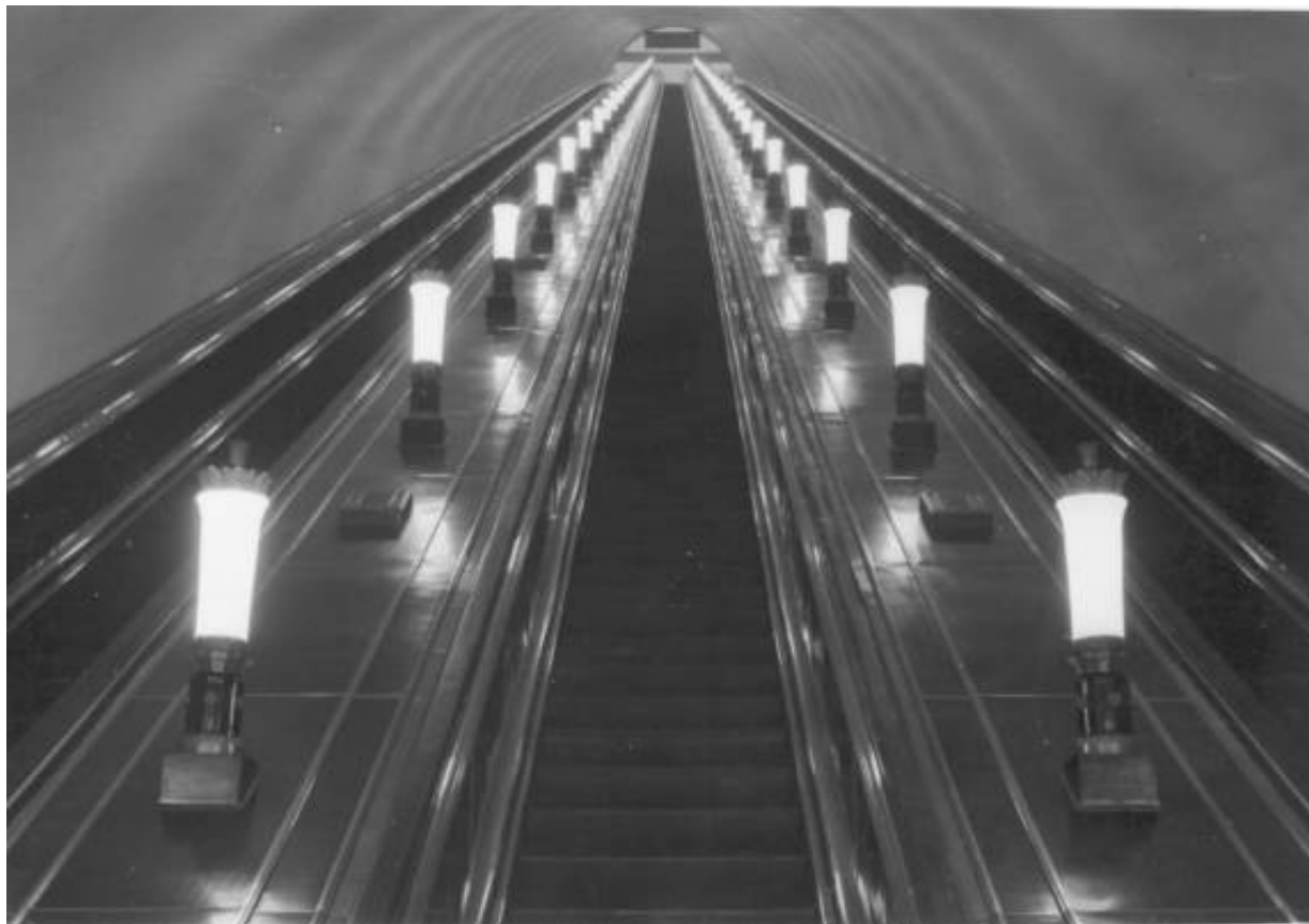
Илл. 37. Общий вид наклонного тоннеля, оборудованного трехленточными эскалаторами на станции "Площадь Восстания". Архитекторы В.В. Ганкевич, Б.Н. Журавлев, И.И. Фомин. Дата съемки: 1955 г. Автор съемки не установлен. // ЦГАКФФД СПб. Фотодокументы. Опись 1БР-56. Ед.хр.71254
