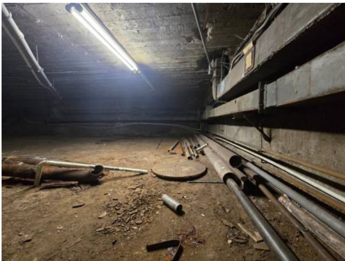
Фото тп.2. Техническое подполье.
