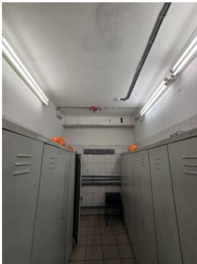
Фото п.13. Подвал, помещение 1-Н (51).
