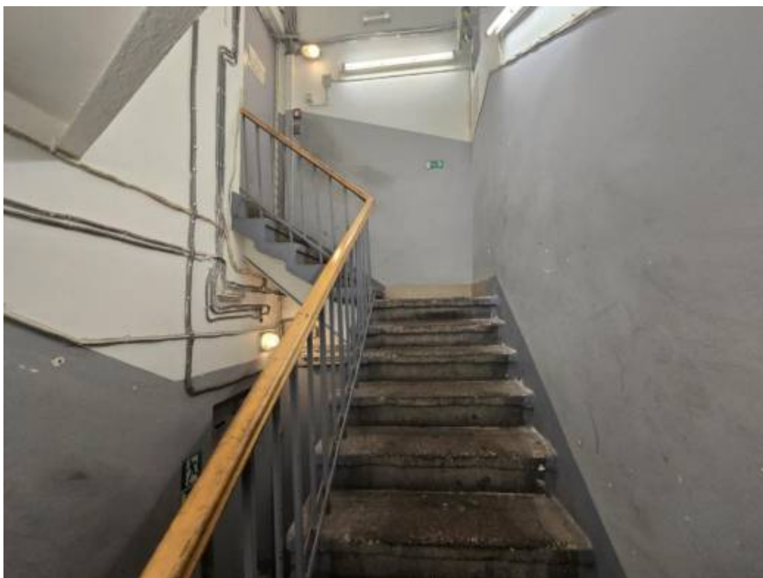
Фото 1.24. 1 этаж, лестница в подвал, помещение 1-Н (45).
