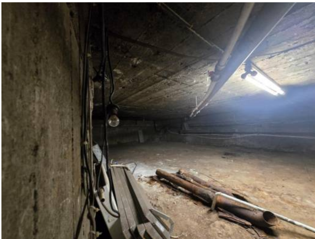
Фото тп.1. Техническое подполье.
