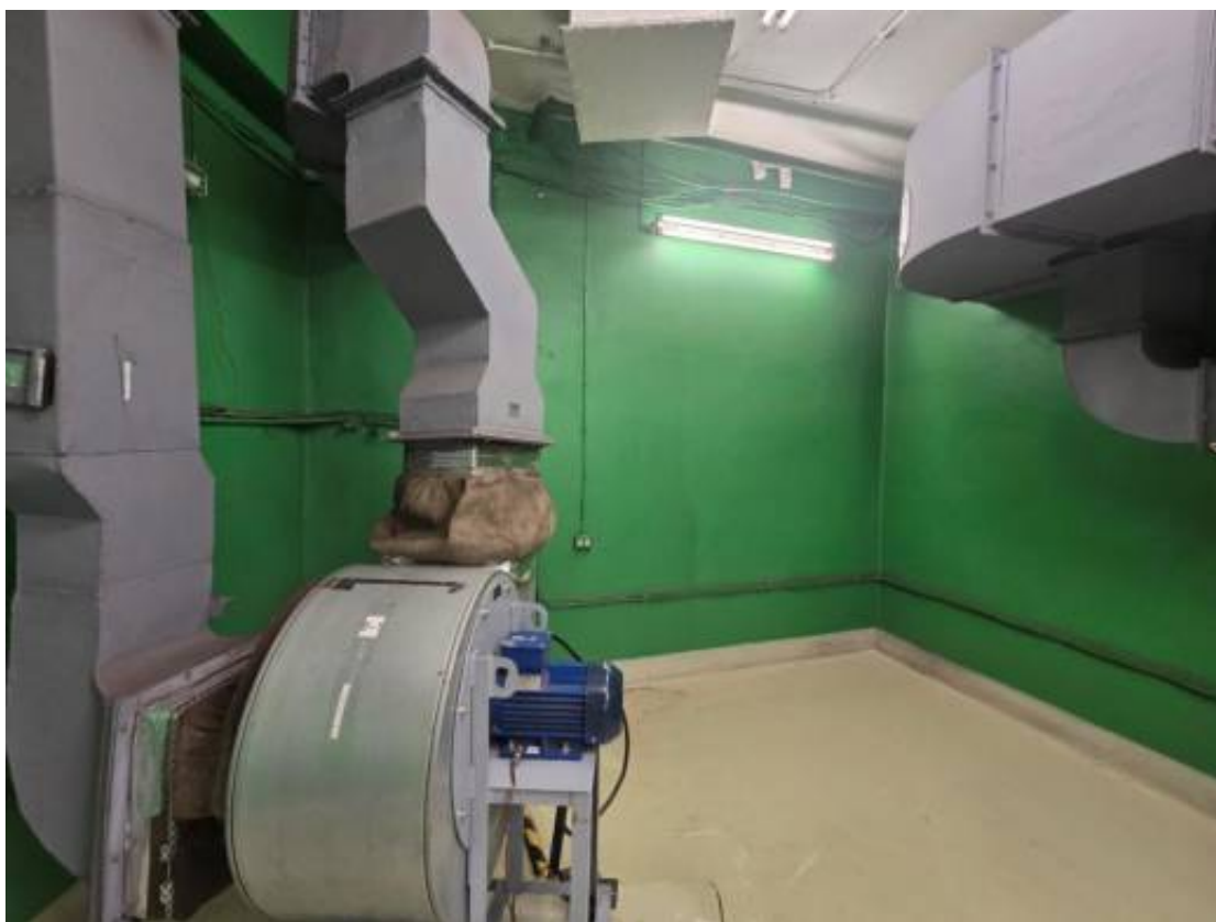
Фото п.4. Подвал, помещение 1-Н (49).
