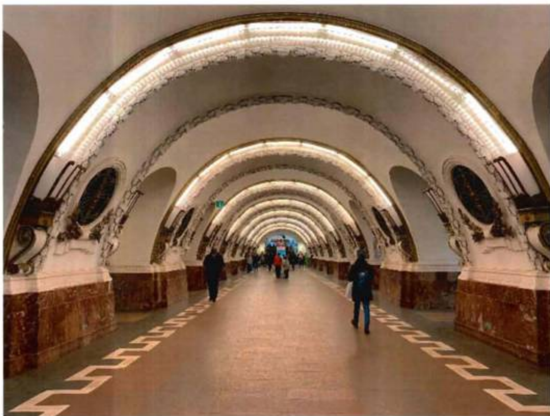
5. Общий вид перронного зала объекта культурного наследия.
