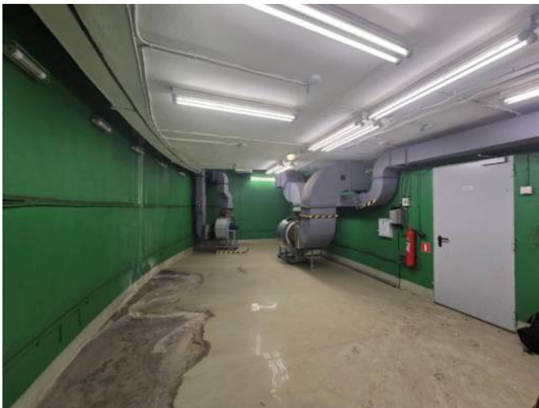
Фото п.3. Подвал, помещение 1-Н (49).
