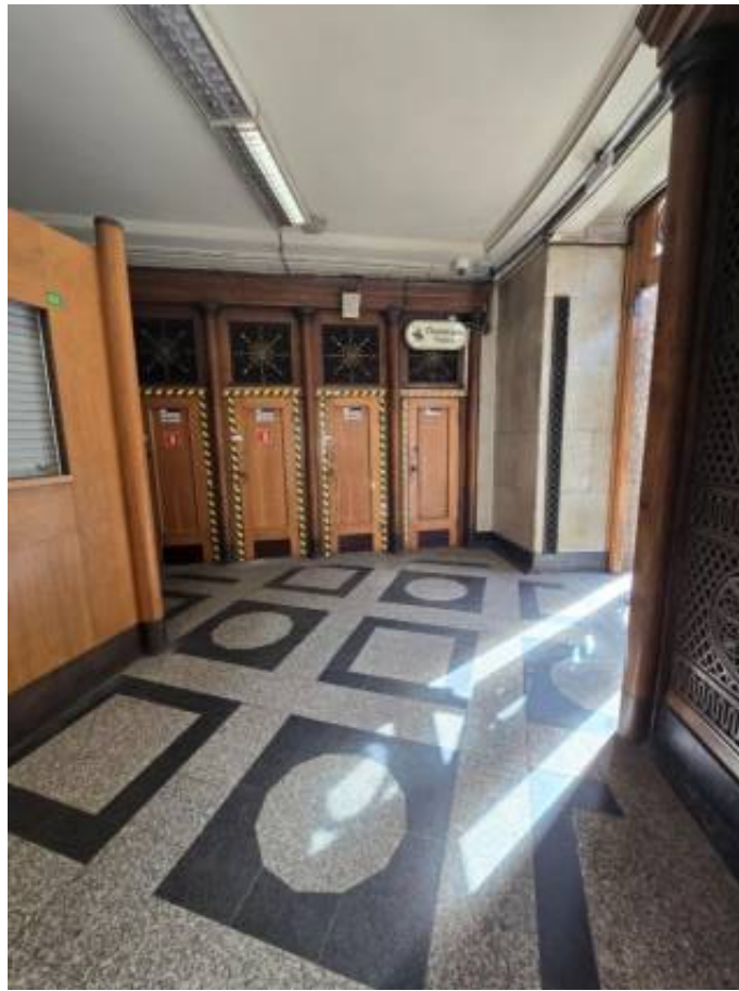
Фото 1.11. 1 этаж, тамбур выхода, помещение 1-Н (9).
