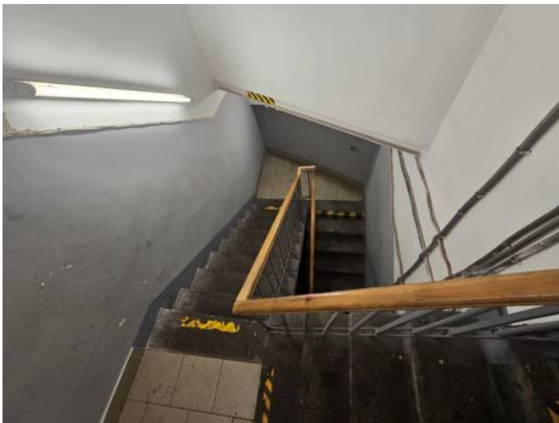
Фото 1.23. 1 этаж, лестница в подвал, помещение 1-Н (45).
