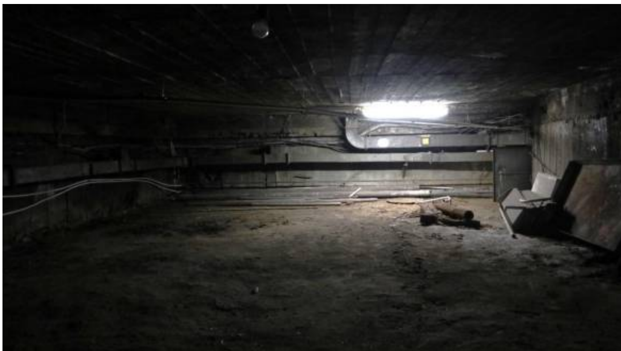
Фото тп.3. Техническое подполье.
