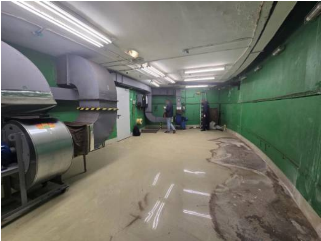
Фото п.5. Подвал, помещение 1-Н (49).
