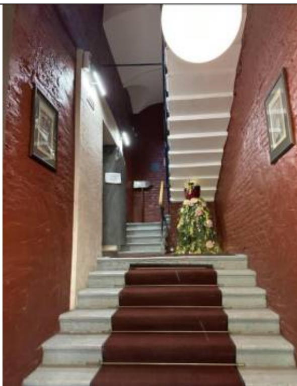
Фото 33. Фрагмент лестницы ЛК №1. Объект культурного наследия регионального значения «Особняк Дурново П.П.», расположенный по адресу: г. Санкт-Петербург, Адмиралтейский район, Галерная улица, дом 15, литера А.
