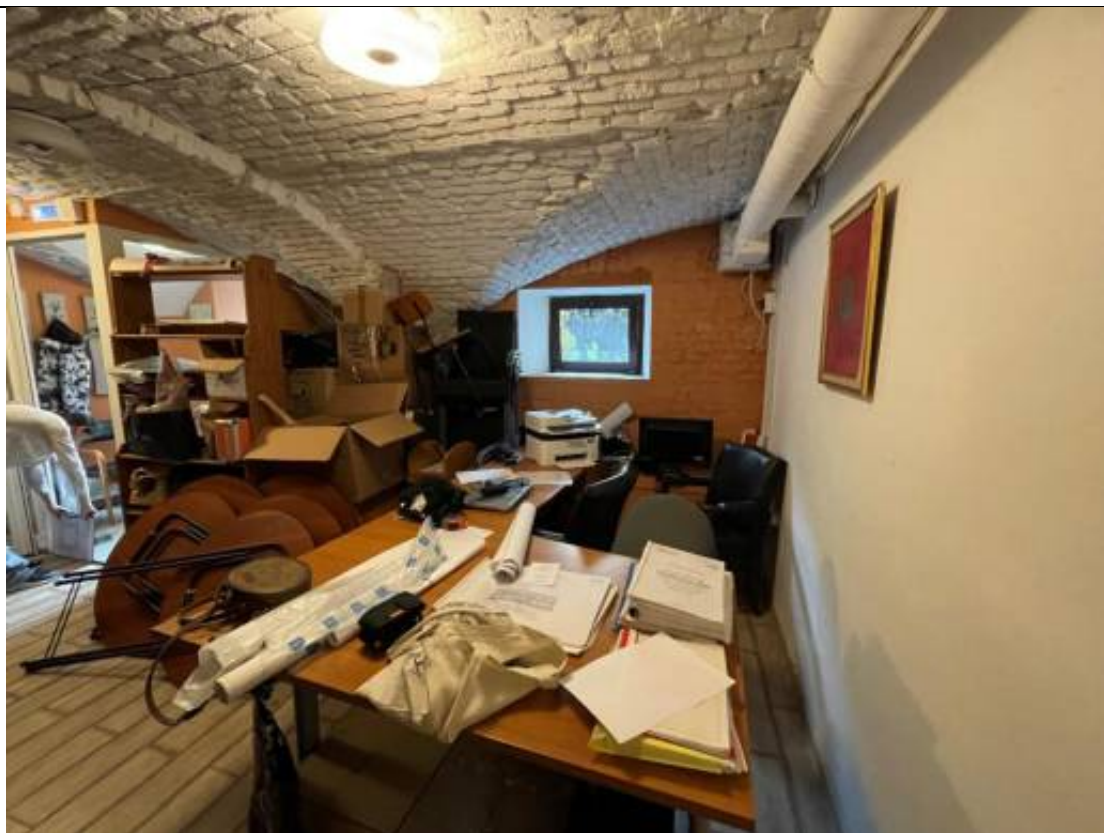
Фото 4. Цокольный этаж, помещение Ц02. Объект культурного наследия регионального значения «Особняк Дурново П.П.». расположенный по адресу: г. Санкт-Петербург, Адмиралтей-ский район, Галерная улица, дом 15, литера А.
