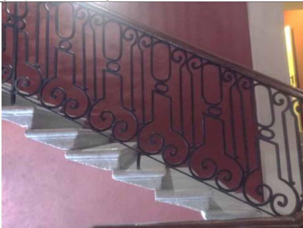
Фото 46. Фрагмент лестницы ЛК №4. Объект культурного наследия регионального значения «Особняк Дурново П.П.», расположенный по адресу: г. Санкт-Петербург, Адмиралтейский район, Галерная улица, дом 15, литера А.
