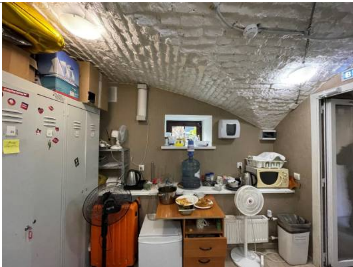
Фото 22. Цокольный этаж, помещение Ц10. Объект культурного наследия регионального значения «Особняк Дурново П.П.», расположенный по адресу: г. Санкт-Петербург, Адмиралтей-ский район, Галерная улица, дом 15, литера А.
