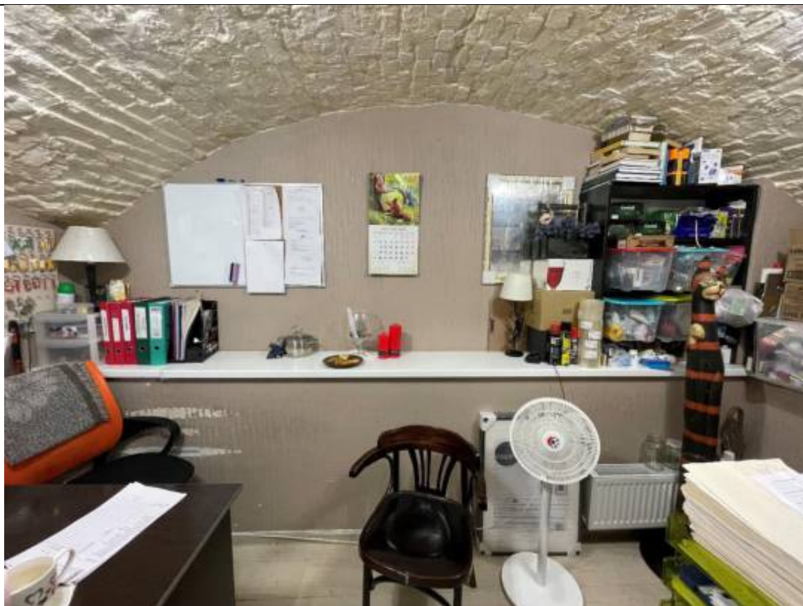
Фото 25. Цокольный этаж, помещение Ц09. Объект культурного наследия регионального значения «Особняк Дурново П.П.», расположенный по адресу: г. Санкт-Петербург, Адмиралтей-ский район, Галерная улица, дом 15, литера А.
