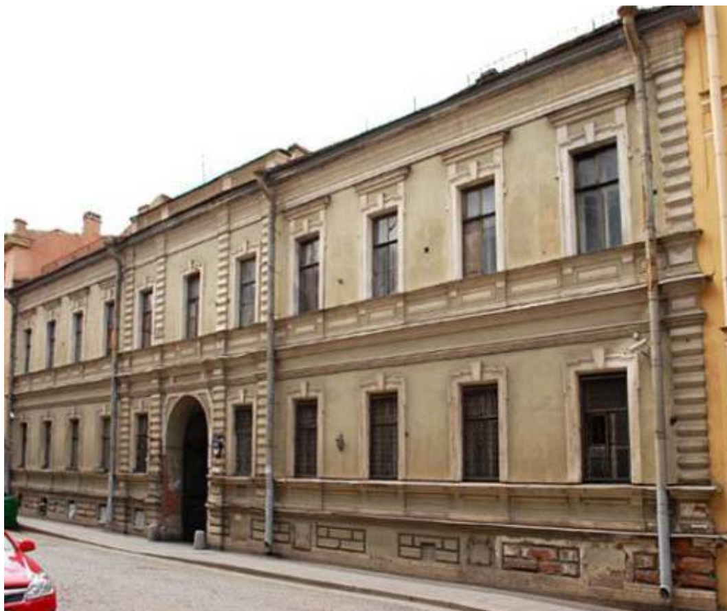
Илл.13. Особняк Дурново на Галерной улице д. 15, 2009 год. Источник: citywalls.ru
