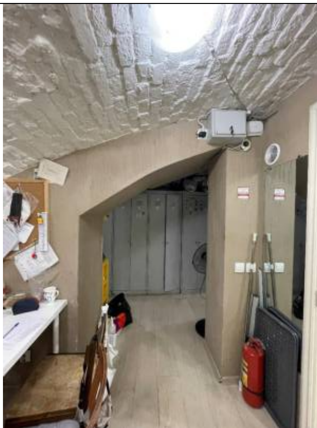
Фото 24. Цокольный этаж, помещение Ц08. Объект культурного наследия регионального значения «Особняк Дурново П.П.», расположенный по адресу: г. Санкт-Петербург, Адмиралтей-ский район, Галерная улица, дом 15, литера А.
