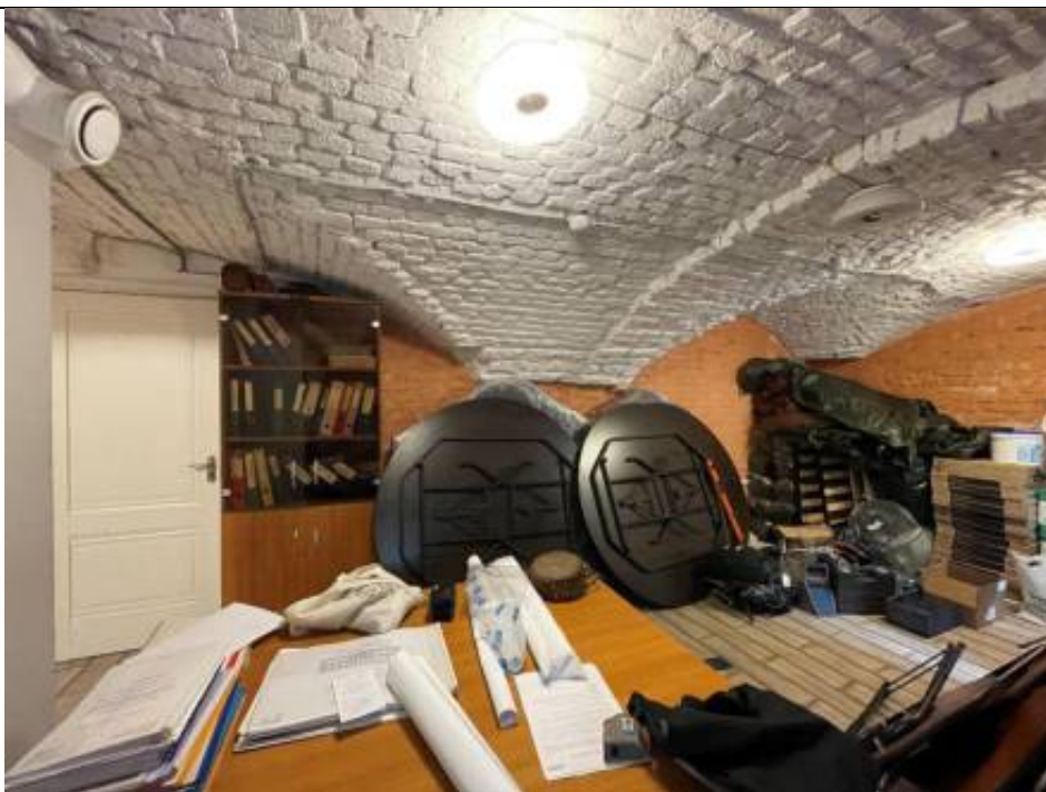
Фото 13. Цокольный этаж, помещение Ц02. Объект культурного наследия регионального значения «Особняк Дурново П.П.», расположенный по адресу: г. Санкт-Петербург, Адмиралтей-ский район, Галерная улица, дом 15, литера А.
