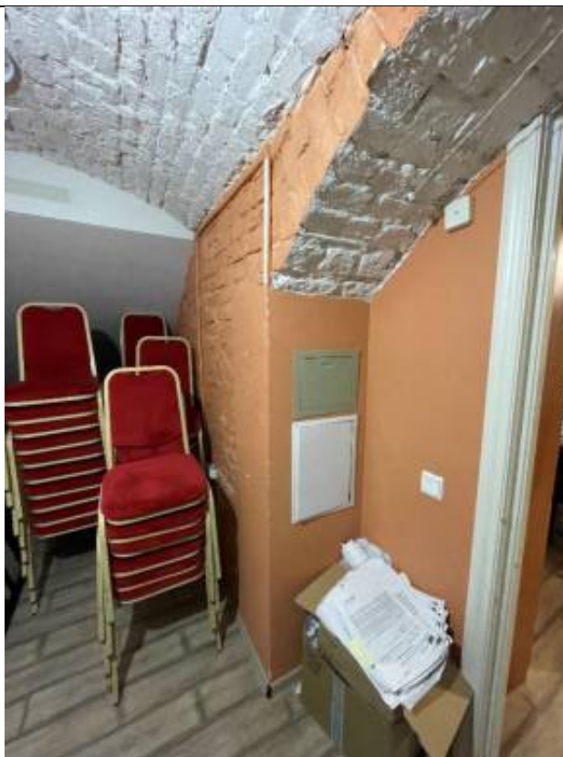
Фото 11. Цокольный этаж, помещение Ц03. Объект культурного наследия регионального значения «Особняк Дурново П.П.», расположенный по адресу: г. Санкт-Петербург, Адмиралтей-ский район, Галерная улица, дом 15, литера А.
