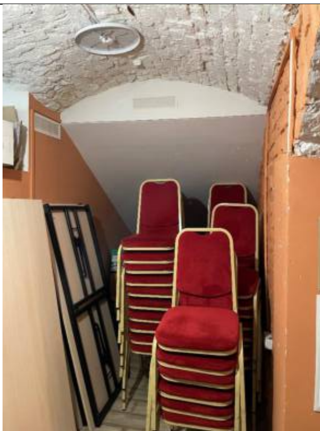
Фото 12. Цокольный этаж, помещение Ц03. Объект культурного наследия регионального значения «Особняк Дурново П.П.», расположенный по адресу: г. Санкт-Петербург, Адмиралтей-ский район, Галерная улица, дом 15, литера А.
