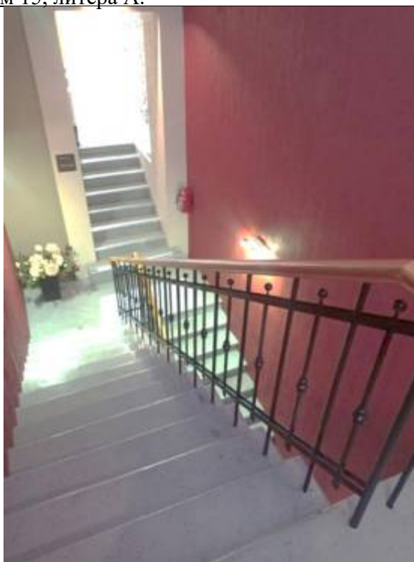
Фото 54. Фрагмент лестницы ЛК №3. Объект культурного наследия регионального значения «Особняк Дурново П.П.», расположенный по адресу: г. Санкт-Петербург, Адмиралтейский район, Галерная улица, дом 15, литера А.
