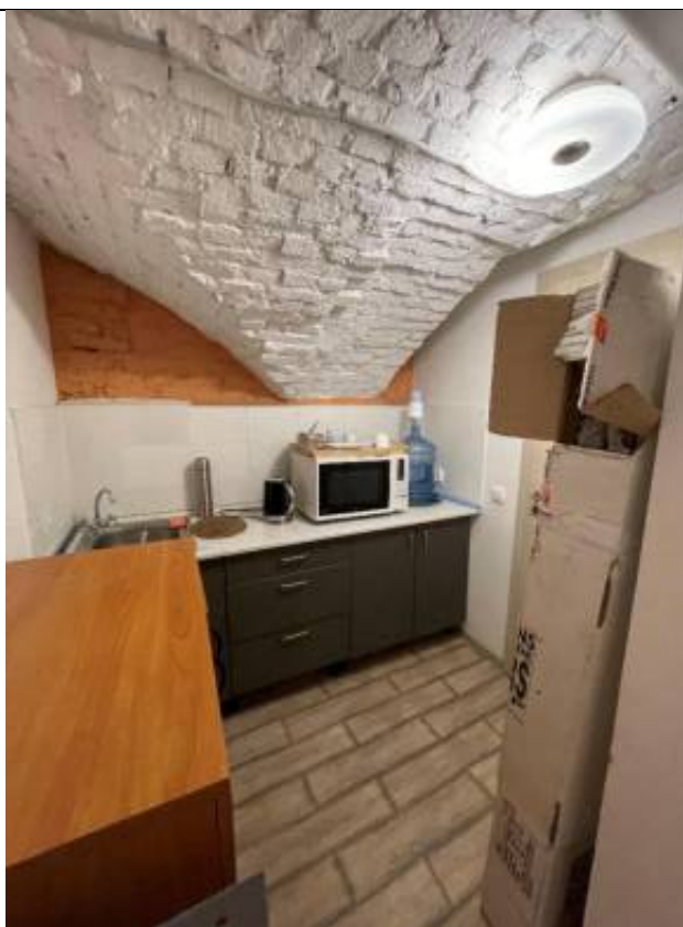
Фото 6. Цокольный этаж, помещение Ц02. Объект культурного наследия регионального значения «Особняк Дурново П.П.». расположенный по адресу: г. Санкт-Петербург, Адмиралтей-ский район, Галерная улица, дом 15, литера А.
