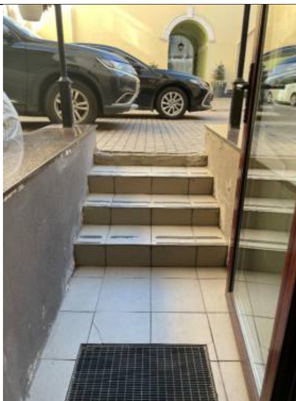
Фото 20. Цокольный этаж, помещение Ц06. Объект культурного наследия регионального значения «Особняк Дурново П.П.», расположенный по адресу: г. Санкт-Петербург, Адмиралтей-ский район, Галерная улица, дом 15, литера А
