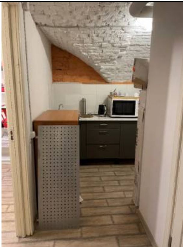
Фото 5. Цокольный этаж, помещение Ц02. Объект культурного наследия регионального значения «Особняк Дурново П.П.». расположенный по адресу: г. Санкт-Петербург, Адмиралтей-ский район, Галерная улица, дом 15, литера А.
