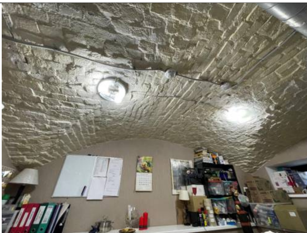
Фото 26. Цокольный этаж, помещение Ц09. Объект культурного наследия регионального значения «Особняк Дурново П.П.», расположенный по адресу: г. Санкт-Петербург, Адмиралтей-ский район, Галерная улица, дом 15, литера А.
