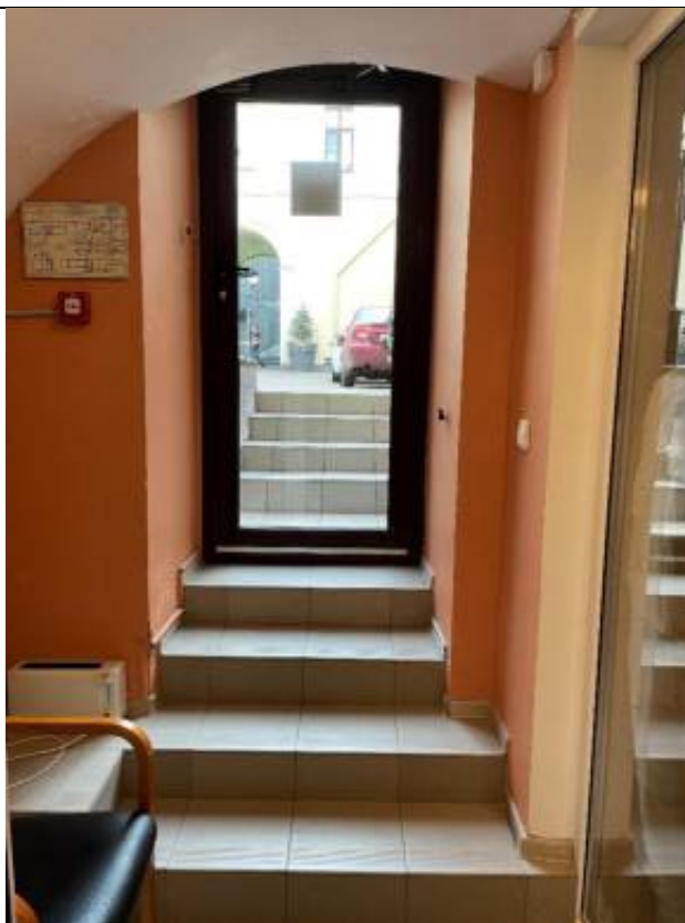
Фото 15. Цокольный этаж. Объект культурного наследия регионального значения «Особняк Дурново П.П.». расположенный по адресу: г. Санкт-Петербург, Адмиралтейский район, Галерная улица, дом 15, литера А.
