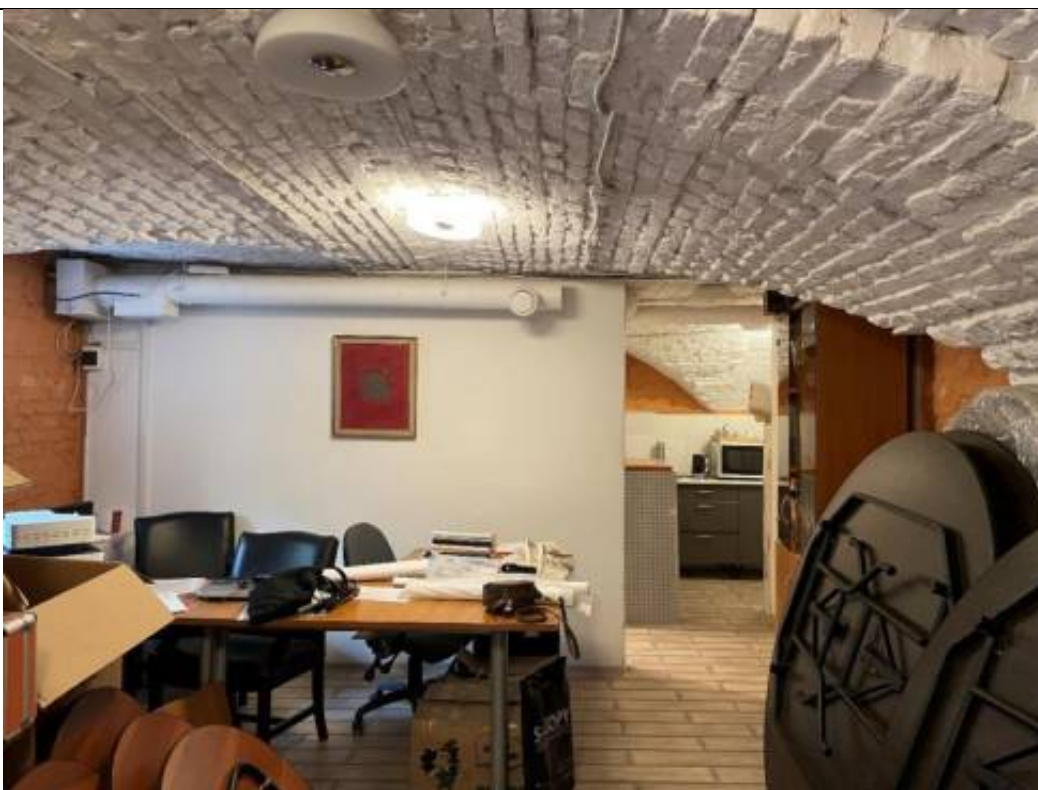
Фото 2. Цокольный этаж, помещение Ц02. Объект культурного наследия регионального значения «Особняк Дурново П.П.». расположенный по адресу: г. Санкт-Петербург, Адмиралтей-ский район, Галерная улица, дом 15, литера А.
