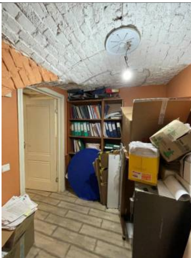
Фото 10. Цокольный этаж, помещение Ц03. Объект культурного наследия регионального значения «Особняк Дурново П.П.». расположенный по адресу: г. Санкт-Петербург, Адмиралтей-ский район, Галерная улица, дом 15, литера А.
