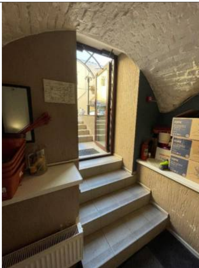
Фото 19. Цокольный этаж, помещение Ц06. Объект культурного наследия регионального значения «Особняк Дурново П.П.», расположенный по адресу: г. Санкт-Петербург, Адмиралтей-ский район, Галерная улица, дом 15, литера А.
