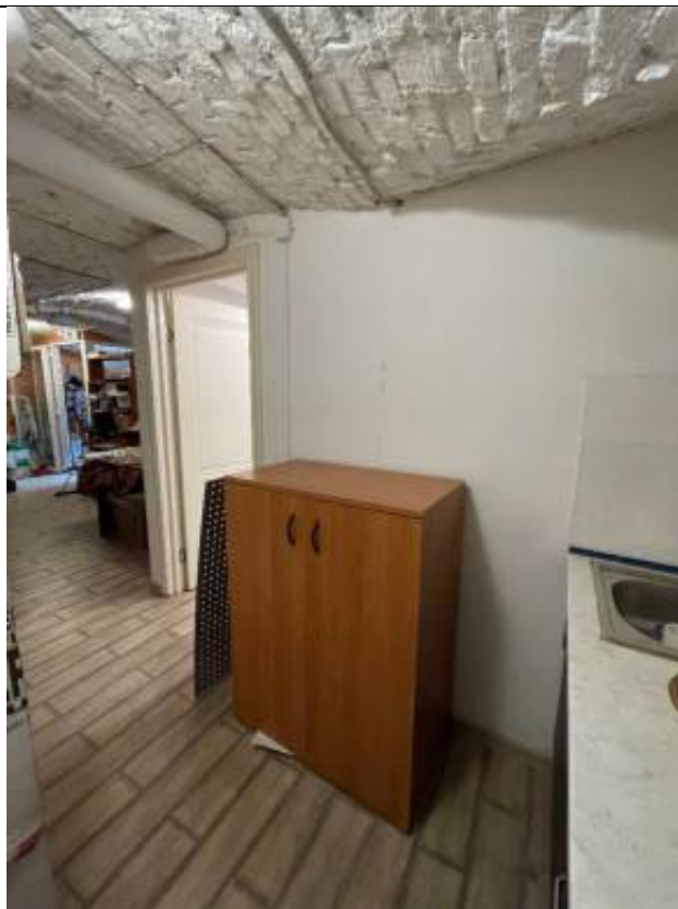
Фото 8. Цокольный этаж, помещение Ц02. Объект культурного наследия регионального значения «Особняк Дурново П.П.», расположенный по адресу: г. Санкт-Петербург, Адмиралтей-ский район, Галерная улица, дом 15, литера А.
