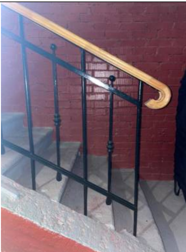
Фото 32. Цокольный этаж, фрагмент лестницы. Объект культурного наследия регионального значения «Особняк Дурново П.П.». расположенный по адресу: г. Санкт-Петербург, Адмиралтейский район, Галерная улица, дом 15, литера А.
