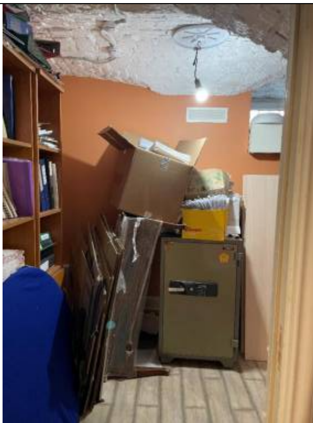
Фото 9. Цокольный этаж, помещение Ц03. Объект культурного наследия регионального значения «Особняк Дурново П.П.». расположенный по адресу: г. Санкт-Петербург, Адмиралтей-ский район, Галерная улица, дом 15, литера А.
