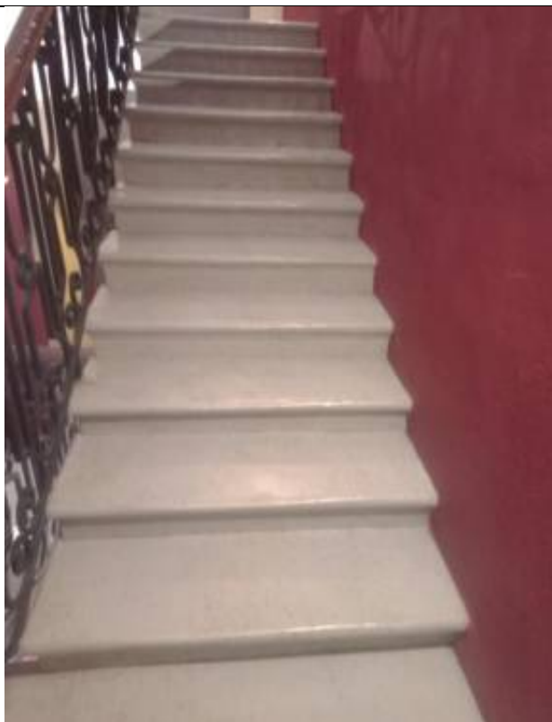
Фото 41. Фрагмент лестницы ЛК №4. Объект культурного наследия регионального значения «Особняк Дурново П.П.», расположенный по адресу: г. Санкт-Петербург, Адмиралтейский район, Галерная улица, дом 15, литера А.
