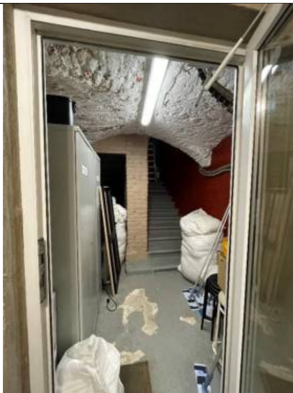
Фото 29. Цокольный этаж, помещение Ц08. Объект культурного наследия регионального значения «Особняк Дурново П.П.». расположенный по адресу: г. Санкт-Петербург, Адмиралтей-ский район, Галерная улица, дом 15, литера А.
