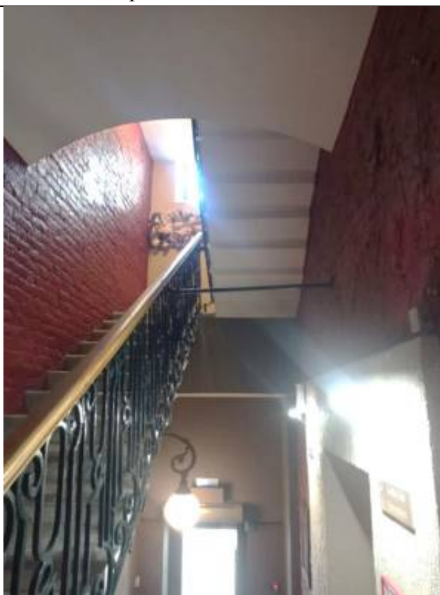
Фото 34. Фрагмент лестницы ЛК №1. Объект культурного наследия регионального значения «Особняк Дурново П.П.», расположенный по адресу: г. Санкт-Петербург, Адмиралтейский район, Галерная улица, дом 15, литера А.
