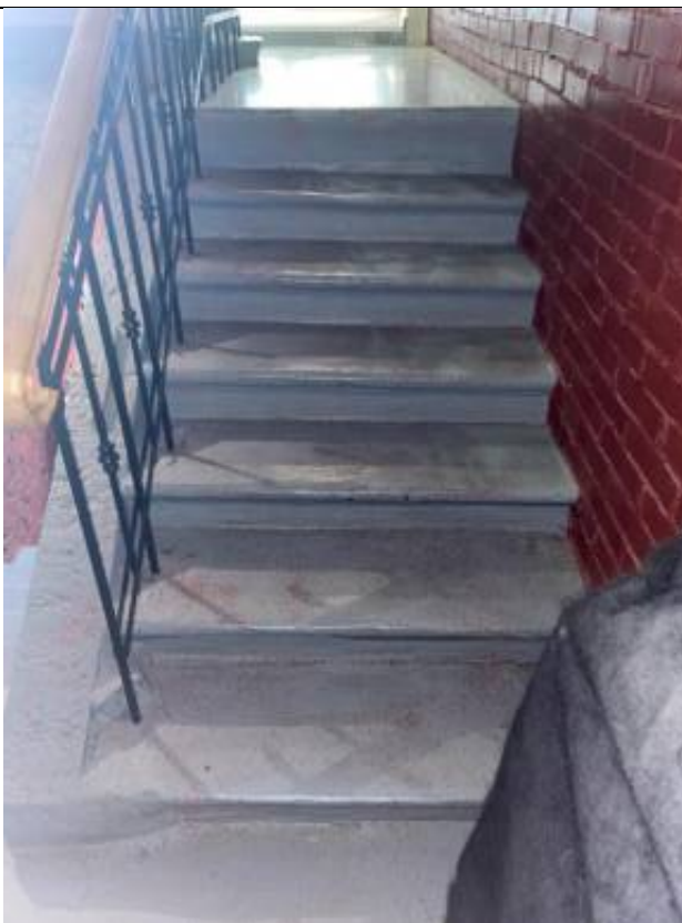
Фото 31. Цокольный этаж, фрагмент лестницы. Объект культурного наследия регионального значения «Особняк Дурново П.П.». расположенный по адресу: г. Санкт-Петербург, Адмиралтейский район, Галерная улица, дом 15, литера А.
