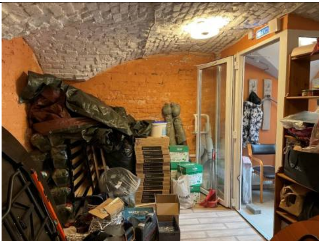
Фото 1. Цокольный этаж, помещение Ц02. Объект культурного наследия регионального значения «Особняк Дурново П.П.». расположенный по адресу: г. Санкт-Петербург, Адмиралтей-ский район, Галерная улица, дом 15, литера А.
