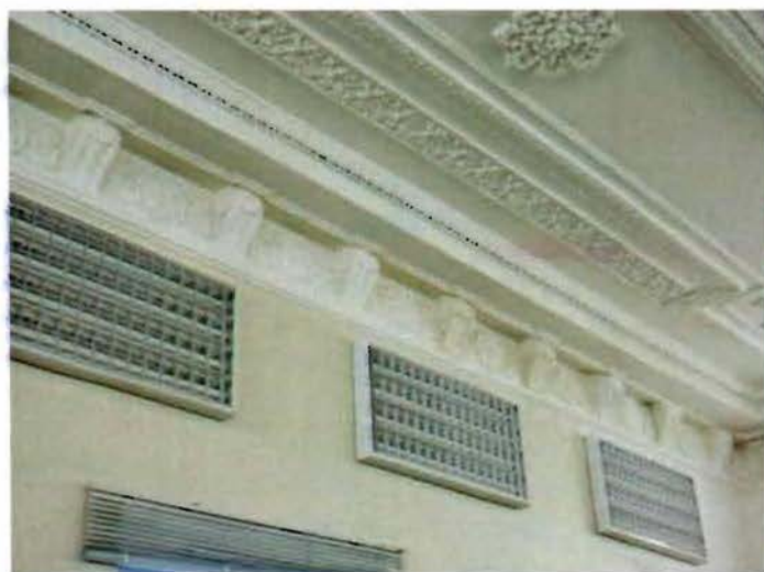
21. Лепной профилированный карниз
