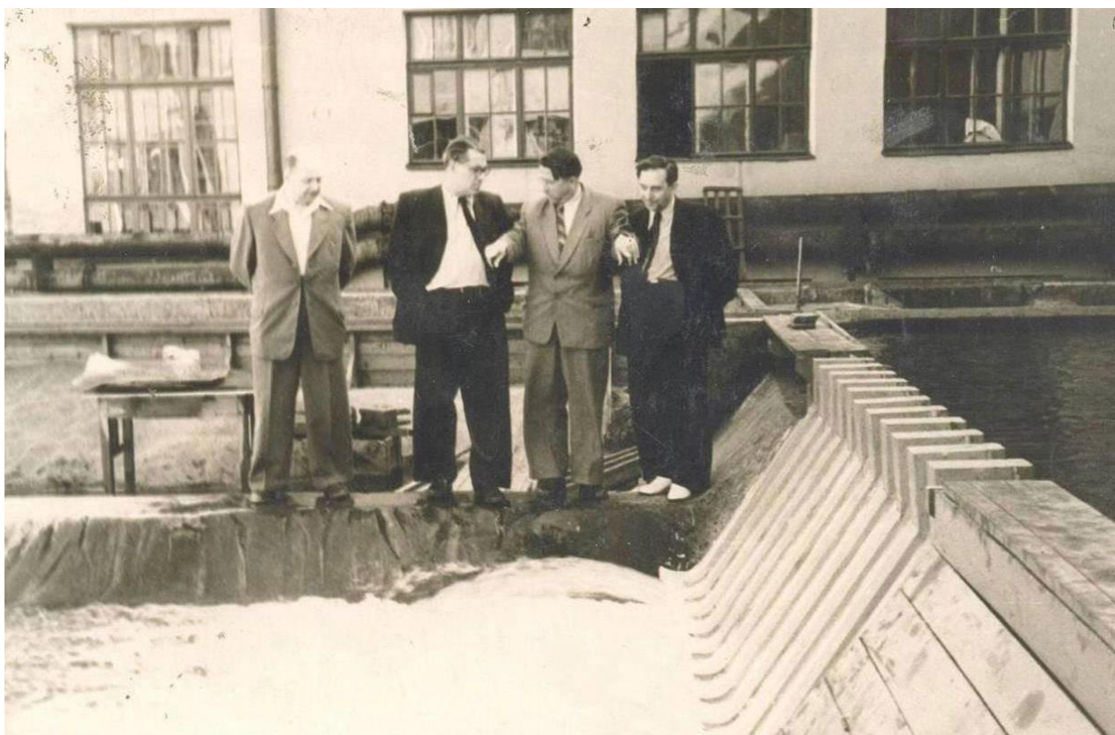
55. Проверка работы братской ГЭС по модели. Фото 1954-х гг. По материалам музея ОАО ВНИИГ им. Б.Е. Веденеева.
