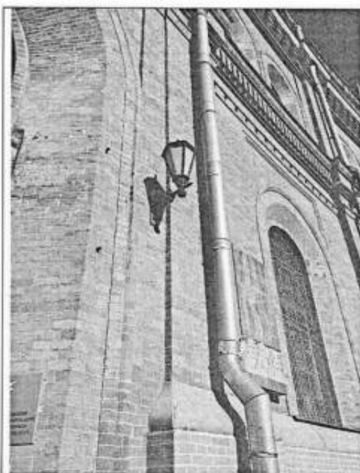
11. Вид на фрагмент фасада с фонарем
