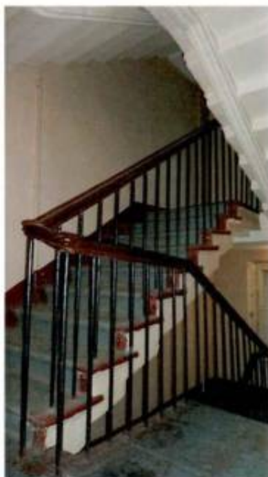
15. Служебная лестница в уровне второго этажа лицевого корпуса по Большой Пушкарской ул.
