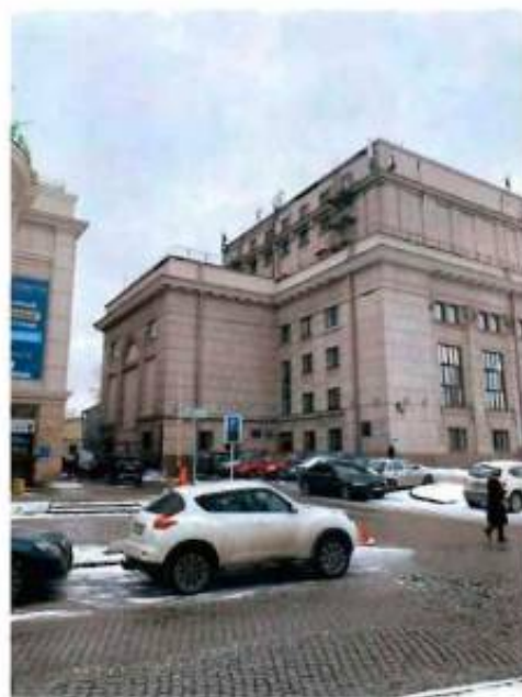
5. Фрагмент восточного фасада объекта культурного наследия.
