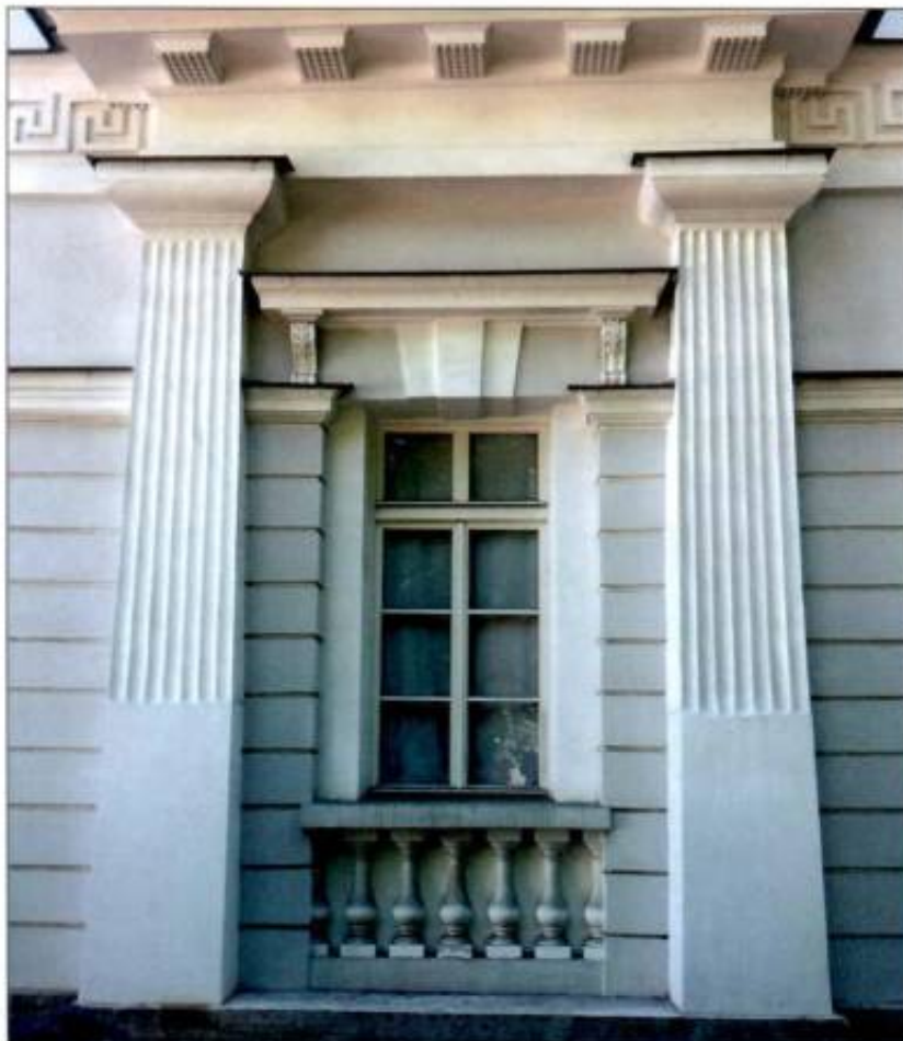
4. «корпус конюшенный». Вид с южной стороны, Фрагмент.
