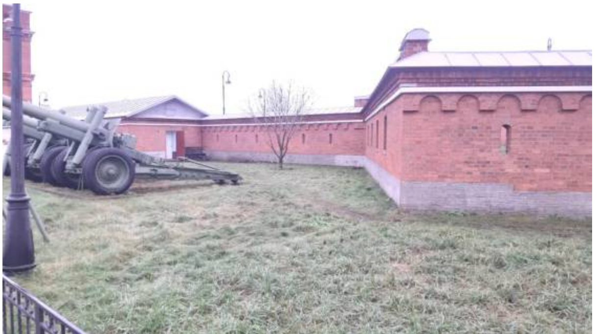
28. «Арсенал (в составе «Кронверк Петропавловской крепости»)). (Александровский парк, д. 7, лит. А). Дворовые фасады. Фото мест установки оборудования и прокладки кабельных трасс. Штиглиц М.С. 17.12.2025.
