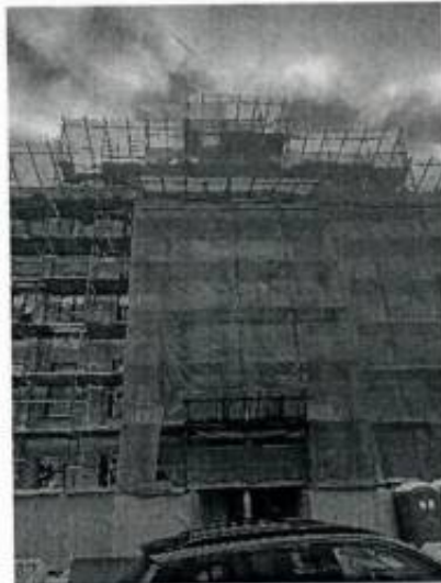
1. Фрагмент фасада со стороны ул. Введенская
