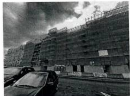
2. Фрагмент фасада со стороны ул. Введенская
