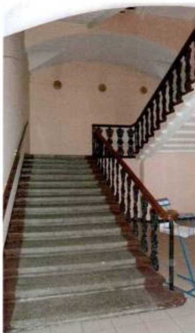
11. Парадная лестница в уровне первого этажа.
