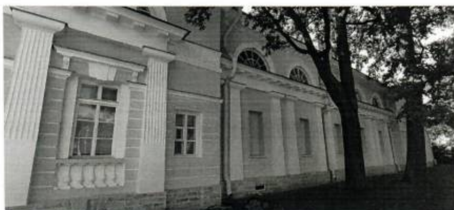
13. Восточный фасад. Фрагмент
