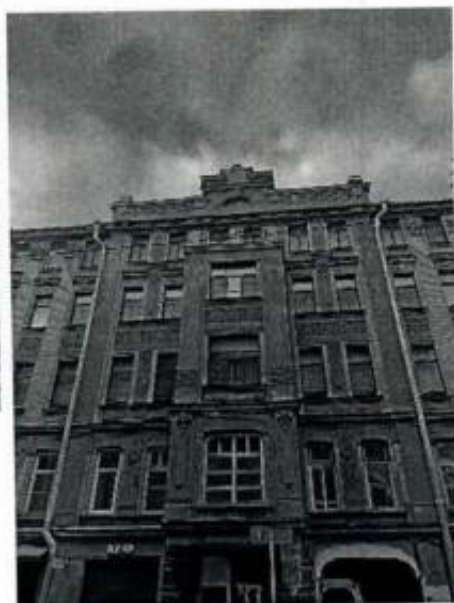
12. Фрагмент фасада со стороны ул. Лизы Чайкиной
