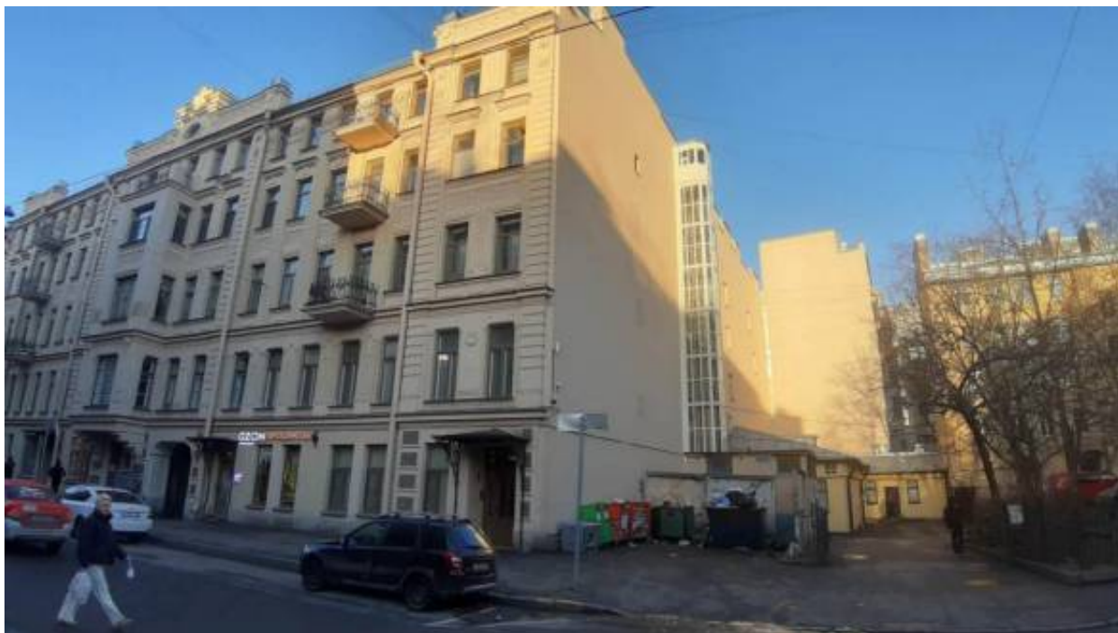
5. «Дом П.Н. Парусова» (Введенская ул., д. 19, лит. А). Лицевой фасад. Фото мест установки оборудования и прокладки кабельных трасс. Штиглиц М.С. 17.12.2025.
