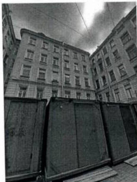
8. Фрагмент дворового фасада
