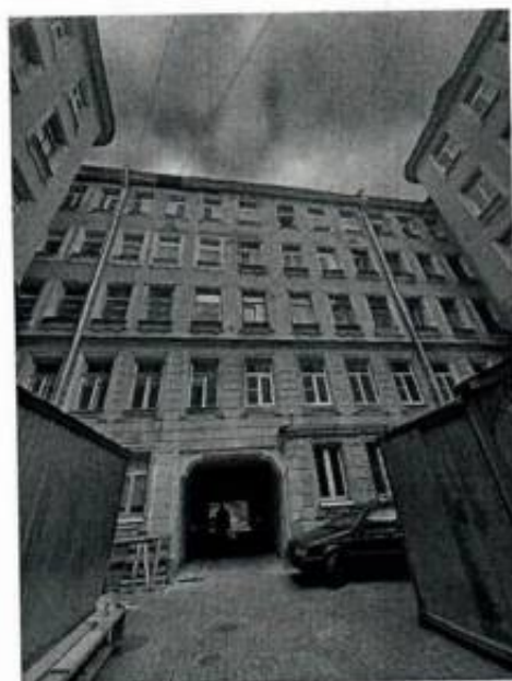
10. Фрагмент дворового фасада
