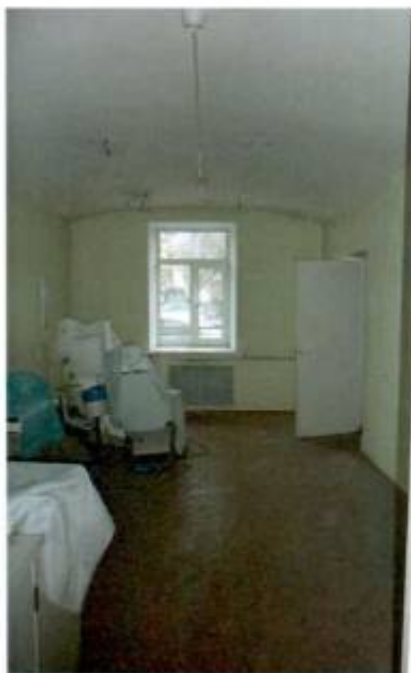
16. Помещение 1-Н (ч. п. 46). Сводчатые перекрытия.
