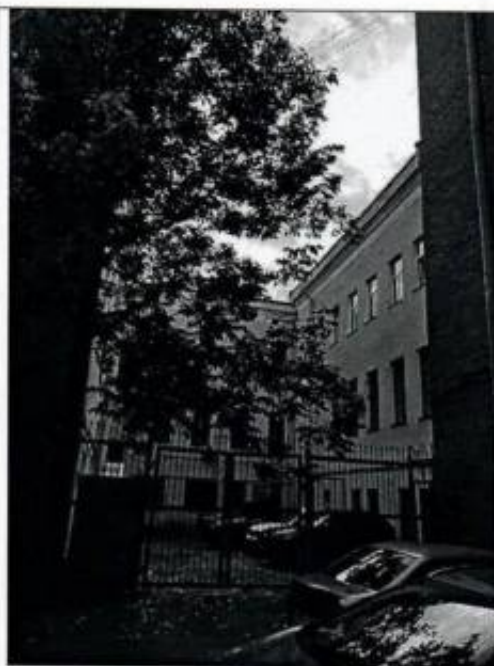
9. Вид на дворовую часть здания
