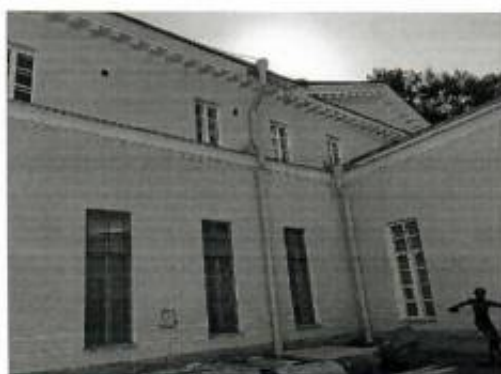
11. Фрагмент южного фасада полукруглого двора
