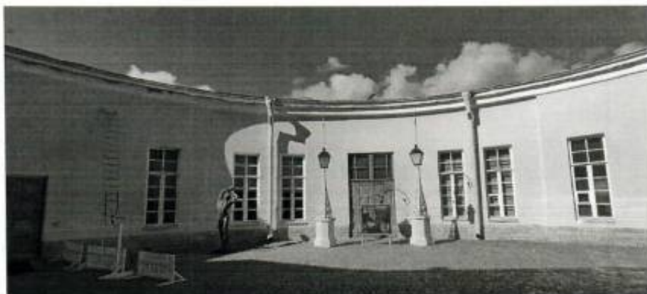
8. Северный фасад полукруглого двора
