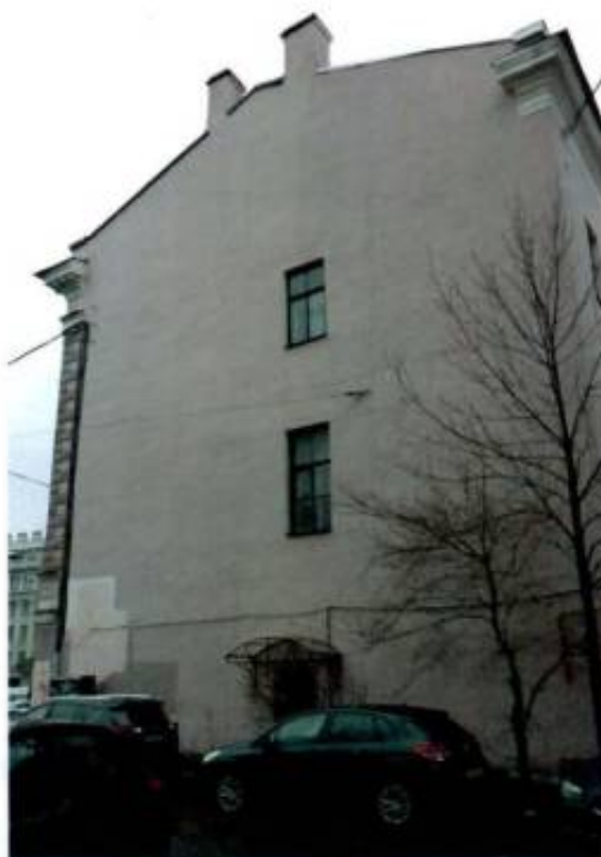
4. Северо-восточный фасад. Вид с севера.
