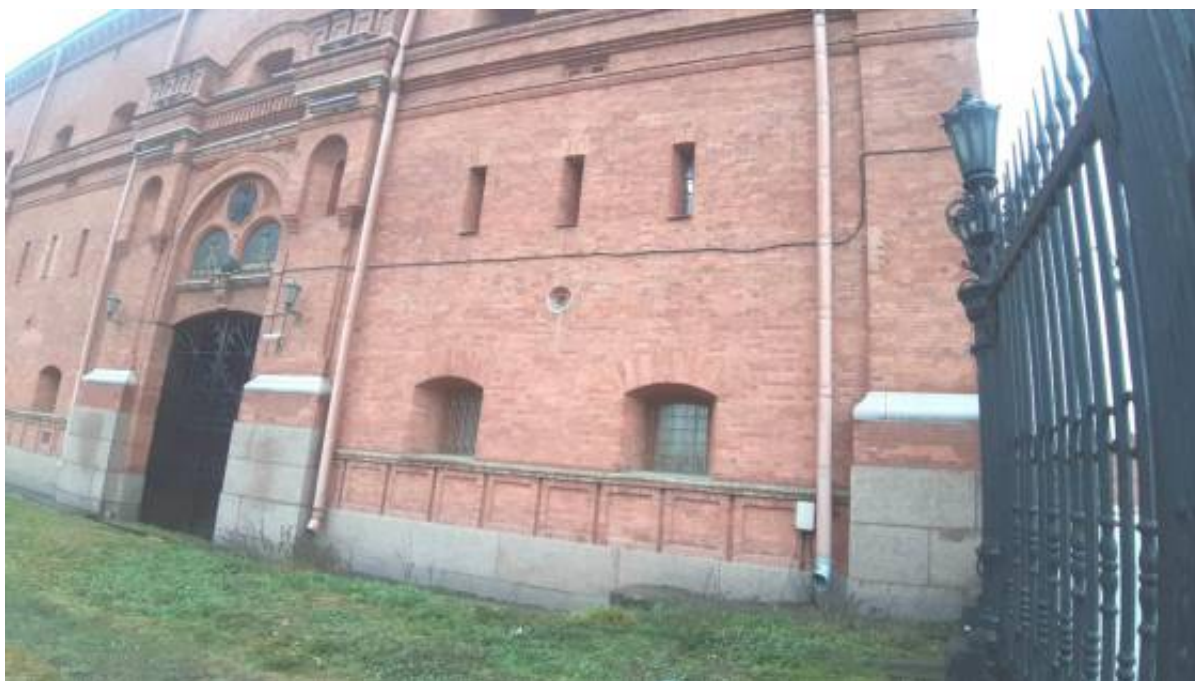
37. «Арсенал (в составе «Кронверк Петропавловской крепости»)». (Александровский парк, д. 7, лит. А). Дворовые фасады. Фото мест установки оборудования и прокладки кабельных трасс. Штиглиц М.С. 17.12.2025.
