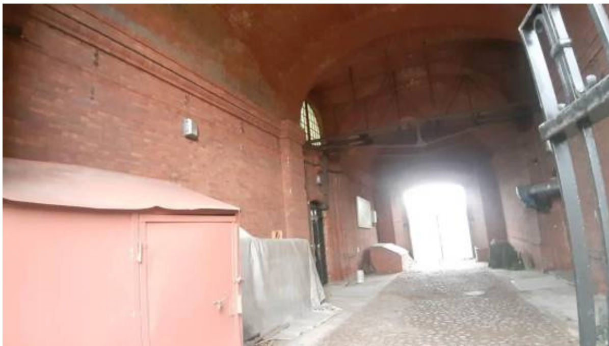
35. «Арсенал (в составе «Кронверк Петропавловской крепости»)). (Александровский парк, д. 7, лит. А). Арочный проезд. Фото мест установки оборудования и прокладки кабельных трасс. Штиглиц М.С. 17.12.2025.
