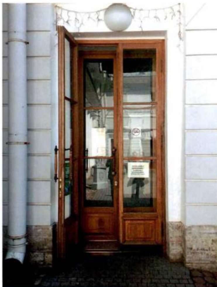
8. «корпус конюшенный». Дворовой фасад. Фрагмент.
