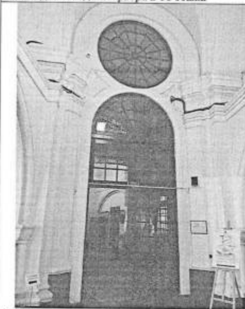
57. Вид на арочный проем 1-го этажа
