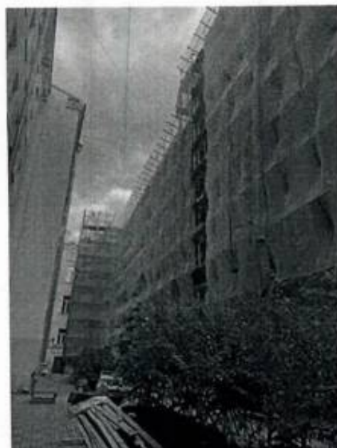
6. Фрагмент дворового фасада
