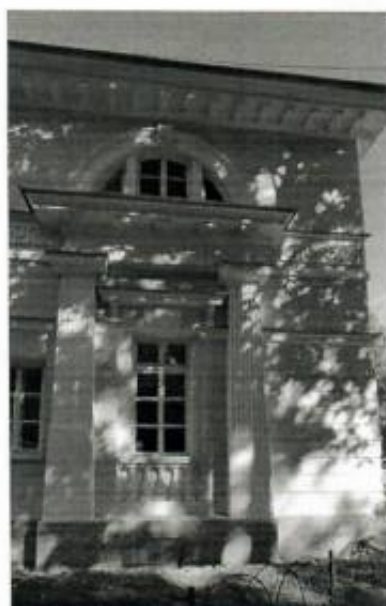
4. Западный фасад. Фрагмент.
