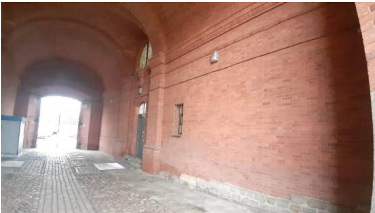
31. «Арсенал (в составе «Кронверк Петропавловской крепости»)). (Александровский парк, д. 7, лит. А). Арочный проезд. Фото мест установки оборудования и прокладки кабельных трасс. Штиглиц М.С. 17.12.2025.
