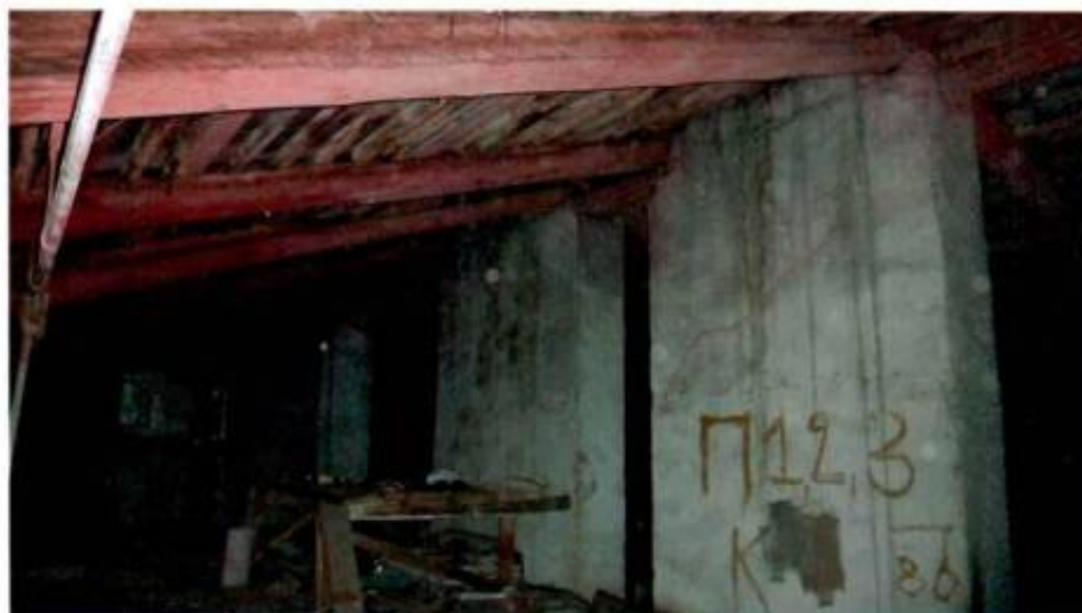
10. Стропильная система. Чердак.
