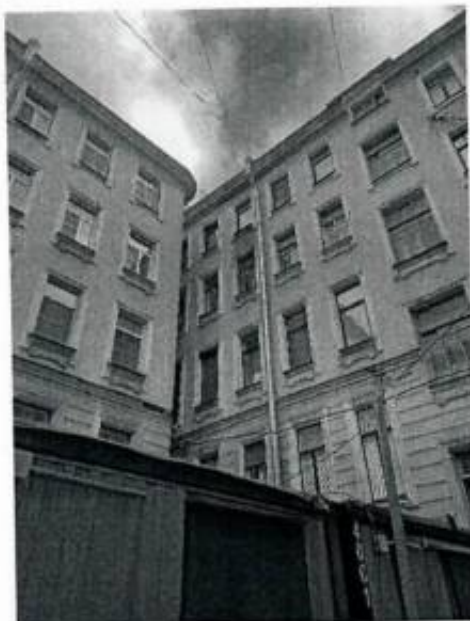
9. Фрагмент дворового фасада
