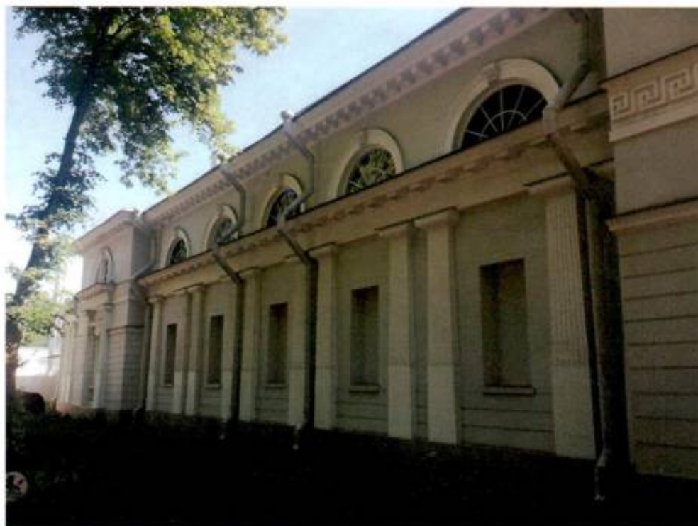
2. «корпус конюшенный». Вид с западной стороны.
