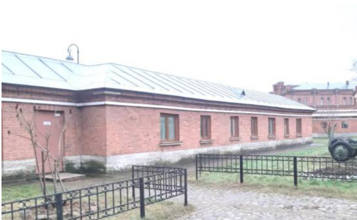
30. «Арсенал (в составе «Кронверк Петропавловской крепости»)). (Александровский парк, д. 7, лит. А). Дворовые фасады. Фото мест установки оборудования и прокладки кабельных трасс. Штиглиц М.С. 17.12.2025.
