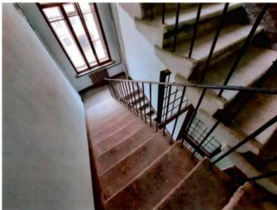
15. Интерьеры объекта культурного наследия. Лестница 3ЛК
