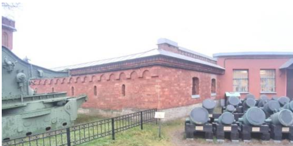
32. «Арсенал (в составе «Кронверк Петропавловской крепости»)). (Александровский парк, д. 7, лит. А). Дворовые фасады. Фото мест установки оборудования и прокладки кабельных трасс. Штиглиц М.С. 17.12.2025.
