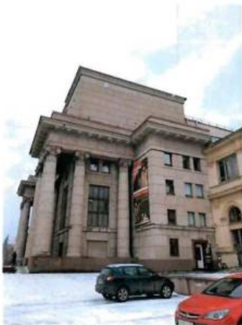
2. Западный фасад объекта культурного наследия.
