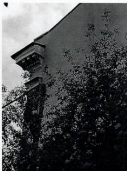
5. Вид на фрагмент фасада с карнизом
