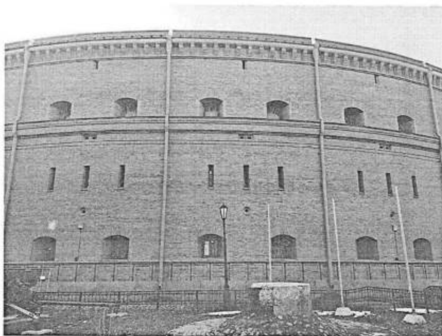
15. Общий вид на фасад с северной стороны
