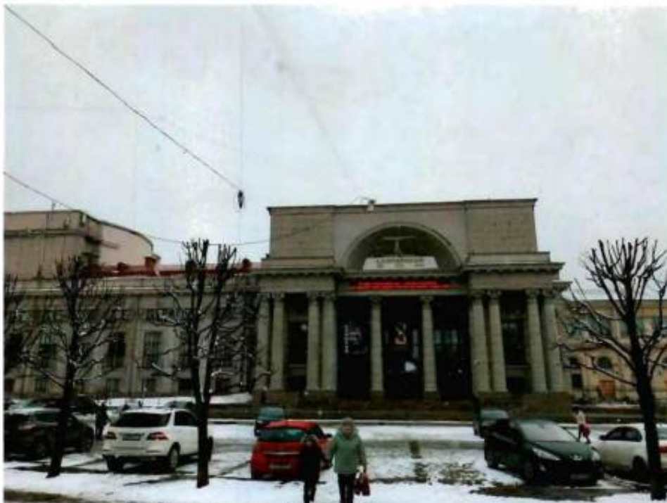
1. Фрагмент северного фасада объекта культурного наследия.
