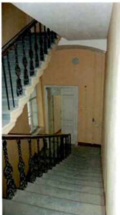
14. Служебная лестница в уровне второго этажа лицевого корпуса по Введенской ул.
