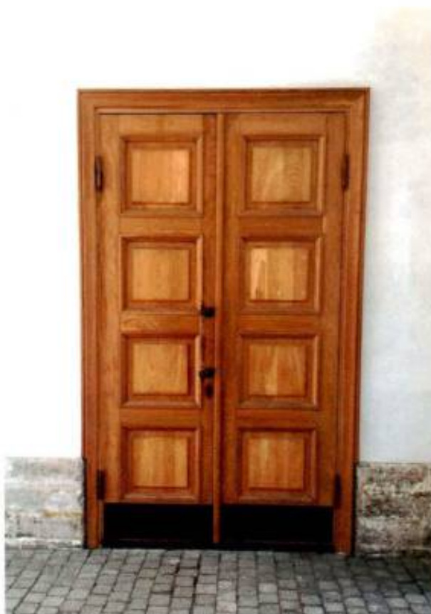
7. «корпус конюшенный». Дворовой фасад. Фрагмент.
