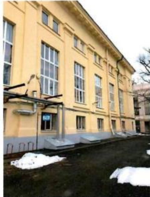
7. Фрагмент южного фасада объекта объекта культурного наследия.
