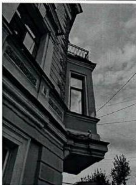
4. Фрагмент лицевого фасада с эркером
