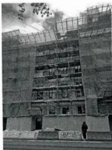
3. Фрагмент фасада со стороны ул. Введенская
