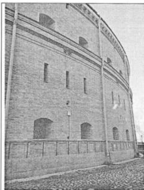
16. Вид на фрагмент фасада с восточной стороны
