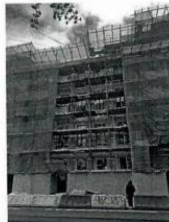
4. Фрагмент фасада со стороны ул. Введенская
