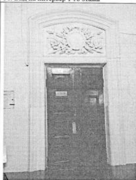
58. Вид на дверной проем 1-го этажа
