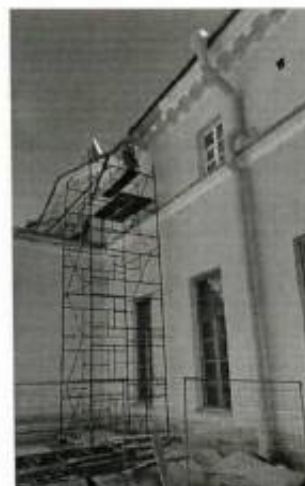
10. Фрагмент южного фасада полукруглого двора
