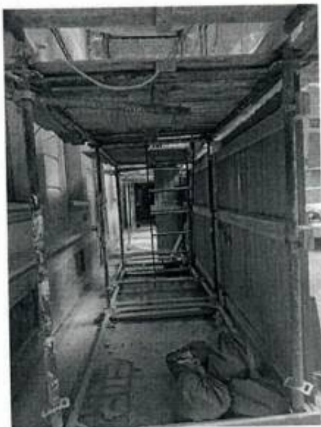
7. Фрагмент дворового фасада
