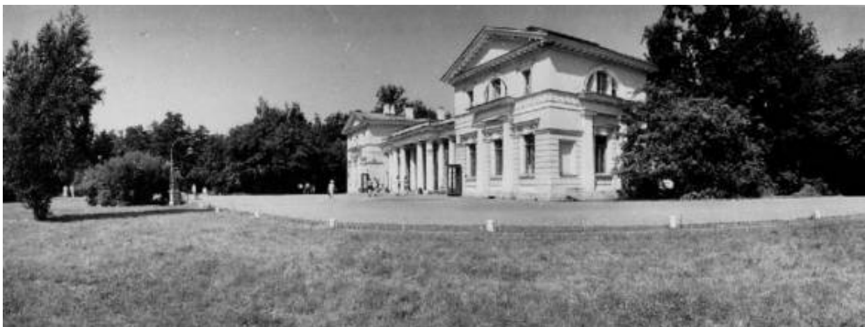
27. «Корпус конюшенный» (в составе «Ансамбль Елагина острова») (Елагин остров, д 4, лит. Д). Общий вид с юго-востока. 1973 г. Архив КГИОП. Паспорт 98-3_83 П. «Конюшенный корпус Елагина дворца».
