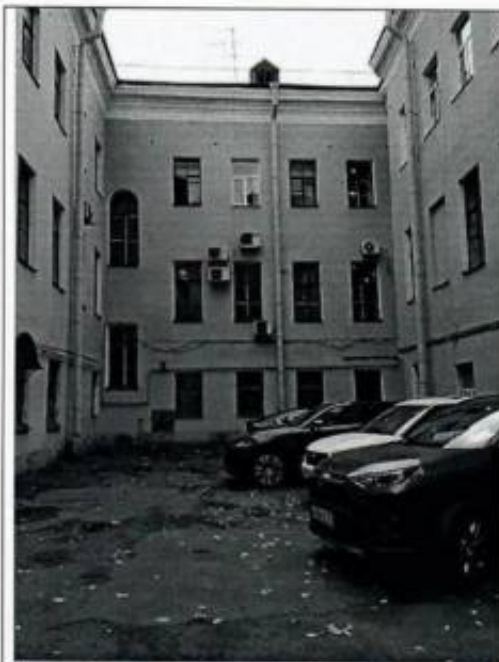
13. Вид на дворовые фасады
