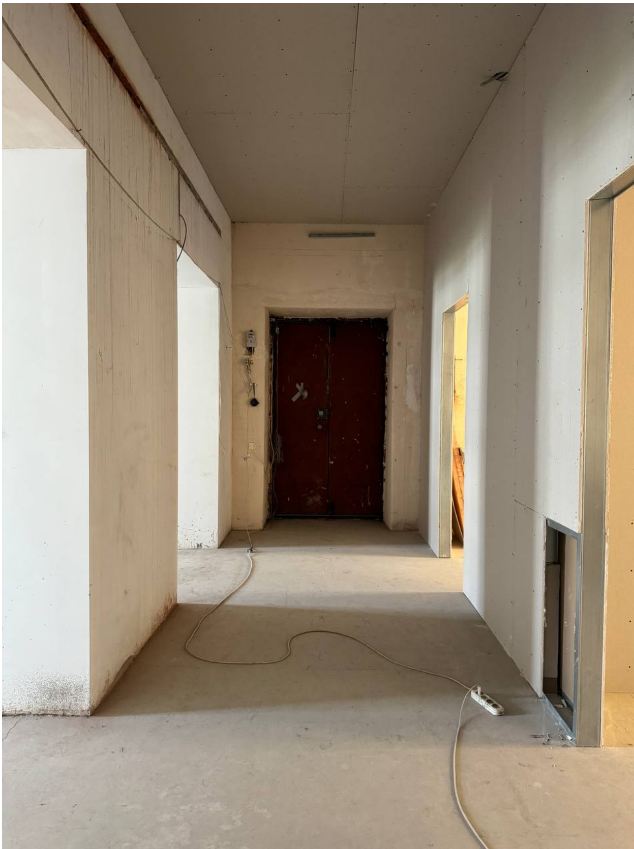
3. Помещение 1. Дата съемки: 04.06.2026.
