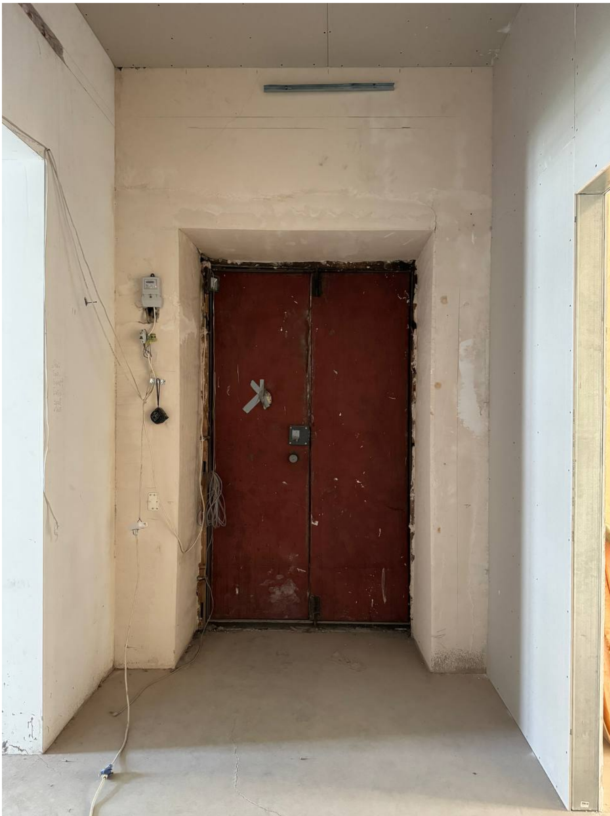
2. Помещение 1. Дата съемки: 04.06.2026.
