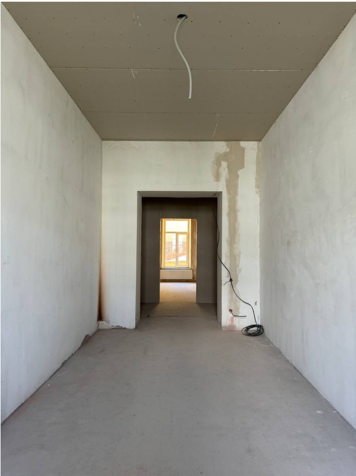
18. Помещение 9. Дата съемки: 04.06.2026.
