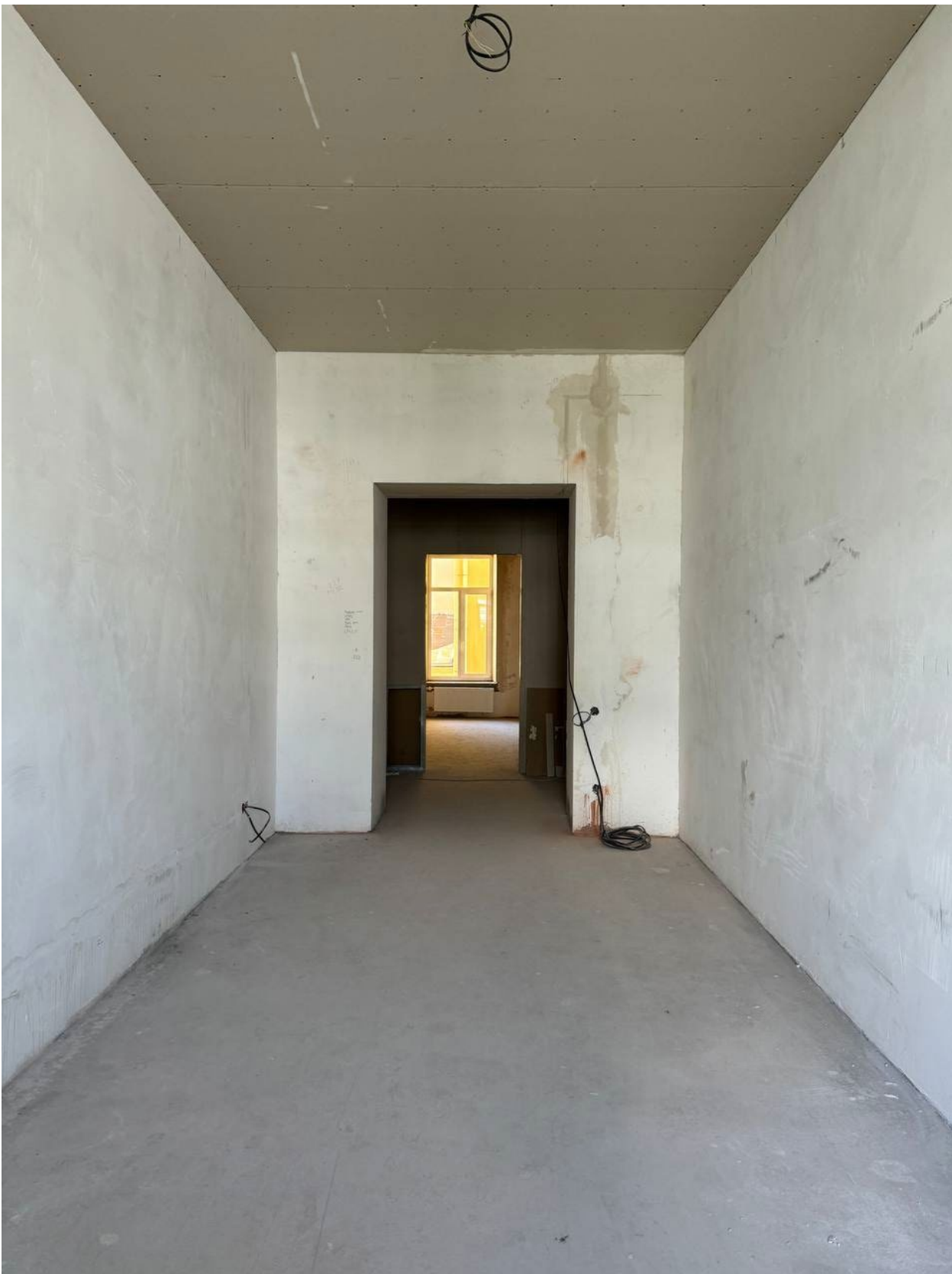
16. Помещение 8. Дата съемки: 04.06.2026.
