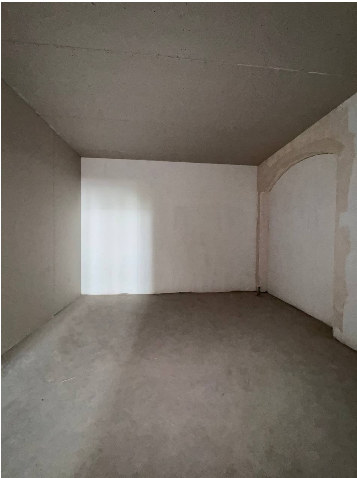
10. Помещение 4. Дата съемки: 04.06.2026.
