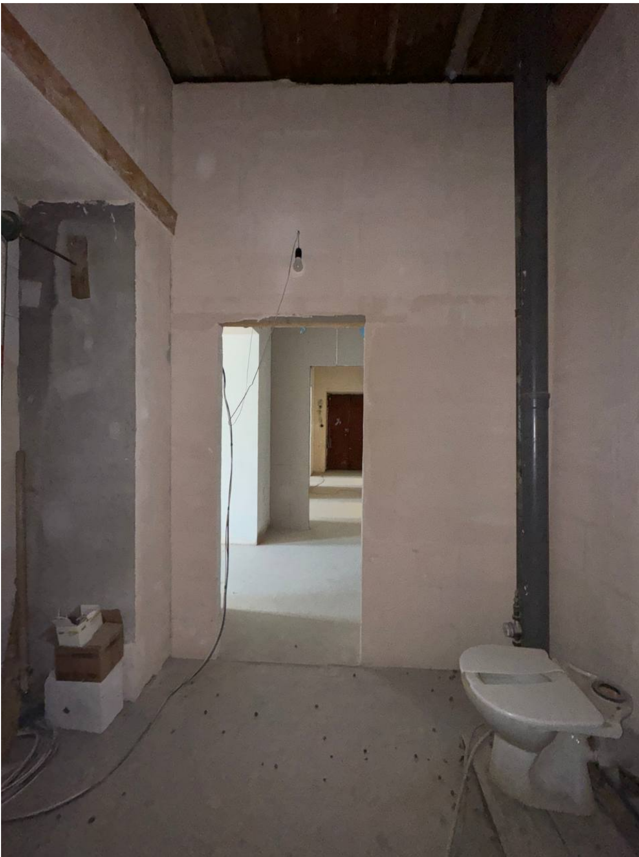
12. Помещение 5. Дата съемки: 04.06.2026
