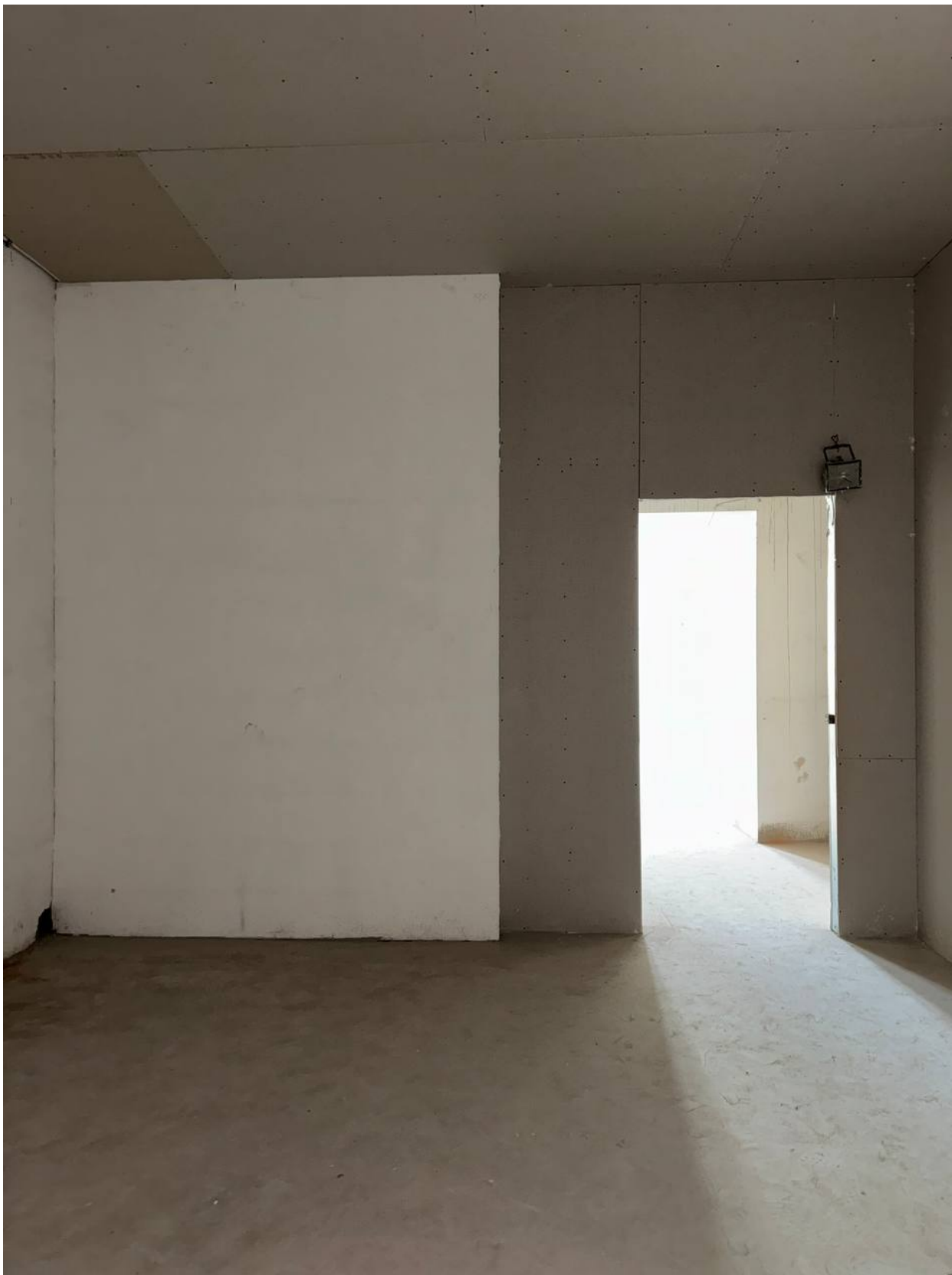
9. Помещение 4. Дата съемки: 04.06.2026.
