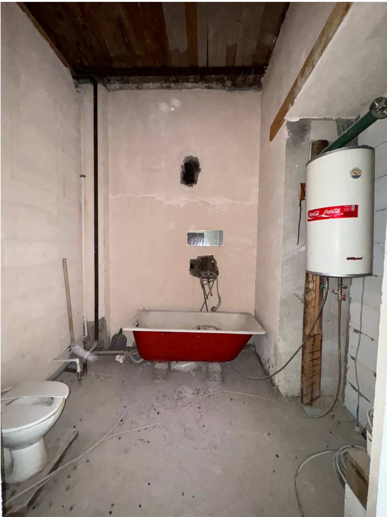
11. Помещение 5. Дата съемки: 04.06.2026
