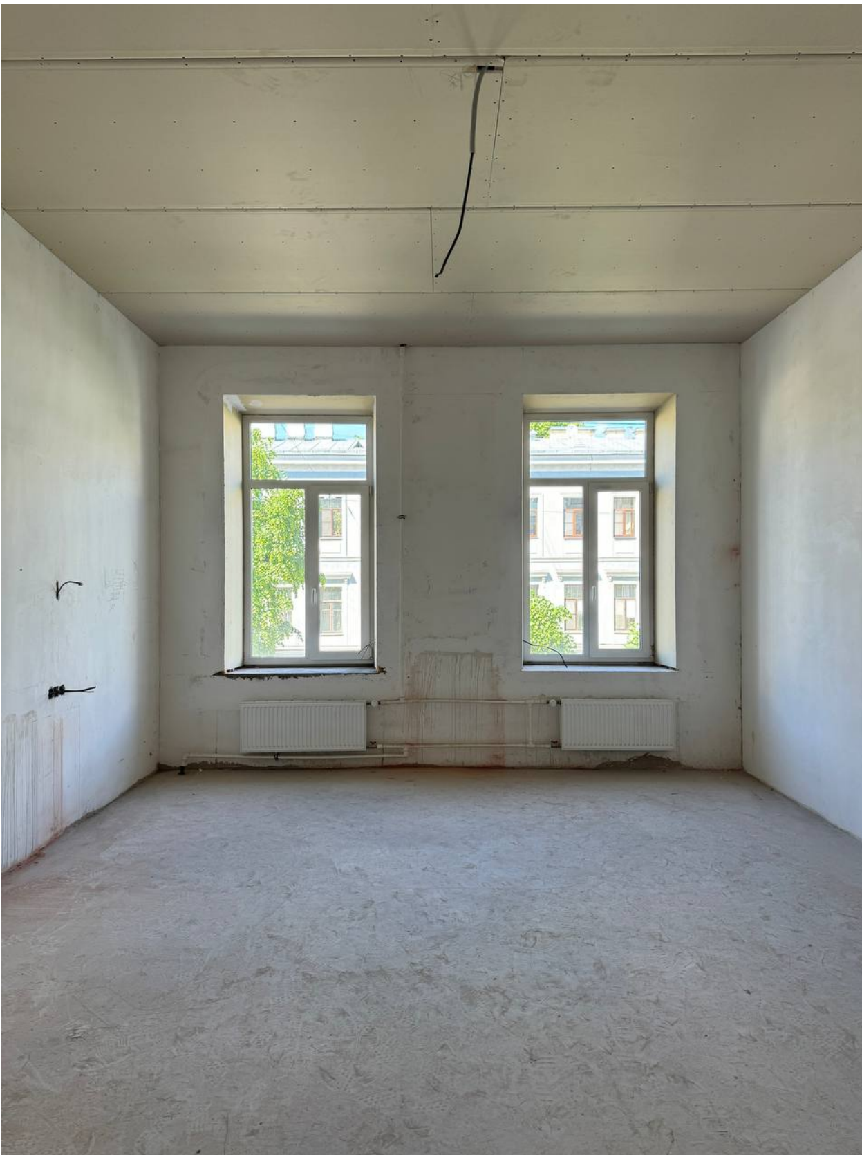
15. Помещение 7. Дата съемки: 04.06.2026.
