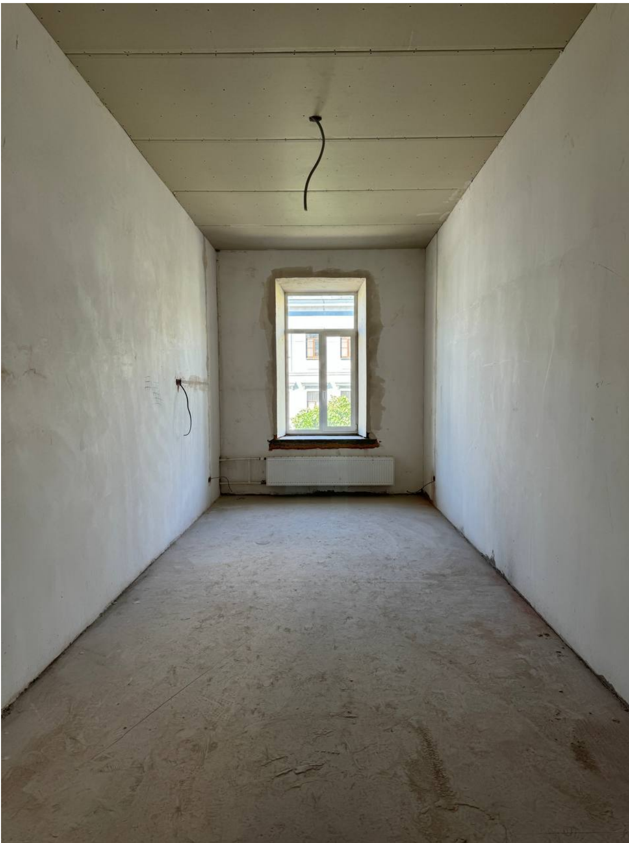
19. Помещение 9. Дата съемки: 04.06.2026.
