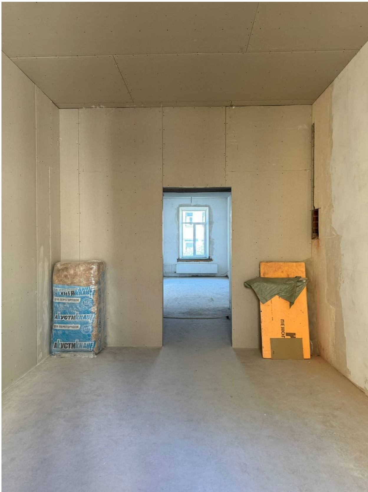
5. Помещение 2. Дата съемки: 04.06.2026.
