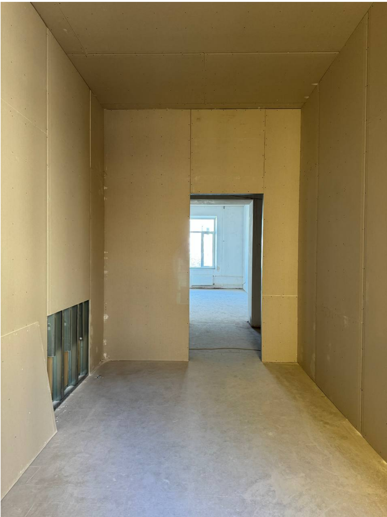
7. Помещение 3. Дата съемки: 04.06.2026.
