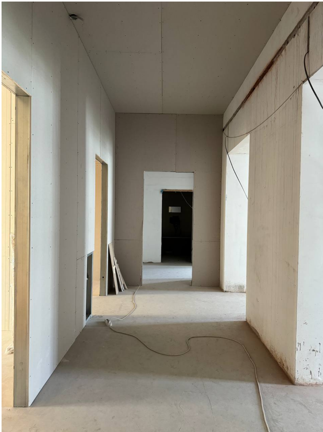
4. Помещение 1. Дата съемки: 04.06.2026
