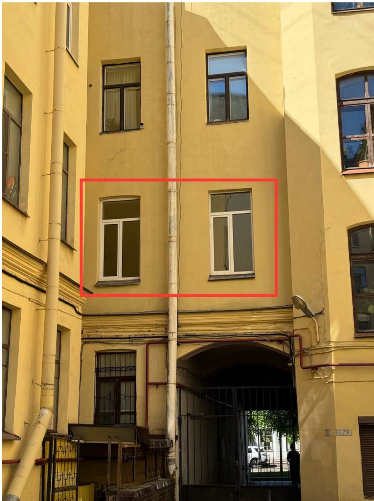
4. Окна квартиры № 2, выходящие во двор. Дата съемки: 04.06.2026.
