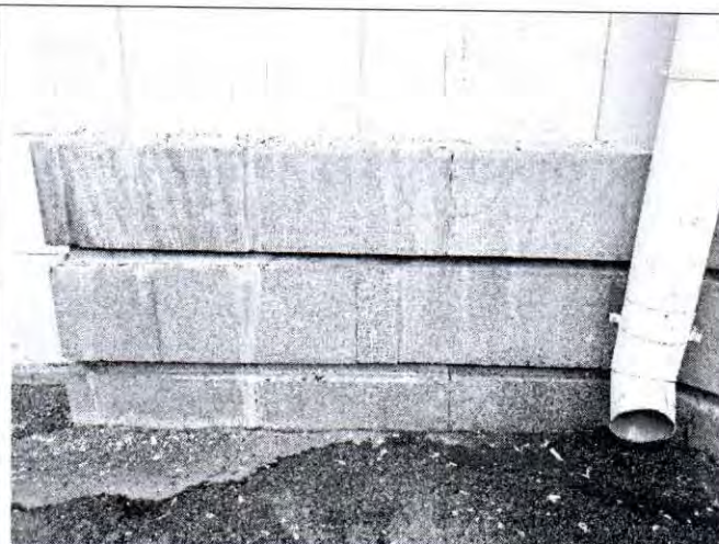
Фото 16. Фрагмент цоколя. Фото от 24.10.2022.
