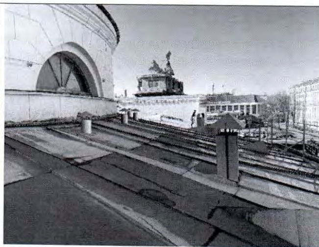
Фото 22. Фрагмент кровли. Фото от 21.03.2022.
