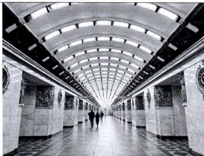
Фото 77. Перронный зал. Фото от 24.10.2022.
