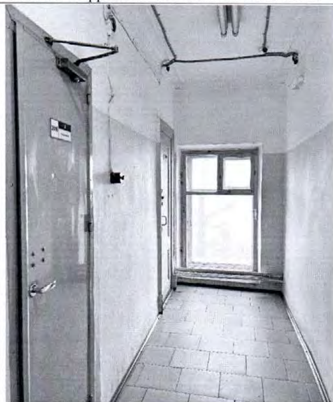
Фото 92. Помещение 2 этажа (пом. 1-Н (29)). Фото от 24.10.2022.
