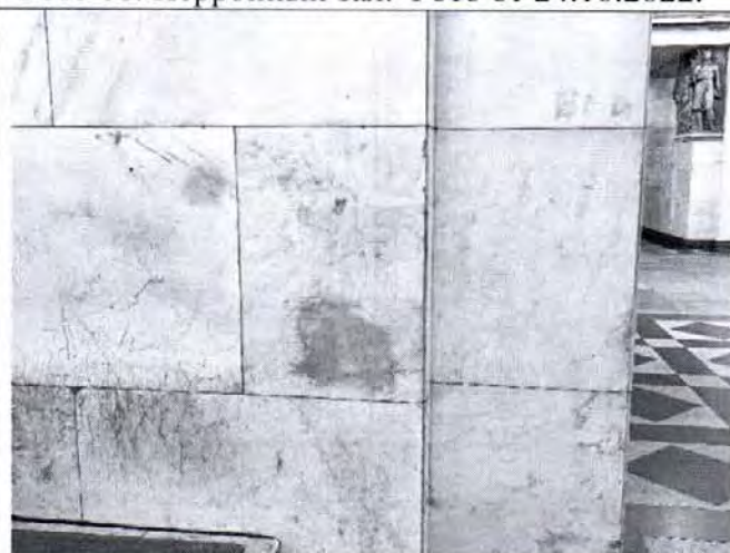
Фото 90. Перронный зал. Фото от 24.10.2022.
