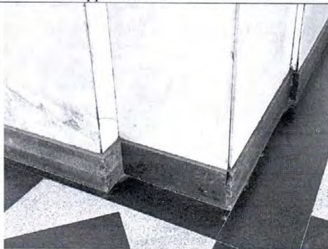
Фото 89. Перронный зал. Фото от 24.10.2022.
