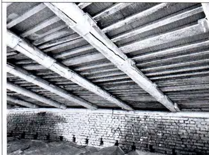
Фото 43. Чердак. Фрагмент стропильной системы. Фото от 24.10.2022.
