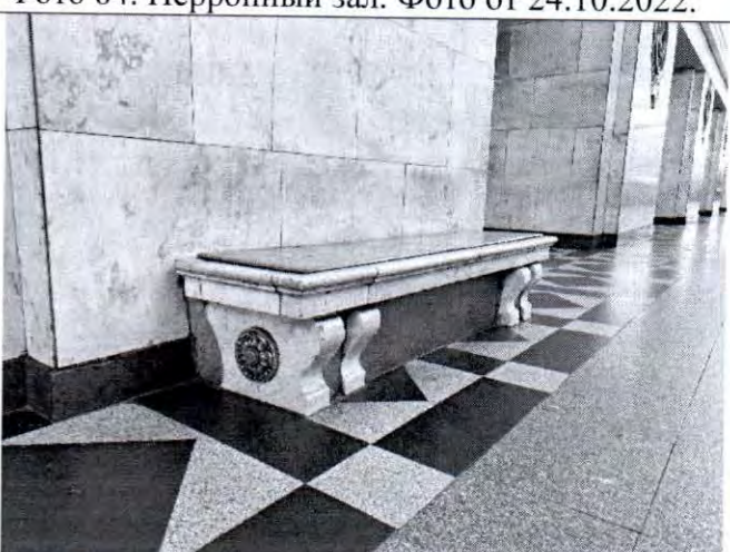
Фото 86. Перронный зал. Фото от 24.10.2022.
