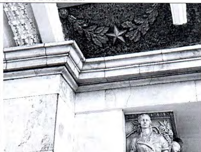
Фото 78. Перронный зал. Фото от 24.10.2022.
