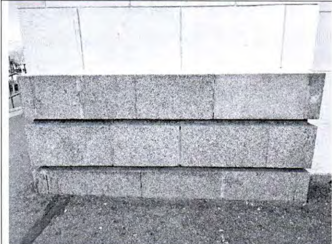
Фото 19. Фрагмент цоколя. Фото от 24.10.2022.
