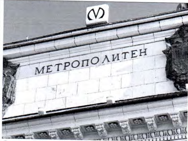
Фото 13. Фрагмент юго-западного фасада. Фото от 24.10.2022.
