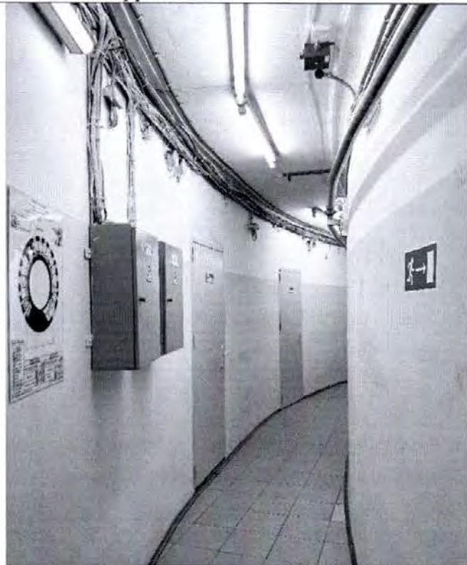
Фото 91. Помещение 2 этажа (пом. 1-Н (41)). Фото от 24.10.2022.
