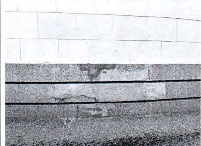
Фото 17. Фрагмент цоколя. Фото от 24.10.2022.
