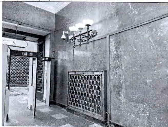
Фото 59. Помещение обходной галереи (пом. 1-Н (13)). Фото от 24.10.2022.
