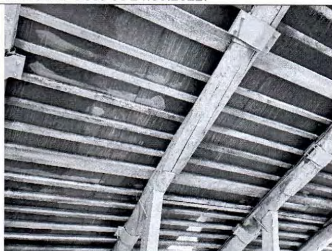
Фото 48. Чердак. Фрагмент стропильной системы. Фото от 24.10.2022.
