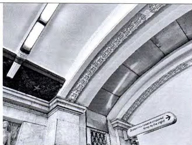
Фото 76. Помещение нижнего вестибюля. Фото от 24.10.2022.
