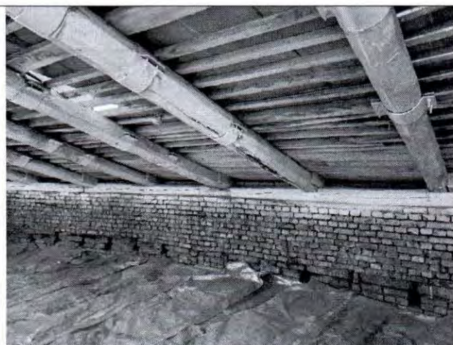
Фото 46. Чердак. Фрагмент стропильной системы. Фото от 24.10.2022.
