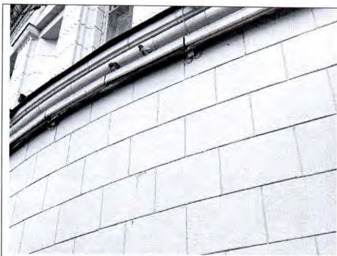
Фото 15. Фрагмент фасада. Фото от 24.10.2022.
