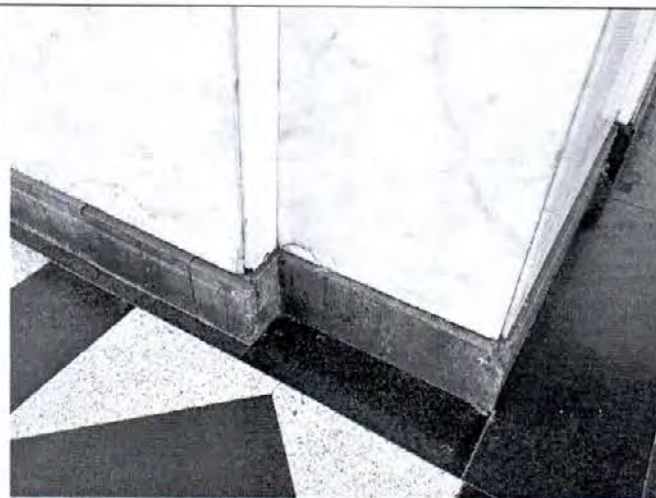
Фото 88. Перронный зал. Фото от 24.10.2022.
