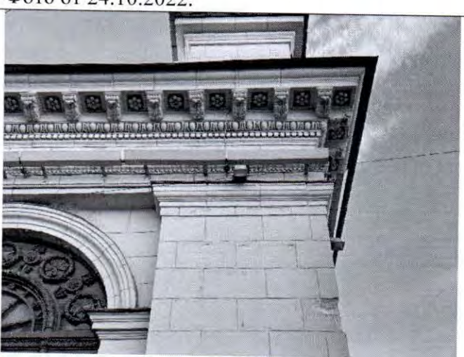
Фото 12. Фрагмент северо-западного фасада. Фото от 24.10.2022.
