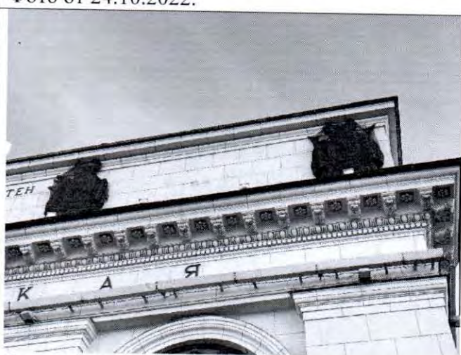
Фото 14. Фрагмент юго-западного фасада. Фото от 24.10.2022.
