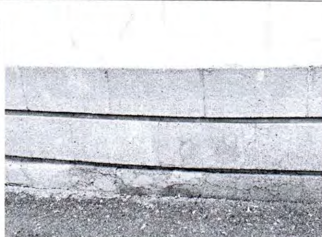
Фото 18. Фрагмент цоколя. Фото от 24.10.2022.
