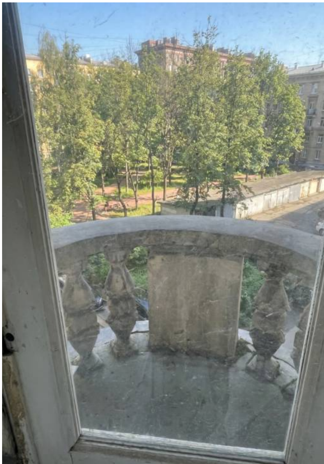
15.Балкон со стороны дворового фасада.
