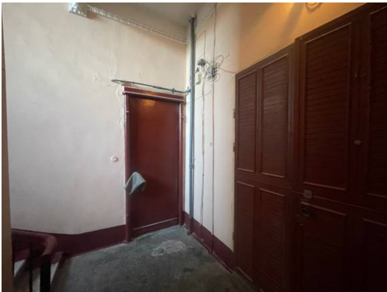
22. Заложенный дверной проем в помещение квартиры.
