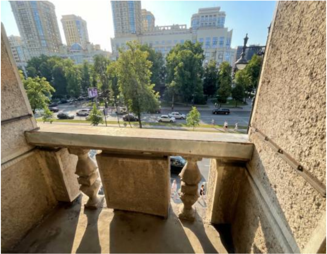
17.Балкон со стороны лицевого фасада.
