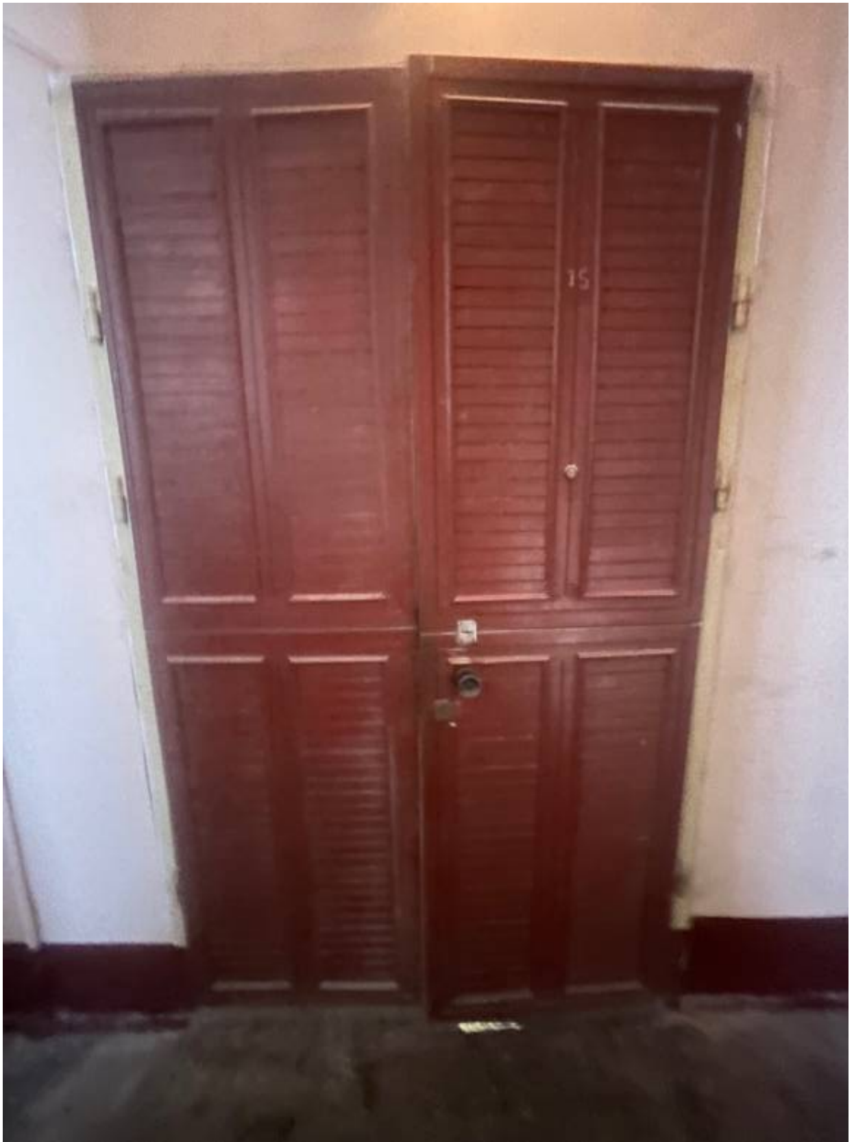
4. Общий вид входной двери.
