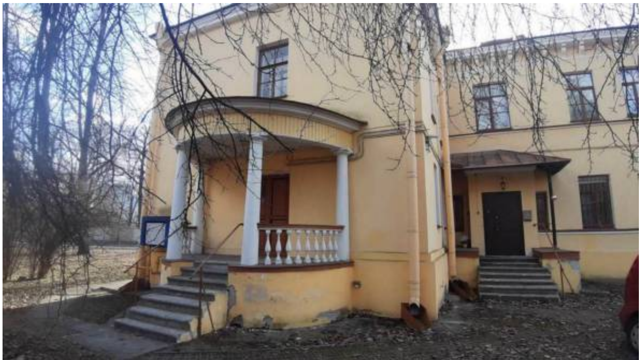
12. «Дача Бехтерева» (наб. реки Малой Невки, д. 25). Дворовый фасад. Фото мест установки оборудования и прокладки кабельных трасс. Штиглиц М.С. 03.04.2026.
