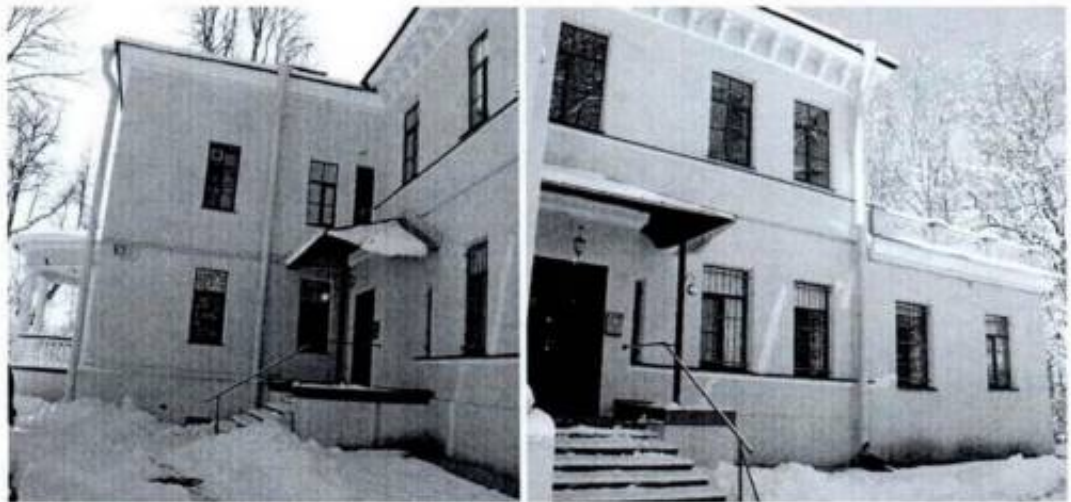
Фото 10. Фрагмент северо-западного и северо-восточного фасадов объекта культурного наследия. Фото 11. Фрагмент северо-восточного фасадов объекта культурного наследия.
