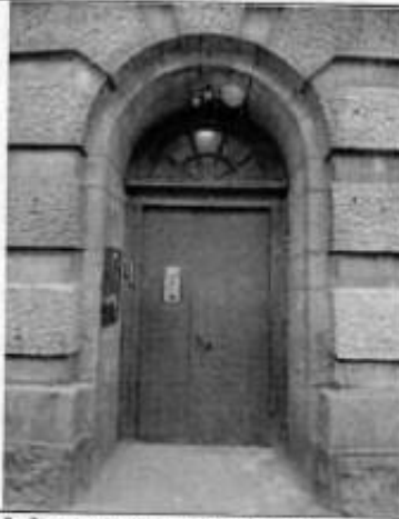
3. Фрагмент юго-западный фасада.
