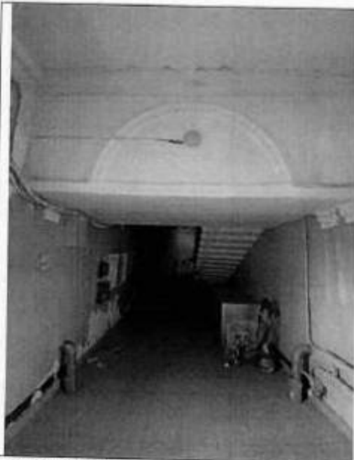
22. Вестибюль лестничной клетки 5ЛК.
