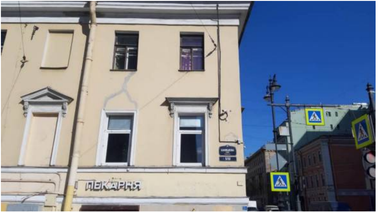
59. «Дом А.Лукина» (Шамшева ул., д. 5/50, лит. А). Лицевой фасад по Шамшева ул. (фрагмент). Фото мест установки оборудования и прокладки кабельных трасс. Штиглиц М.С. 03.04.2026.
