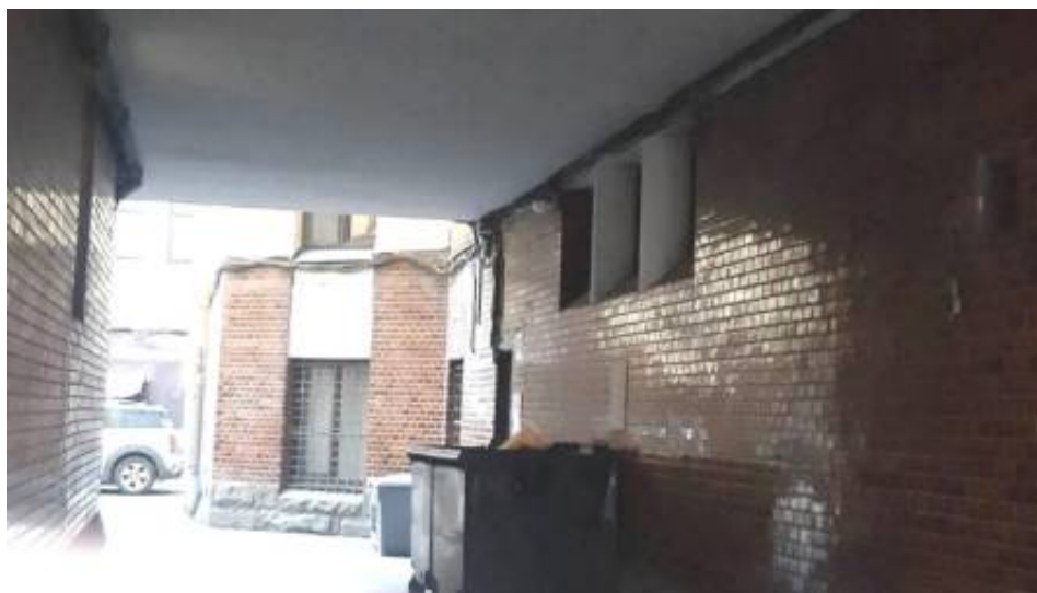
42. «Дом Р.А.Дидерихса» (Большой пр. П.С., д. 104, лит. А). Фото мест установки оборудования и прокладки кабельных трасс. Штиглиц М.С. 03.04.2026.
