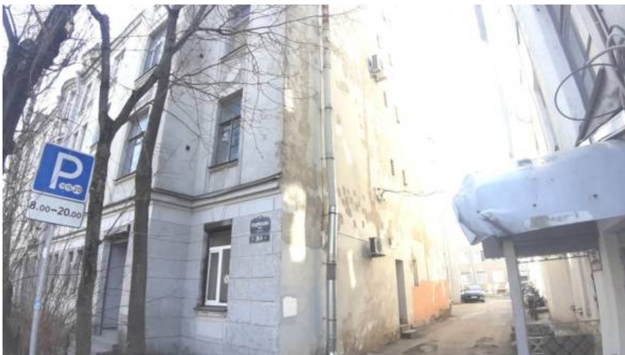
44. «Дом Н.А.Бороздина (два корпуса с палисадником и металлической оградой)» (Подрезова ул., д. 26б, лит. А). Лицевой фасад (фрагмент). Фото мест установки оборудования и прокладки кабельных трасс. Штиглиц М.С. 03.04.2026.
