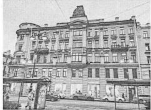
2. Фасад по Большому пр. П.С.
