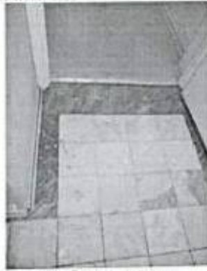
40. Фрагмент пола пом. 2-Н(13)
