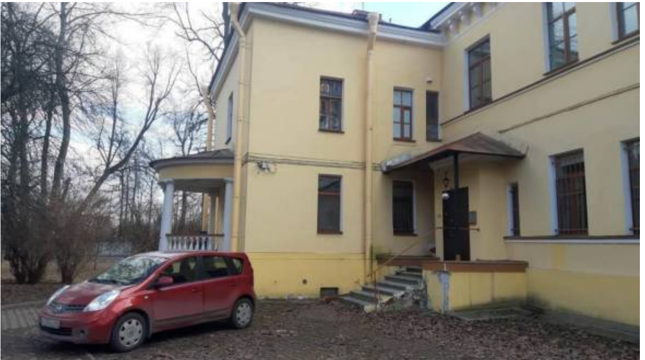
10. «Дача Бехтерева» (наб. реки Малой Невки, д. 25). Дворовый фасад. Фото мест установки оборудования и прокладки кабельных трасс. Штиглиц М.С. 03.04.2026.
