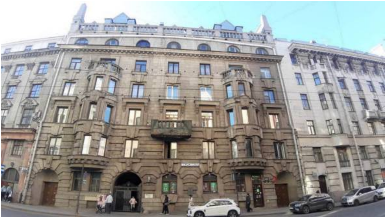
5. «Бывш. дом Гонцкевича» (Большой пр. П.С., д. 102, лит. А). Лицевой фасад. Штиглиц М.С. 03.04.2026.
