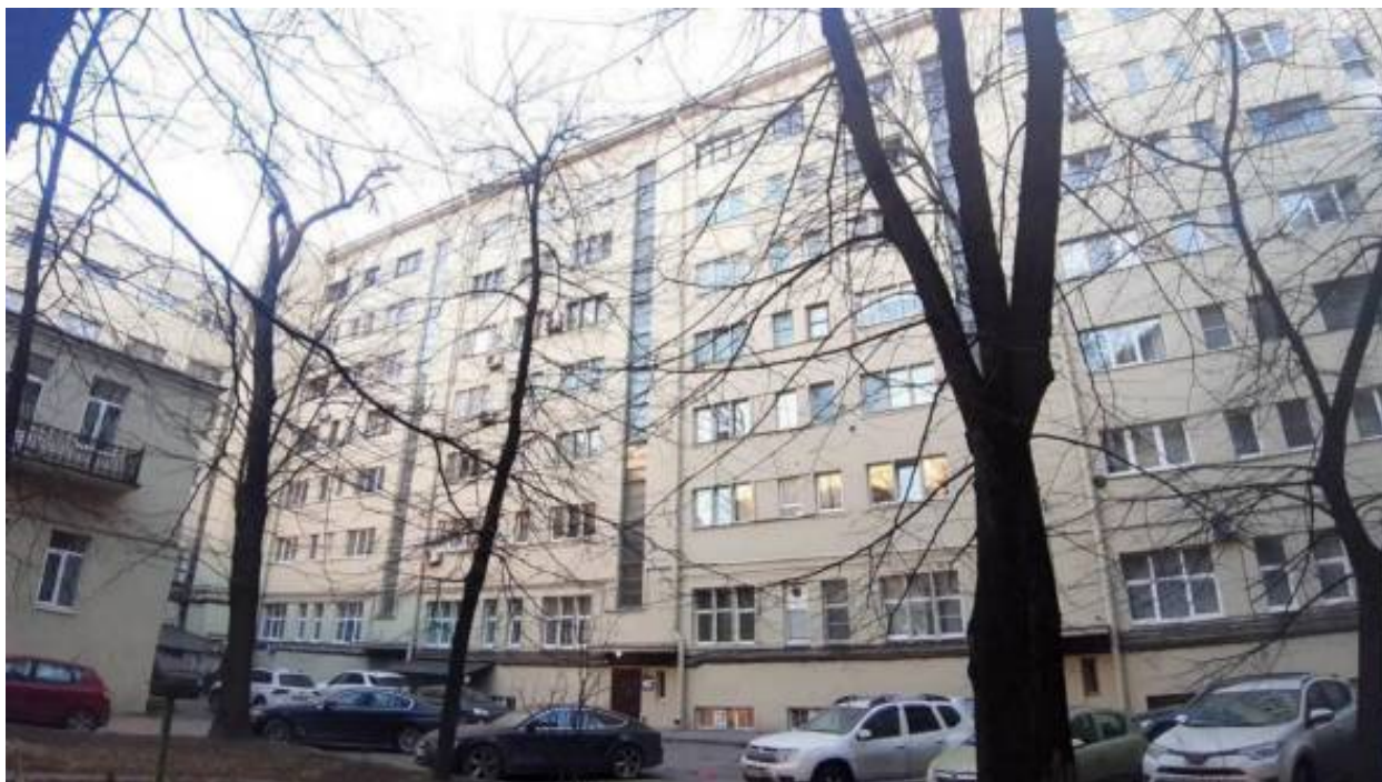
27. «Дом-коммуна Общества бывших политкаторжан и ссыльнопоселенцев» (Троицкая пл. П.С., д. 1, лит. А). Дворовый фасад. Фото мест установки оборудования и прокладки кабельных трасс. Штиглиц М.С. 03.04.2026.
