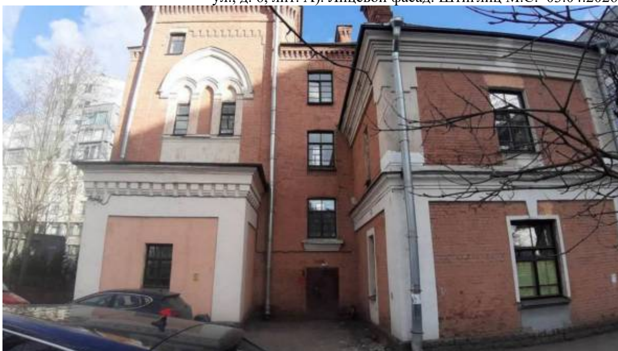
48. «Водонапорная башня с жилым флигелем «Городка Ф. К. Сан-Галли» (Ремесленная ул., д. 6, лит. А). Дворовый фасад. Фото мест установки оборудования и прокладки кабельных трасс. Штиглиц М.С. 03.04.2026.
