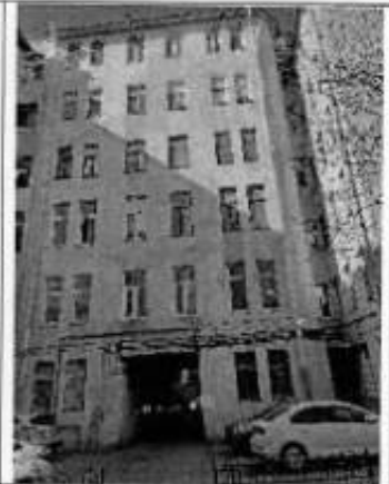
15. Юго-восточный торцевой фасад.
