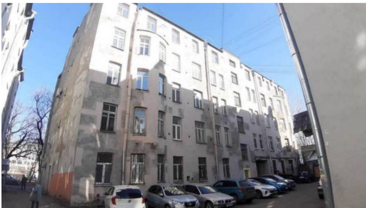
46. «Дом Н.А.Бороздина (два корпуса с палисадником и металлической оградой)» (Подрезова ул., д. 26б, лит. А). Дворовый фасад. Фото мест установки оборудования и прокладки кабельных трасс. Штиглиц М.С. 03.04.2026.
