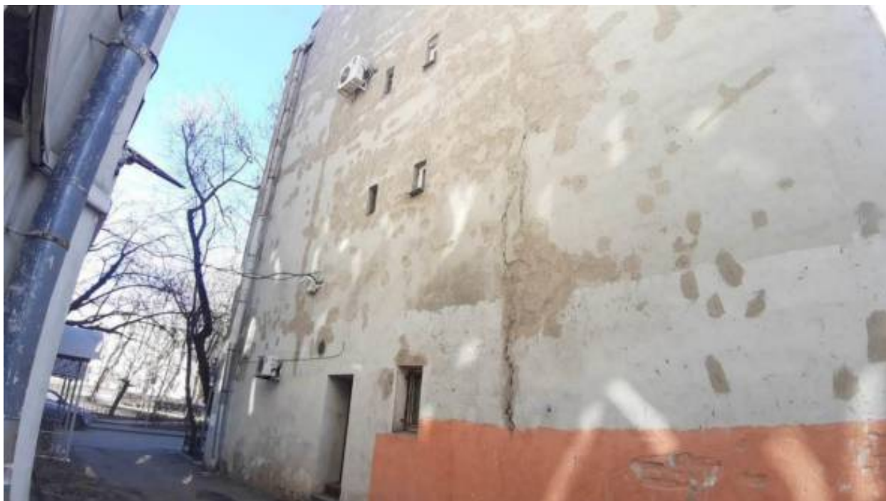
45. «Дом Н.А.Бороздина (два корпуса с палисадником и металлической оградой)» (Подрезова ул., д. 26б, лит. А). Дворовый фасад. Фото мест установки оборудования и прокладки кабельных трасс. Штиглиц М.С. 03.04.2026.
