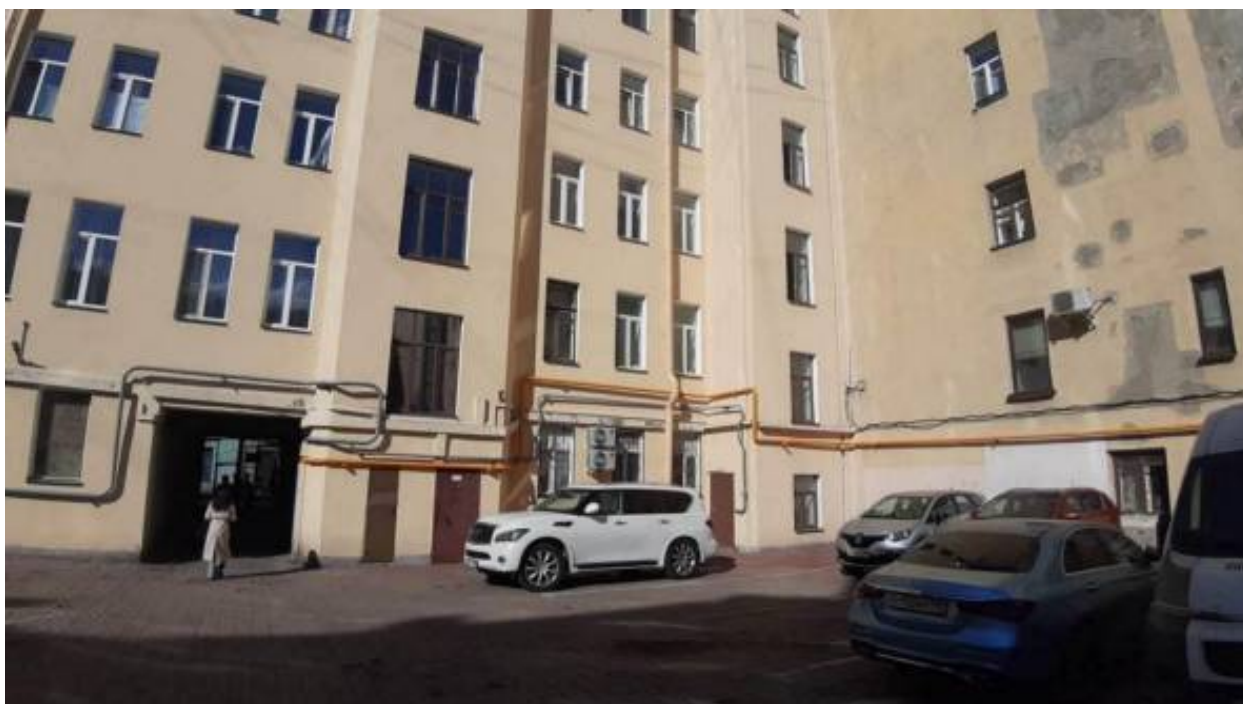
4. «Доходный дом П.Т. Бадаева» (Большой пр. П.С., д. 49/18, лит. А). Дворовый фасад. Фото мест установки оборудования и прокладки кабельных трасс. Штиглиц М.С. 03.04.2026.
