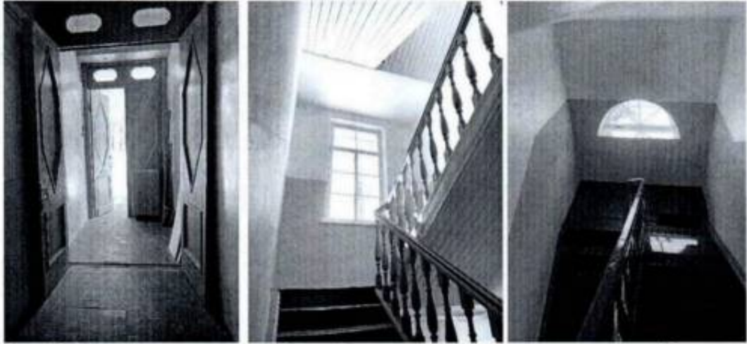
Фото 15. Общий вид интерьера вестибюля объекта культурного наследия со стороны Л-1. Фото 16,17. Интерьер лестницы Л-2 объекта культурного наследия.
