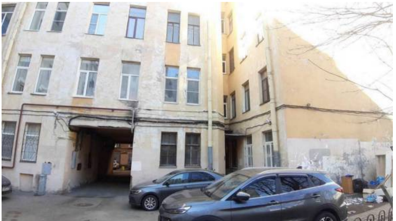
16. «Дом А.Л. Лишнеvского» (Ленина ул., д. 41, лит. А). Дворовый фасад. Фото мест установки оборудования и прокладки кабельных трасс. Штиглиц М.С. 03.04.2026.
