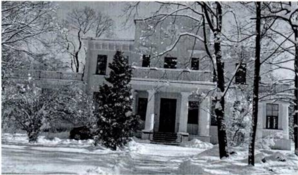
Фото 3. Общий вид на юго-западный фасад объекта культурного наследия.
