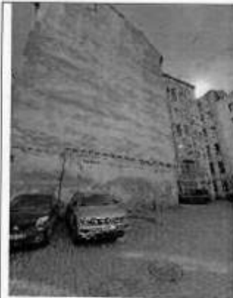
13. Брандмауэрная стена северо-западного торцевого фасада.
