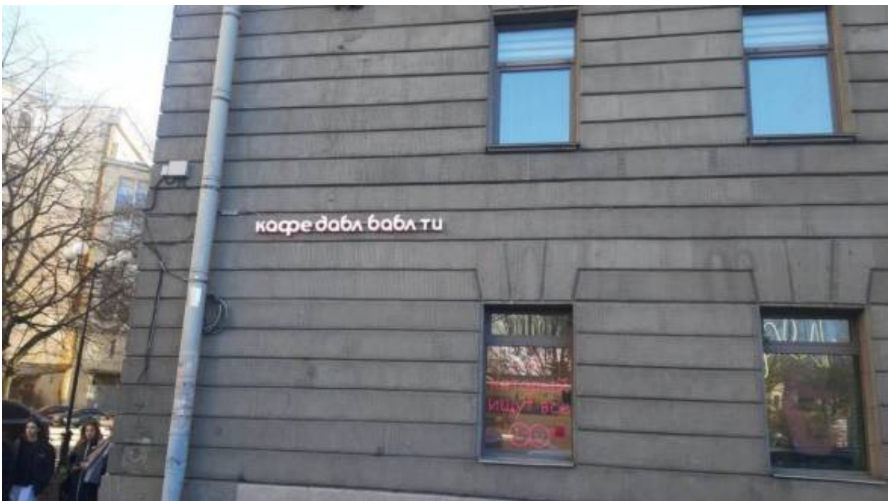
56. «Дом Ф.Ф.Нидермейера» (Каменноостровский пр., д. 39, лит. А). Дворовый фасад. Фото мест установки оборудования и прокладки кабельных трасс. Штиглиц М.С. 03.04.2026.
