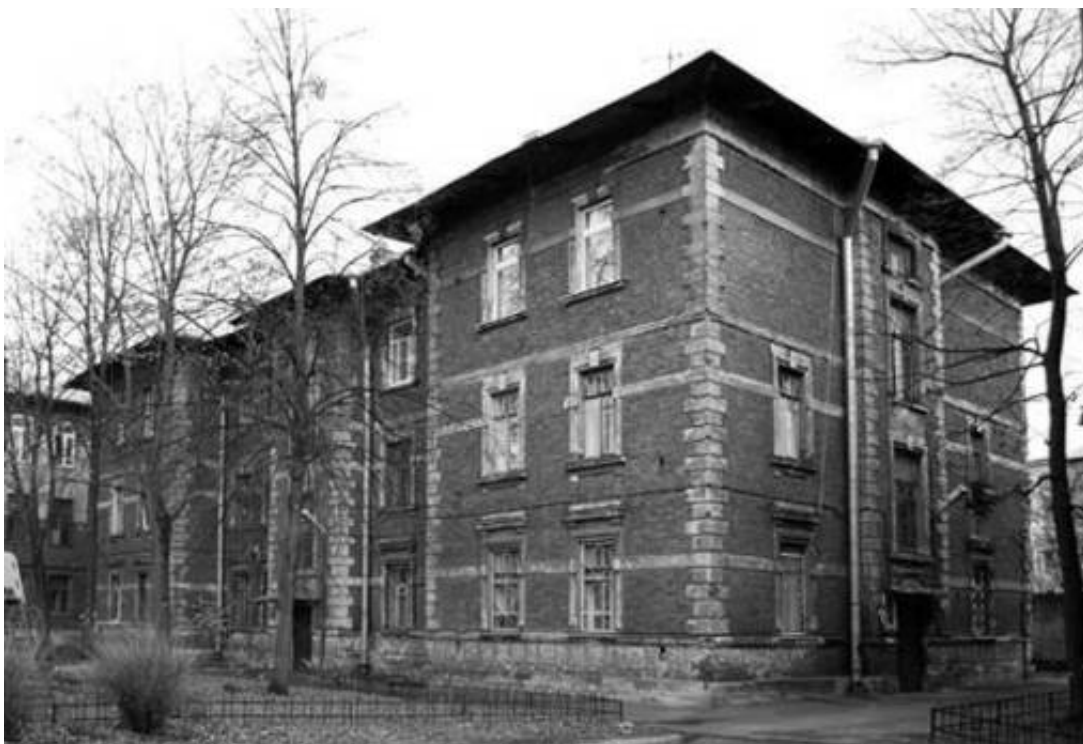
37. «Казарменный корпус» (в составе «Казарменные, административные и хозяйственные корпуса», в составе «Здания Санкт-Петербургской бригады пограничной стражи») (Красного Курсанта, дом 34, литера Б). 2016 (31).
