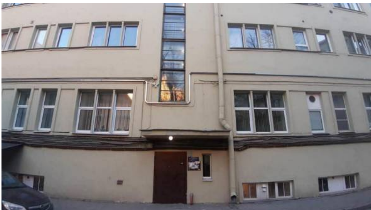
28. «Дом-коммуна Общества бывших политкаторжан и ссыльнопоселенцев» (Троицкая пл. П.С., д. 1, лит. А). Дворовый фасад. Фото мест установки оборудования и прокладки кабельных трасс. Штиглиц М.С. 03.04.2026.
