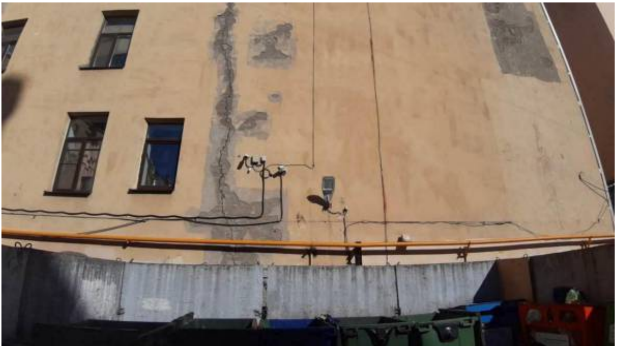
2. «Доходный дом П.Т. Бадаева» (Большой пр. П.С., д. 49/18, лит. А). Дворовый фасад. Фото мест установки оборудования и прокладки кабельных трасс. Штиглиц М.С. 03.04.2026.
