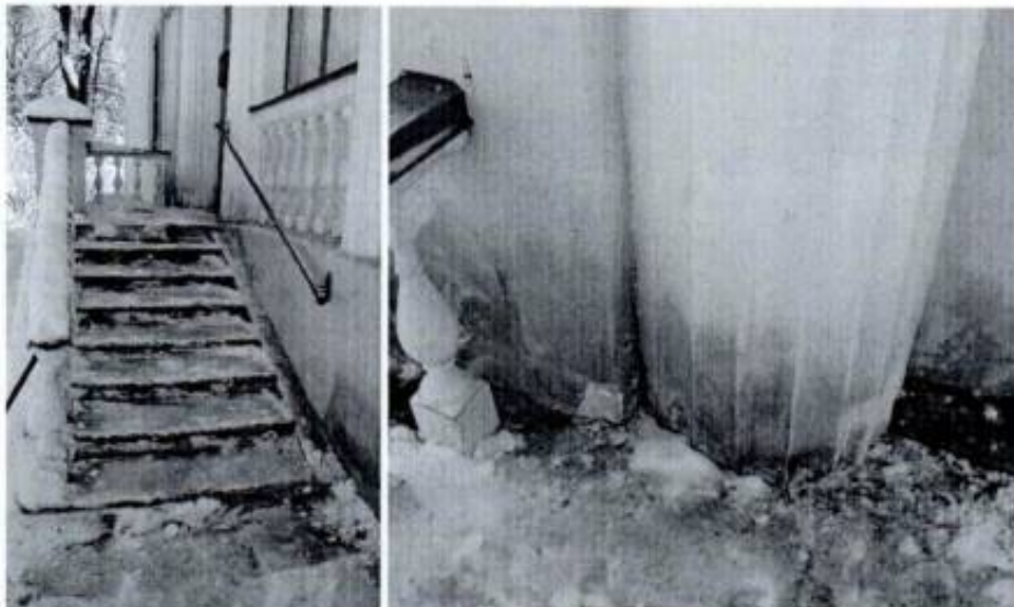
Фото 7. Общий вид на крыльцо со стороны северо-западного фасада объекта культурного наследия.
