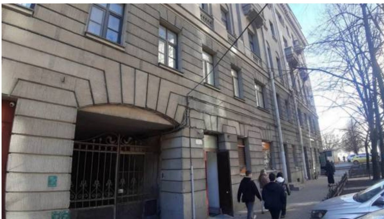
52. «Дом Ф.Ф.Нидермейера» (Каменноостровский пр., д. 39, лит. А). Дворовый фасад. Фото мест установки оборудования и прокладки кабельных трасс. Штиглиц М.С. 03.04.2026.
