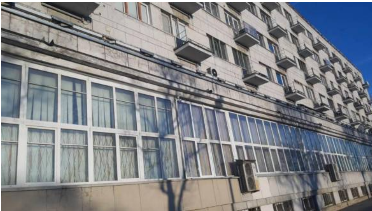
19. «Дом-коммуна Общества бывших политкаторжан и ссыльнопоселенцев» (Троицкая пл. П.С., д. 1, лит. А). Лицевой фасад (фрагмент). Фото мест установки оборудования и прокладки кабельных трасс. Штиглиц М.С. 03.04.2026.
