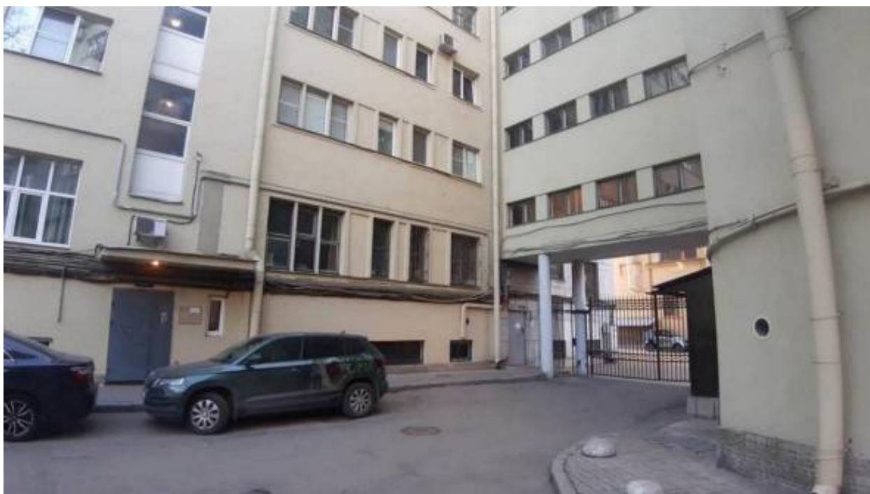
25. «Дом-коммуна Общества бывших политкаторжан и ссыльнопоселенцев» (Троицкая пл. П.С., д. 1, лит. А). Дворовый фасад. Фото мест установки оборудования и прокладки кабельных трасс. Штиглиц М.С. 03.04.2026.
