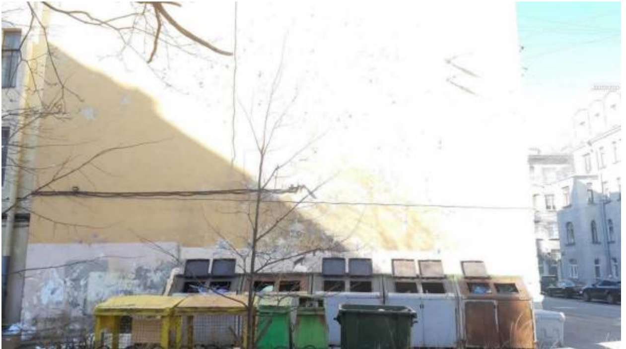
15. «Дом А.Л. Лишнеvского» (Ленина ул., д. 41, лит. А). Дворовый фасад. Фото мест установки оборудования и прокладки кабельных трасс. Штиглиц М.С. 03.04.2026.
