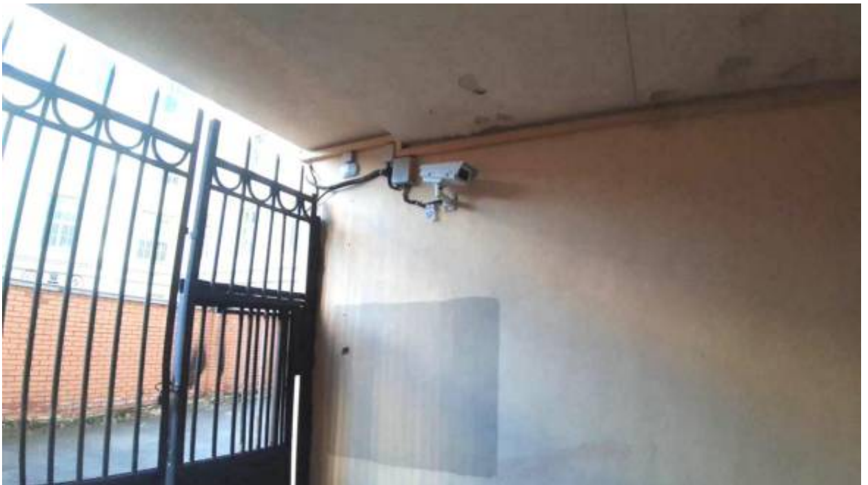
38. «Автомобильный гараж и жилой дом фирмы К. Л. Крюммеля» (Дивенская ул., д. 9/3, лит. А, Большая Посадская ул., д. 12, лит. А). Фото мест установки оборудования и прокладки кабельных трасс. Штиглиц М.С. 03.04.2026.
