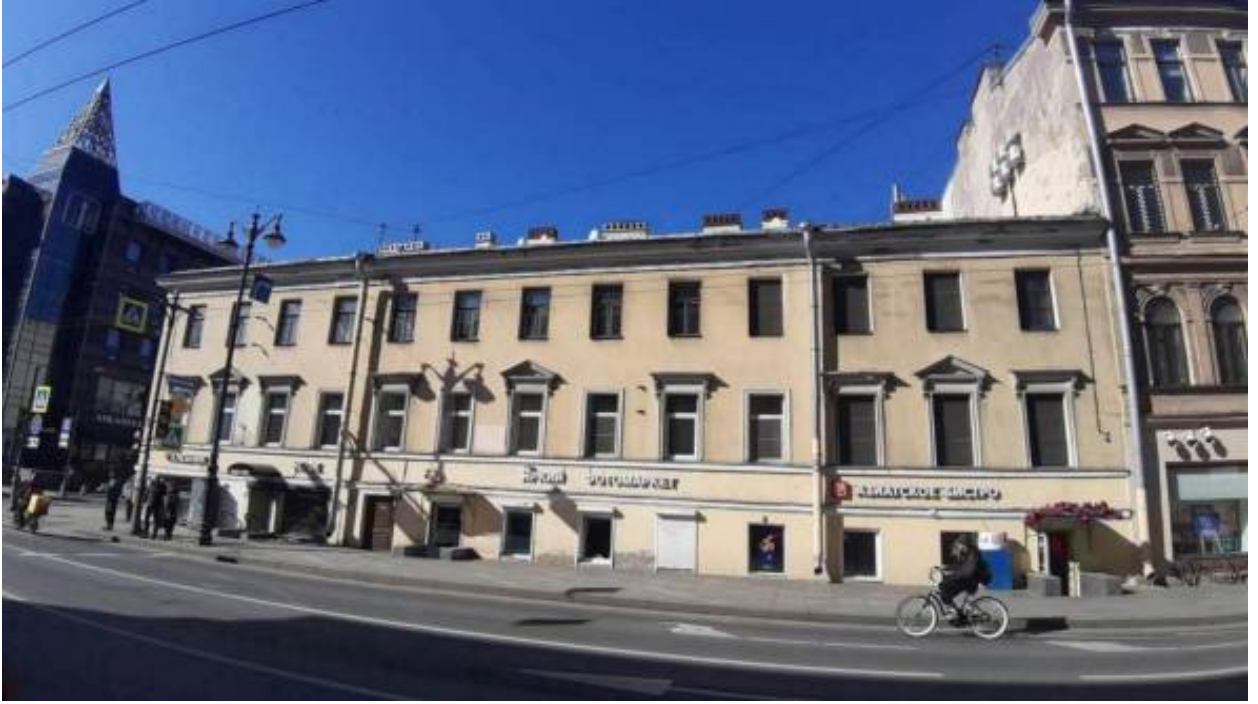
57. «Дом А.Лукина» (Шамшева ул., д. 5/50, лит. А). Лицевой фасад по Большому пр П.С.. Штиглиц М.С. 03.04.2026.
