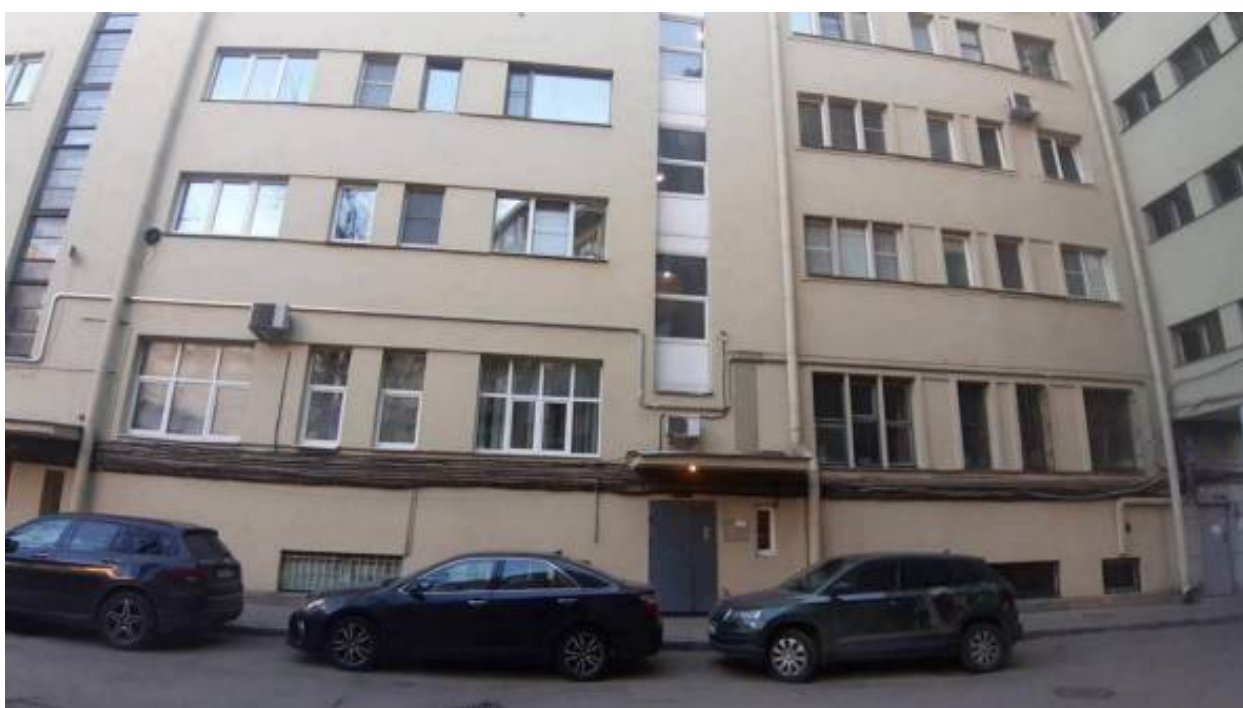
26. «Дом-коммуна Общества бывших политкаторжан и ссыльнопоселенцев» (Троицкая пл. П.С., д. 1, лит. А). Дворовый фасад. Фото мест установки оборудования и прокладки кабельных трасс. Штиглиц М.С. 03.04.2026.
