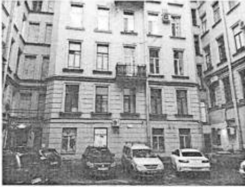
7. Дворовый фасад. Фрагмент
