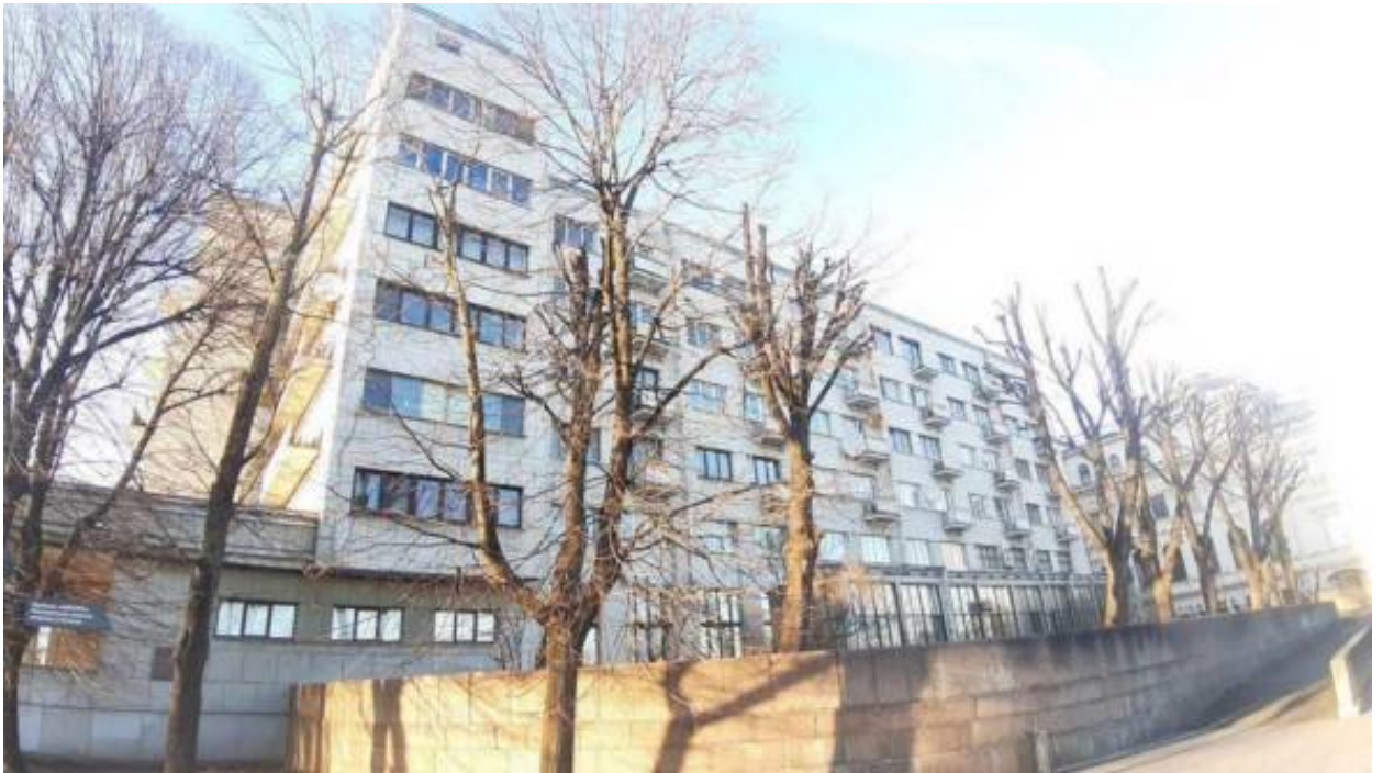
23. «Дом-коммуна Общества бывших политкаторжан и ссыльнопоселенцев» (Троицкая пл. П.С., д. 1, лит. А). Лицевой фасад по Петровской наб. Штиглиц М.С. 03.04.2026.
