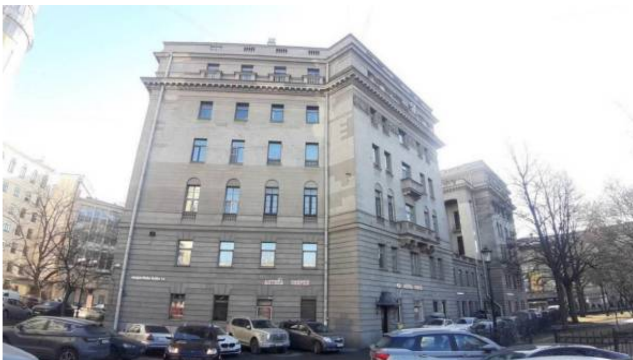
54. «Дом Ф.Ф.Нидермейера» (Каменноостровский пр., д. 39, лит. А). Дворовый фасад. Фото мест установки оборудования и прокладки кабельных трасс. Штиглиц М.С. 03.04.2026.
