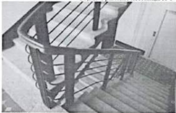
33. Фрагмент ограждения лестницы Л-1 – Л-6, Л-8
