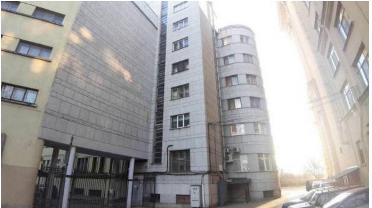
24. «Дом-коммуна Общества бывших политкаторжан и ссыльнопоселенцев» (Троицкая пл. П.С., д. 1, лит. А). Дворовый фасад. Фото мест установки оборудования и прокладки кабельных трасс. Штиглиц М.С. 03.04.2026.
