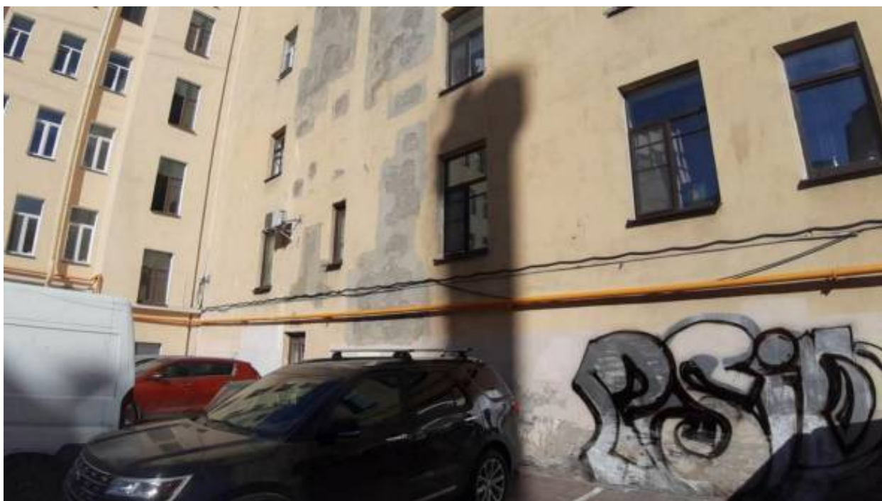
3. «Доходный дом П.Т. Бадаева» (Большой пр. П.С., д. 49/18, лит. А). Дворовый фасад. Фото мест установки оборудования и прокладки кабельных трасс. Штиглиц М.С. 03.04.2026.
