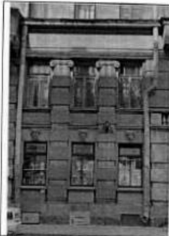
2. Фрагмент юго-западный фасада.
