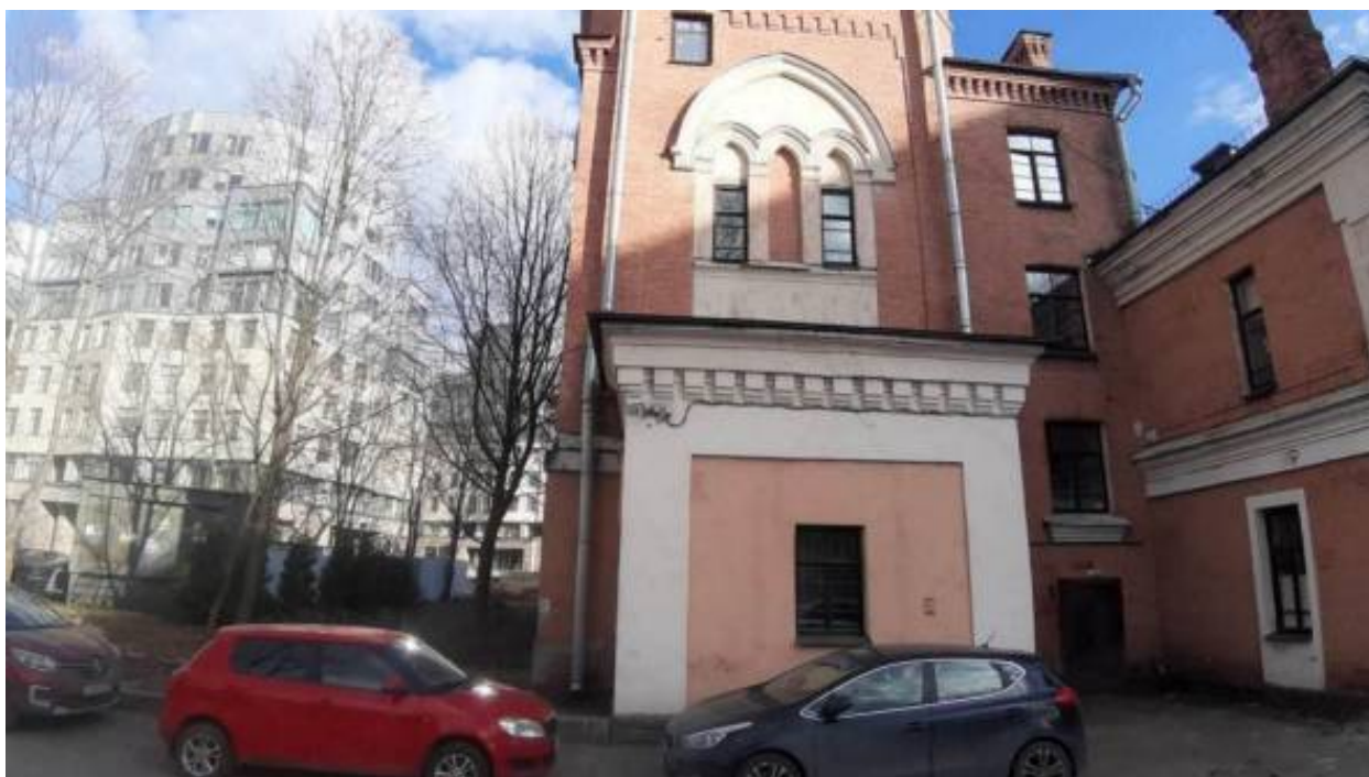
49. «Водонапорная башня с жилым флигелем «Городка Ф. К. Сан-Галли» (Ремесленная ул., д. 6, лит. А). Дворовый фасад. Фото мест установки оборудования и прокладки кабельных трасс. Штиглиц М.С. 03.04.2026.
