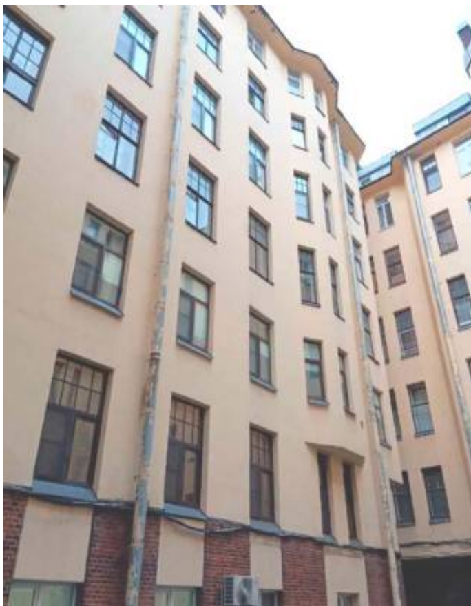
41. «Дом Р.А.Дидерихса» (Большой пр. П.С., д. 104, лит. А). Дворовый фасад. Фото мест установки оборудования и прокладки кабельных трасс. Штиглиц М.С. 03.04.2026.
