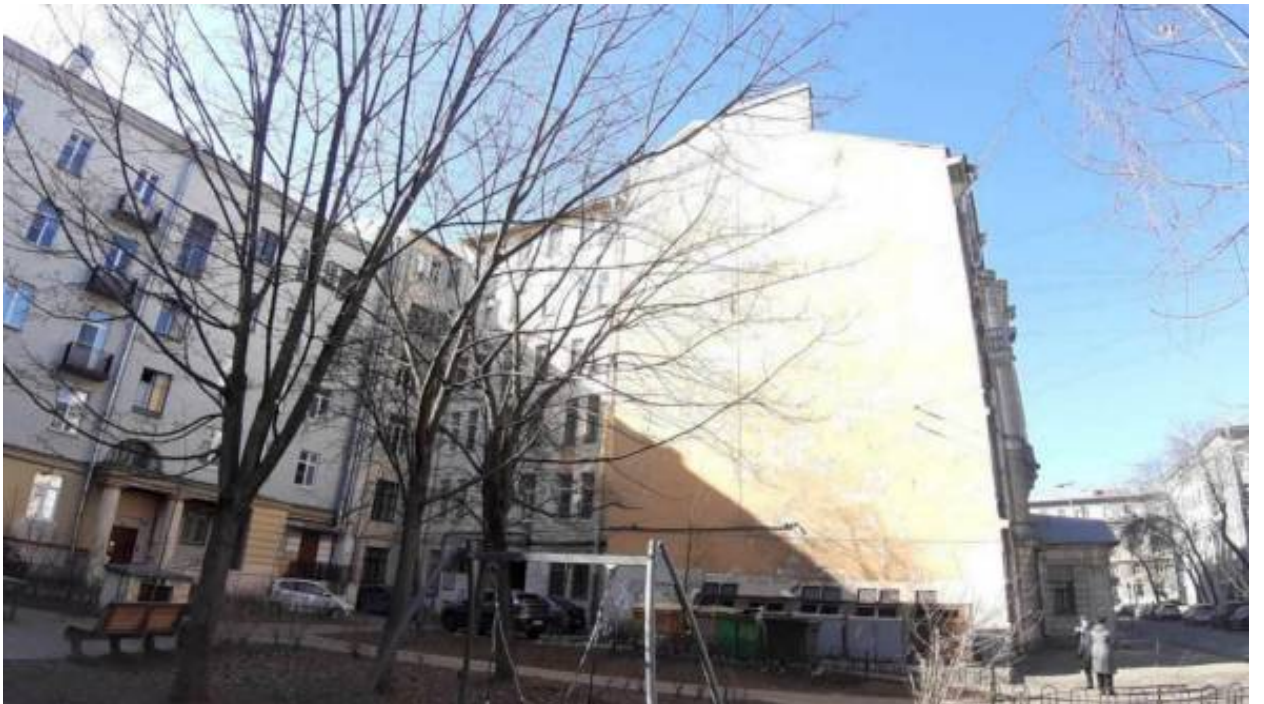
14. «Дом А.Л. Лишнеvского» (Ленина ул., д. 41, лит. А). Дворовый фасад. Фото мест установки оборудования и прокладки кабельных трасс. Штиглиц М.С. 03.04.2026.
