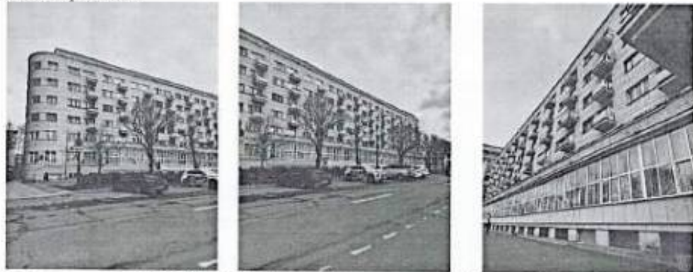
1,2,3. Фрагмент лицевого фасада со стороны Троицкой пл.
