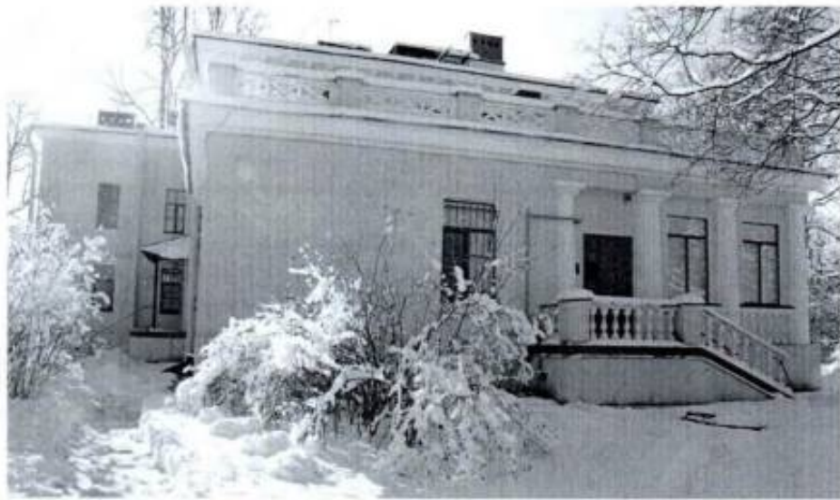
Фото 6. Общий вид на северо-западный фасад объекта культурного наследия.
