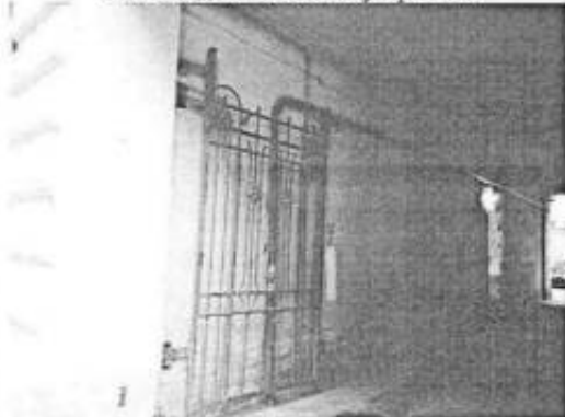
4. Фасад по ул. Ленина. Воротный проезд.
