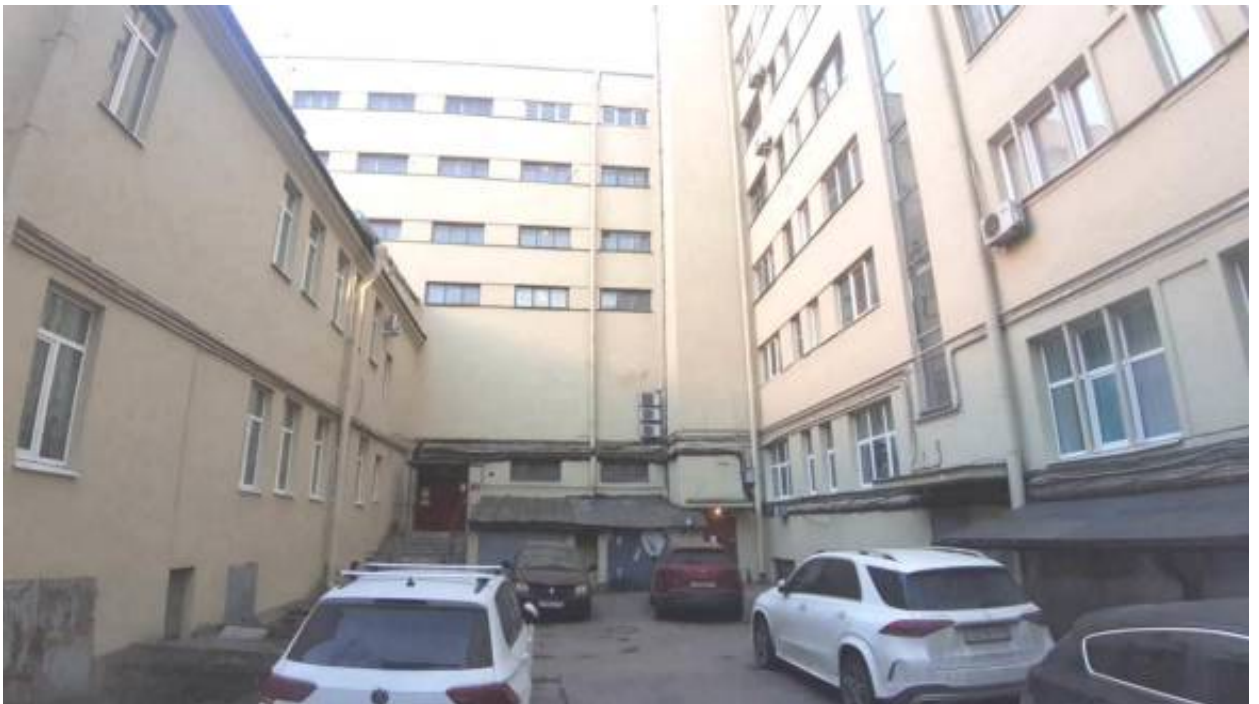
30. «Дом-коммуна Общества бывших политкаторжан и ссыльнопоселенцев» (Троицкая пл. П.С., д. 1, лит. А). Дворовый фасад. Фото мест установки оборудования и прокладки кабельных трасс. Штиглиц М.С. 03.04.2026.
