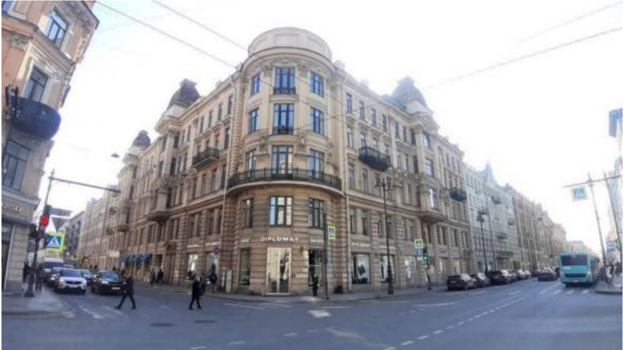
1. «Доходный дом П.Т. Бадаева» (Большой пр. П.С., д. 49/18, лит. А). Общий вид. Штиглиц М.С. 03.04.2026.
