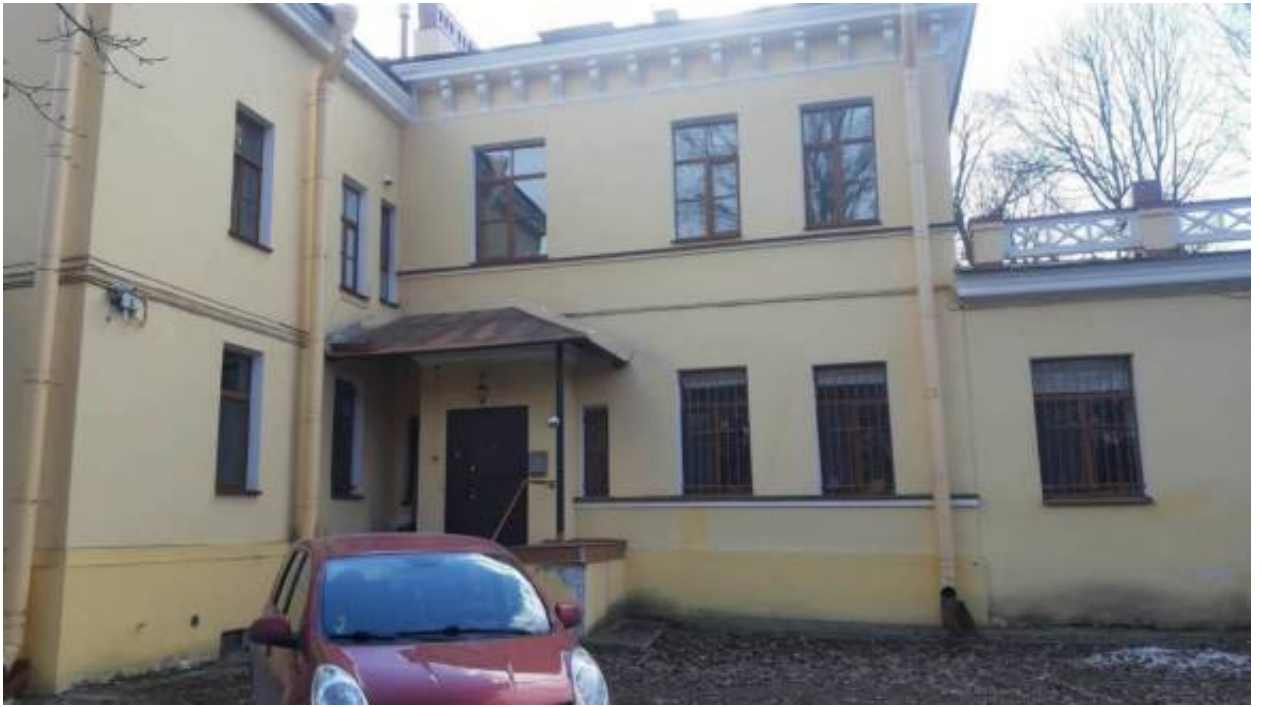
11. «Дача Бехтерева» (наб. реки Малой Невки, д. 25). Дворовый фасад. Фото мест установки оборудования и прокладки кабельных трасс. Штиглиц М.С. 03.04.2026.
