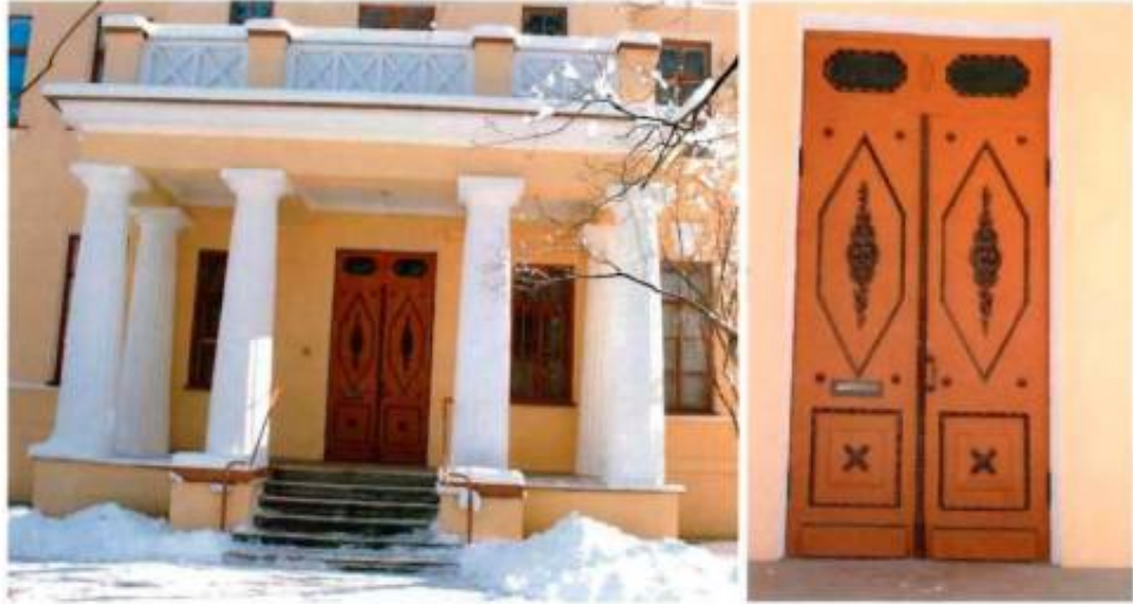
7,8. Фрагмент юго-западного фасада объекта культурного наследия.
