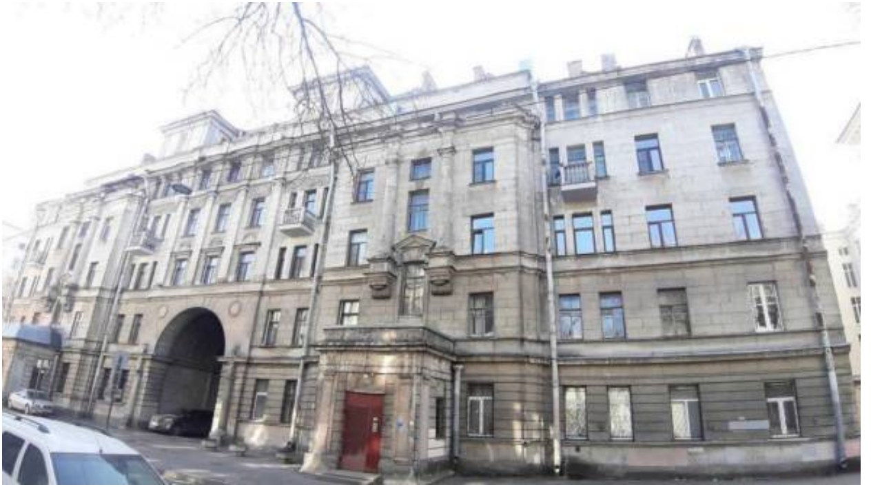
13. «Дом А.Л. Лишнеvского» (Ленина ул., д. 41, лит. А). Лицевой фасад по Полозова ул. Штиглиц М.С. 03.04.2026.
