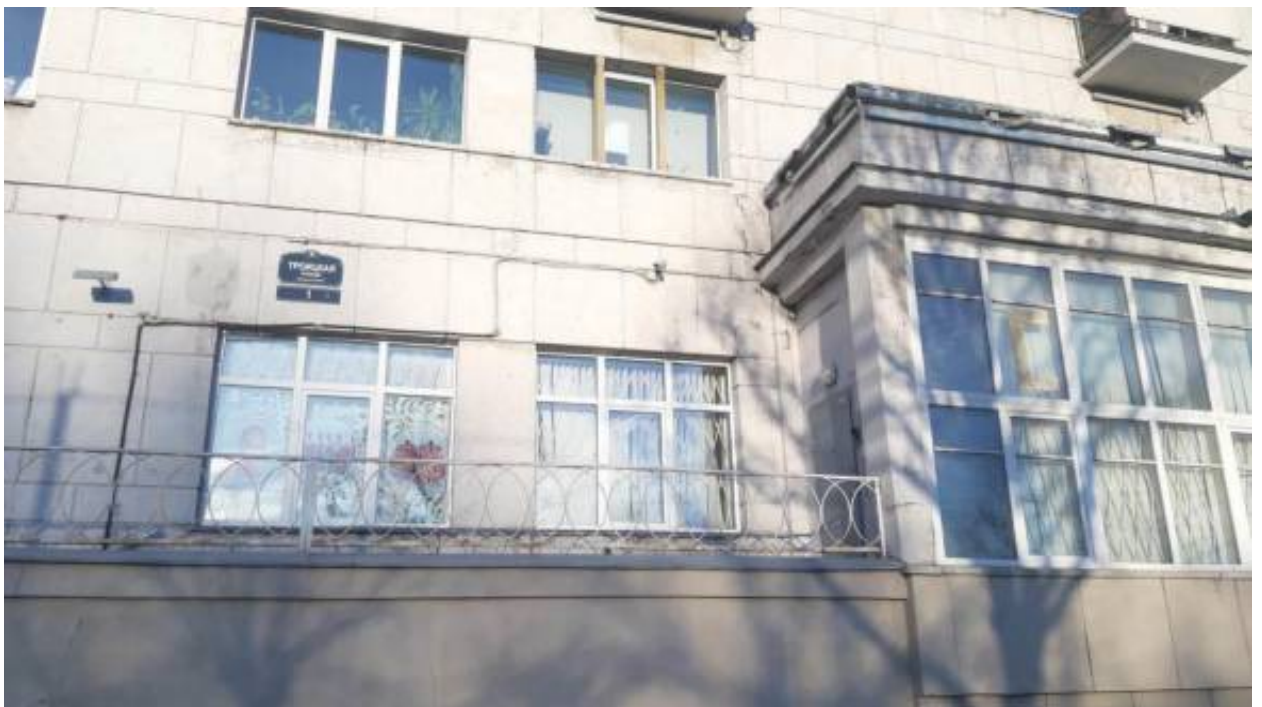
18. «Дом-коммуна Общества бывших политкаторжан и ссыльнопоселенцев» (Троицкая пл. П.С., д. 1, лит. А). Лицевой фасад (фрагмент). Фото мест установки оборудования и прокладки кабельных трасс. Штиглиц М.С. 03.04.2026.
