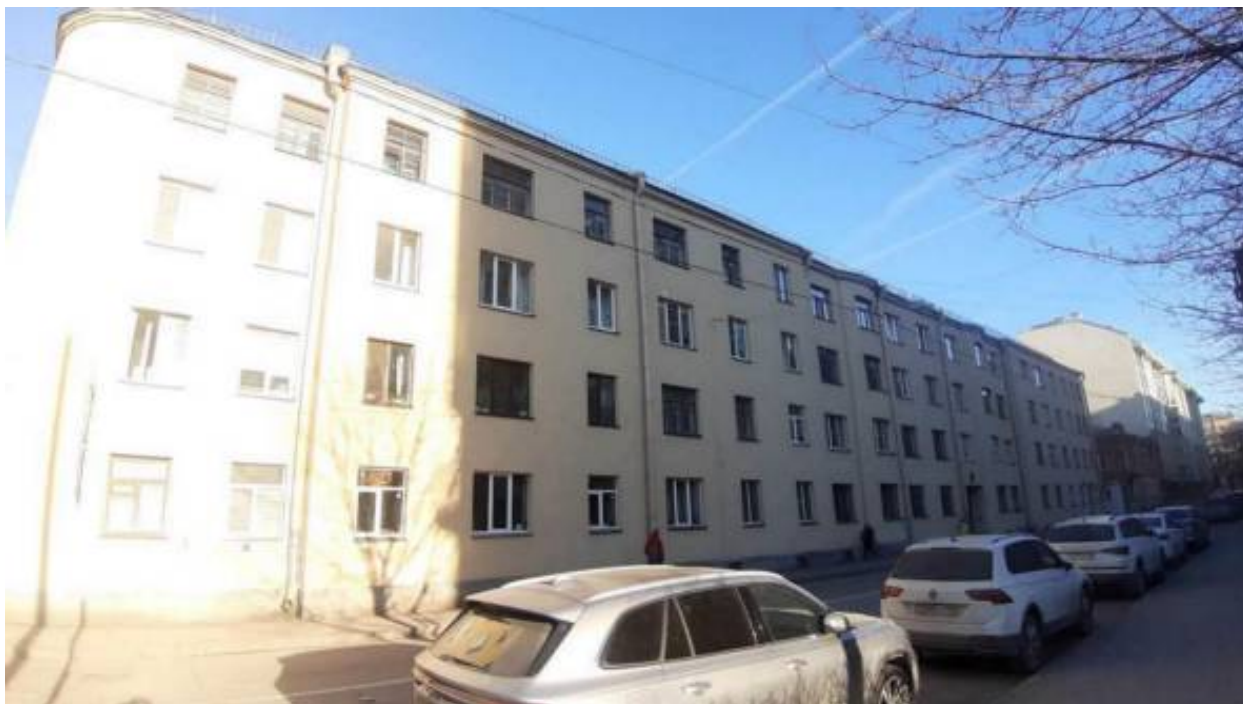
33. «Автомобильный гараж и жилой дом фирмы К. Л. Крюммеля» (Дивенская ул., д. 9/3, лит. А, Большая Посадская ул., д. 12, лит. А). Лицевой фасад по Малой Монетной ул. Штиглиц М.С. 03.04.2026.
