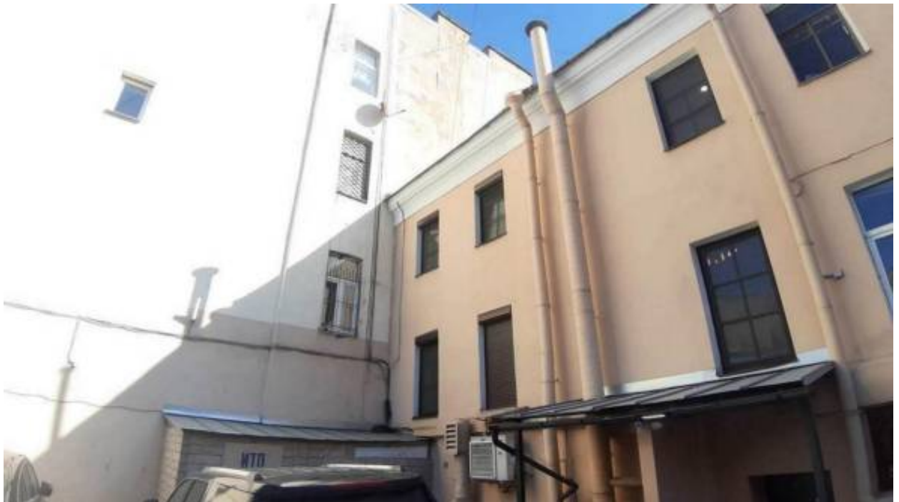
60. «Дом А.Лукина» (Шамшева ул., д. 5/50, лит. А). Дворовый фасад. Фото мест установки оборудования и прокладки кабельных трасс. Штиглиц М.С. 03.04.2026.
