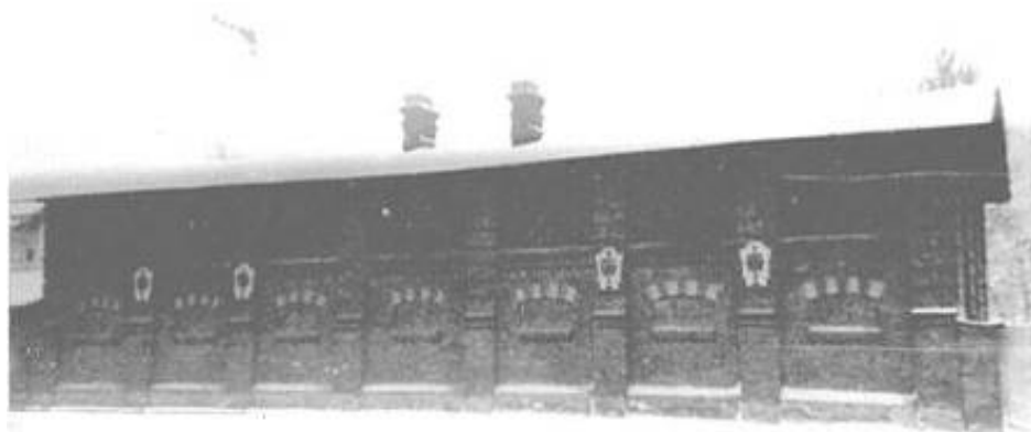
35. «Здания Санкт-Петербургской бригады пограничной стражи» (Красного Курсанта ул., д. 32). 1999 (24).
