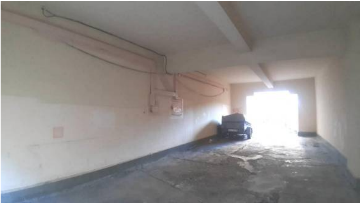
35. «Автомобильный гараж и жилой дом фирмы К. Л. Крюммеля» (Дивенская ул., д. 9/3, лит. А, Большая Посадская ул., д. 12, лит. А). Фото мест установки оборудования и прокладки кабельных трасс. Штиглиц М.С. 03.04.2026.
