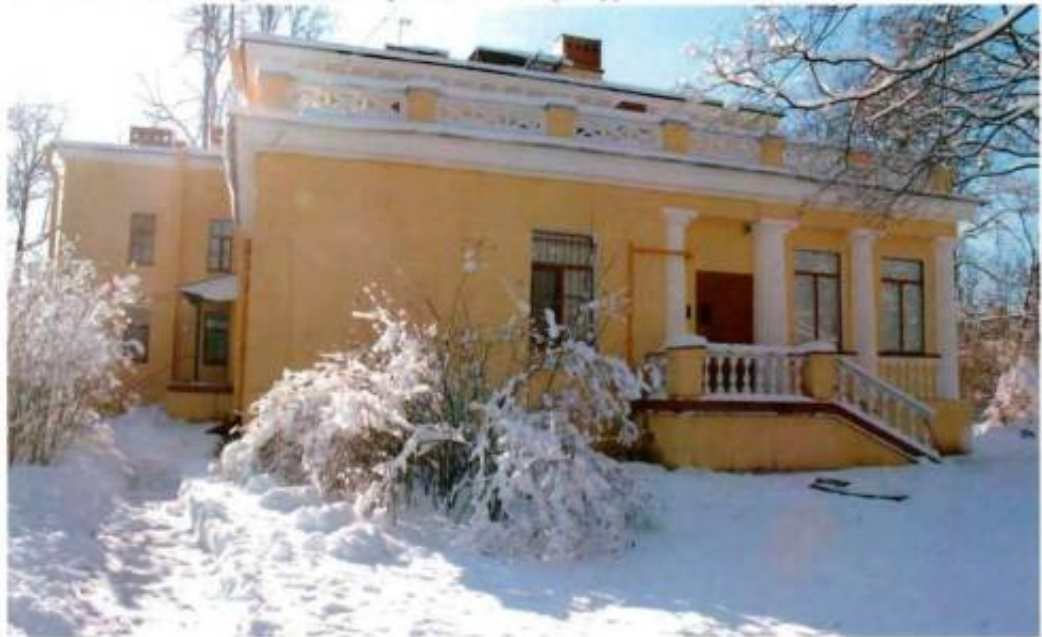
9. Общий вид на северо-западный фасад объекта культурного наследия.
