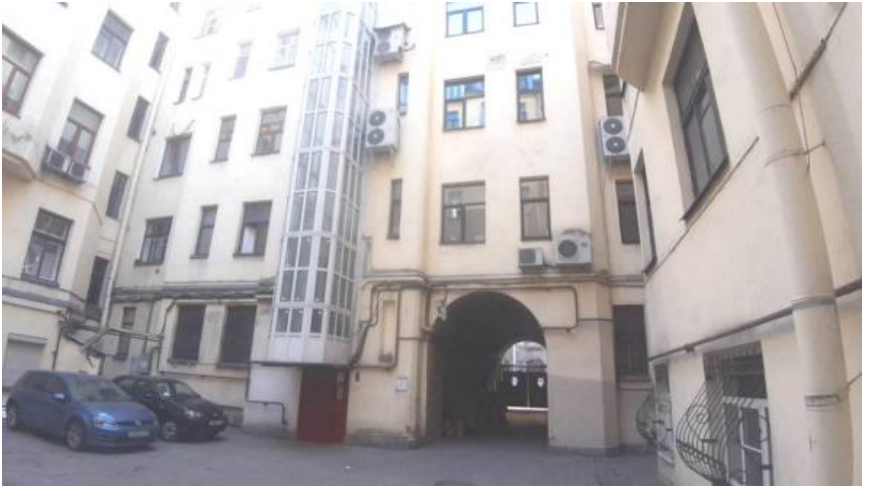
7. «Бывш. дом Гонцкевича» (Большой пр. П.С., д. 102, лит. А). Дворовый фасад. Фото мест установки оборудования и прокладки кабельных трасс. Штиглиц М.С. 03.04.2026.
