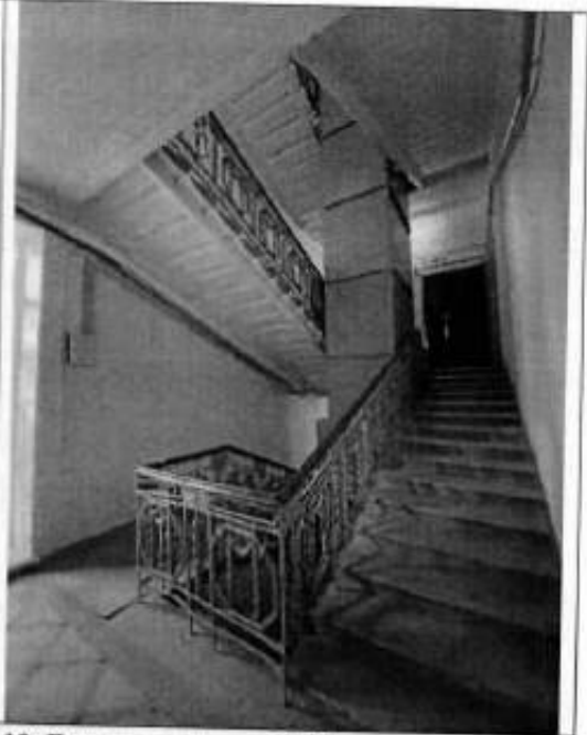
19. Лестничная клетка 2ЛК.
