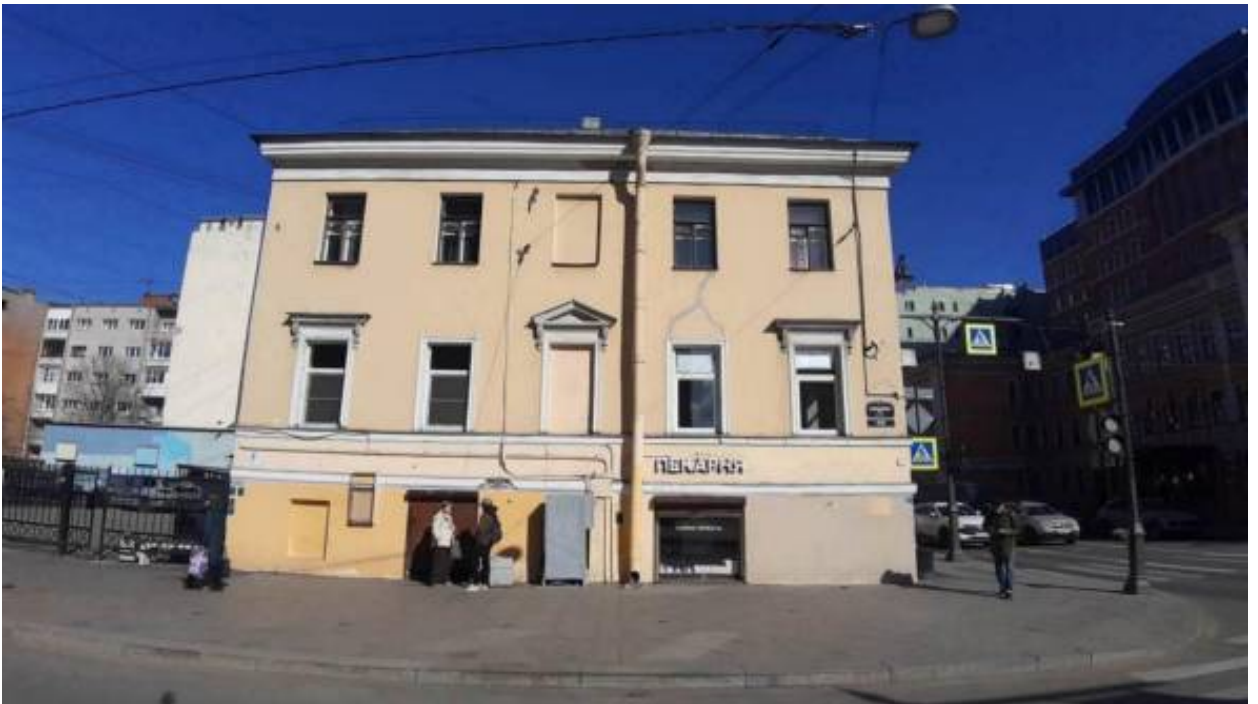
58. «Дом А.Лукина» (Шамшева ул., д. 5/50, лит. А). Лицевой фасад по Шамшева ул. Штиглиц М.С. 03.04.2026.
