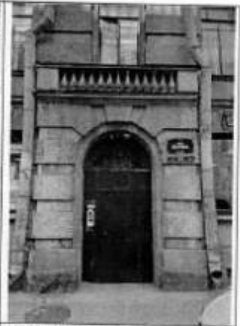
4. Фрагмент юго-западный фасада.
