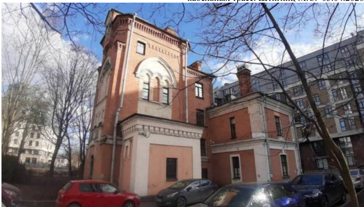
50. «Водонапорная башня с жилым флигелем «Городка Ф. К. Сан-Галли» (Ремесленная ул., д. 6, лит. А). Дворовый фасад. Фото мест установки оборудования и прокладки кабельных трасс. Штиглиц М.С. 03.04.2026.
