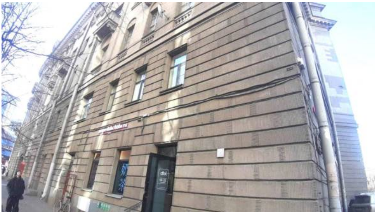
53. «Дом Ф.Ф.Нидермейера» (Каменноостровский пр., д. 39, лит. А). Дворовый фасад. Фото мест установки оборудования и прокладки кабельных трасс. Штиглиц М.С. 03.04.2026.
