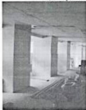
45. Фрагмент подвального пом.
