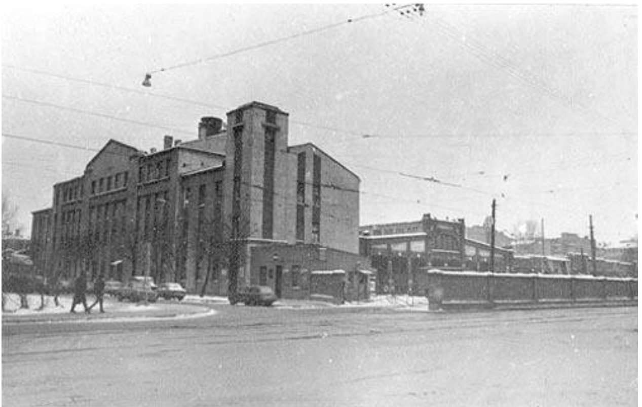
9. «Депо Конно-железной дороги и комплекс трампарка (4 здания)» (Большая Посадская ул., д. 24/2, лит. А). 1999 (24).
