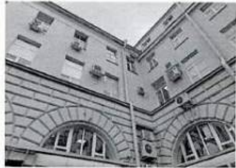
Фото 24. Фрагмент дворового фасада.
