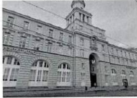
Фото 4. Лицевой фасад со стороны со стороны Kronверкского пр.
