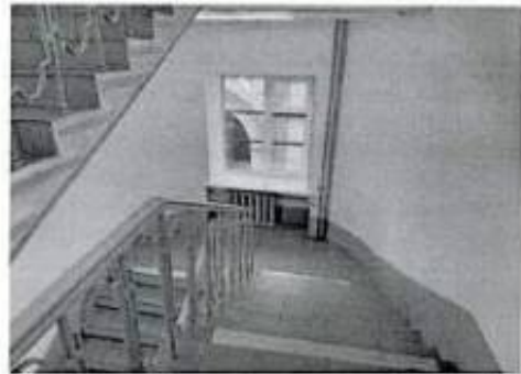
Фото 30. Лестница Л15 – служебная, фрагмент.
