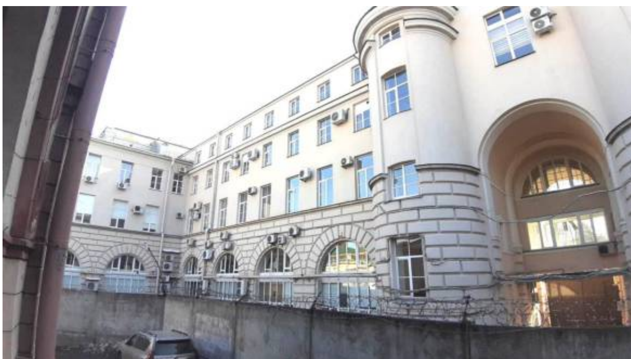
56. «Быв. дом городских учреждений "Городск. дом"» (Кронверкский пр., д. 49, лит. А). Дворовые фасады. Фото мест установки оборудования и прокладки кабельных трасс. Штиглиц М.С. 02.04.2026 г.
