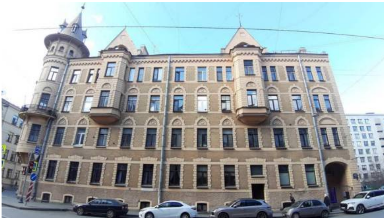
9. «Дом А.Ю. Кейбеля» (Барочная ул., д. 2, лит. А). Лицевой фасад. Штиглиц М.С. 02.04.2026 г.
