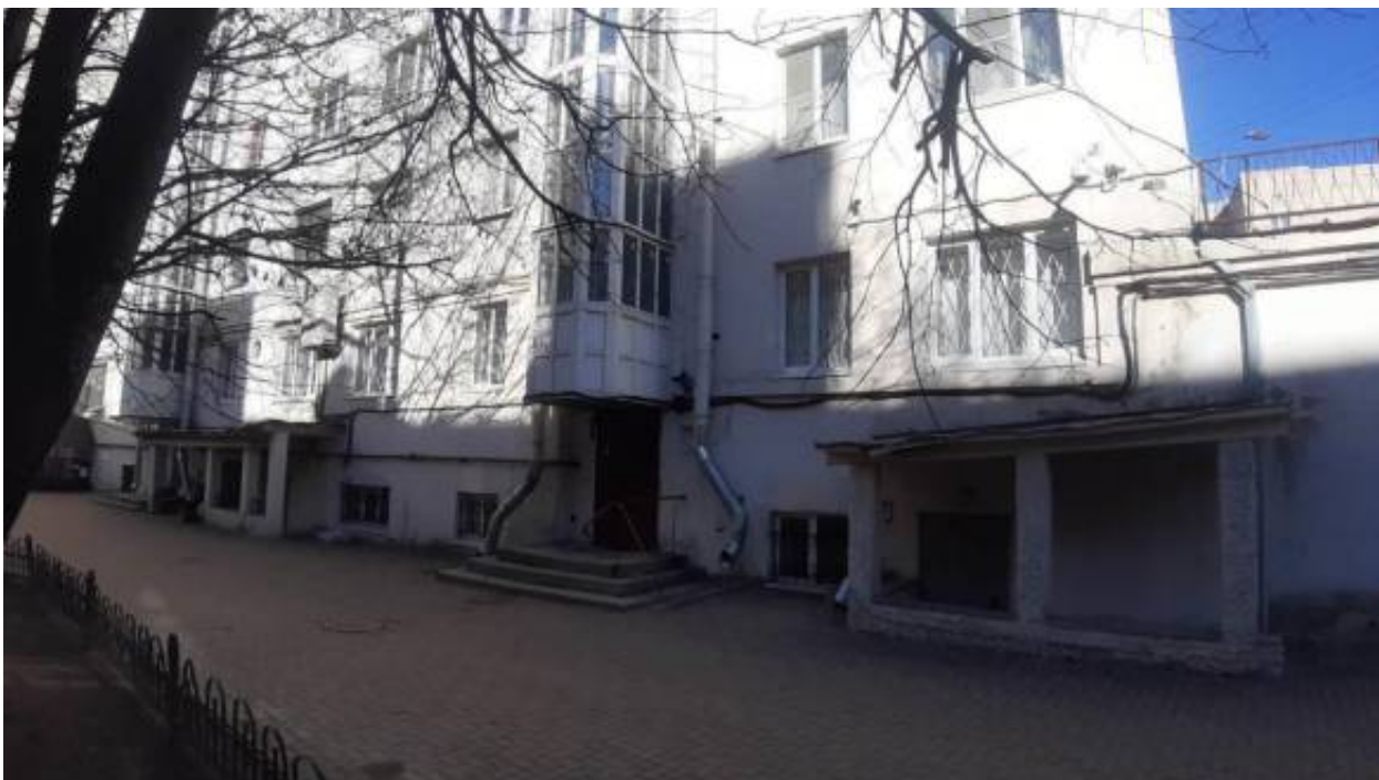
27. «Жилой дом» (Каменноостровский пр., д. 55, лит. А). Дворовые фасады. Фото мест установки оборудования и прокладки кабельных трасс. Штиглиц М.С. 02.04.2026 г.
