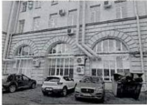
Фото 14. Фрагмент дворового фасада.
