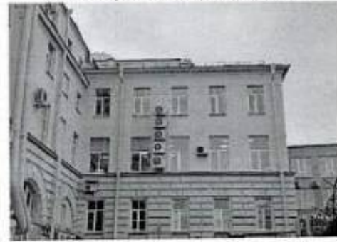
Фото 10. Фрагмент дворового фасада.
