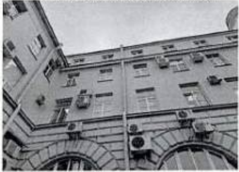
Фото 20. Фрагмент дворового фасада.
