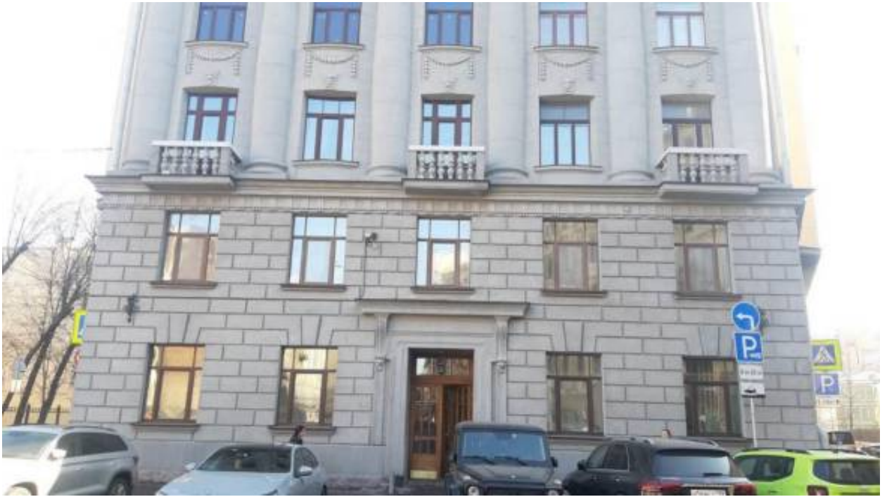
5. «Дом М.С. Берковского» (Съезжинская ул., д. 29/9, лит. А). Лицевой фасад по Татарскому пер. (фрагмент). Фото мест установки оборудования и прокладки кабельных трасс. Штиглиц М.С. 02.04.2026 г.
