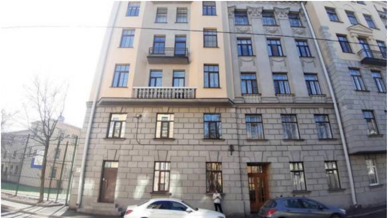
3. «Дом М.С. Берковского» (Съезжинская ул., д. 29/9, лит. А). Лицевой фасад по Съезжинской ул. (фрагмент). Фото мест установки оборудования и прокладки кабельных трасс. Штиглиц М.С. 02.04.2026 г.
