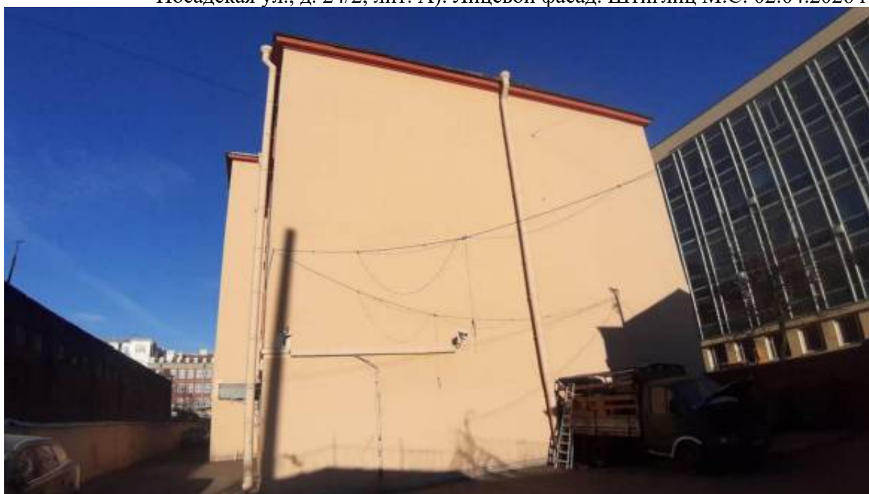
14. «Депо Конно-железной дороги и комплекс трампарка (4 здания)» (Большая Посадская ул., д. 24/2, лит. А). Дворовые фасады. Фото мест установки оборудования и прокладки кабельных трасс. Штиглиц М.С. 02.04.2026 г.
