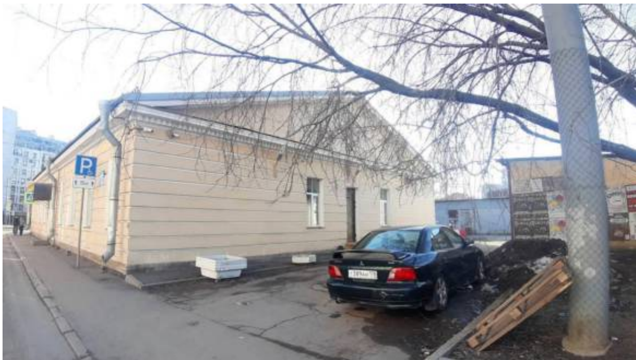
59. «Школа» (в составе «Казармы Гренадерского полка») (Чапаева ул., д. 24, лит. А). Дворовые фасады. Фото мест установки оборудования и прокладки кабельных трасс. Штиглиц М.С. 02.04.2026 г.
