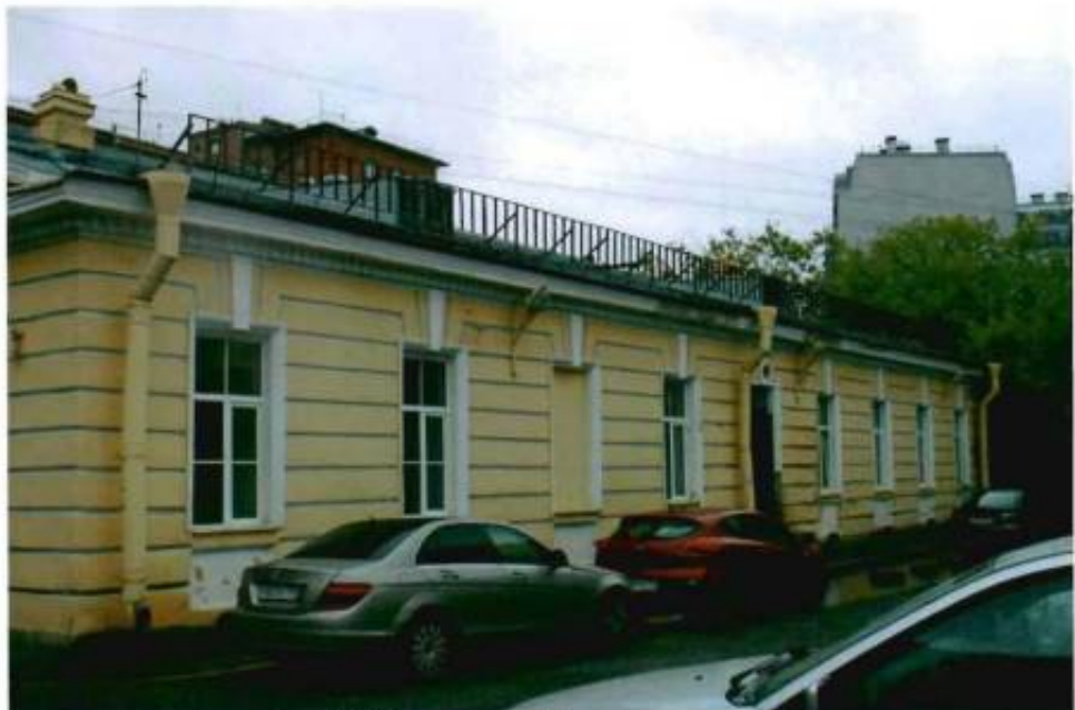
Фото №3. Вид на западный фасад со стороны двора.
