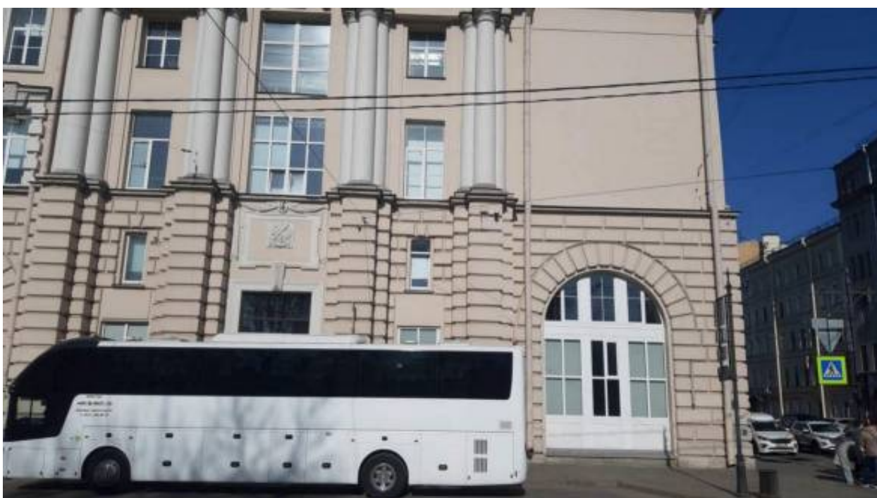
50. «Быв. дом городских учреждений "Городск. дом"» (Кронверкский пр., д. 49, лит. А). Лицевой фасад по Кронверкскому пр. (фрагмент). Фото мест установки оборудования и прокладки кабельных трасс. Штиглиц М.С. 02.04.2026 г.
