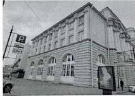
Фото 6. Лицевой фасад со стороны со стороны Саблинской ул.
