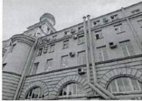
Фото 12. Фрагмент дворового фасада.
