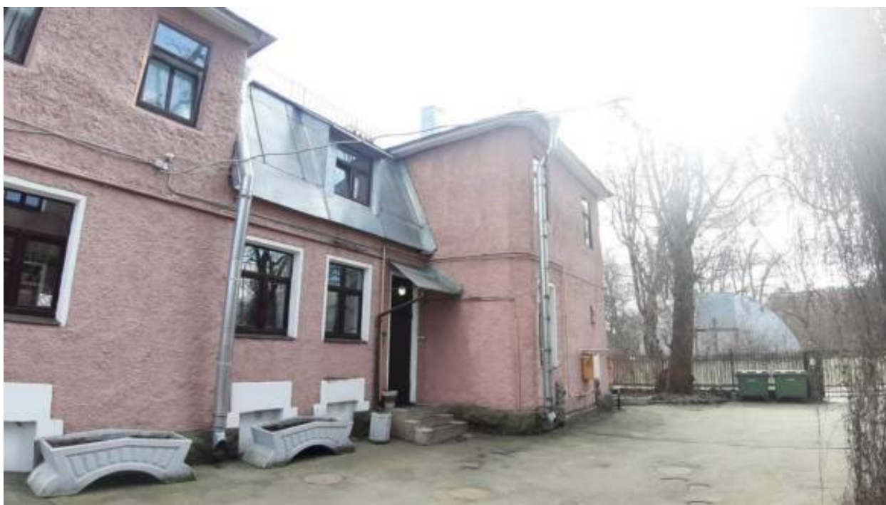
40. «Служебный флигель» (в составе «Особняк Ф.И. Андреевского») (Ольгина ул., д. 2, лит. Б). Дворовые фасады. Фото мест установки оборудования и прокладки кабельных трасс. Штиглиц М.С. 02.04.2026 г.
