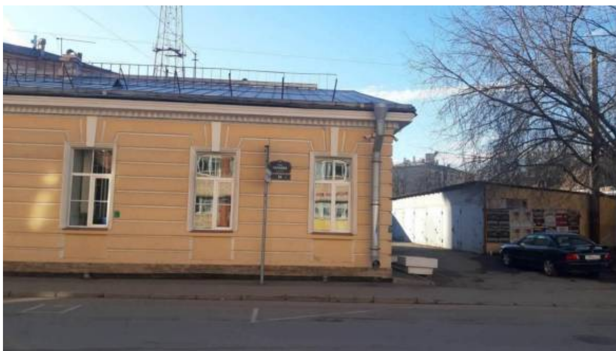
58. «Школа» (в составе «Казармы Гренадерского полка») (Чапаева ул., д. 24, лит. А). Лицевой фасад (фрагмент). Фото мест установки оборудования и прокладки кабельных трасс. Штиглиц М.С. 02.04.2026 г.
