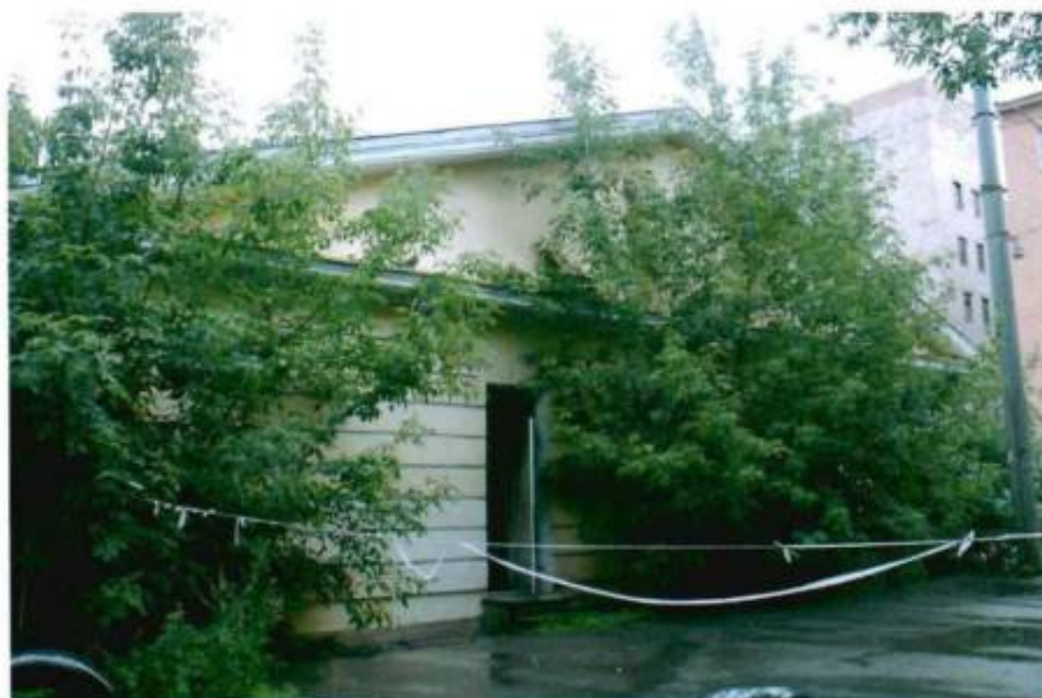
Фото №5. Вид на южный фасад.
