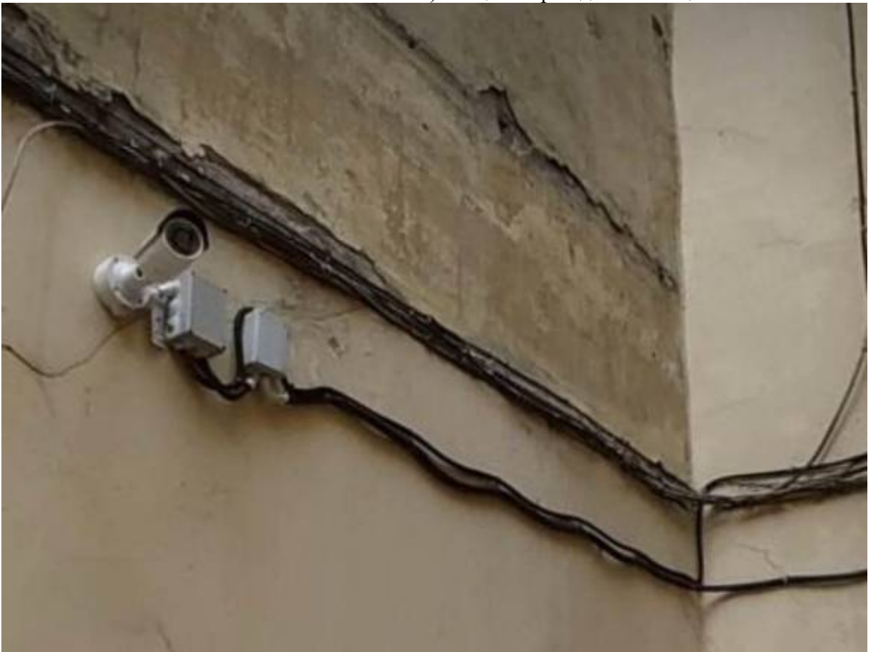
18. «Доходный дом и частная лечебница Б.М. Кальмейера» (Большой пр. П.С., д. 100, лит. А). Дворовые фасады. Фото мест установки оборудования и прокладки кабельных трасс. Штиглиц М.С. 02.04.2026 г.
