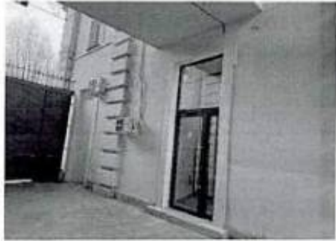
Фото 18. Фрагмент дворового фасада.
