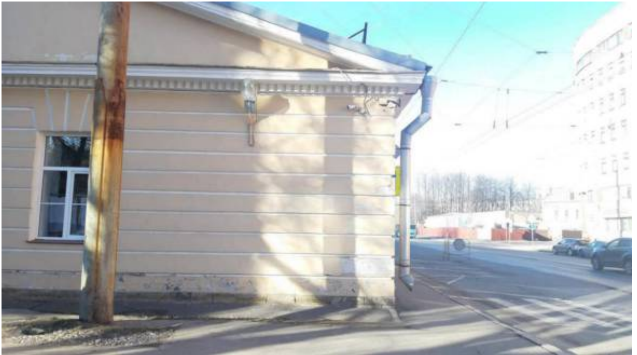
63. «Школа» (в составе «Казармы Гренадерского полка») (Чапаева ул., д. 24, лит. А). Дворовые фасады. Фото мест установки оборудования и прокладки кабельных трасс. Штиглиц М.С. 02.04.2026 г.
