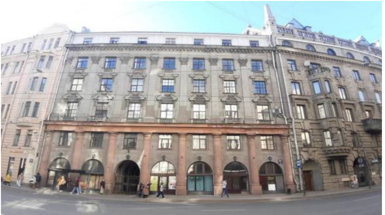
17. «Доходный дом и частная лечебница Б.М. Кальмейера» (Большой пр. П.С., д. 100, лит. А). Лицевой фасад. Штиглиц М.С. 02.04.2026 г.
