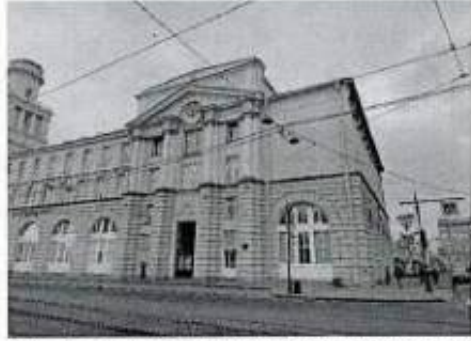
Фото 2. Лицевой фасад со стороны со стороны Kronverкского пр.
