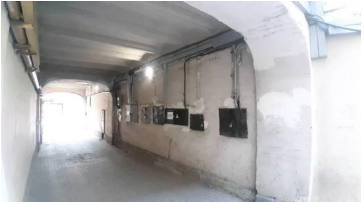
48. «Дом В.Г. Чубакова» Куйбышева ул., д. 23, лит. А). Арочный проезд. Фото мест установки оборудования и прокладки кабельных трасс. Штиглиц М.С. 02.04.2026 г.
