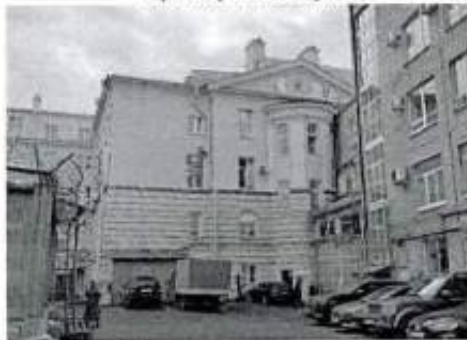
Фото 7. Фрагмент дворового фасада.
