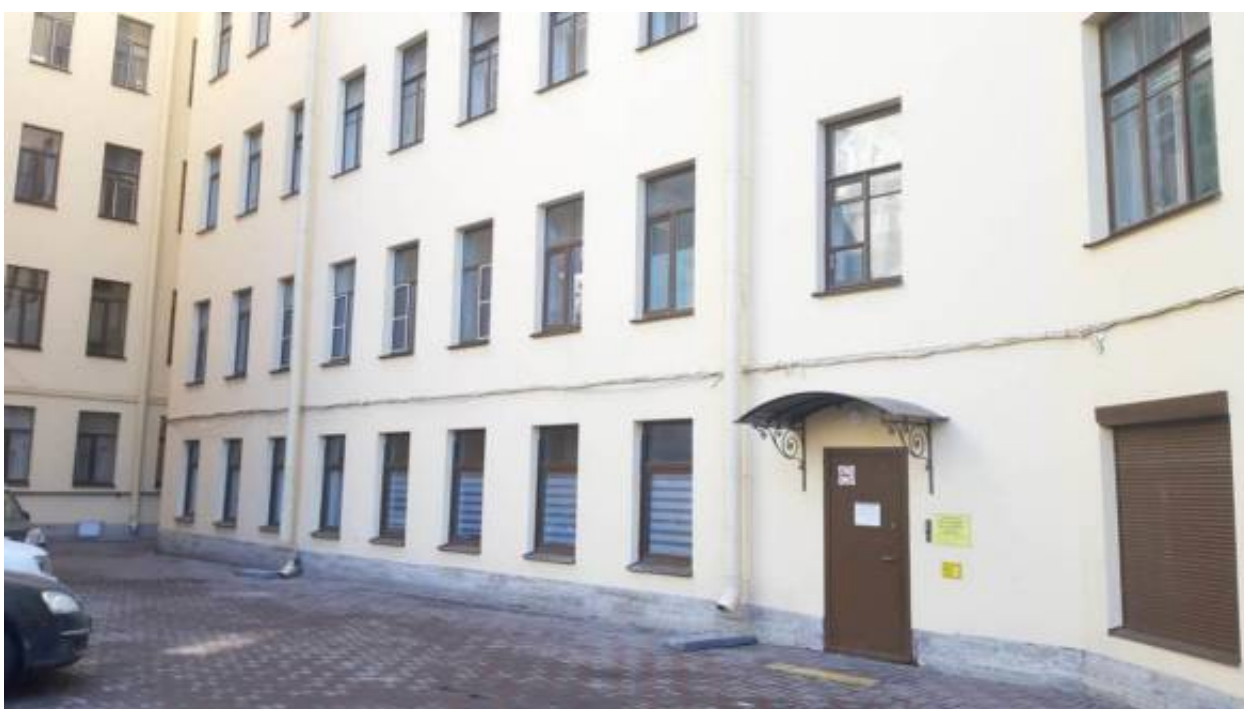
22. «Дом, в котором жил с 1915 по 1927 год и умер художник Б.М. Кустодиев» (Введенская ул., д. 7, лит. А). Дворовые фасады. Фото мест установки оборудования и прокладки кабельных трасс. Штиглиц М.С. 02.04.2026 г.
