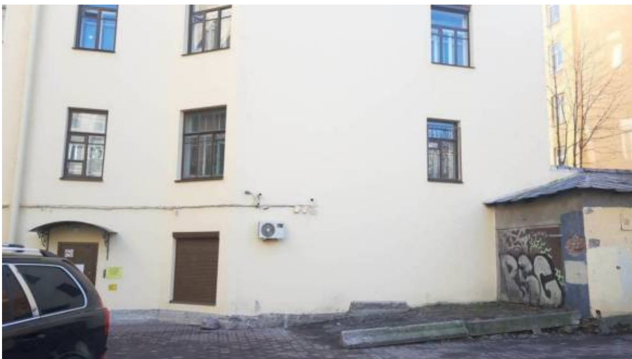
21. «Дом, в котором жил с 1915 по 1927 год и умер художник Б.М. Кустодиев» (Введенская ул., д. 7, лит. А). Дворовые фасады. Фото мест установки оборудования и прокладки кабельных трасс. Штиглиц М.С. 02.04.2026 г.
