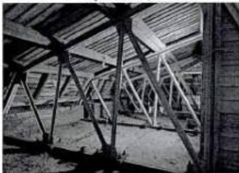
Фото 37. Деревянная стропильная система по металлическим клепаным фермам.
