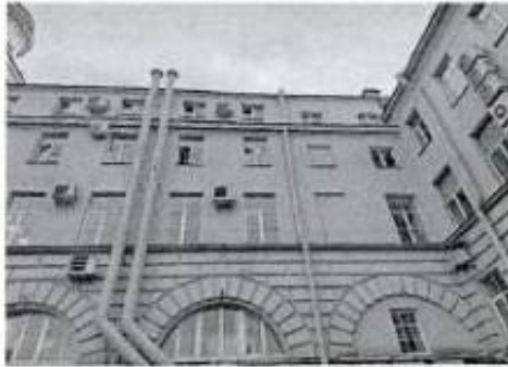
Фото 11. Фрагмент дворового фасада.
