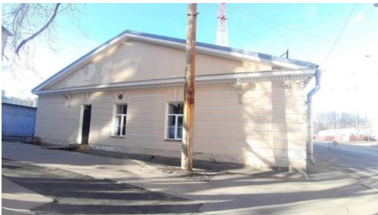
62. «Школа» (в составе «Казармы Гренадерского полка») (Чапаева ул., д. 24, лит. А). Дворовые фасады. Фото мест установки оборудования и прокладки кабельных трасс. Штиглиц М.С. 02.04.2026 г.
