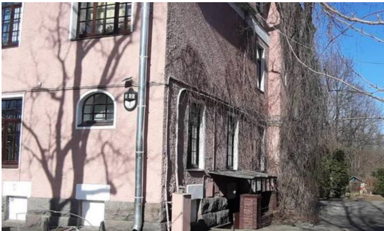
37. «Особняк» (в составе «Особняк Ф.И. Андреевского») (Ольгина ул., д. 2, лит. А). Дворовые фасады. Фото мест установки оборудования и прокладки кабельных трасс. Штиглиц М.С. 02.04.2026 г.
