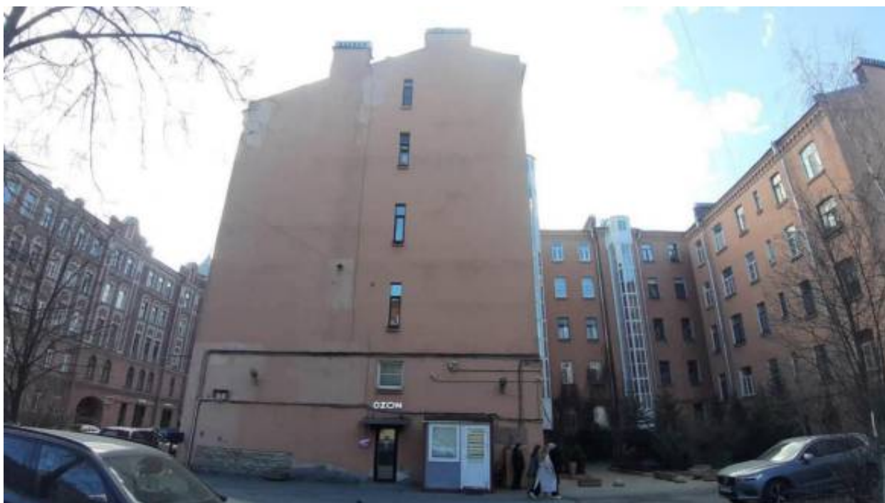
10. «Дом А.Ю. Кейбеля» (Барочная ул., д. 2, лит. А). Дворовые фасады. Фото мест установки оборудования и прокладки кабельных трасс. Штиглиц М.С. 02.04.2026 г.
