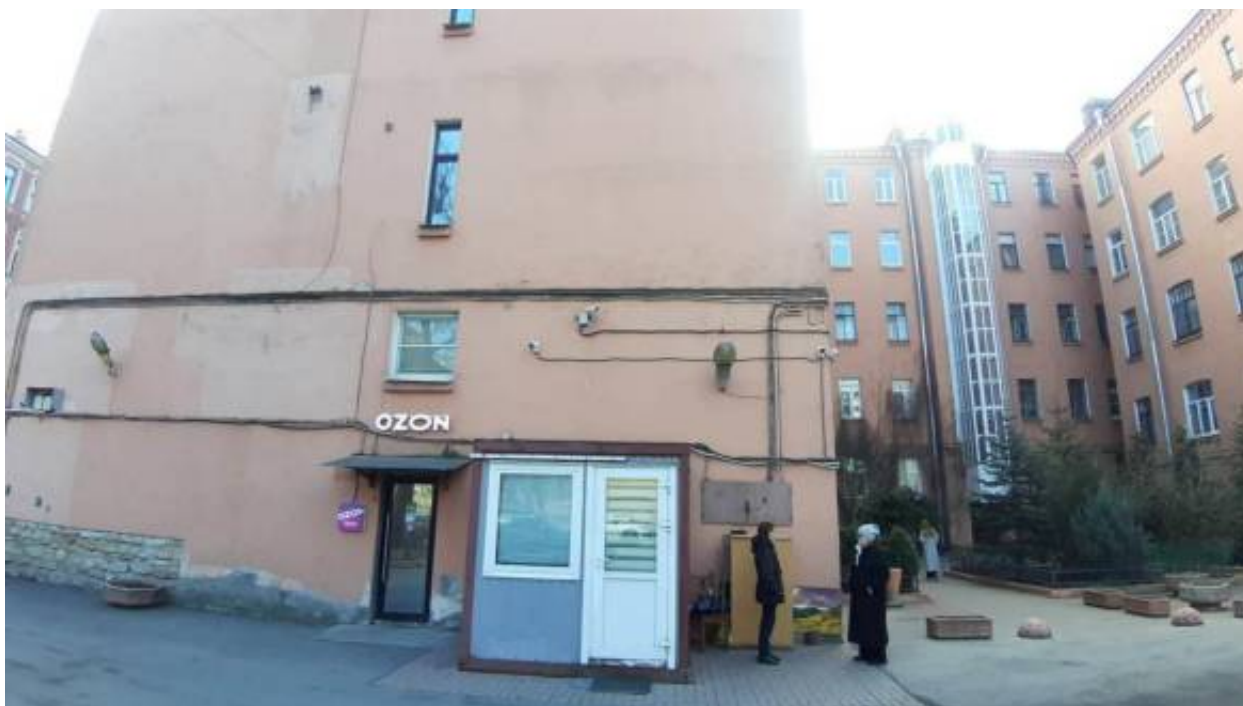
11. «Дом А.Ю. Кейбеля» (Барочная ул., д. 2, лит. А). Дворовые фасады. Фото мест установки оборудования и прокладки кабельных трасс. Штиглиц М.С. 02.04.2026 г.
