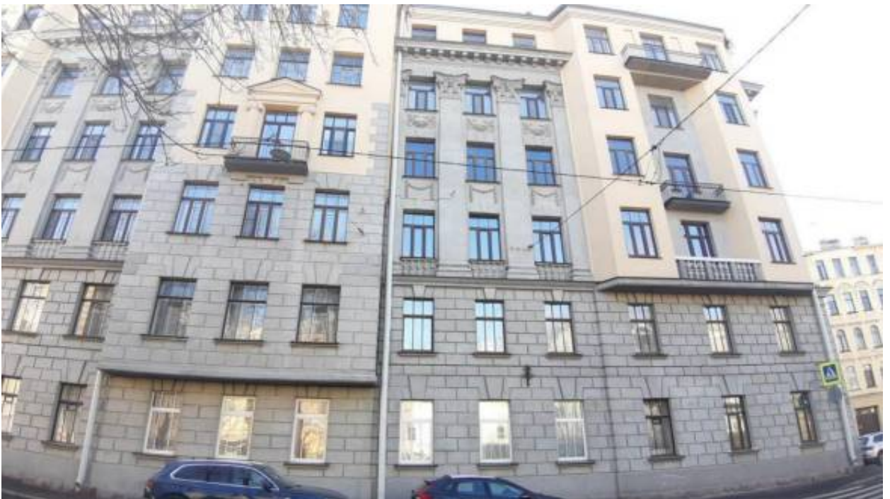
2. «Дом М.С. Берковского» (Съезжинская ул., д. 29/9, лит. А). Лицевой фасад по Съезжинской ул. (фрагмент). Фото мест установки оборудования и прокладки кабельных трасс. Штиглиц М.С. 02.04.2026 г.
