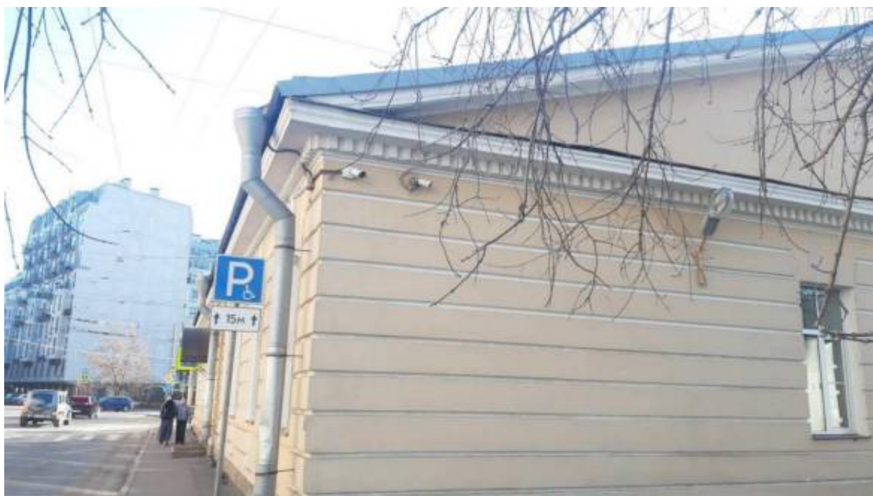
60. «Школа» (в составе «Казармы Гренадерского полка») (Чапаева ул., д. 24, лит. А). Дворовые фасады. Фото мест установки оборудования и прокладки кабельных трасс. Штиглиц М.С. 02.04.2026 г.
