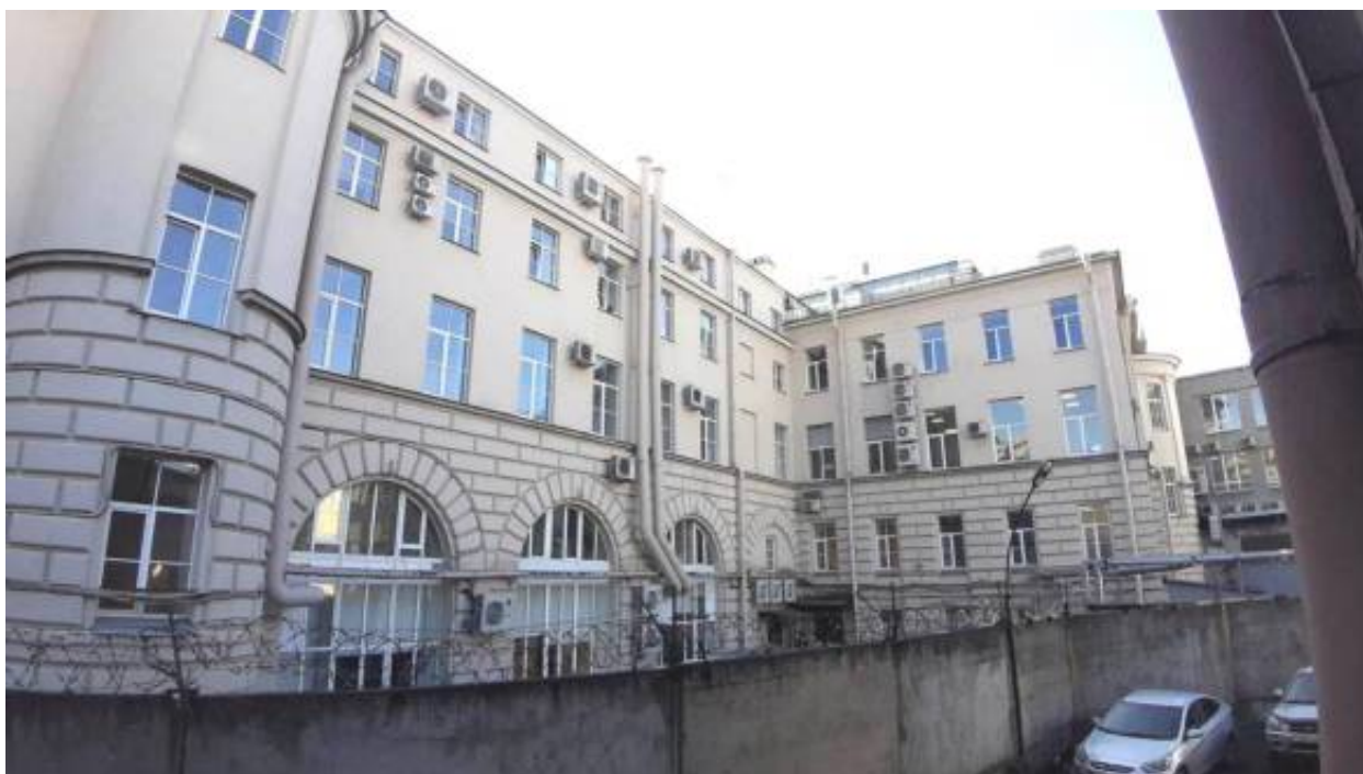
55. «Быв. дом городских учреждений "Городск. дом"» (Кронверкский пр., д. 49, лит. А). Дворовые фасады. Фото мест установки оборудования и прокладки кабельных трасс. Штиглиц М.С. 02.04.2026 г.
