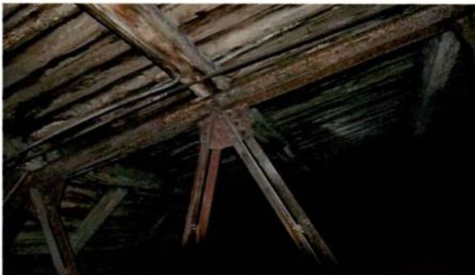
8. Деревянная стропильная система по металлическим клепаным фермам.
