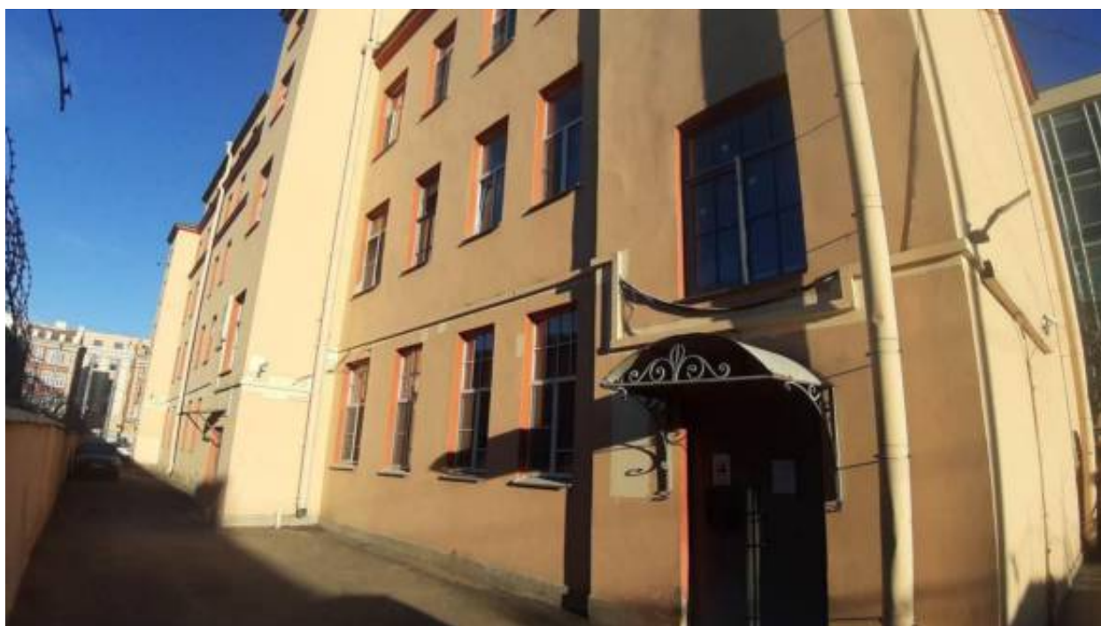
16. «Депо Конно-железной дороги и комплекс трампарка (4 здания)» (Большая Посадская ул., д. 24/2, лит. А). Дворовые фасады. Фото мест установки оборудования и прокладки кабельных трасс. Штиглиц М.С. 02.04.2026 г.
