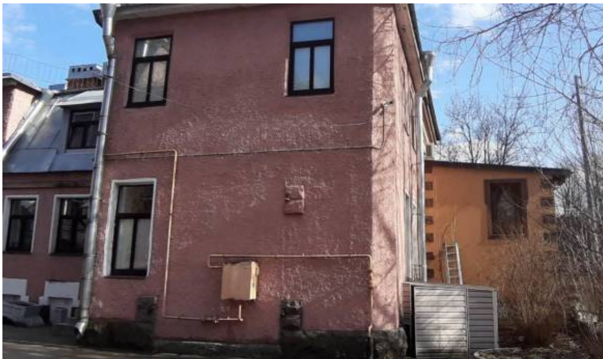
41. «Служебный флигель» (в составе «Особняк Ф.И. Андреевского») (Ольгина ул., д. 2, лит. Б). Дворовые фасады. Фото мест установки оборудования и прокладки кабельных трасс. Штиглиц М.С. 02.04.2026 г.
