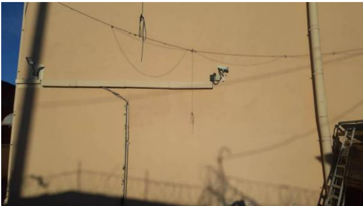
15. «Депо Конно-железной дороги и комплекс трампарка (4 здания)» (Большая Посадская ул., д. 24/2, лит. А). Дворовые фасады. Фото мест установки оборудования и прокладки кабельных трасс. Штиглиц М.С. 02.04.2026 г.
