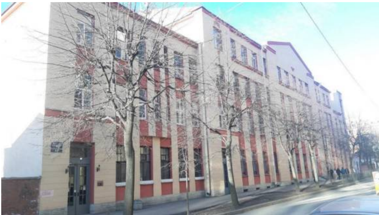
13. «Депо Конно-железной дороги и комплекс трампарка (4 здания)» (Большая Посадская ул., д. 24/2, лит. А). Лицевой фасад. Штиглиц М.С. 02.04.2026 г.
