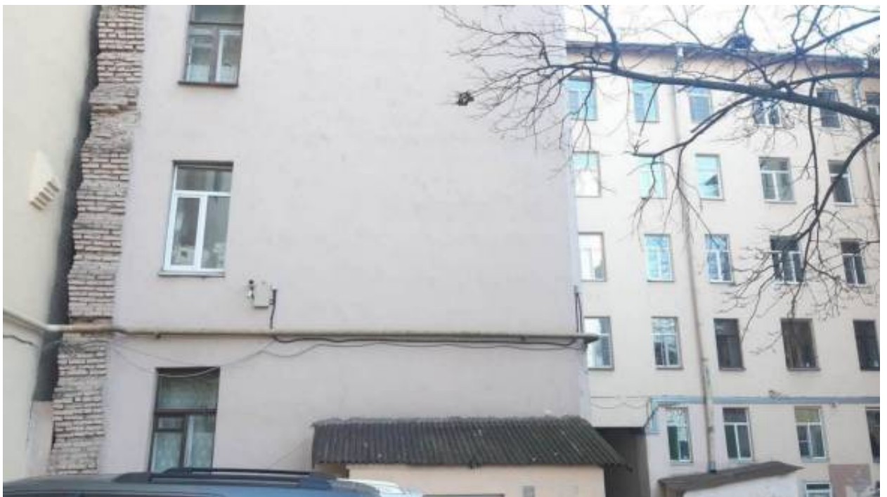
44. «Дом В.Г. Чубакова» Куйбышева ул., д. 23, лит. А). Дворовые фасады. Фото мест установки оборудования и прокладки кабельных трасс. Штиглиц М.С. 02.04.2026 г.
