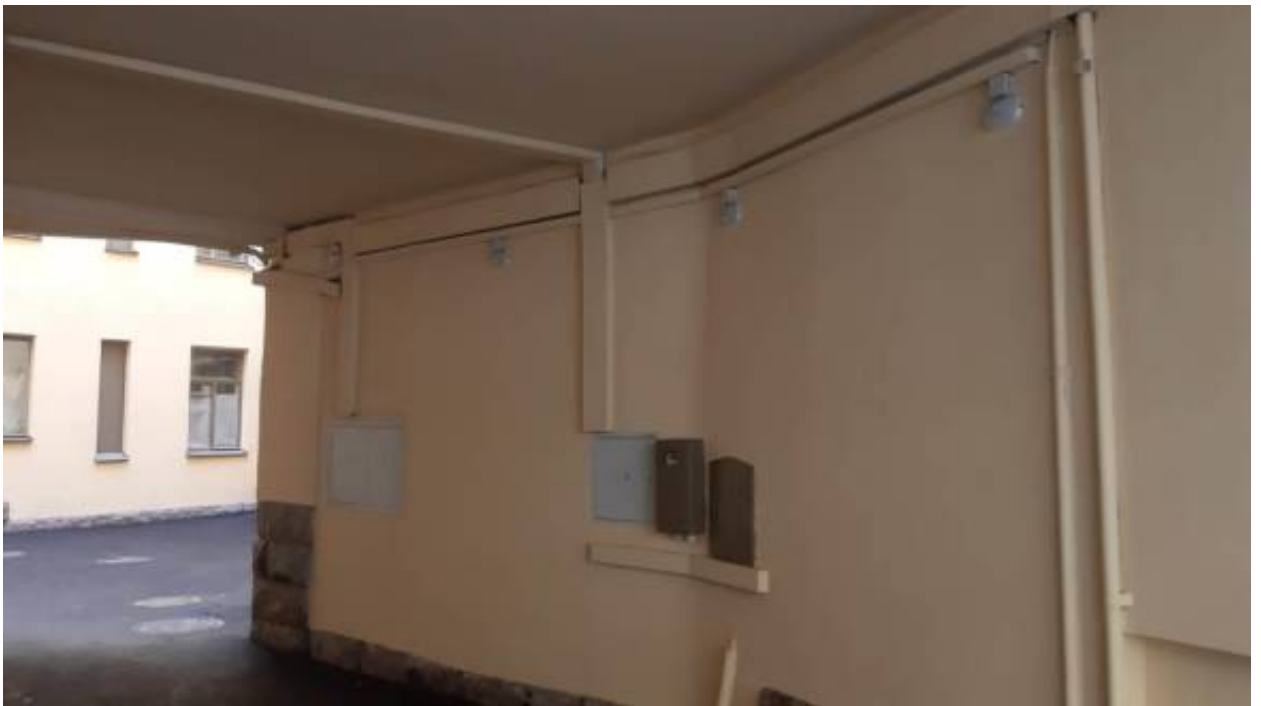
6. «Дом М.С. Берковского» (Съезжинская ул., д. 29/9, лит. А). Арочный проезд. Фото мест установки оборудования и прокладки кабельных трасс. Штиглиц М.С. 02.04.2026 г.
