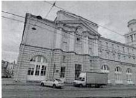
Фото 5. Лицевой фасад со стороны со стороны Кронверкского пр.
