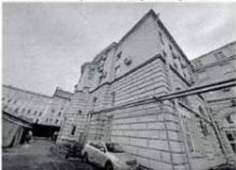
Фото 27. Фрагмент дворового фасада.
