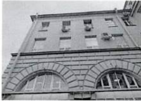
Фото 23. Фрагмент дворового фасада.
