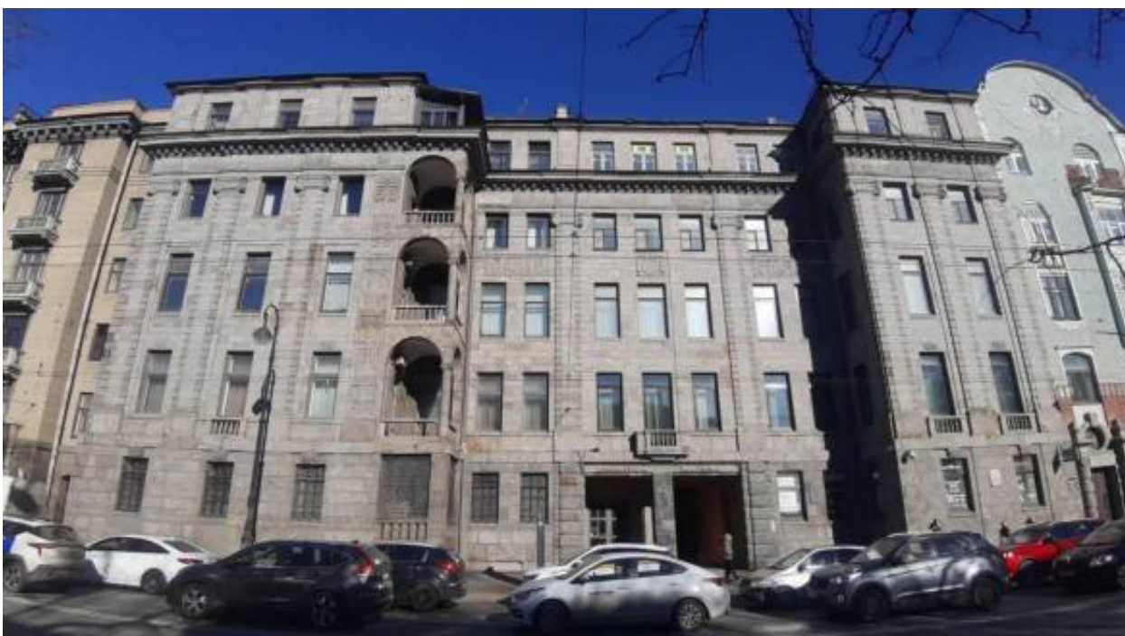
28. «Дом доходный Сомова (Маркова)» (Каменноостровский пр., д. 63, лит. А). Лицевой фасад. Штиглиц М.С. 02.04.2026 г.
