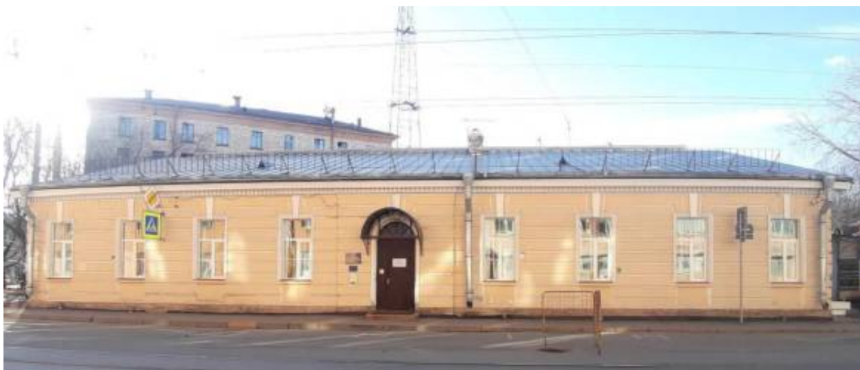
57. «Школа» (в составе «Казармы Гренадерского полка») (Чапаева ул., д. 24, лит. А). Лицевой фасад. Штиглиц М.С. 02.04.2026 г.
