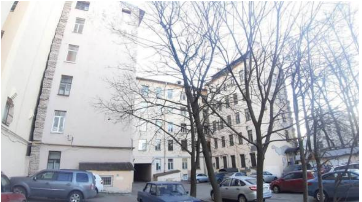
43. «Дом В.Г. Чубакова» Куйбышева ул., д. 23, лит. А). Дворовые фасады. Фото мест установки оборудования и прокладки кабельных трасс. Штиглиц М.С. 02.04.2026 г.
