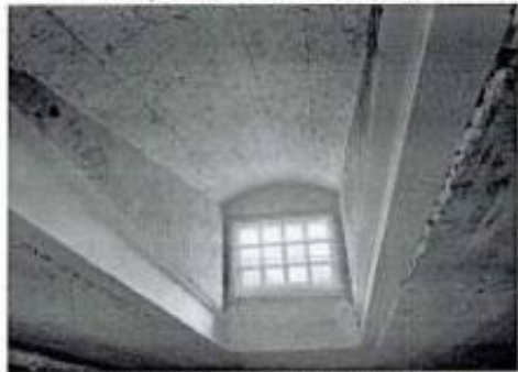
Фото 38. Цилиндрический уплощенный свод в уровне чердачного пространства.
