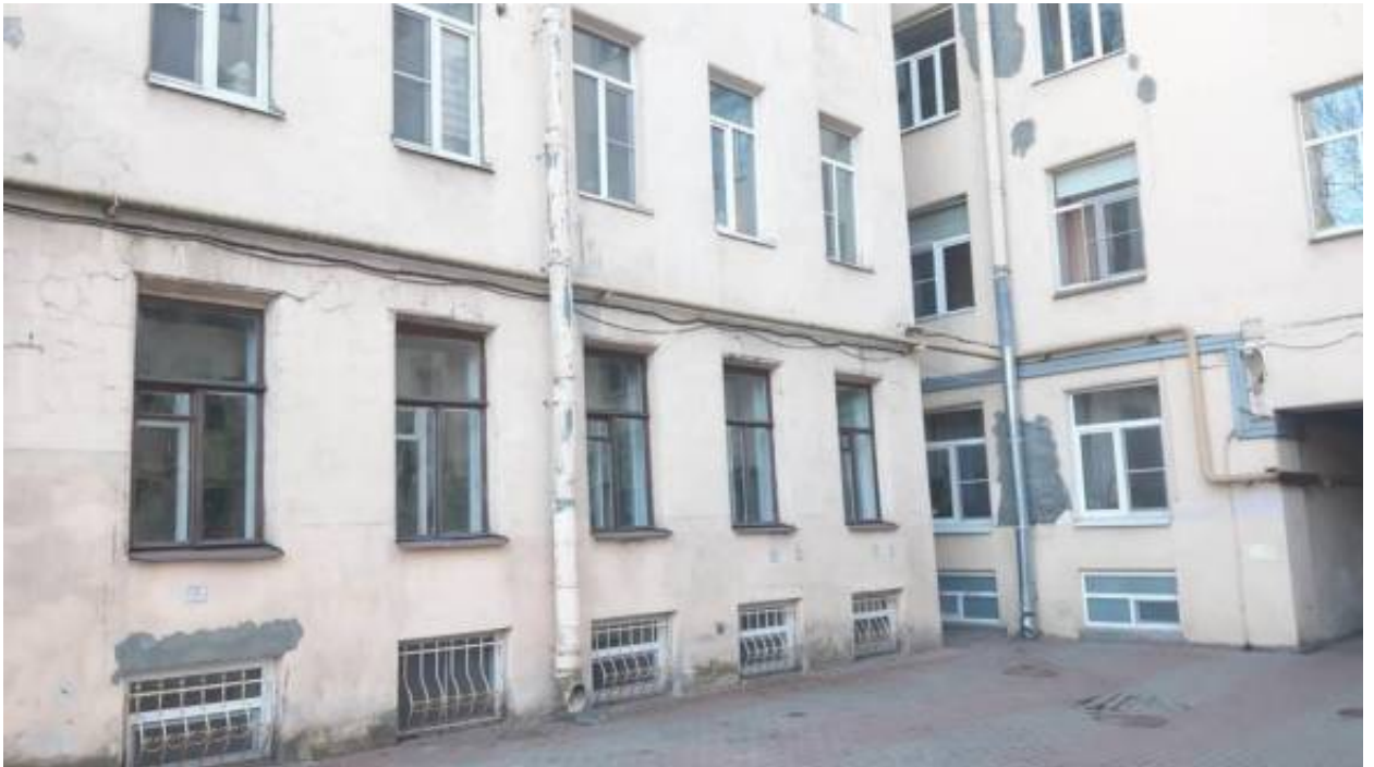
45. «Дом В.Г. Чубакова» Куйбышева ул., д. 23, лит. А). Дворовые фасады. Фото мест установки оборудования и прокладки кабельных трасс. Штиглиц М.С. 02.04.2026 г.
