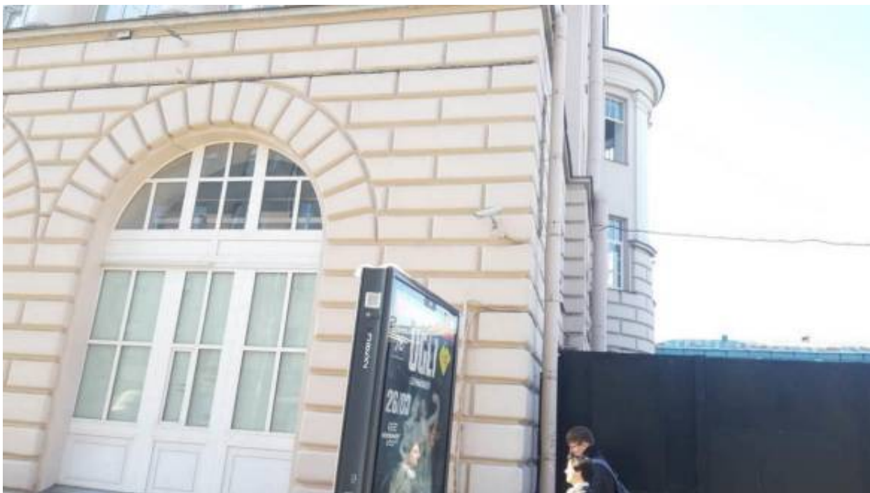
53. «Быв. дом городских учреждений "Городск. дом"» (Кронверкский пр., д. 49, лит. А). Лицевой фасад по Сытнинской пл. (фрагмент). Фото мест установки оборудования и прокладки кабельных трасс. Штиглиц М.С. 02.04.2026 г.
