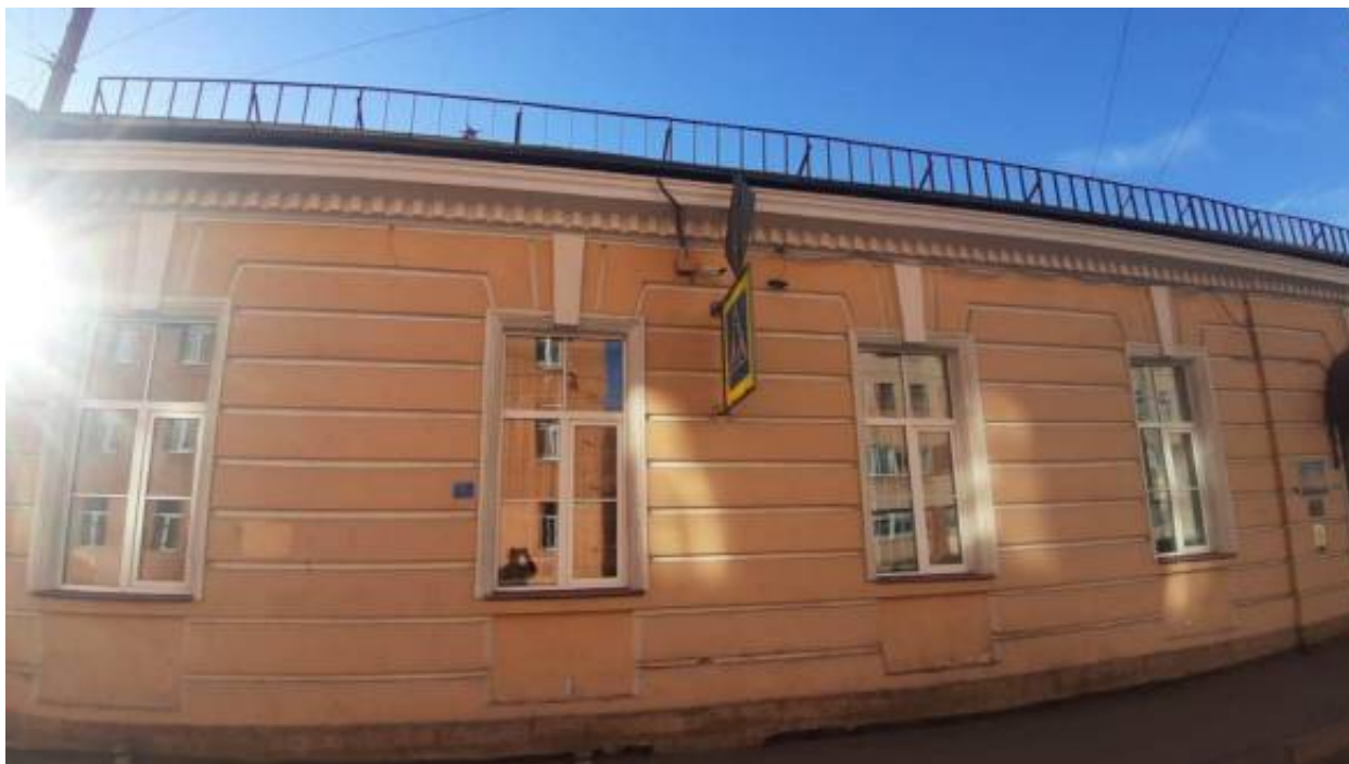
61. «Школа» (в составе «Казармы Гренадерского полка») (Чапаева ул., д. 24, лит. А). Лицевой фасад (фрагмент). Фото мест установки оборудования и прокладки кабельных трасс. Штиглиц М.С. 02.04.2026 г.
