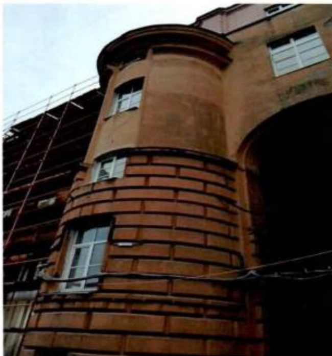
9. Полуциркульные объемы лестничных клеток.
