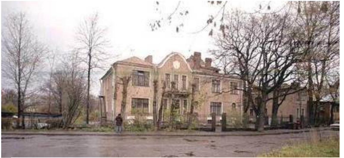
33. «Особняк Ф.И. Андреевского» (Ольгина ул., д. 2, лит. А, Б). Фото из ЕИСТ-2002 (между 1999 и 2001).
