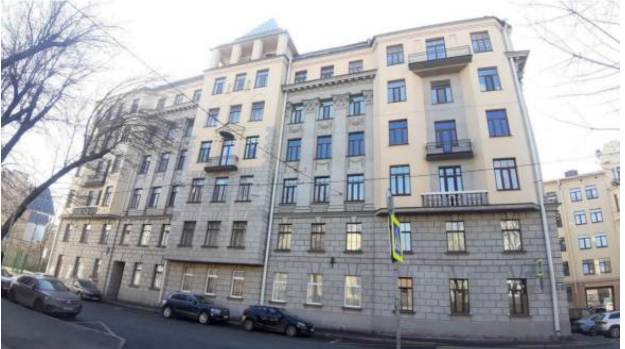
1. «Дом М.С. Берковского» (Съезжинская ул., д. 29/9, лит. А). Лицевой фасад по Съезжинской ул. Штиглиц М.С. 02.04.2026 г.
