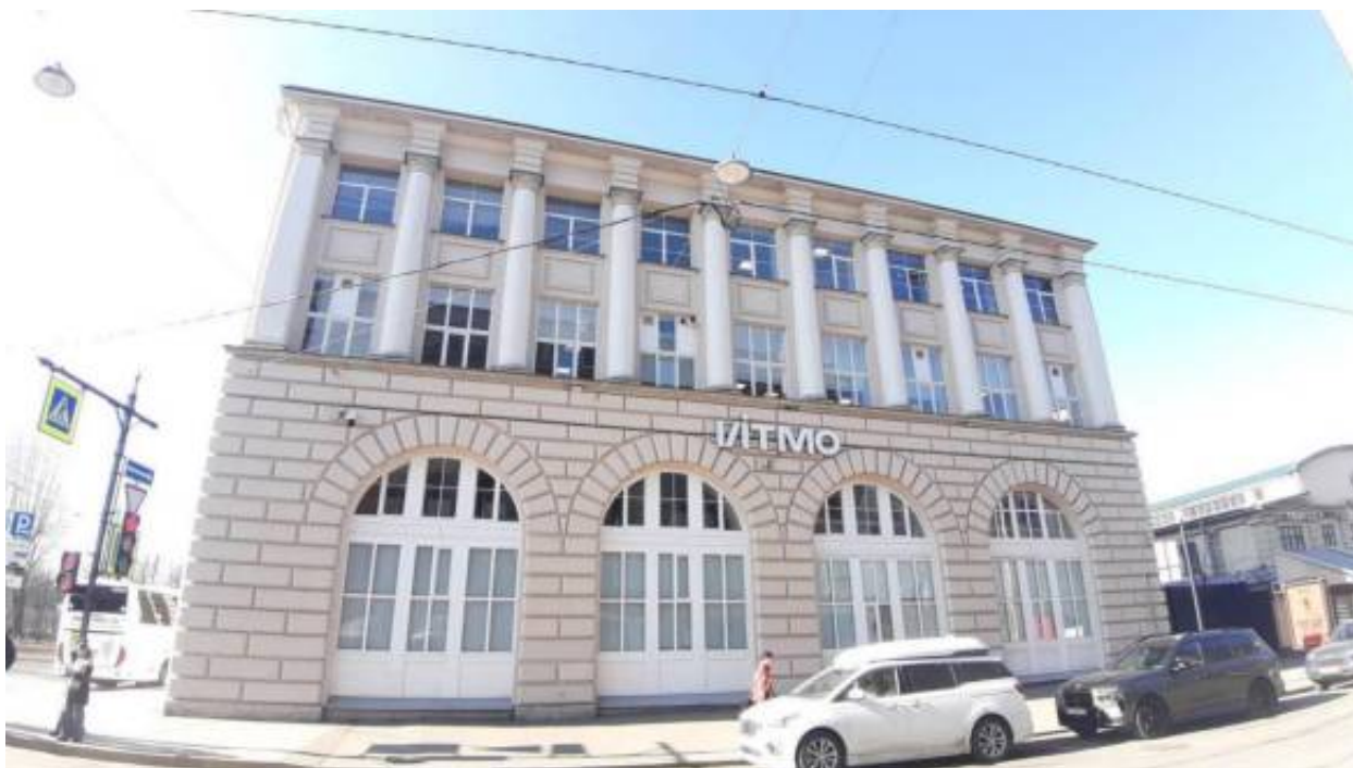
51. «Быв. дом городских учреждений "Городск. дом"» (Кронверкский пр., д. 49, лит. А). Лицевой фасад по Сытнинской пл. Штиглиц М.С. 02.04.2026 г.
