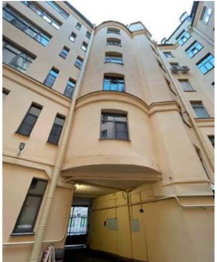
7. «Дом М.С. Берковского» (Съезжинская ул., д. 29/9, лит. А). Дворовые фасады. Фото мест установки оборудования и прокладки кабельных трасс. Штиглиц М.С. 02.04.2026 г.
