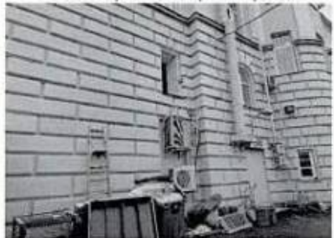
Фото 28. Фрагмент дворового фасада.
