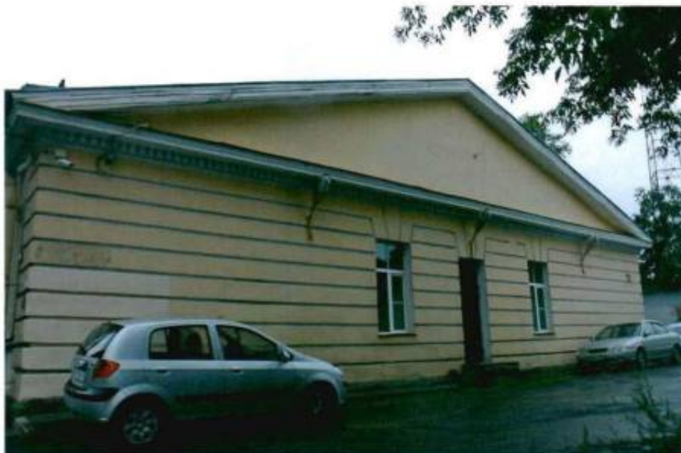
Фото №4. Вид на северный фасад.
