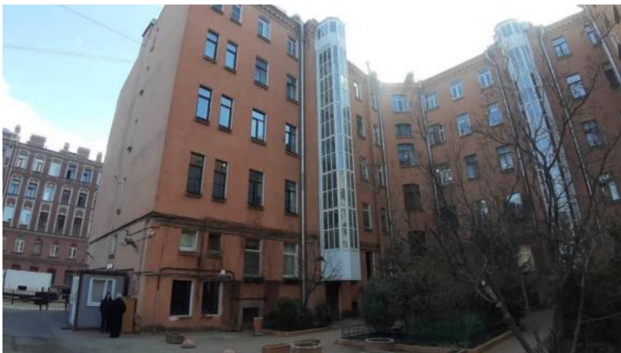
12. «Дом А.Ю. Кейбеля» (Барочная ул., д. 2, лит. А). Дворовые фасады. Фото мест установки оборудования и прокладки кабельных трасс. Штиглиц М.С. 02.04.2026 г.
