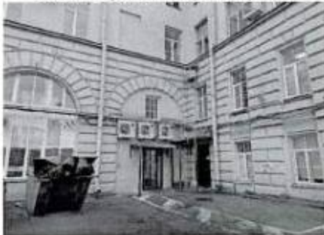
Фото 13. Фрагмент дворового фасада.
