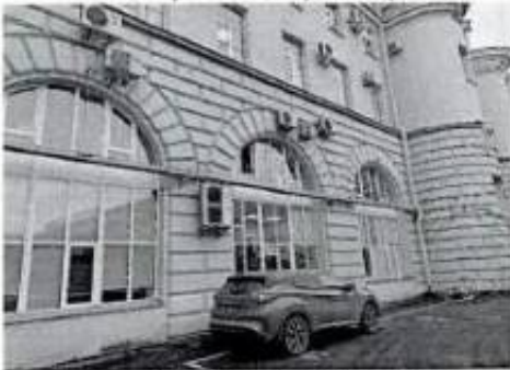
Фото 21. Фрагмент дворового фасада.
