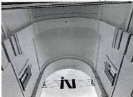
Фото 39. Цилиндрический свод на подпружных арках воротного проезда.
