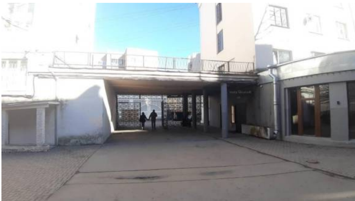
26. «Жилой дом» (Каменноостровский пр., д. 55, лит. А). Дворовые фасады. Фото мест установки оборудования и прокладки кабельных трасс. Штиглиц М.С. 02.04.2026 г.
