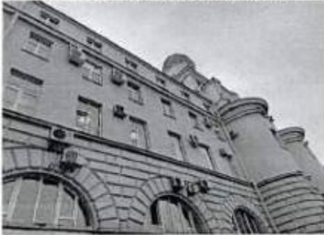
Фото 19. Фрагмент дворового фасада.
