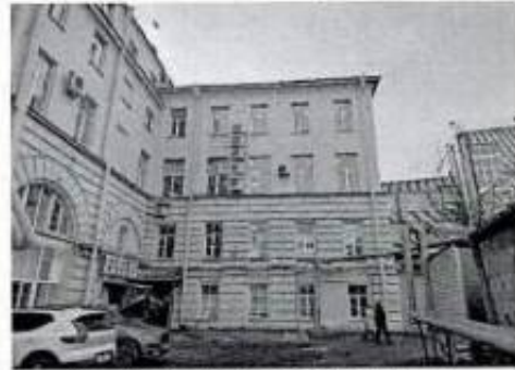
Фото 8. Фрагмент дворового фасада.
