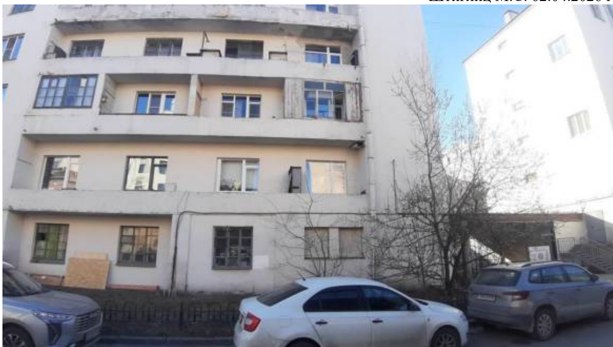
24. «Жилой дом» (Каменноостровский пр., д. 55, лит. А). Восточный фасад (фрагмент). Фото мест установки оборудования и прокладки кабельных трасс. Штиглиц М.С. 02.04.2026 г.
