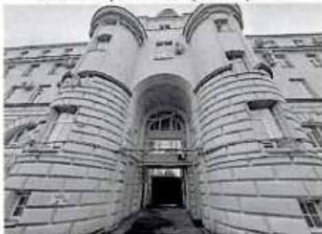
Фото 15. Фрагмент дворового фасада.
