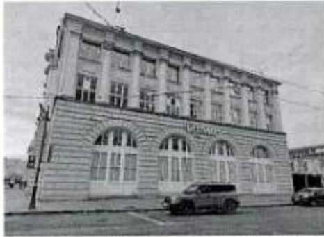
Фото 1. Лицевой фасад со стороны со стороны Сытинской ул.
