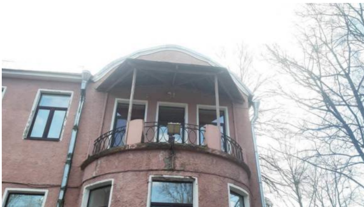
36. «Особняк» (в составе «Особняк Ф.И. Андреевского») (Ольгина ул., д. 2, лит. А). Дворовые фасады. Фото мест установки оборудования и прокладки кабельных трасс. Штиглиц М.С. 02.04.2026 г.
