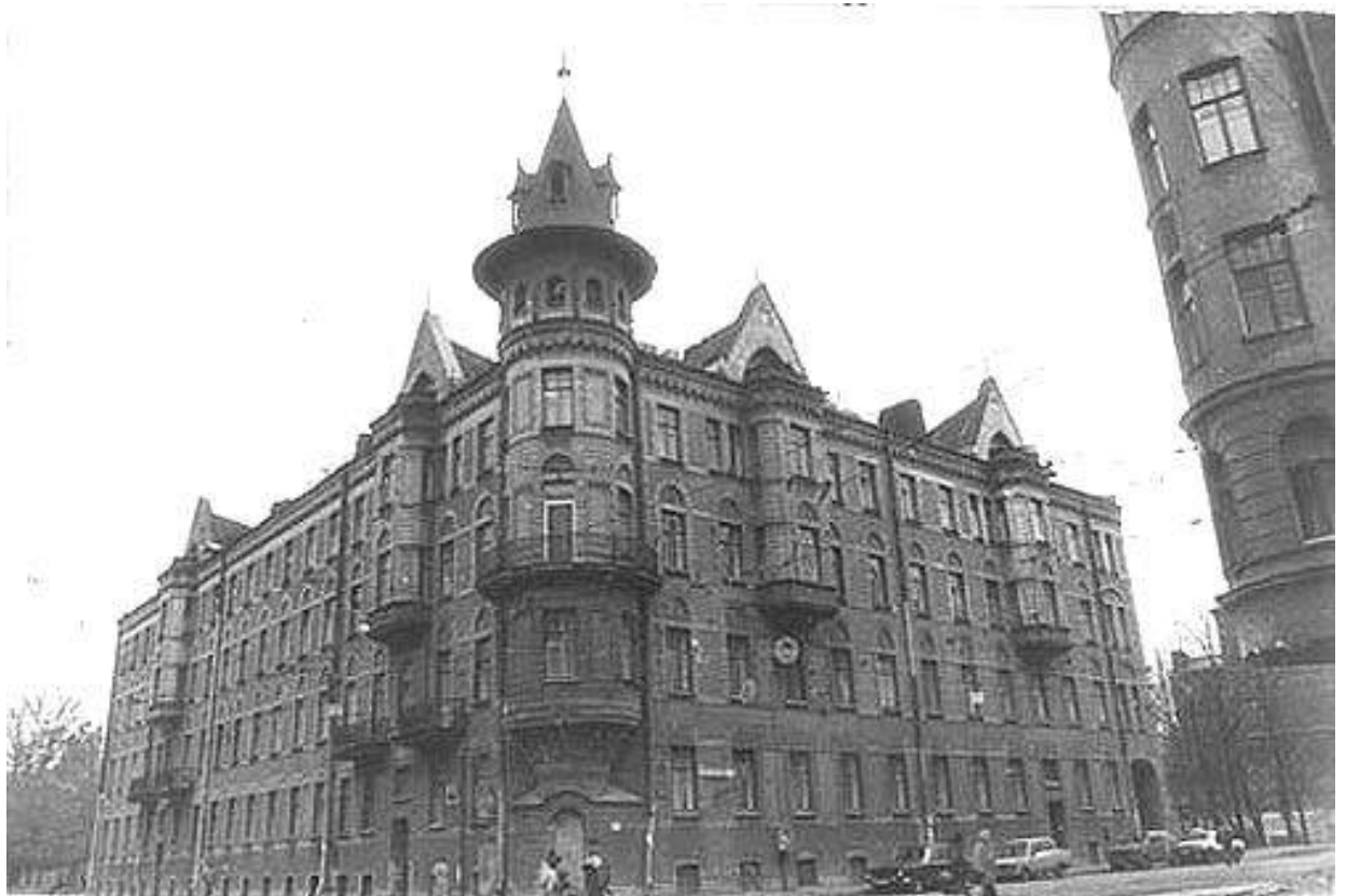
4. «Дом А.Ю. Кейбеля» (Барочная ул., д. 2, лит. А). 1999 (24).
