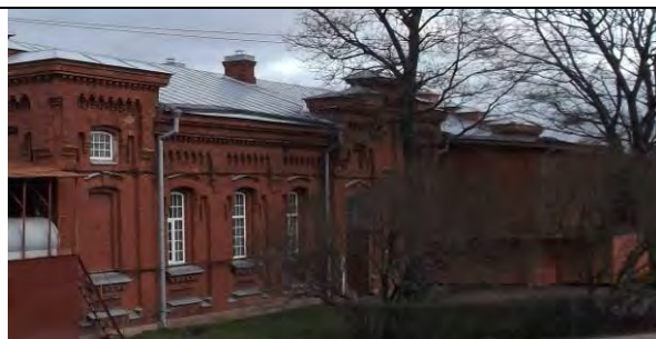
Южный фасад юго-западного корпуса
