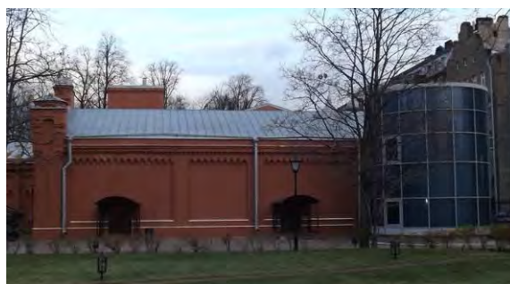
Южный фасад южного корпуса
