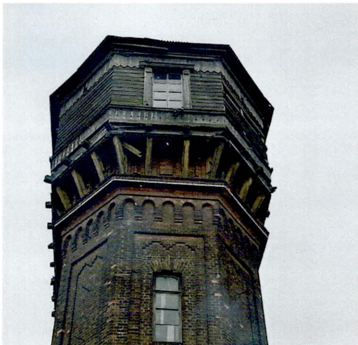
5. Общий вид на верхнюю часть башни.
