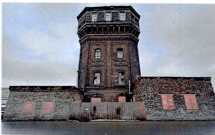
4. Общий вид с западной стороны.
