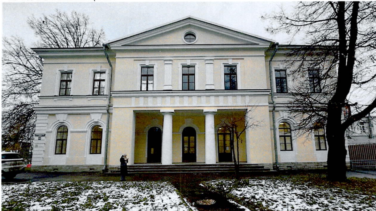
1. Общий вид на южный фасад.
