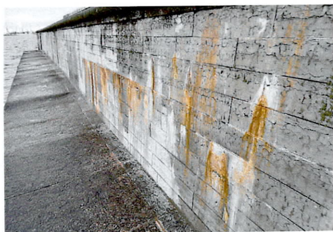
3. Общий вид на стенку набережной.
