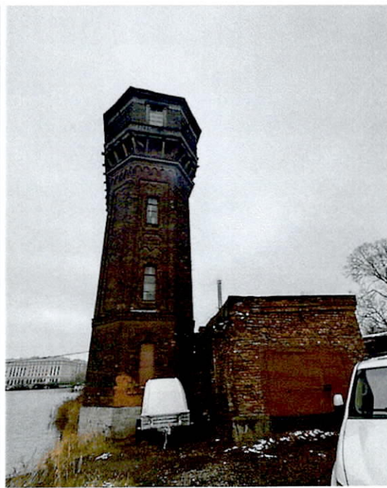
6. Общий вид на верхнюю часть башни.
