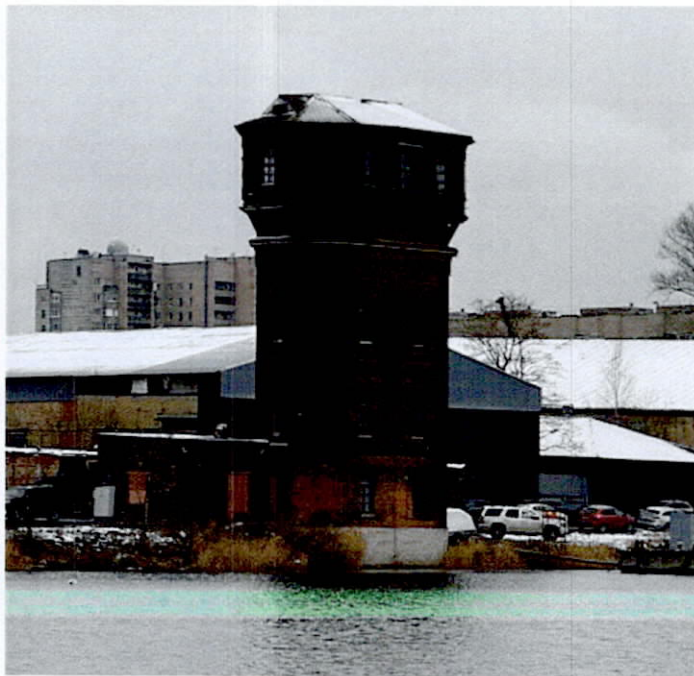
2. Общий с северной-западной стороны.
