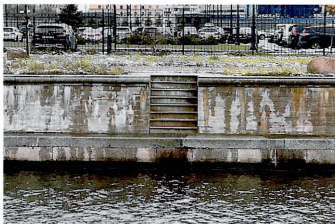
5. Общий вид на лестницу.
