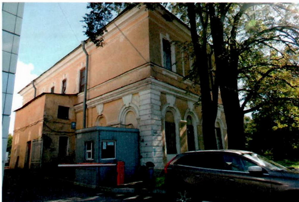
3. Вид с северо-запада.
