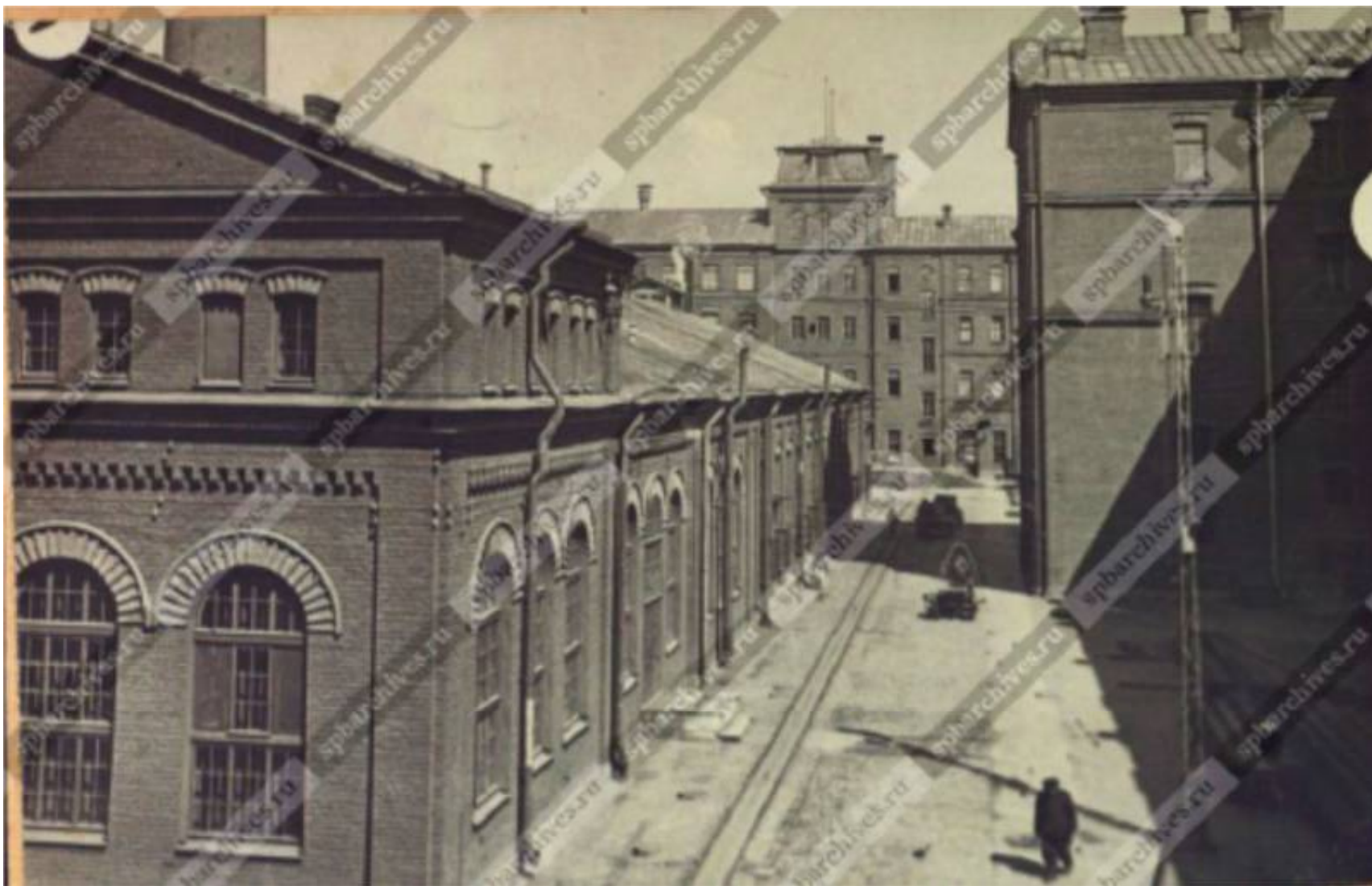
38. Внутренний вид заводского двора. 1920–1930-е гг. ЦГАКФФД СПб. Ар 83621.
