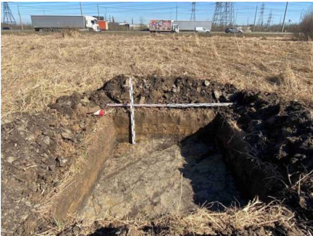
Рис. 68. Санкт-Петербург, город Колпино, территория предприятия «Ленсоветовское»: участок 279 ск/н 78:37:0017212:427; участок 290 ск/н 78:37:0017212:421. Шурф №1. Зачистка дна шурфа по материку. Вид с юга.
