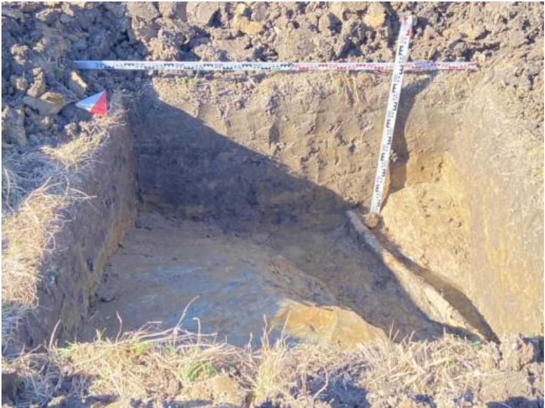
Рис. 103. Санкт-Петербург, город Колпино, территория предприятия «Ленсоветовское»: участок 279 ск/н 78:37:0017212:427; участок 290 ск/н 78:37:0017212:421. Шурф №8. Зачистка дна шурфа по материку. Вид с юга.
