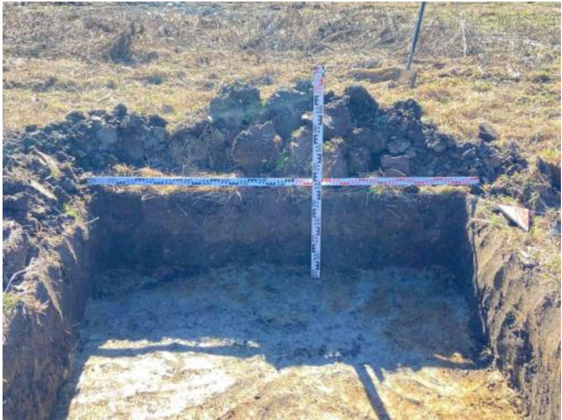
Рис. 99. Санкт-Петербург, город Колпино, территория предприятия «Ленсоветовское»: участок 279 ск/н 78:37:0017212:427; участок 290 ск/н 78:37:0017212:421. Шурф №7. Южная стенка. Вид с севера.
