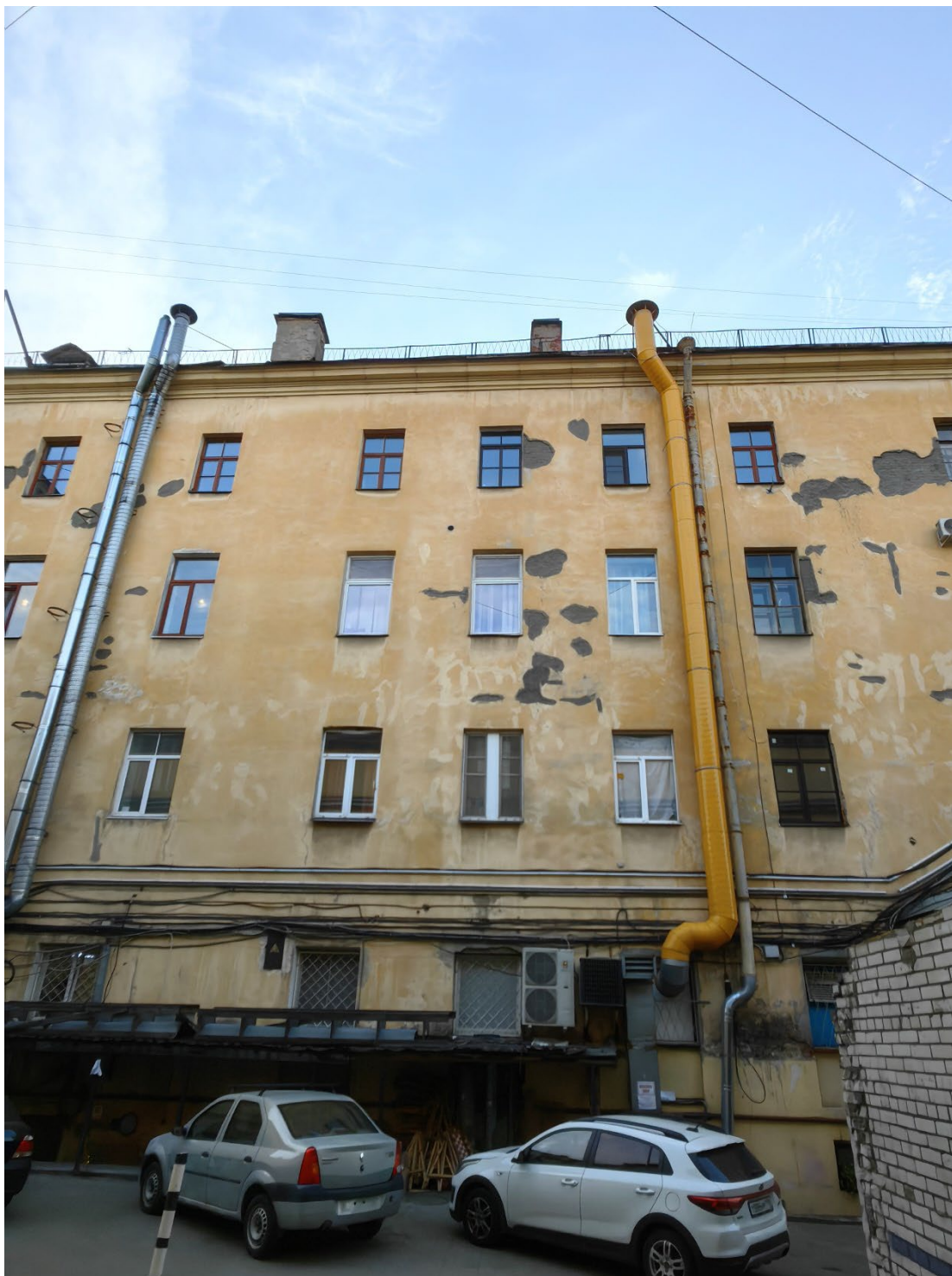
Фото 5. Фрагмент дворового фасада
