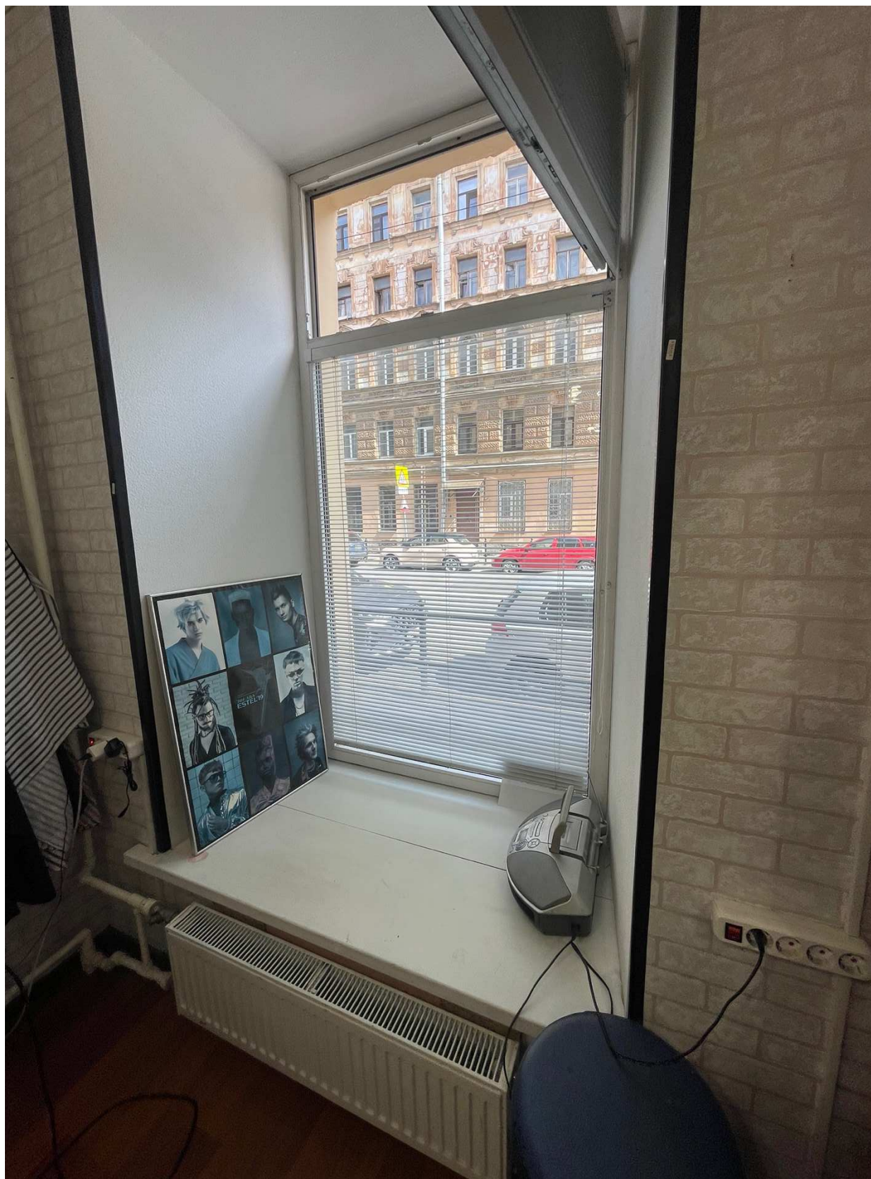
17. Вид на оконное заполнение (помещение №3);
