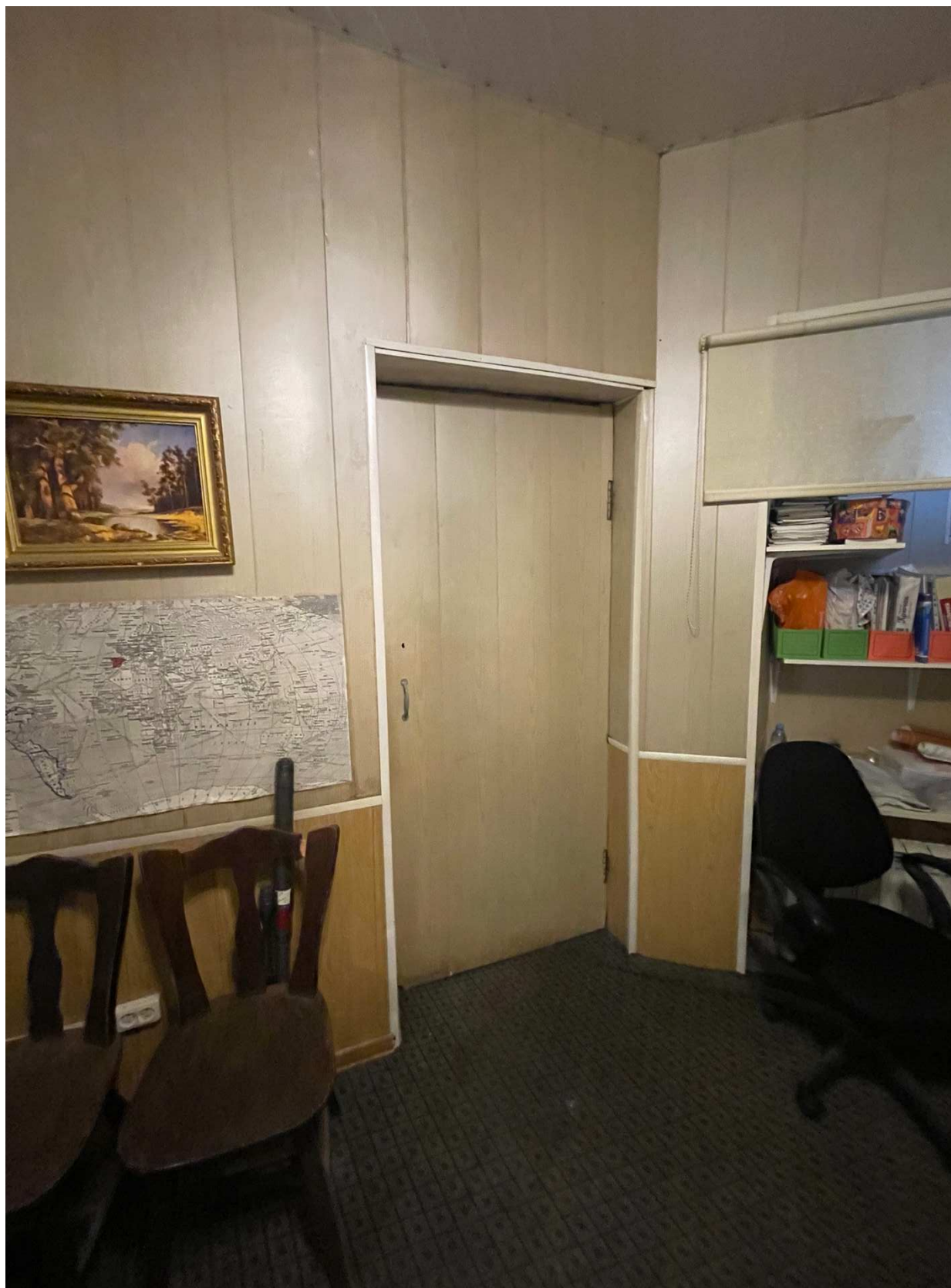
6. Вид на входную дверь в помещении;
