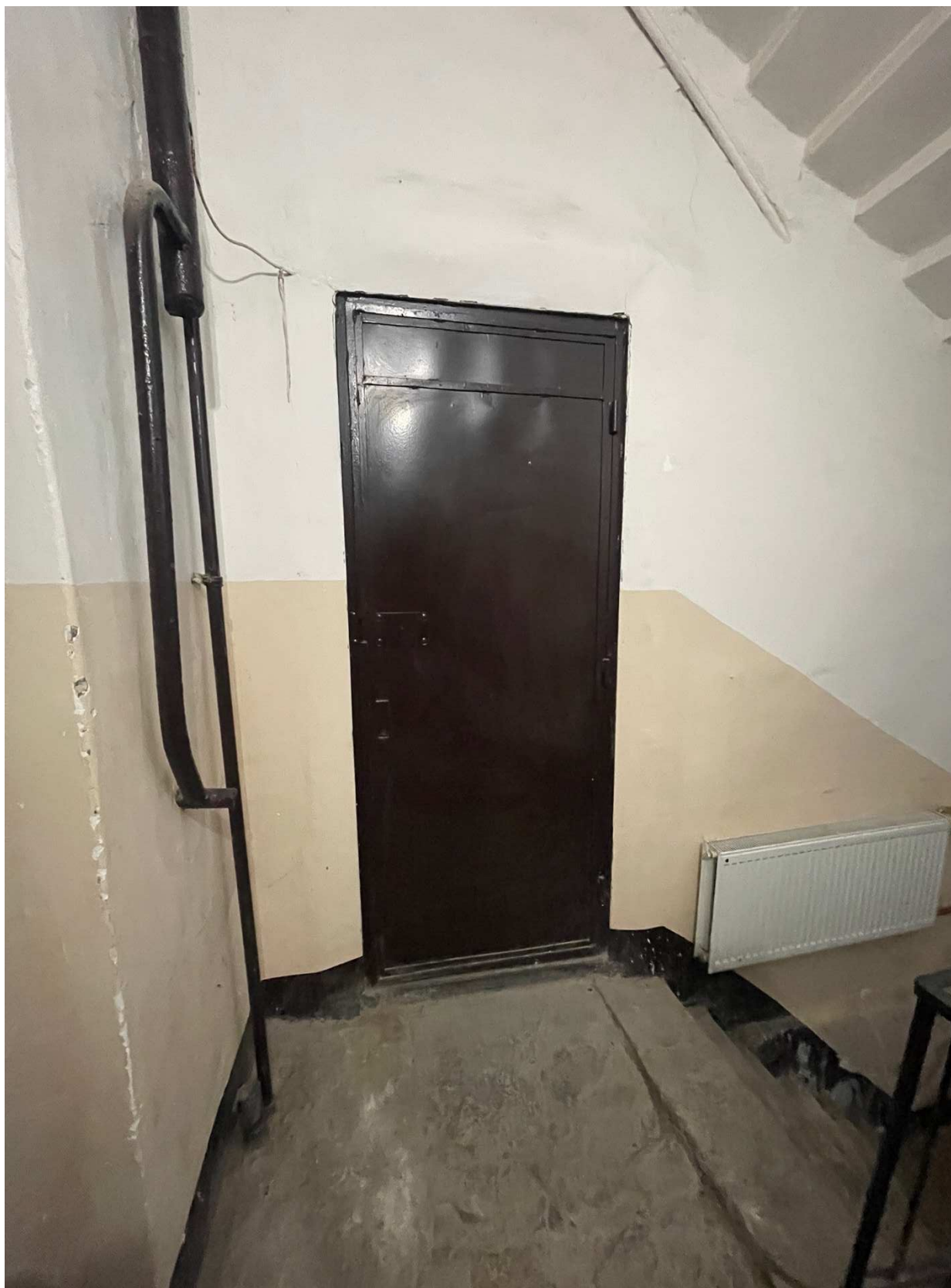
5. Вид на входную дверь в помещение;
