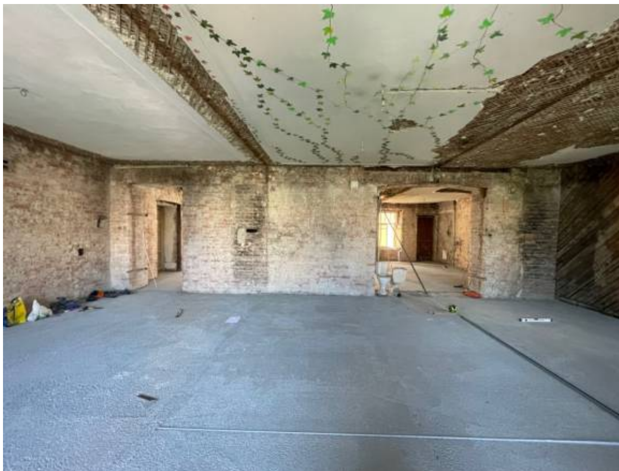
10. Помещение со стороны лицевого фасада (все перегородки демонтированы).
