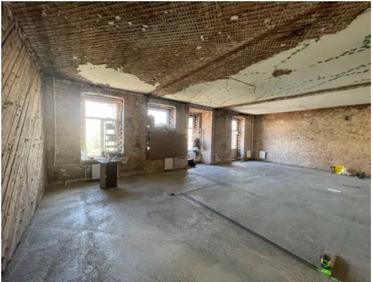
9. Помещение со стороны лицевого фасада (все перегородки демонтированы).
