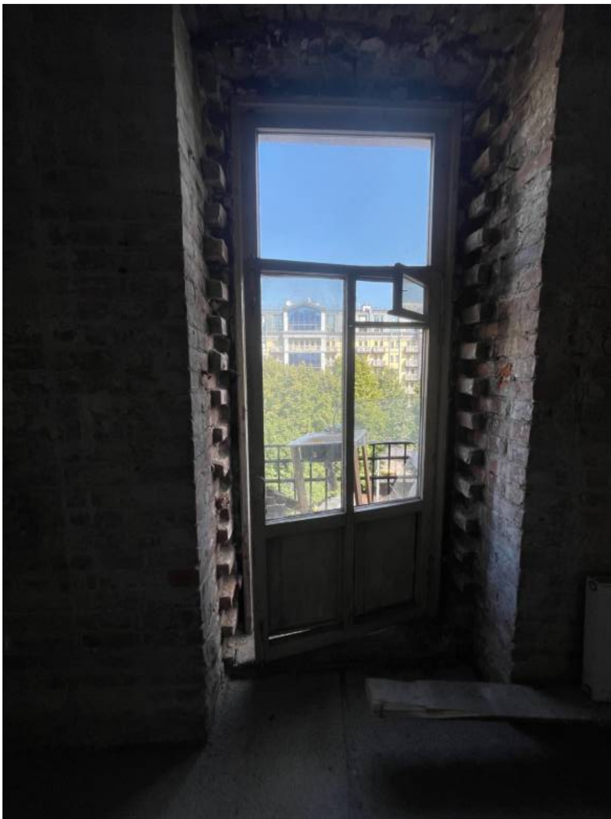
11. Балконное дверное заполнение.
