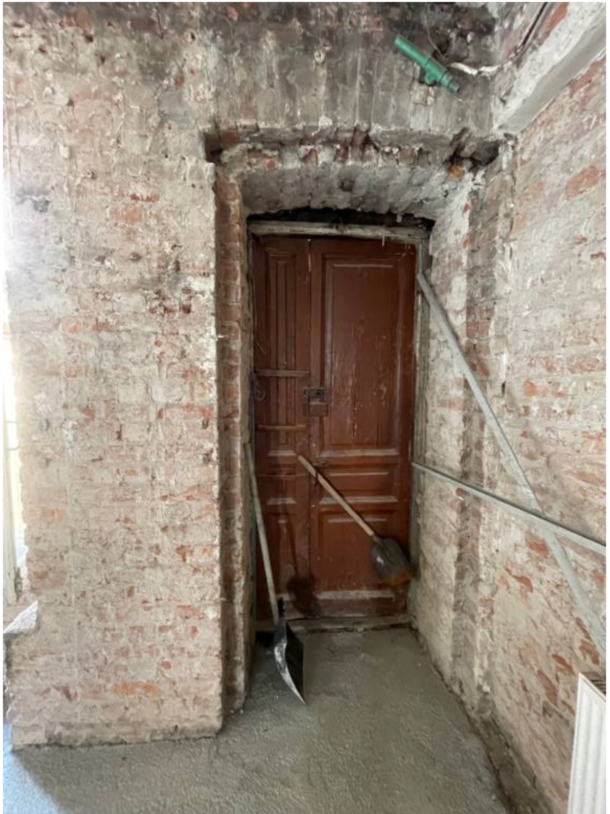
8. Входная дверь со стороны помещения 5 (в соответствии с техническим паспортом).
