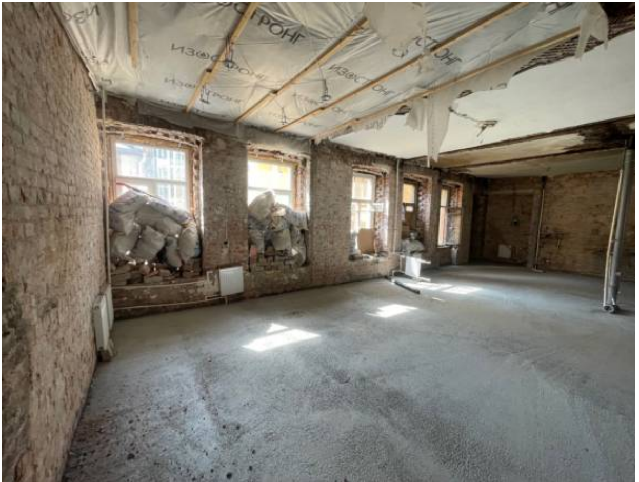
6. Помещение со стороны дворового фасада (все перегородки демонтированы).
