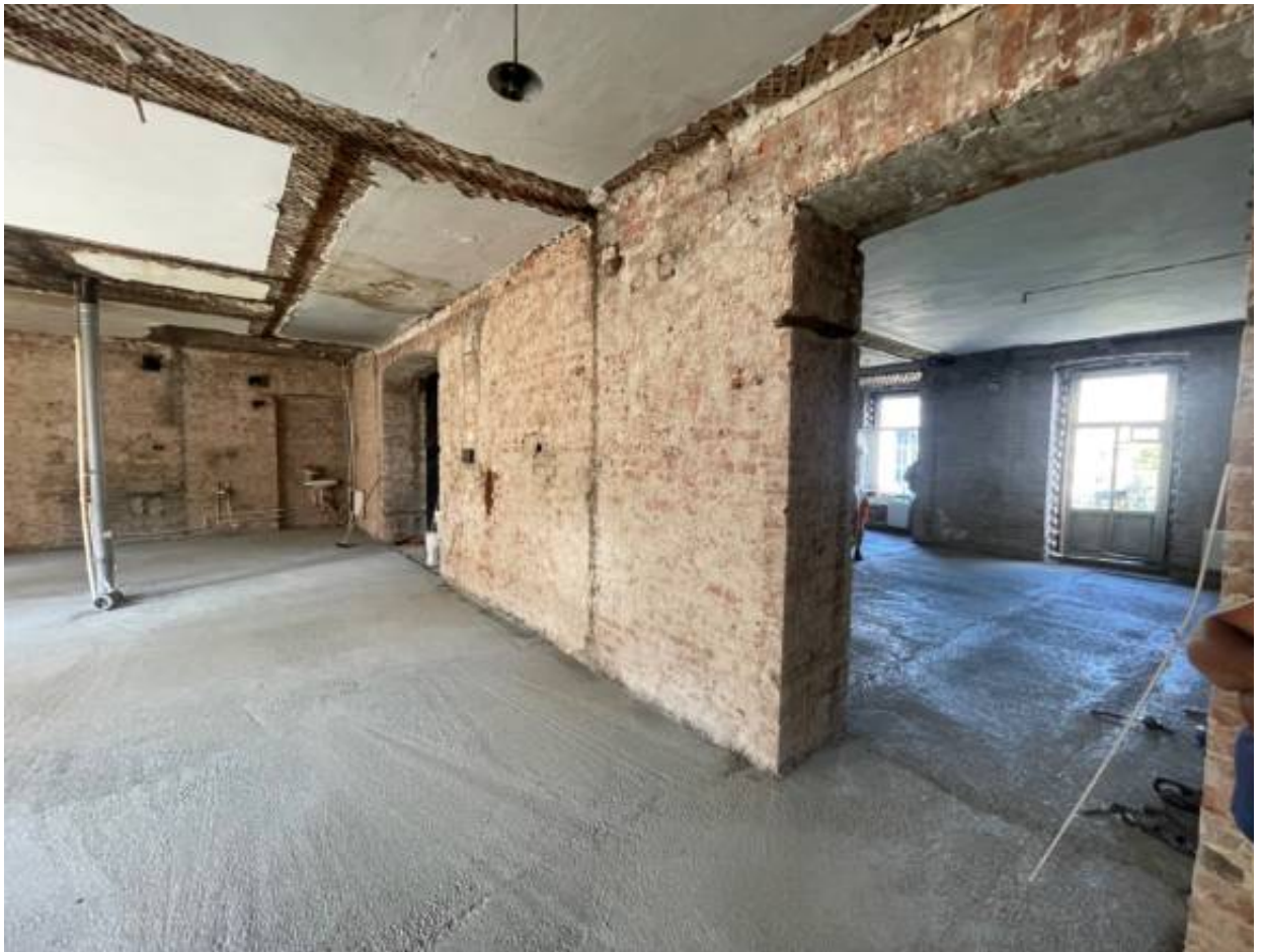
7. Помещение со стороны дворового фасада (все перегородки демонтированы).
