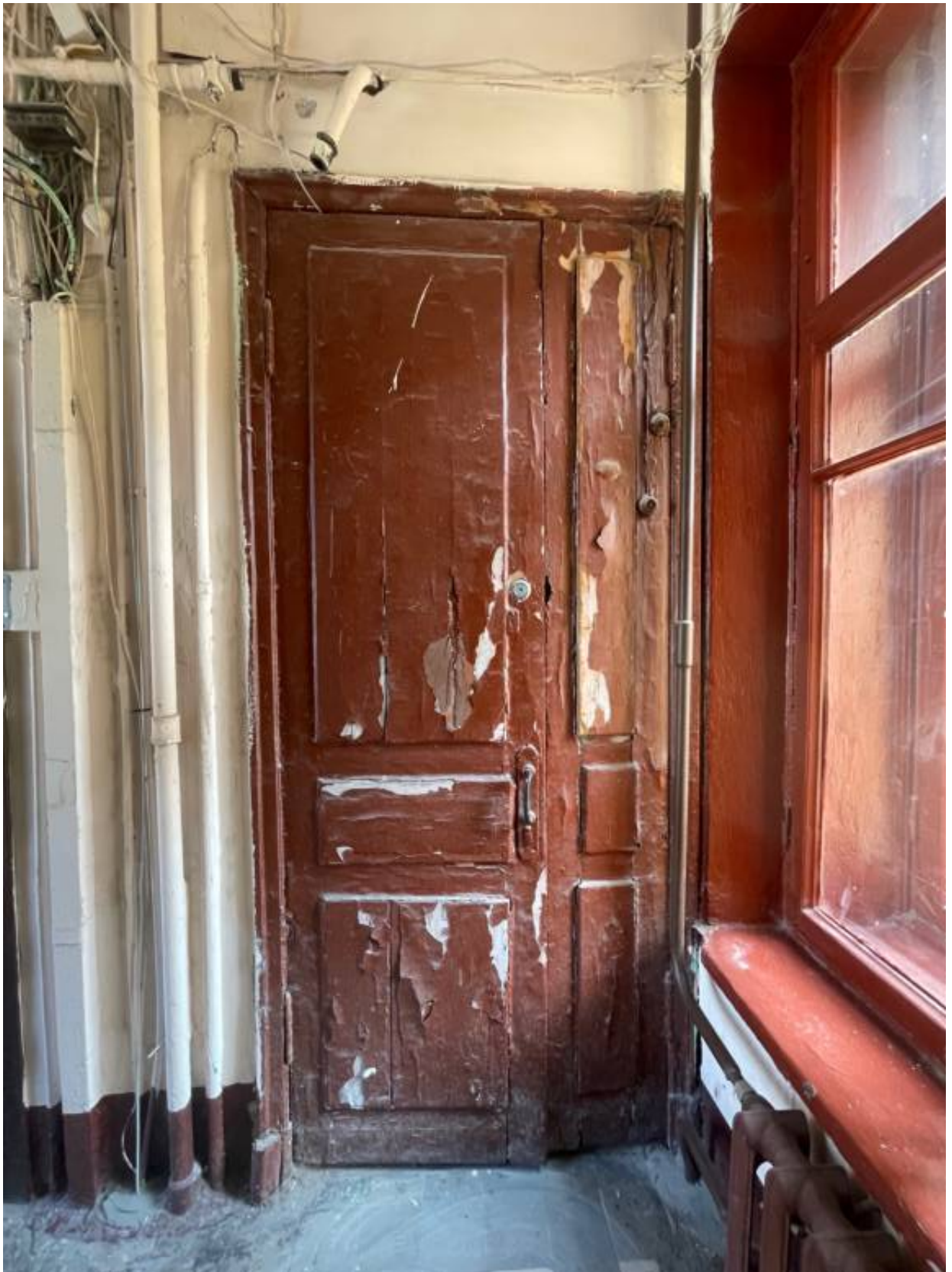
4. Входная дверь в квартиру № 18 со стороны помещения 5 (в соответствии с техническим паспортом).
