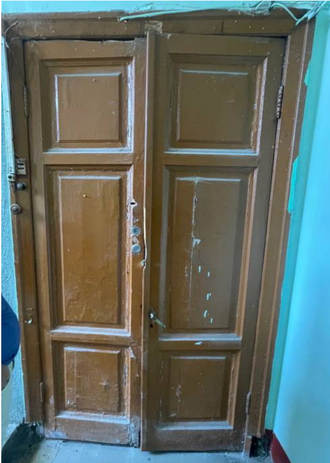
3. Входная дверь квартиры № 18 (со стороны помещения 1 в соответствии с техническим паспортом).
