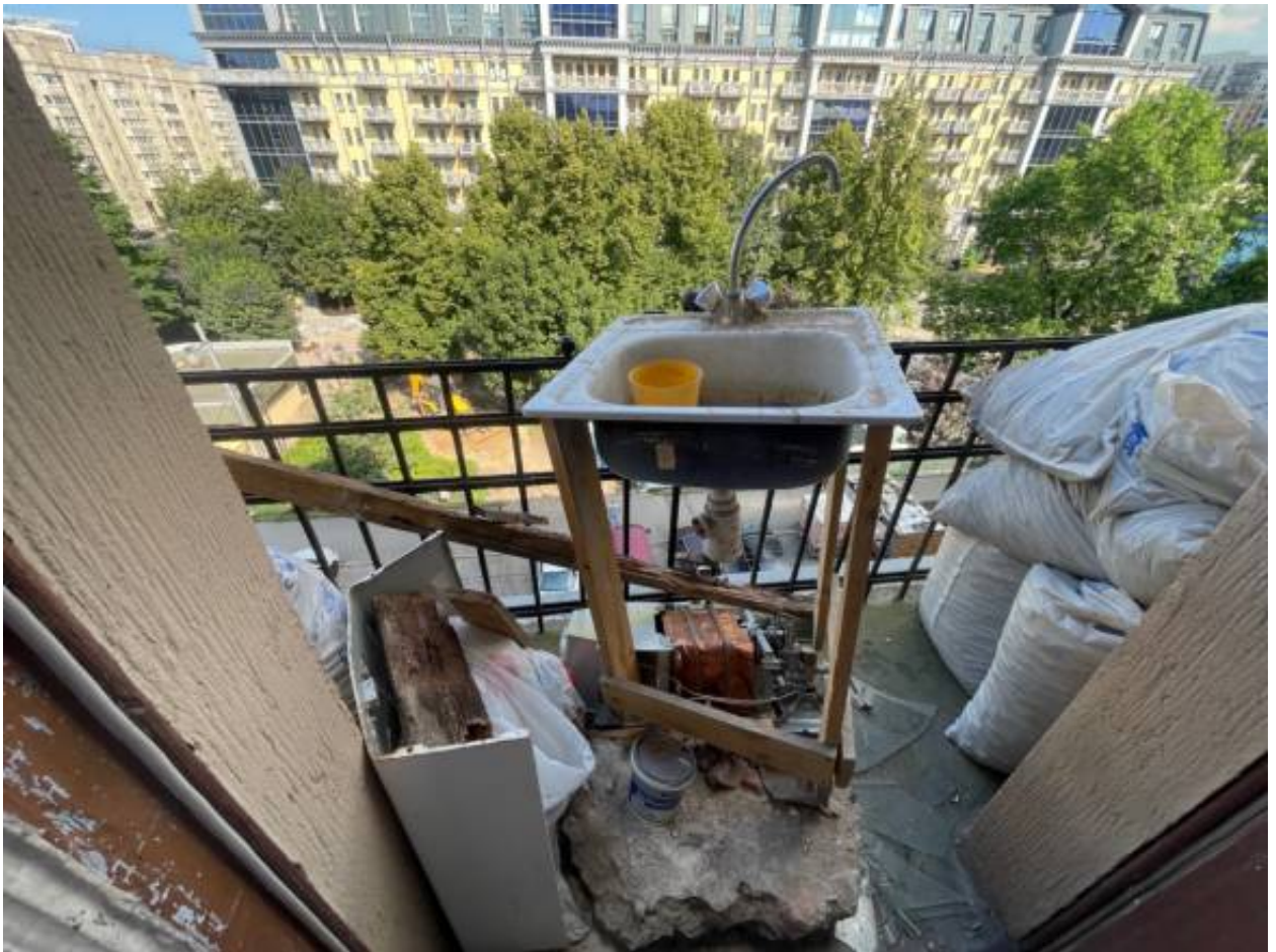
12.Общий вид балкона.
