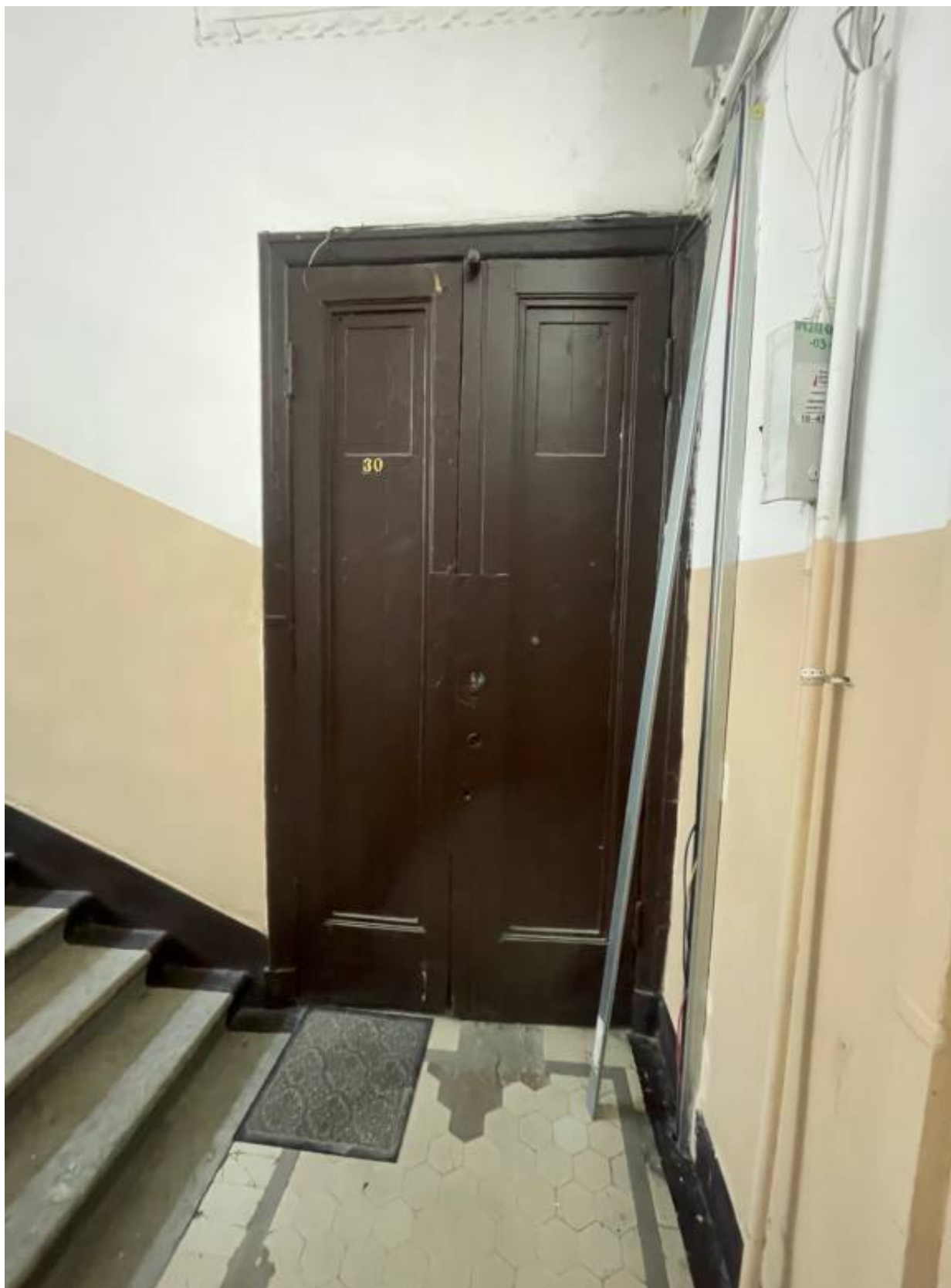
3. Входная дверь квартиры со стороны лестничной клетки.
