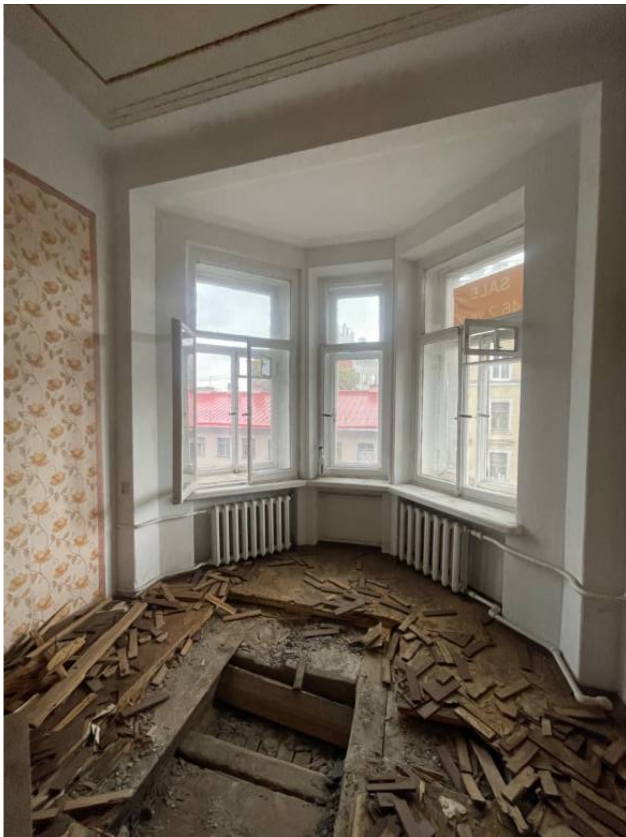
23. Помещение 1 (в соответствии с техническим паспортом).
