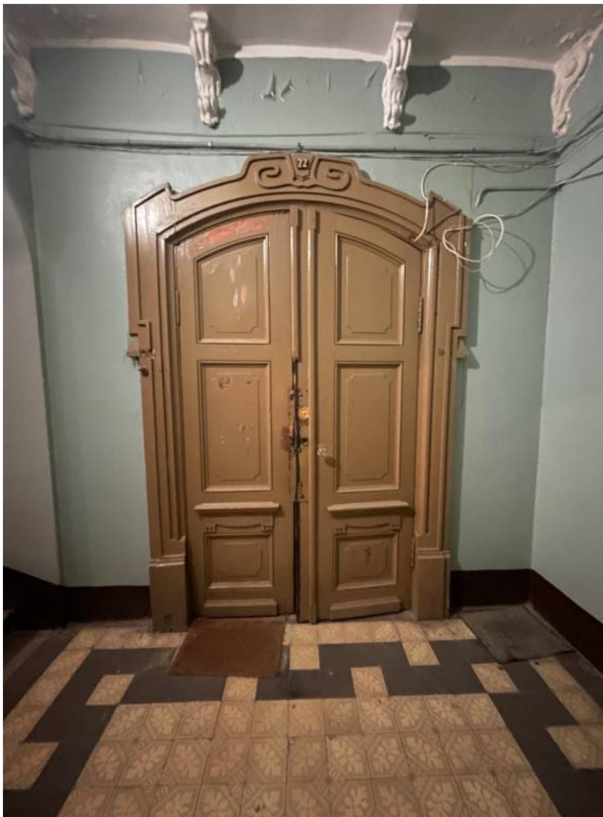
3. Входная дверь квартиры со стороны лестницы.
