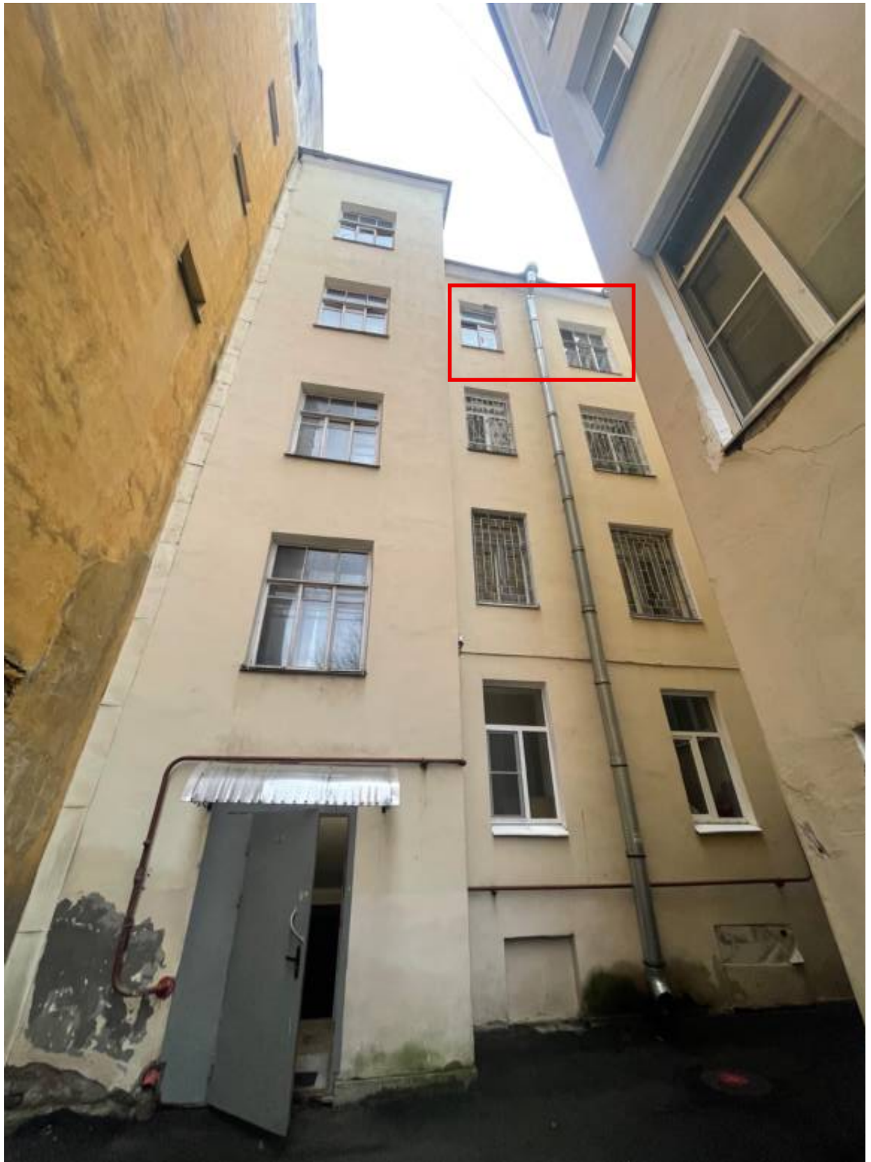
2. Фрагмент дворового фасада. Красной линией отмечены оконные проемы квартиры.
