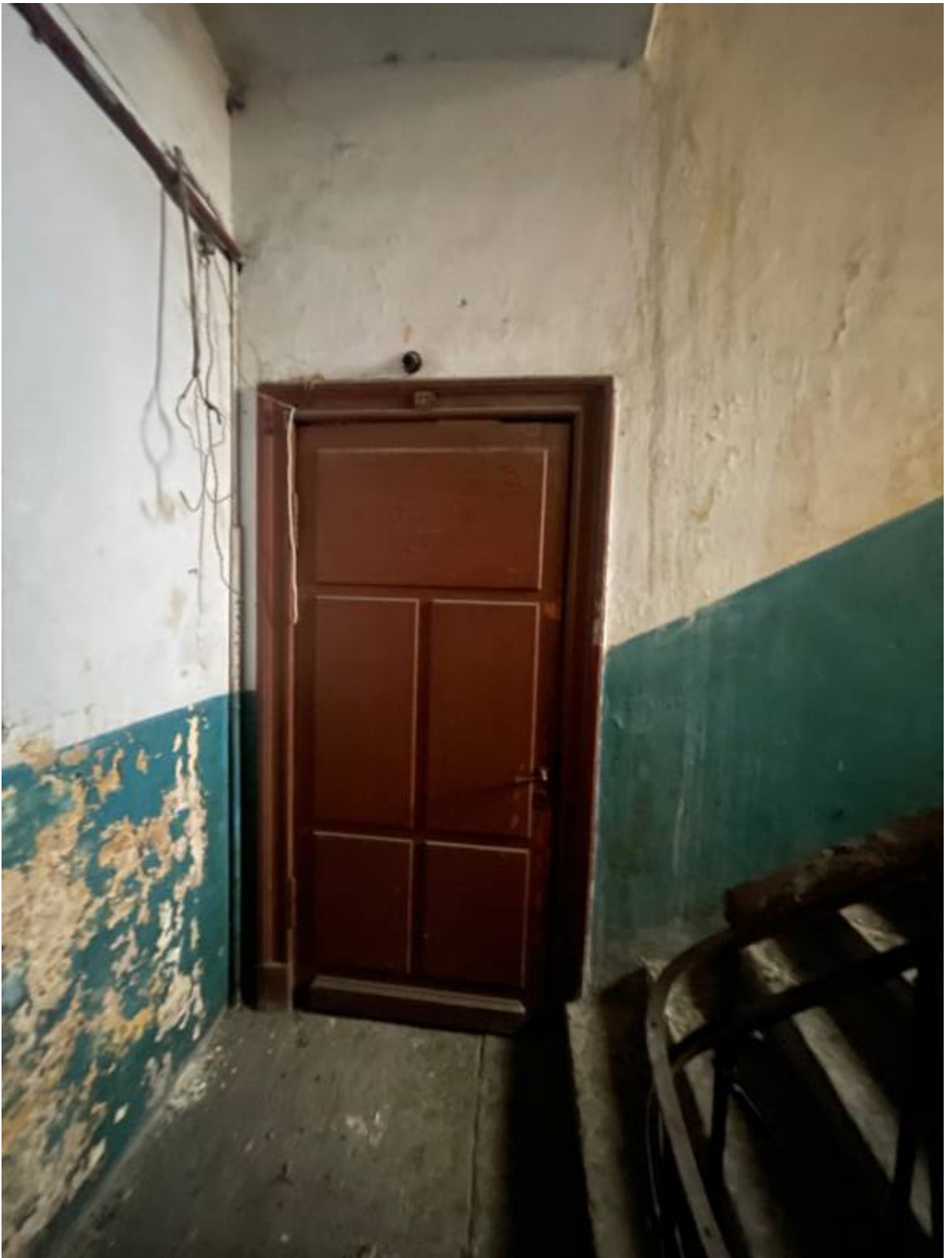
11. Входная дверь со стороны служебной лестничной клетки.
